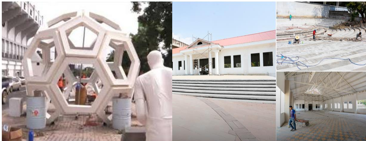
Ilustración 15-Edificaciones realizadas en el Distrito Cultural
