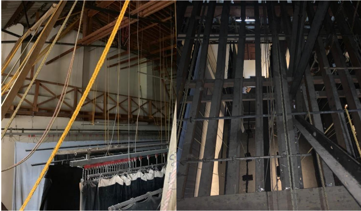
Ilustración 9-Disposición de largueros y cuerdas de la Tramoya
