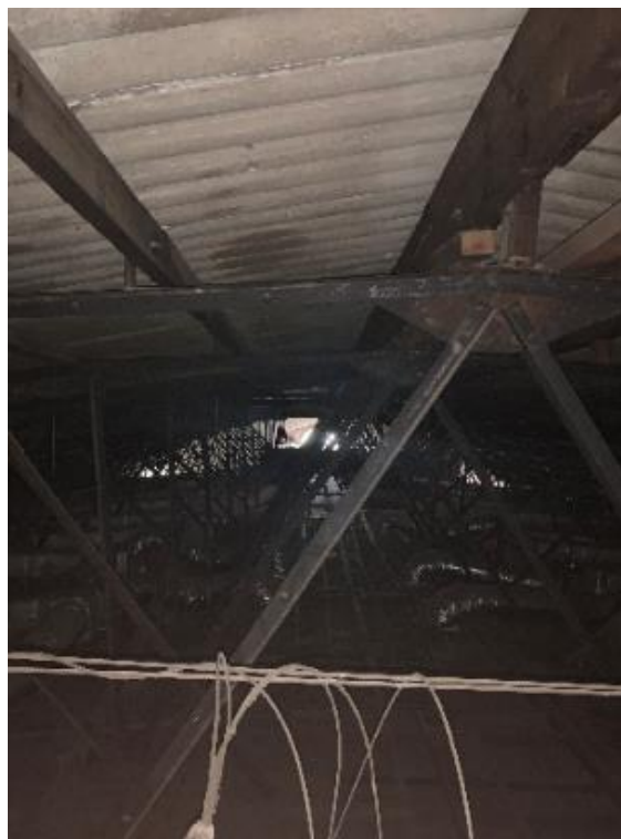
Ilustración 116-Vista Disposición de Armadura Teatro Nacional Manuel Bonilla
