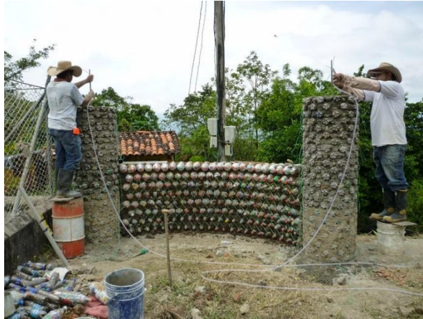
Ilustración 7. Construcción de viviendas con botellas
