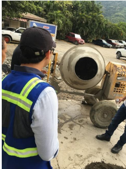
Ilustración 16. Mezcla de concreto
