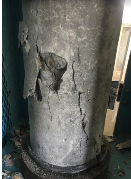
Ilustración 100. Falla por compresión CB228-035
