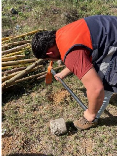
Ilustración 17: Realización de Calicata
