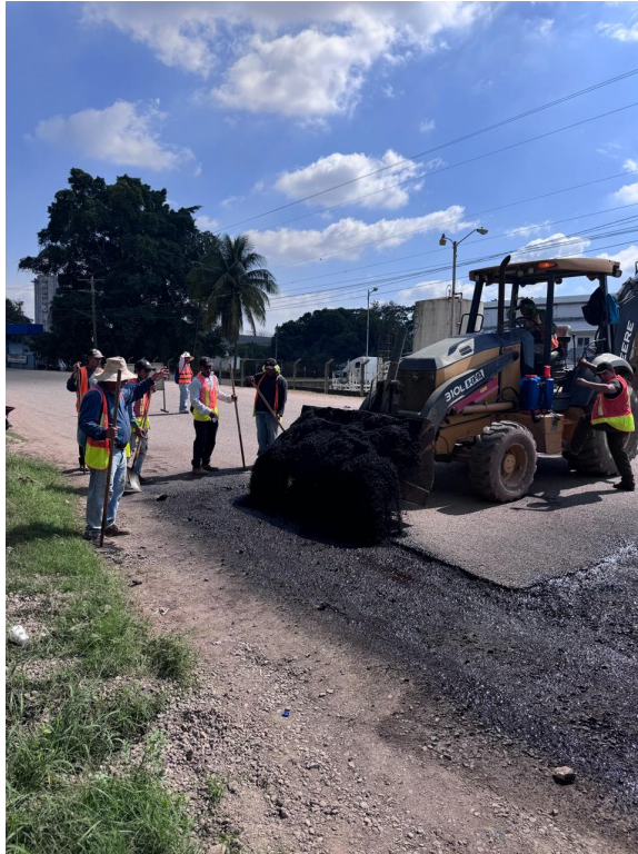
Ilustración 13 Colocación de mezcla con retroexcavadora
