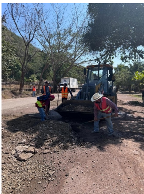
Ilustración 9 Limpieza de bache excavado
