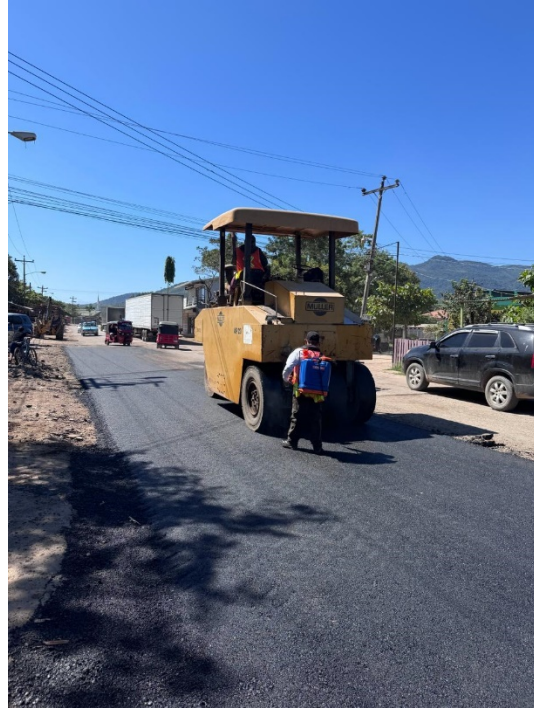
Ilustración 16 Sellado de la mezcla
