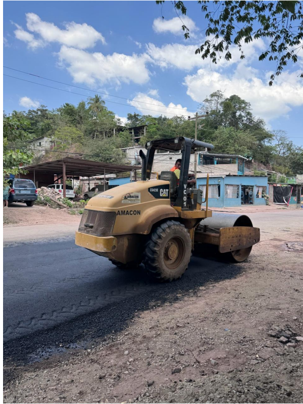
Ilustración 15 Compactación de la mezcla
