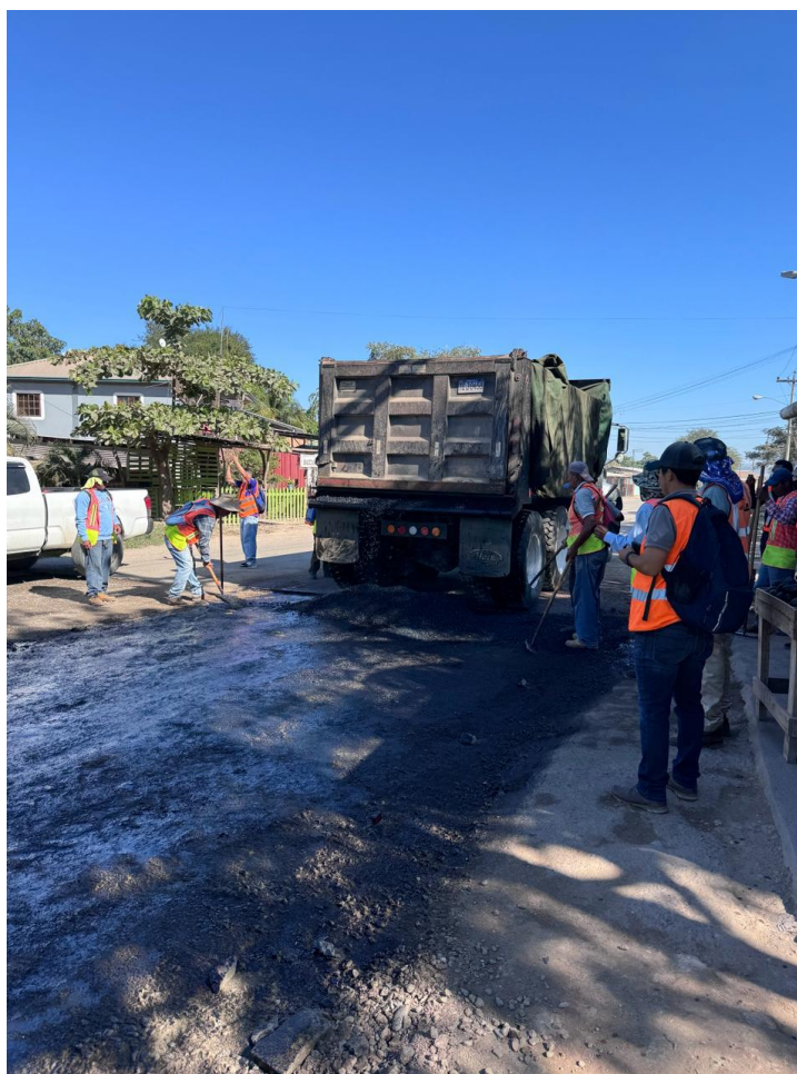
Ilustración 12 Colocación del material directo en el bache.
