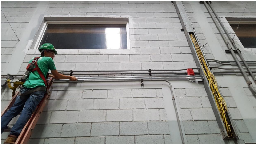
Ilustración 11. Instalación de ramificación de tubería RMC en Bandeja Porta cable existente.
