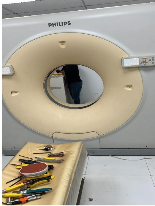
Ilustración 34 Desinstalación TAC Philips en Hospital Adventista de Valle de Angeles
