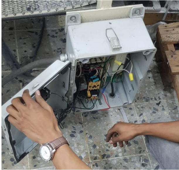
Ilustración 14. Revisión del panel de la detectora de metal.
