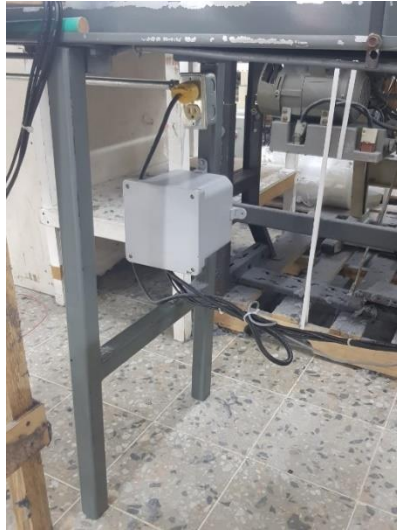
Ilustración 10. Instalación de tomacorriente y caja en banda transportadora
