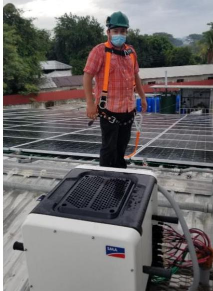
Ilustración 12-Reinicio de los inversores de los módulos solares
