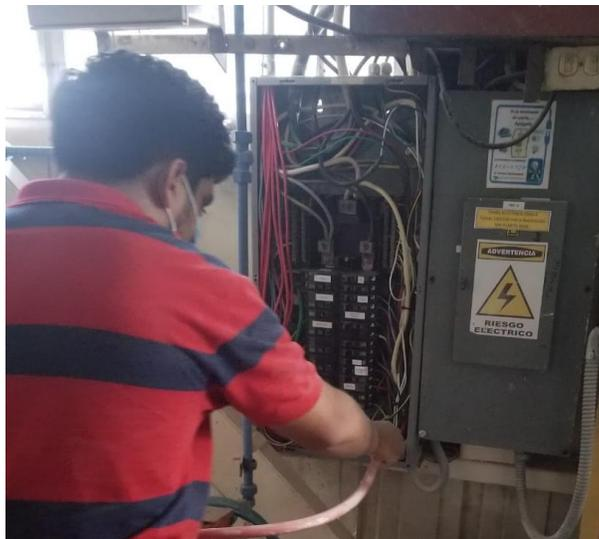
Ilustración 13-Limpieza de paneles eléctricos
