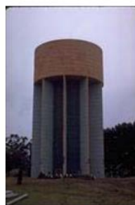
(b) Tanque de concreto
