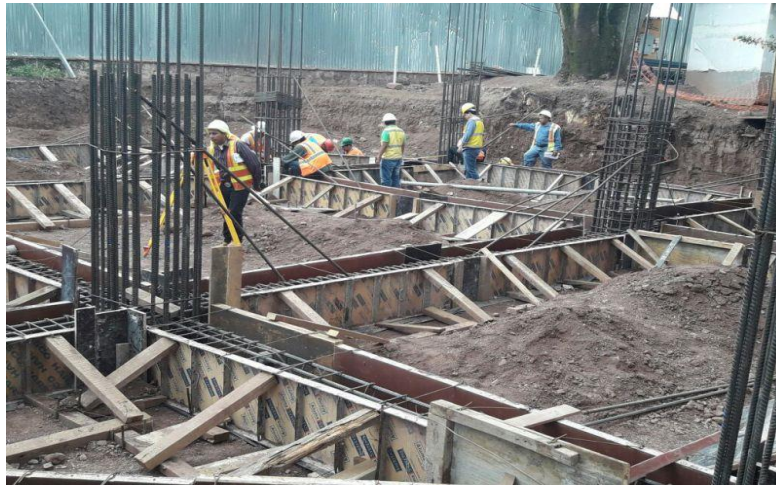
Figura 4. Construcción de mega tanque
