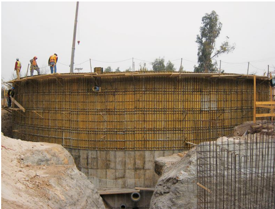
Figura 12. Tanque Circular Fuente: EFCO CORP, 2018
