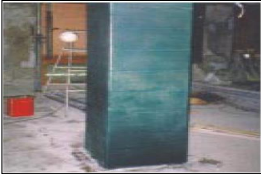
Figura 8. Aplicación de fibra de carbono en columna.
