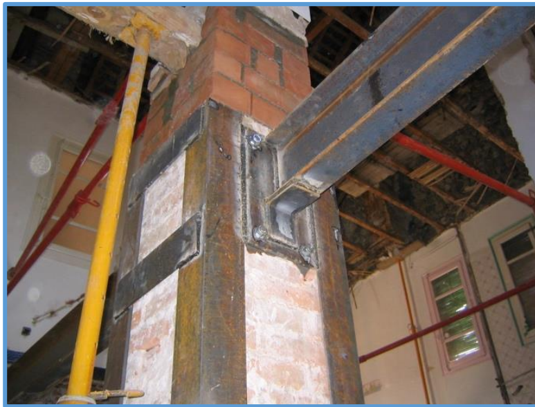
Figura 10. Encamisado de columna con acero.
