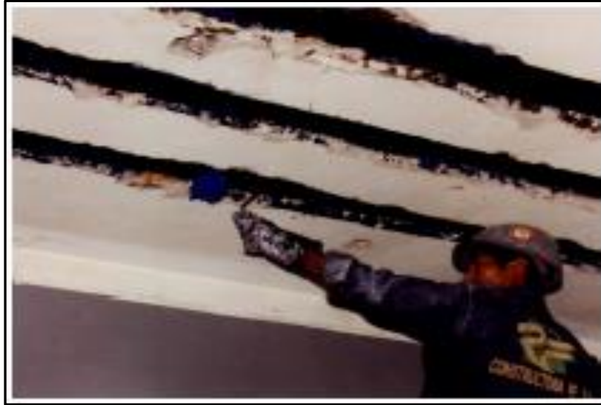
Figura 9. Aplicación de fibra de carbono en losa.
