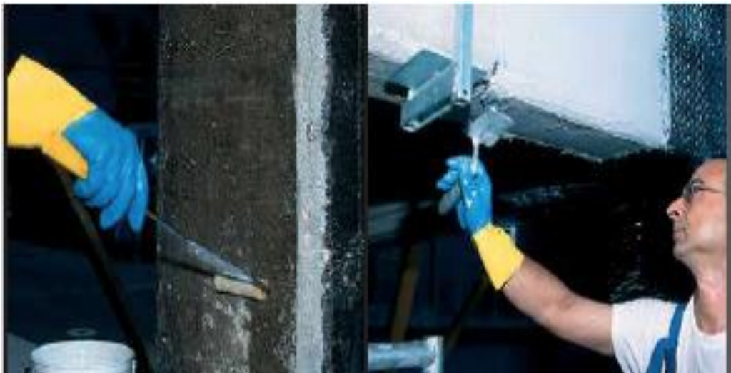
Figura 5. Impregnación de viga con resina epoxi.
