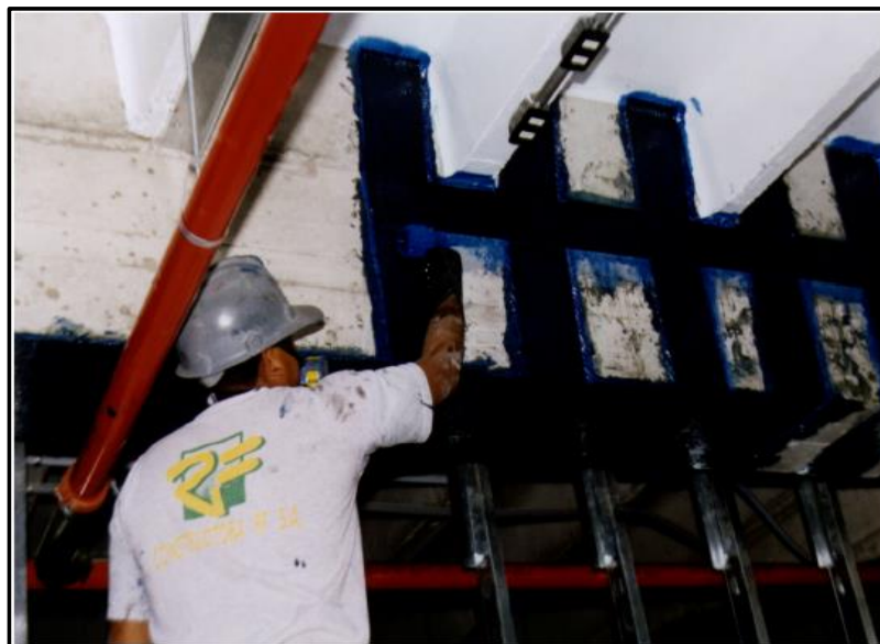
Figura 6. Reforzamiento por corte y flexión en viga estructural.
