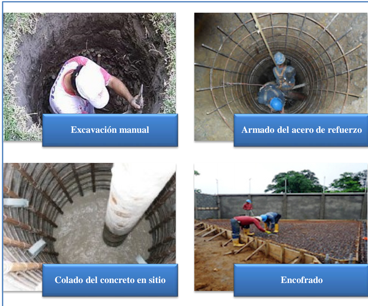
Figura 21. Proceso constructivo del pilote para torre triangular
