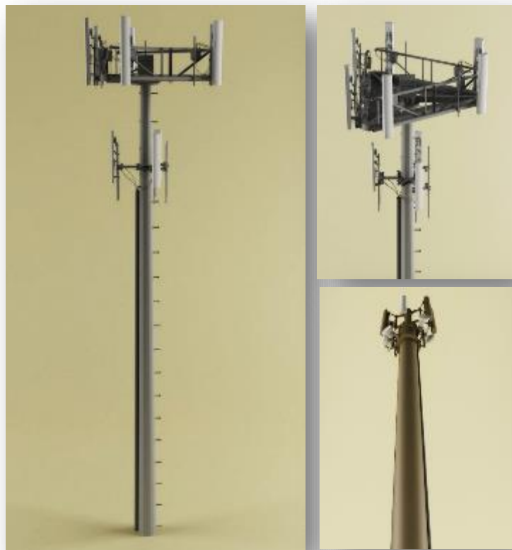
Figura 9. Torre Monopolo o Tubular
