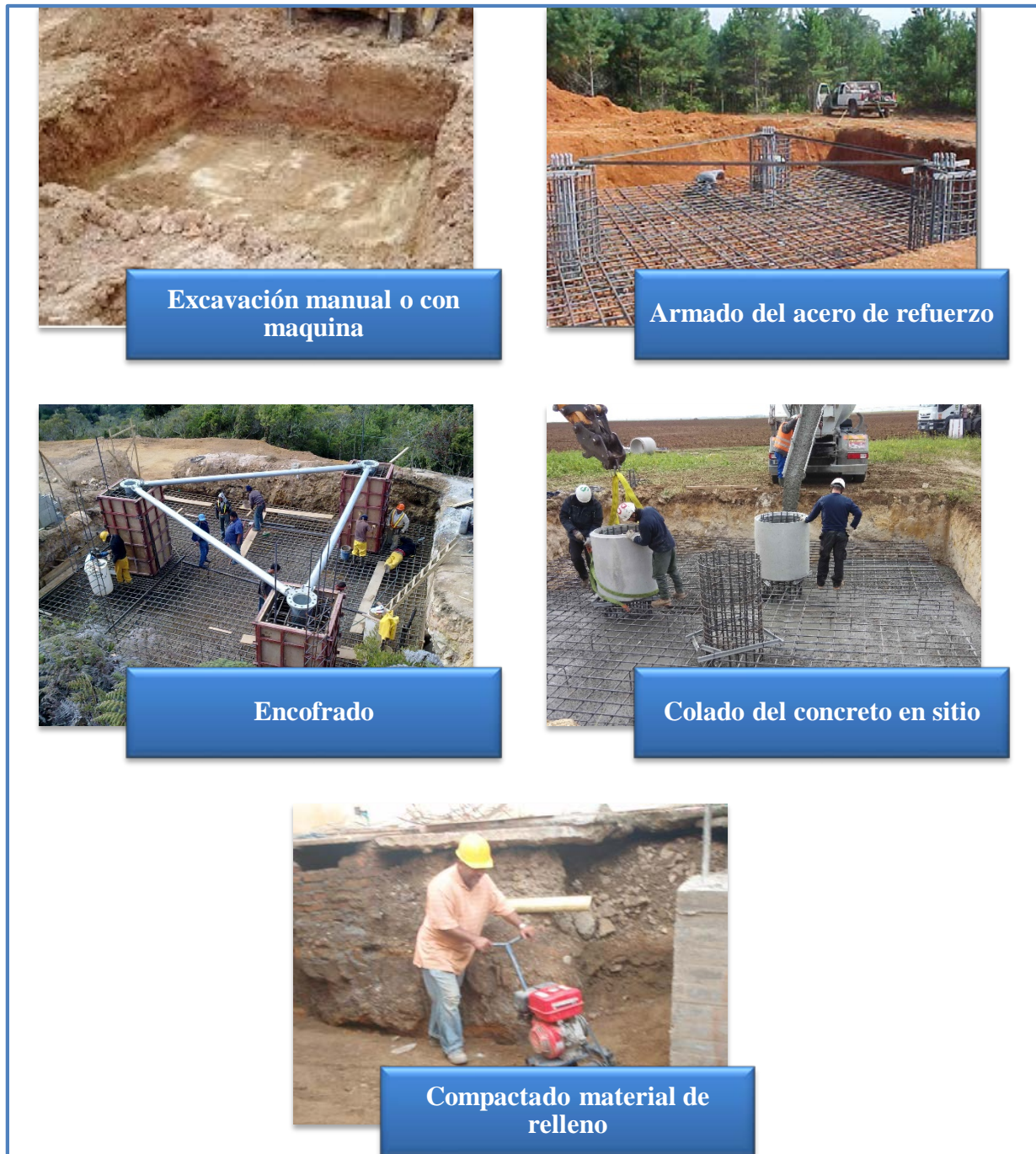
Figura 20. Proceso constructivo losa de cimentación para torre triangular
