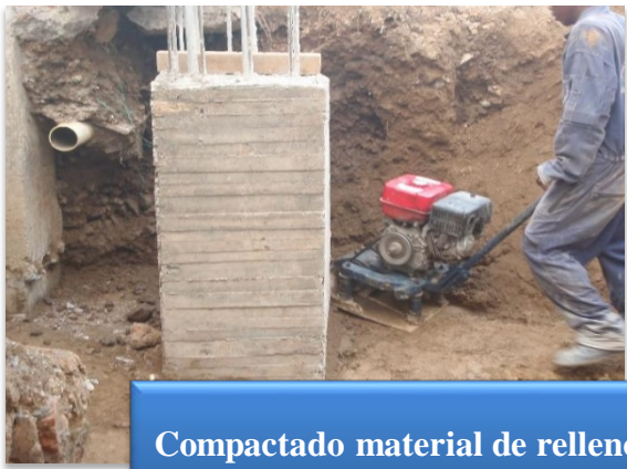
Figura 19. Proceso constructivo zapata aislada para torre triangular
