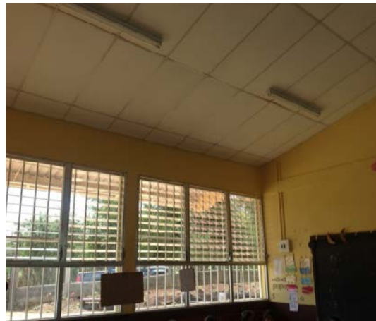
Construcción del Programa PROMINE
