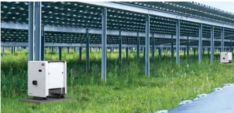
**Figura 20** Inversores SMA Sunny en instalación fotovoltaica a nivel de piso
