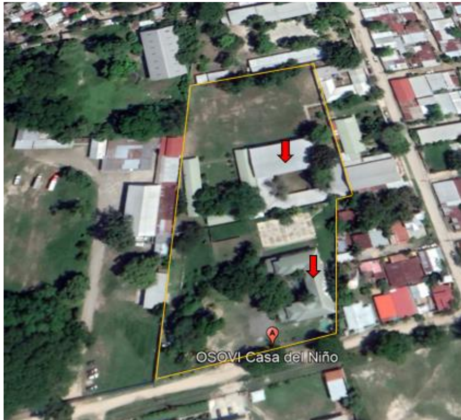
Figura 36 Identificación de los Edificios de la Fundación OSOVI
