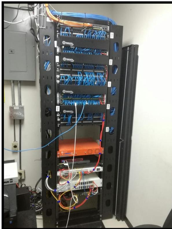
**Figura 51 - Cableado sin identificación**
