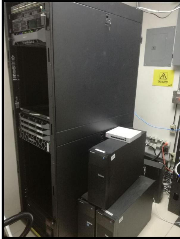
**Figura 50 - Computadoras con la función de servidores.**
