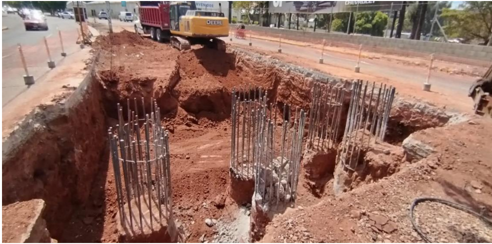
Ilustración 142 Avance de excavación de estribo No.1
