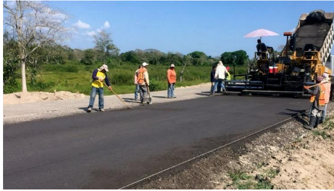
Ilustración 38 Recapeo en pavimento flexible
