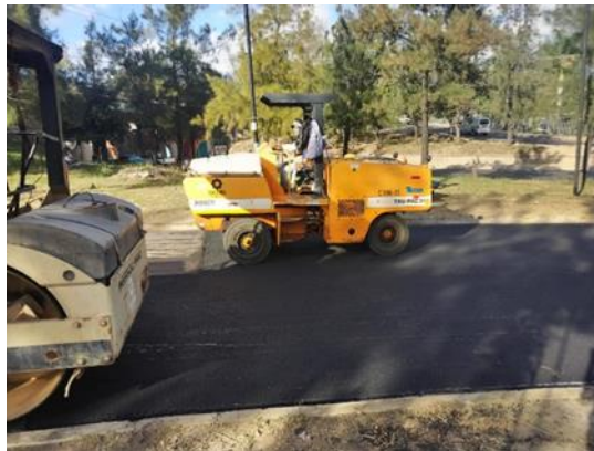
Ilustración 63 Sellado de capa asfáltica con máquina rodillo neumático CON-08
