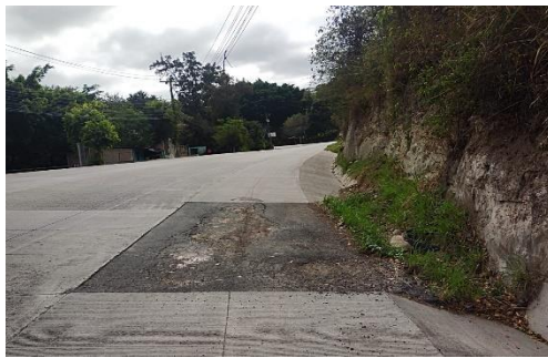
Ilustración 83 Limpieza y remoción de asfalto
