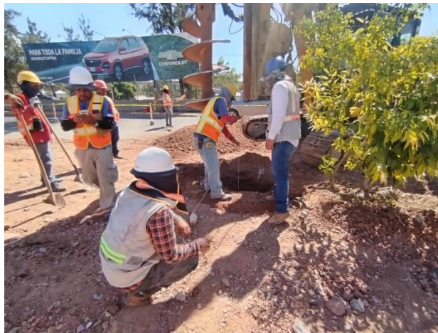
Ilustración 127 Medida de profundidad de perforación
