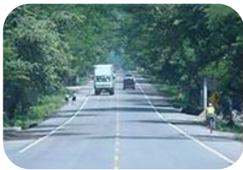
Supervisión, rehabilitación y pavimentación de tramo Juticalpa - Catacamas.
