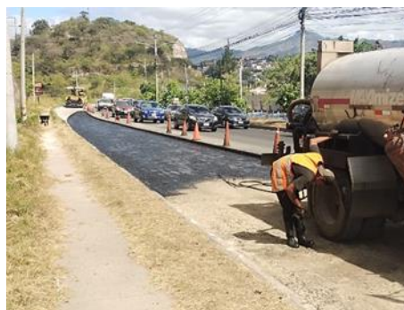
Ilustración 70 Colocación de emulsión asfáltica en tramo
