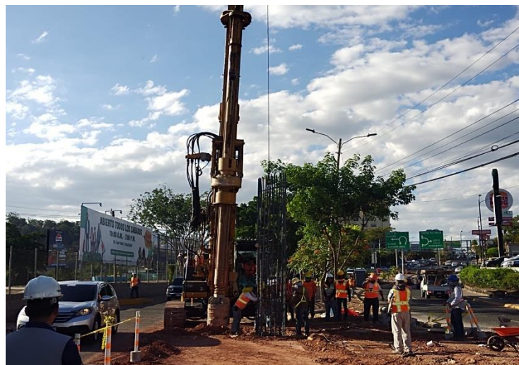
Ilustración 129 Colocación de pilote con máquina perforadora
