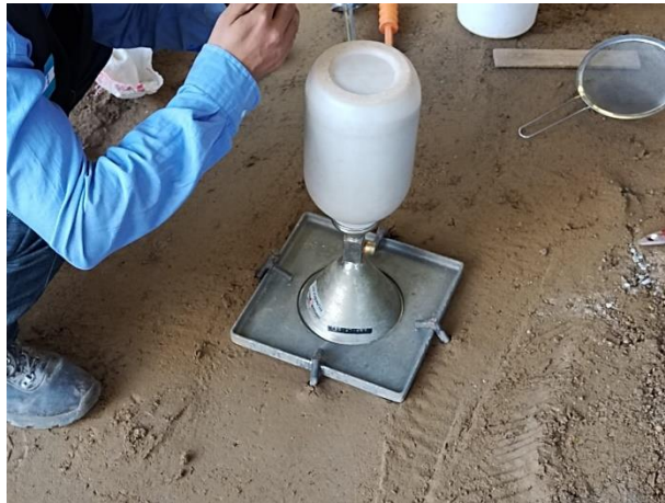
Ilustración 104 Colocación de arena en suelo
