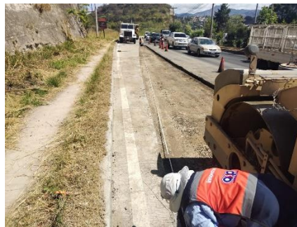
Ilustración 69 Medición de longitud, ancho y espesor para tramo a pavimentar
