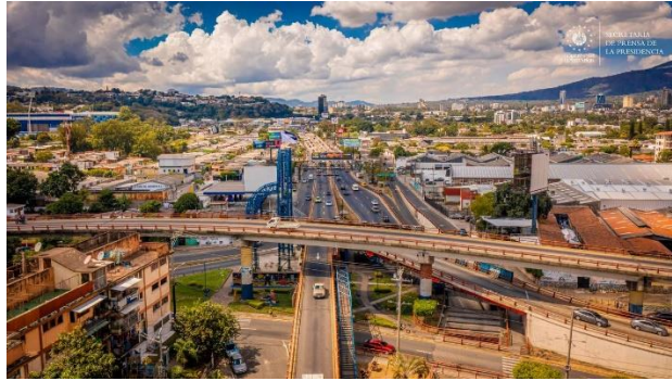
Ilustración 39 Paso a desnivel
