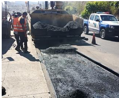
Ilustración 66 Colocación de capa asfáltica con máquina Finisher
