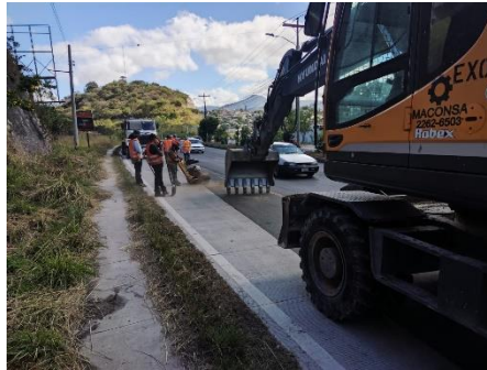
Ilustración 68 Máquina excavadora Exo-31 en retiro de carpeta asfáltica
