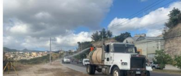
Ilustración 72 Informe semanal proyecto Rehabilitación carpeta del Anillo Periférico
