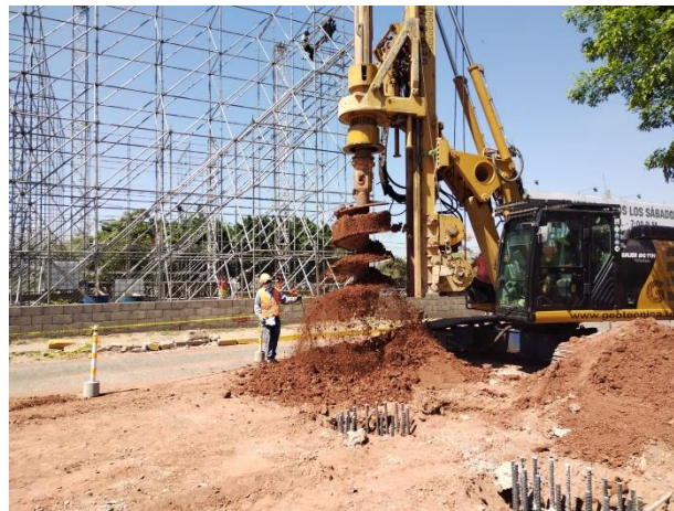
Ilustración 131 Retiro de material luego de perforación
