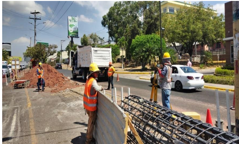
Ilustración 139 Ubicación de perforación de pilote con topografía
