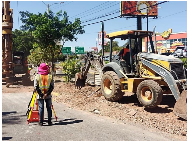
Ilustración 126 Remoción de material con retroexcavadora
