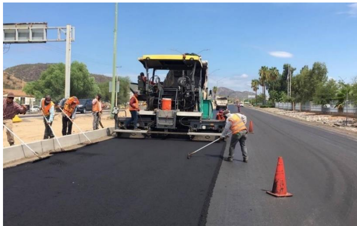
Ilustración 35 Pavimento de concreto asfáltico
