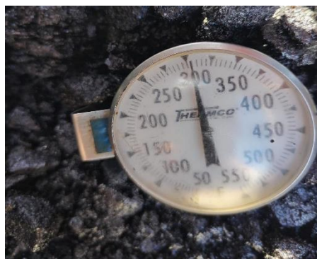
Ilustración 71 Revisión de temperatura en asfalto
