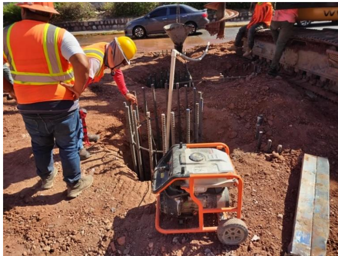
Ilustración 133 Drenaje de agua de hoyo perforado
