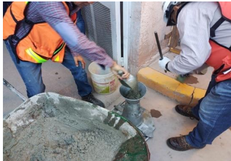
Ilustración 113 Colocación de concreto en Cono de Abrams
