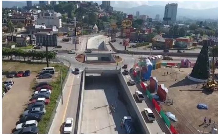
Ilustración 2 Construcción paso a desnivel sobre rotonda en Juan Pablo II
