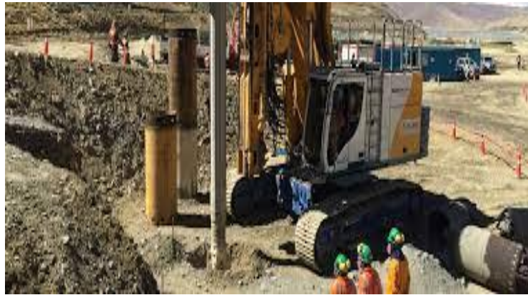
Ilustración 43 Pilotes perforados
