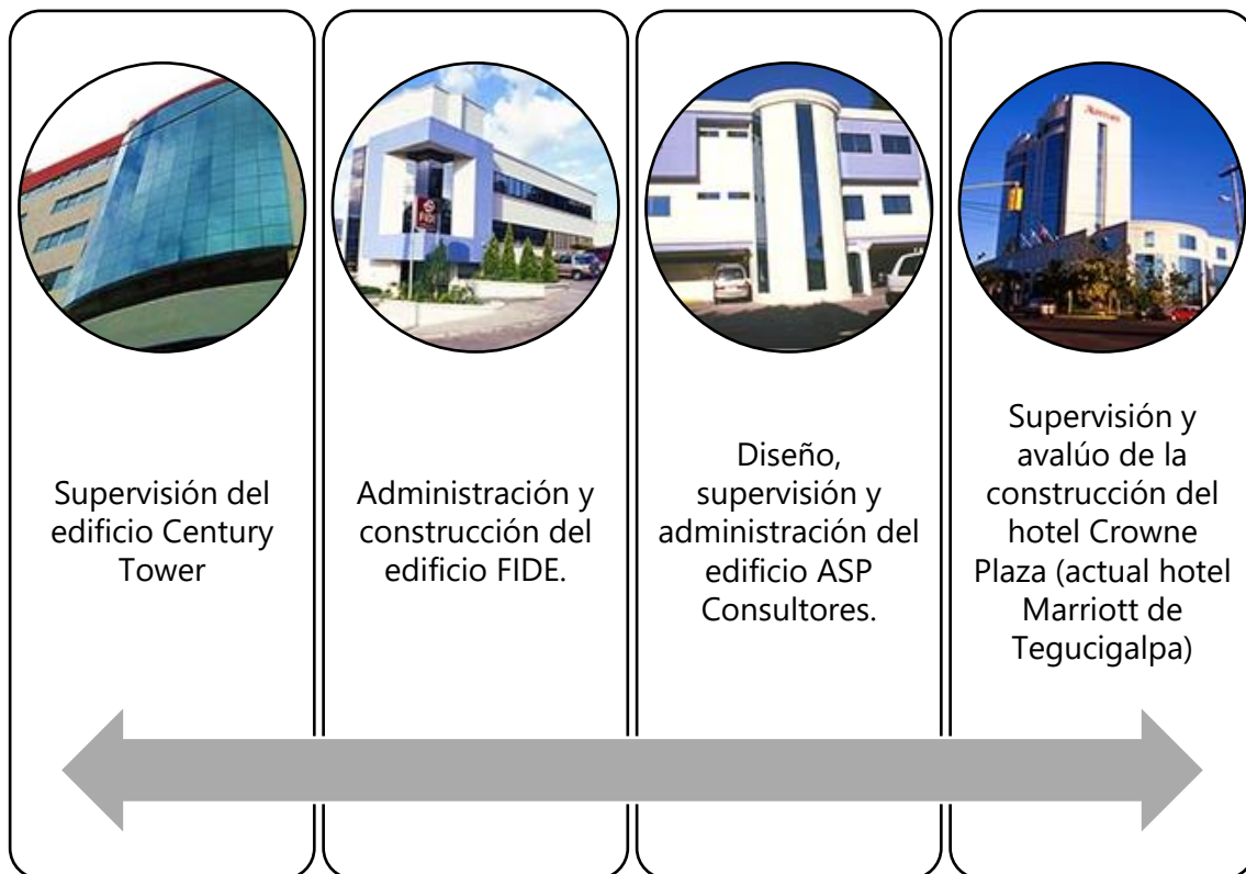
Gráfico 5 Proyectos de edificaciones
