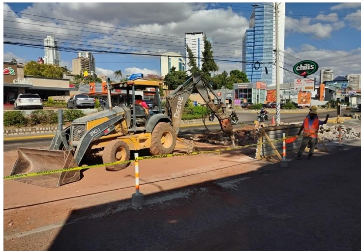
Ilustración 128 Remoción de concreto hidráulico con retroexcavadora
