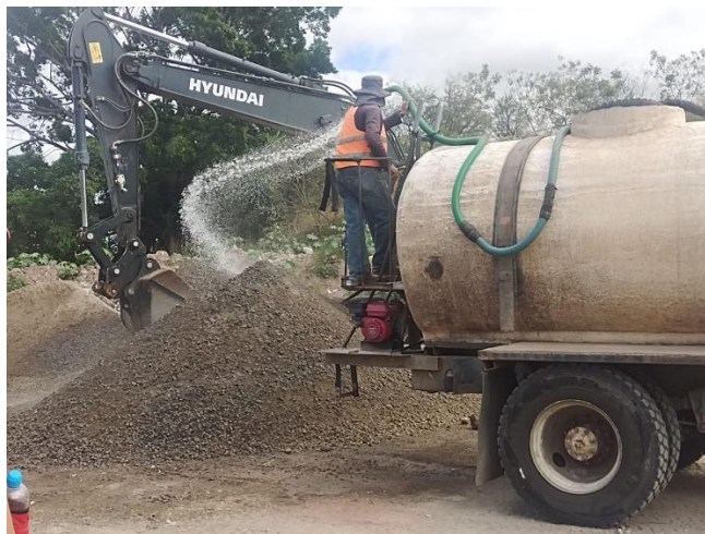
Ilustración 78 Mezclado de relleno de material para bordillo
