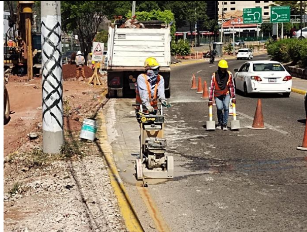
Ilustración 130 Máquina cortadora en pavimento rígido
