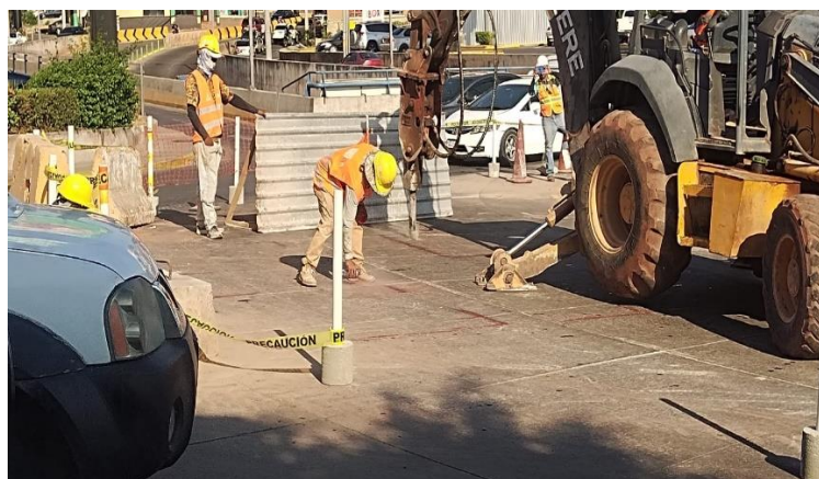
Ilustración 140 Marcado de demolición de pavimento rígido
