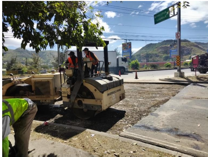
Ilustración 73 Compactación de relleno de material en tramo
