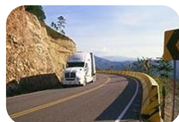
Supervisión pavimentación de la carretera Copán Ruinas - El Florido.
