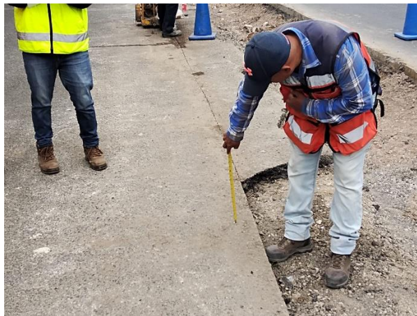
Ilustración 80 Medición de longitud, anchos y espesores de bordillo
