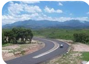
Supervisión sección I. Desvío San Antonio Libramiento de Comayagua, CA-5 Norte.
