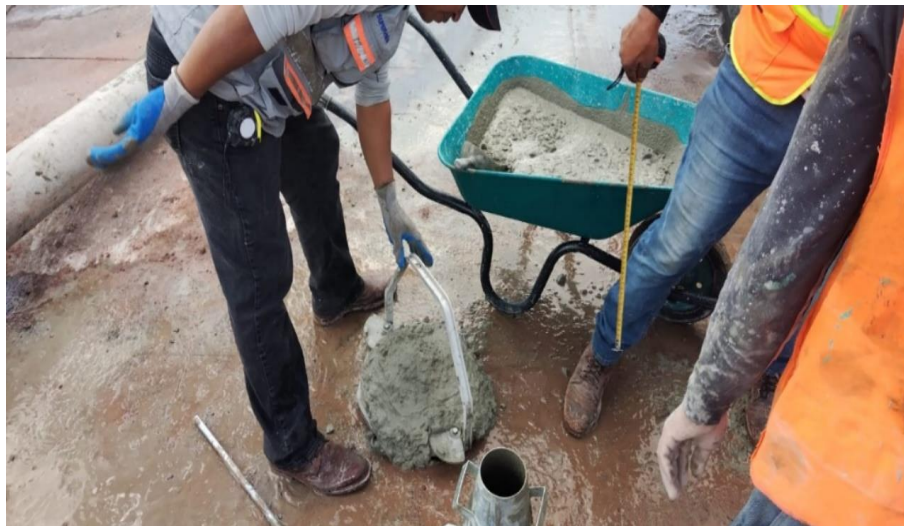
Ilustración 156 Medición de revenimiento de concreto
