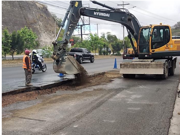
Ilustración 79 Relleno con material de bordillo con excavadora
