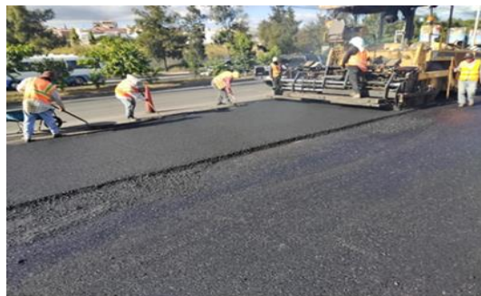
Ilustración 67 Colocación de sobre carpeta
