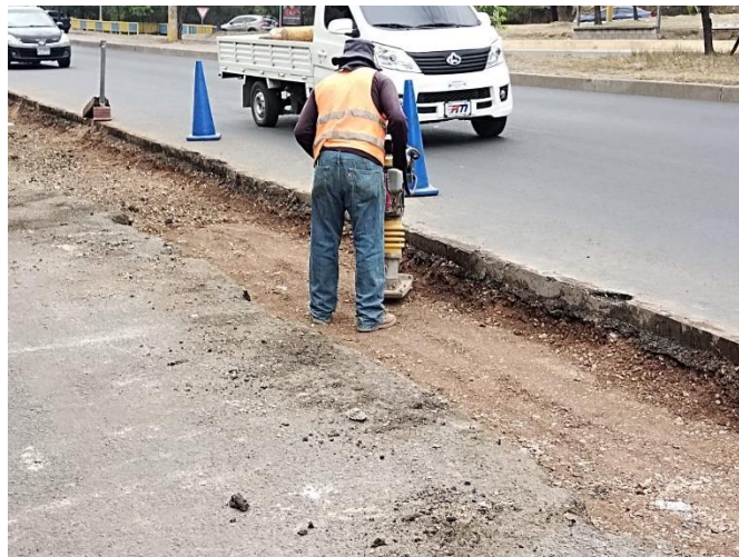
Ilustración 81 Compactación de relleno con máquina bailarina
