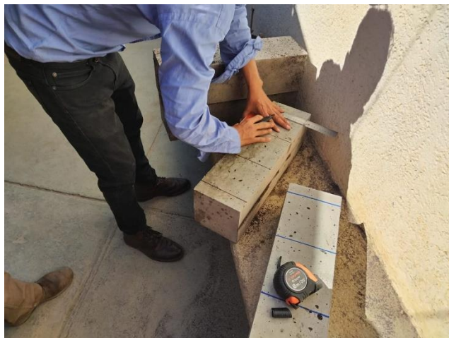
Ilustración 120 Trazado de medidas en viga de concreto
