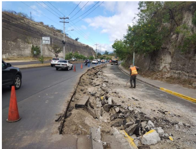
Ilustración 77 Eliminación de bordillo y limpieza de área
