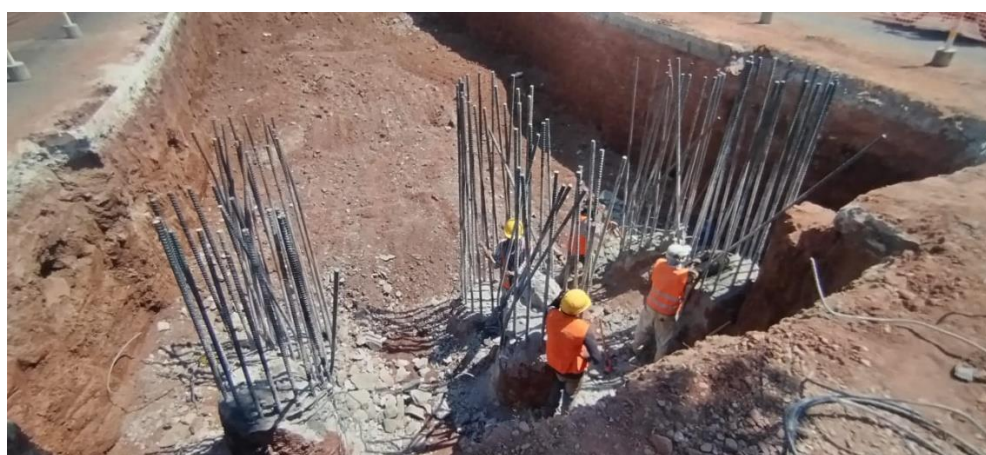
Ilustración 145 Remoción de piedra de pilotes de estribo No.1
