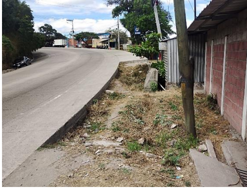
Ilustración 82 Limpieza y construcción de pavimento
