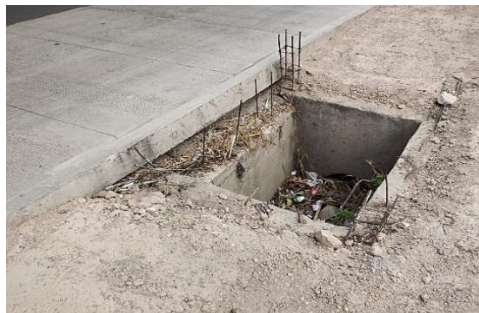
Ilustración 85 Realización de trabajo de tragante
