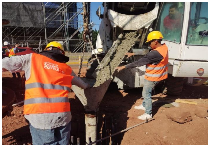
Ilustración 134 Fundición de pilotes
