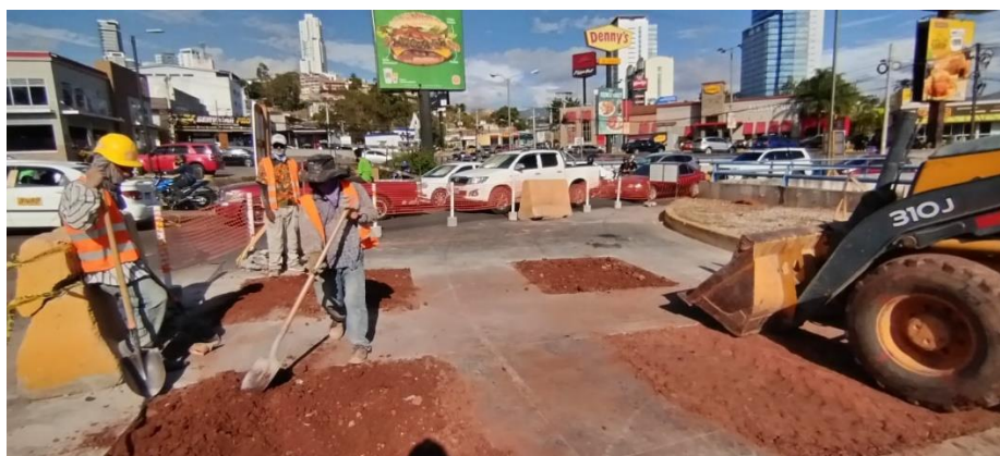
Ilustración 144 Relleno de pilotes de rotonda con material
