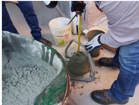
Ilustración 112 Medición de revenimiento de concreto
