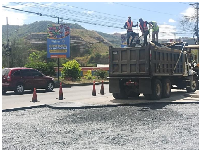
Ilustración 74 Pureo de asfalto sobre emulsión asfáltico
