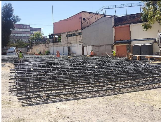
Ilustración 122 Armado de pilotes con varilla N°10
