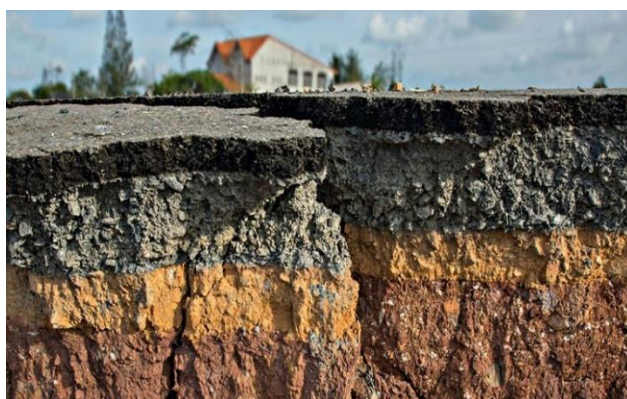
Ilustración 8 Mecánica de suelos
