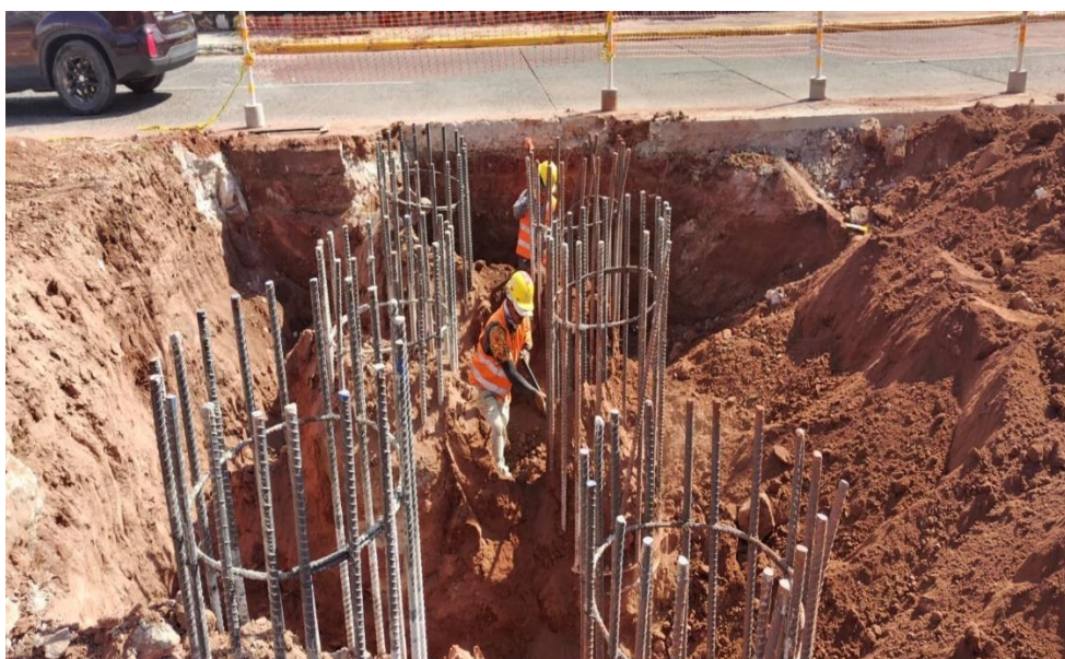
Ilustración 141 Inicio de excavación de estribo No.1
