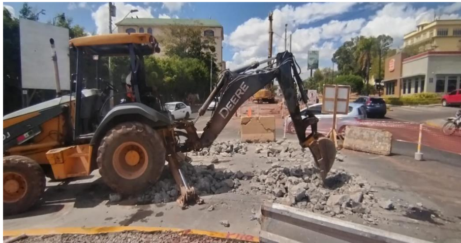
Ilustración 143 Demolición de pilotes de rotonda con retroexcavadora
