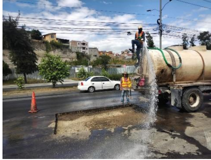
Ilustración 64 Tanque cisterna CCA-06 regando tramo para bacheo y sobre carpeta
