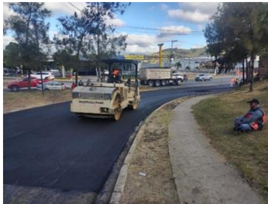
Ilustración 62 Compactación de capa asfáltica con máquina de rodillo liso COV-24
