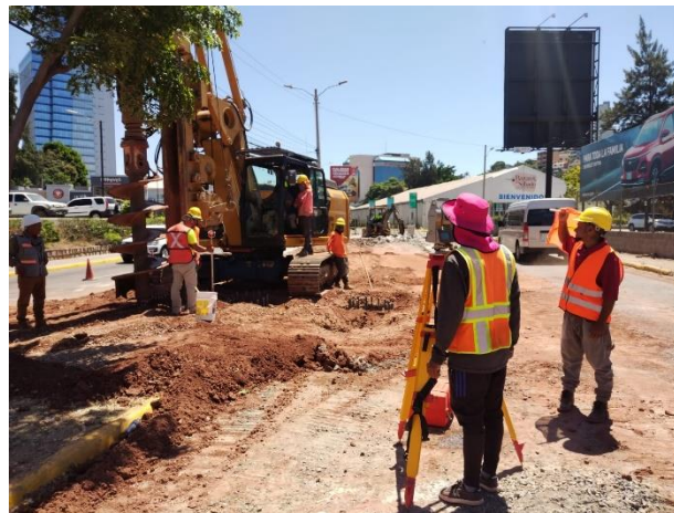
Ilustración 132 Marcado de punto de perforación con topografía
