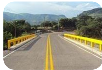
Supervisión, revisión del diseño y construcción de la carretera Choluteca - Orocuina
