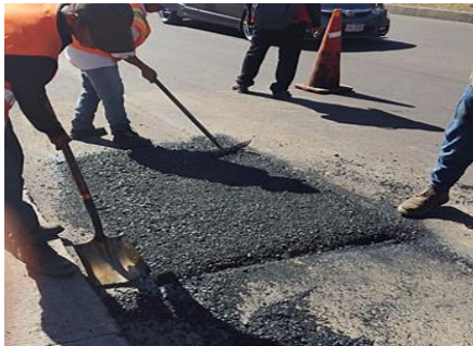
Ilustración 65 Nivelación de asfalto para bacheo
