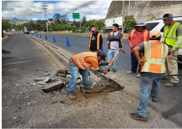
Ilustración 76 Eliminación de bordillo con herramientas y excavadora
