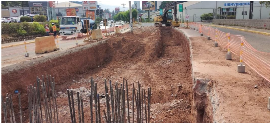
Ilustración 155 Avance de excavación de estribo No.1 con retroexcavadora
