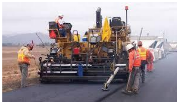
Ilustración 37 Sobre carpeta asfáltica
