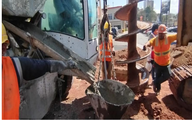
Ilustración 138 Vertido de concreto en pilote
