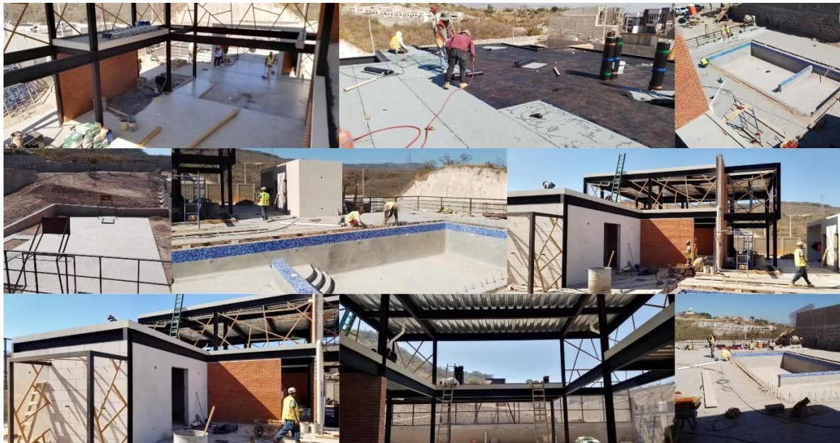
Ilustración 63 - Supervisión de avance de obra en Residencial El Sauce
