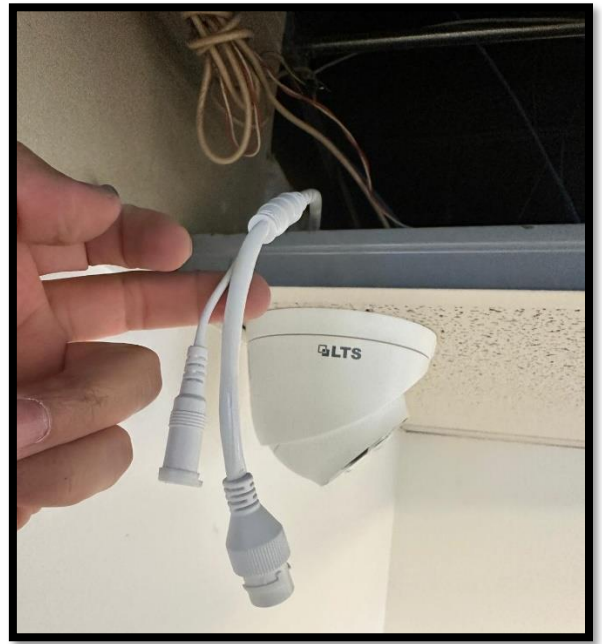
Ilustración 36 instalación de cámaras de seguridad
