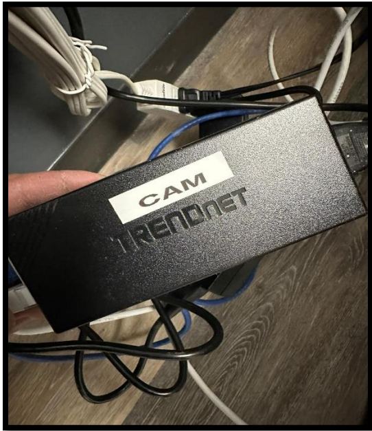
Ilustración 35 instalación de cámaras de seguridad
