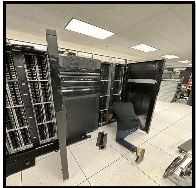
Ilustración 26 desmontaje de rack
