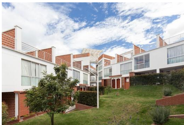
Ilustración 40: Complejo Residencial Villanueva. Fuente: ArchDaily
