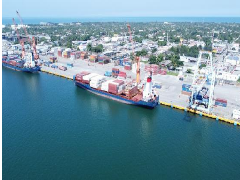
Figura 13. Terminal Contenedores en Puerto Cortés
