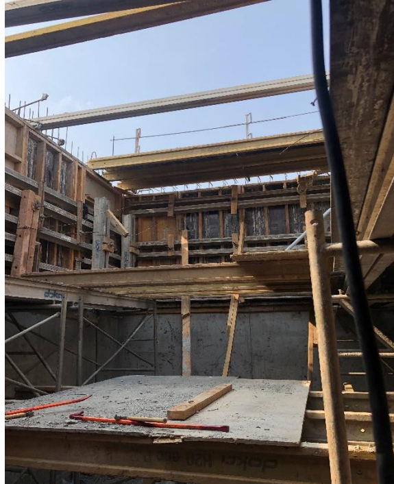
Ilustración 45 Desencofrado de cubo Sur en N-4
