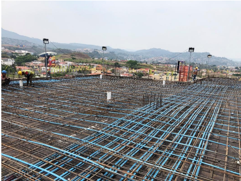
Ilustración 40 Nivel 6 losa postensada
