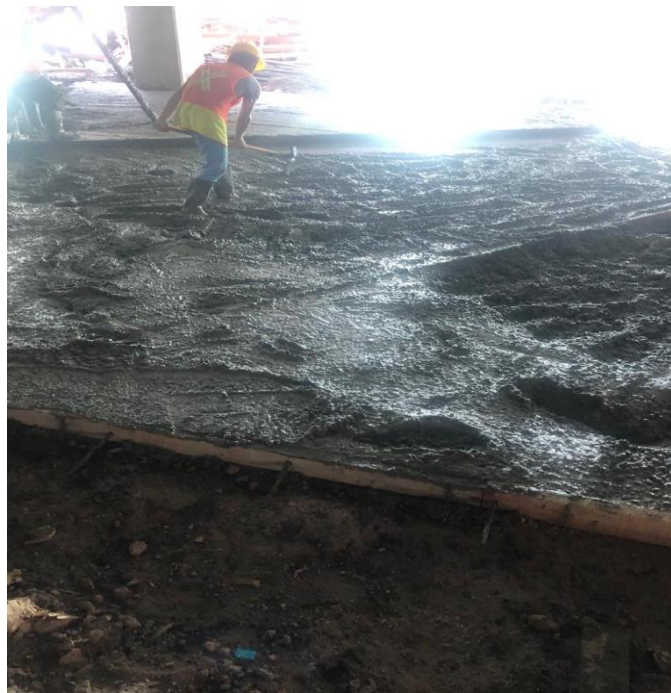
Ilustración 79 Fundición de firmes en S1
