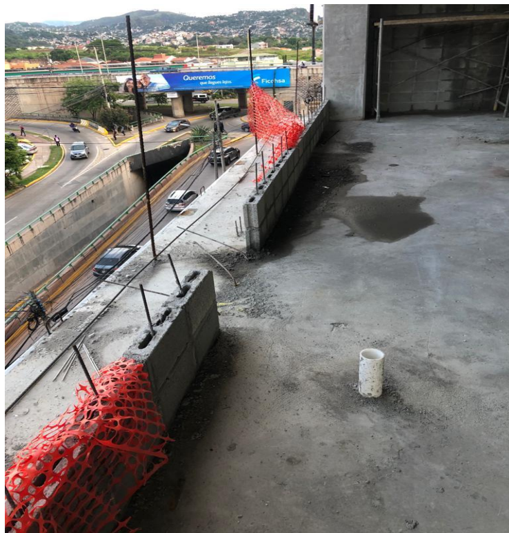
Ilustración 101 Murete de 0.44 cm en perímetro de nivel 4
