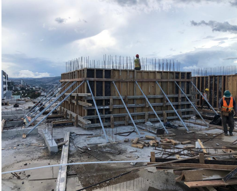
Ilustración 100 Encofrado en el nivel 6
