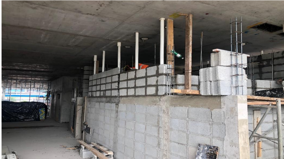
Ilustración 42 Levantamiento de obra
