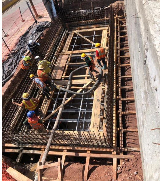
Ilustración 65 Fundición de paredes de cisterna
