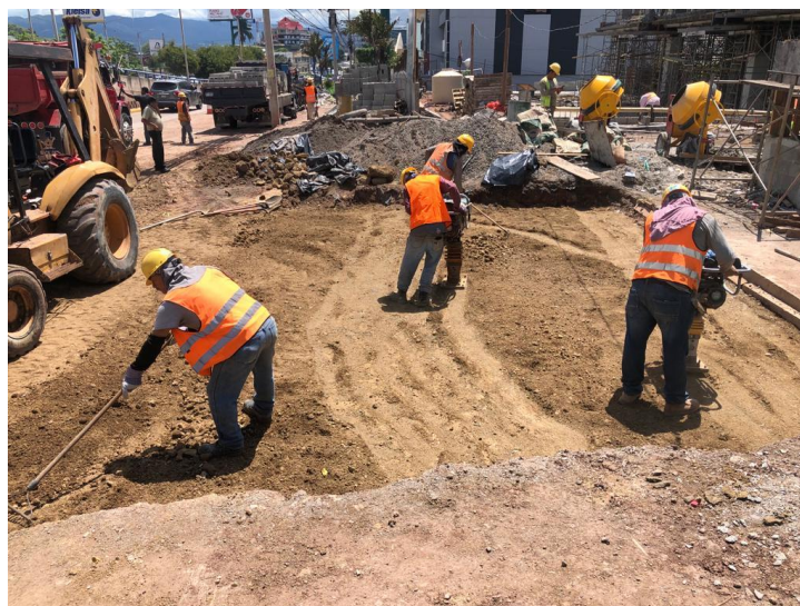
Ilustración 106 Capa de material selecto para pavimentación
