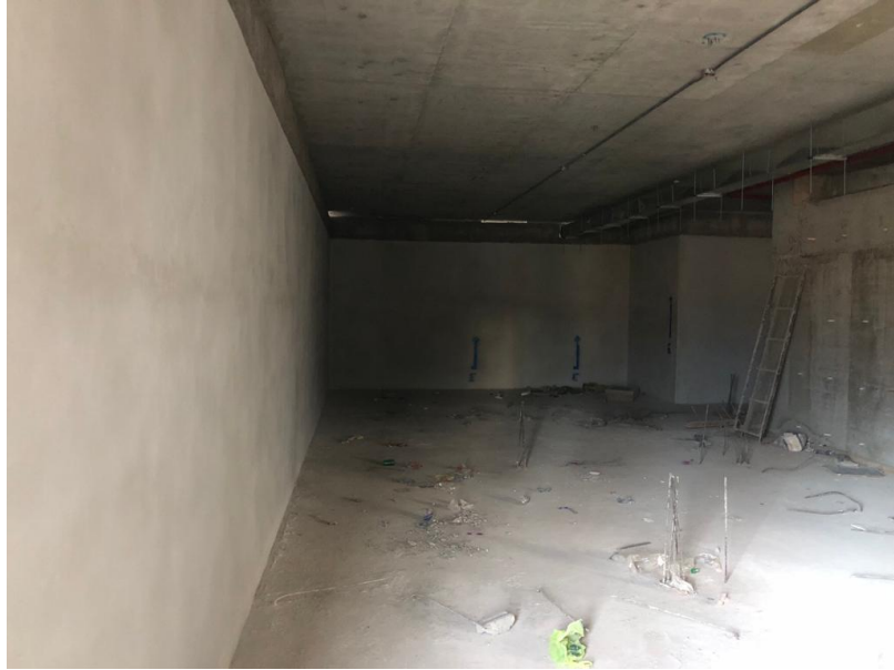
Ilustración 104 Levantamiento de obra con SERCONSA
