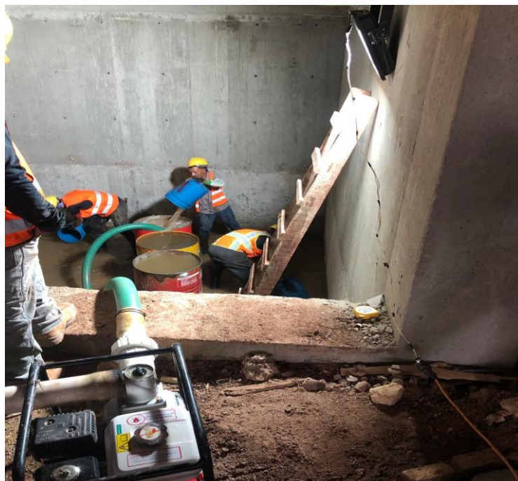
Ilustración 96 Extracción de agua en cubos de gradas
