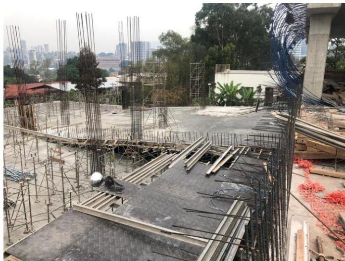
Ilustración 70 Losa terminada en S3
