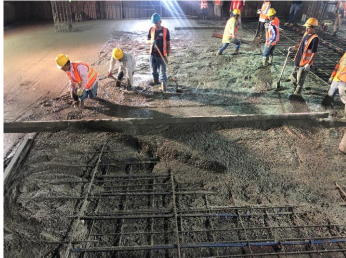
Ilustración 69 Nivelación de concreto vertido en S3
