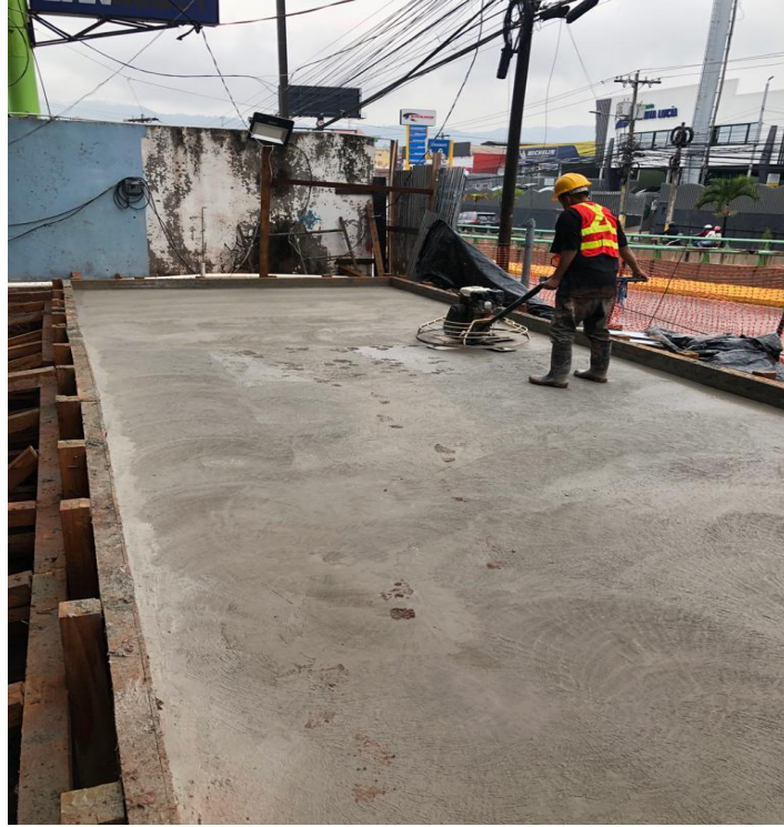
Ilustración 73 Helicóptero en losa de cisterna.
