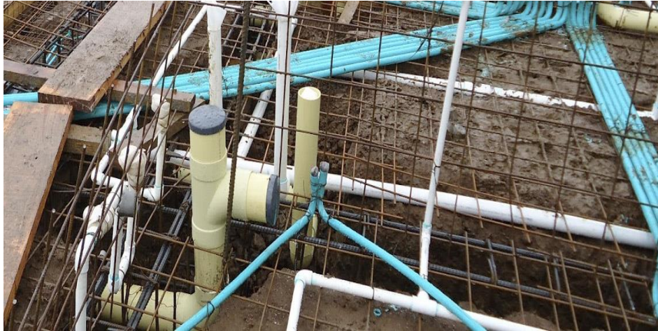
Ilustración 23 Instalaciones hidrosanitarias en losa
