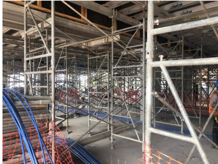
Ilustración 59 Limpieza de N4
