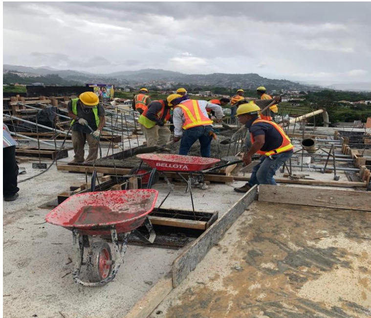
Ilustración 105 Fundición de dados de concreto
