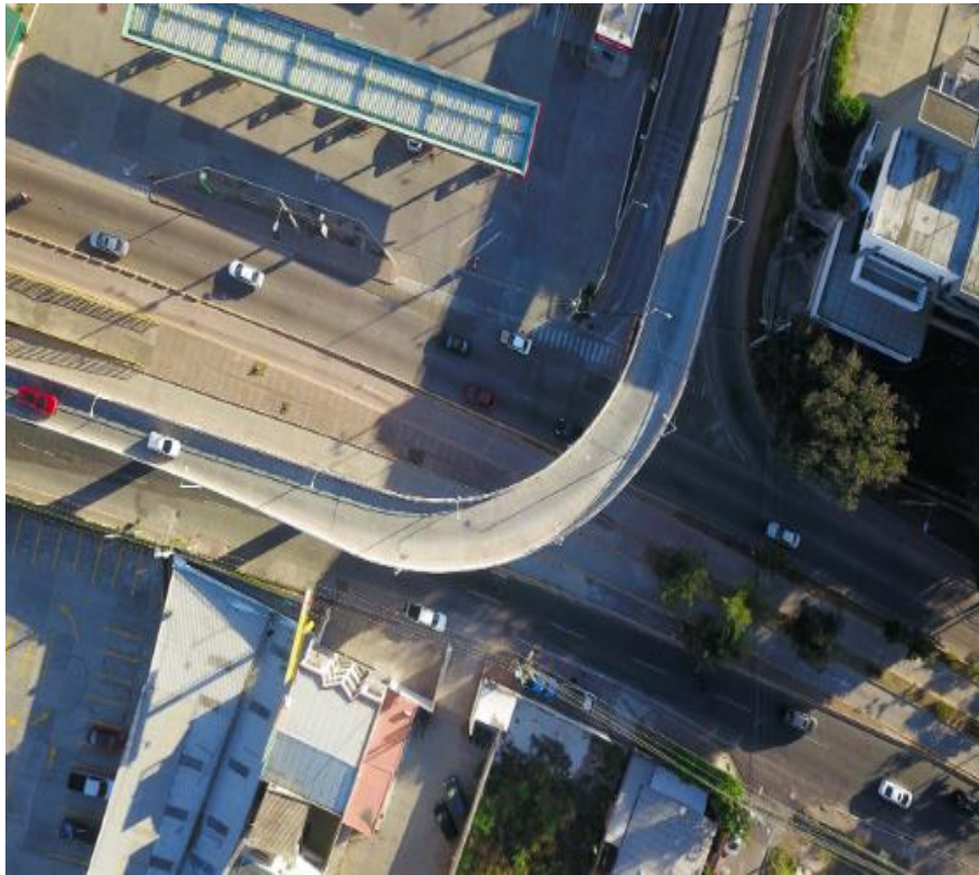
Ilustración 12 Paso a desnivel Bulevar Suyapa, Tegucigalpa
