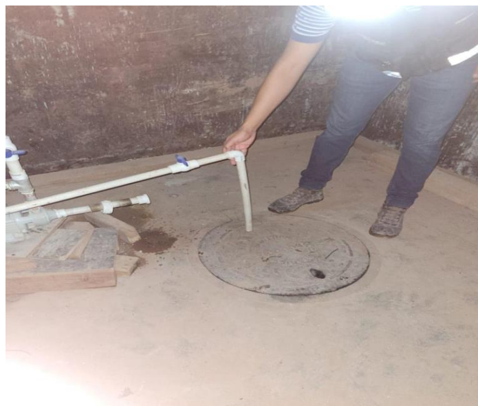
Ilustración 108 Reparación de bomba de agua
