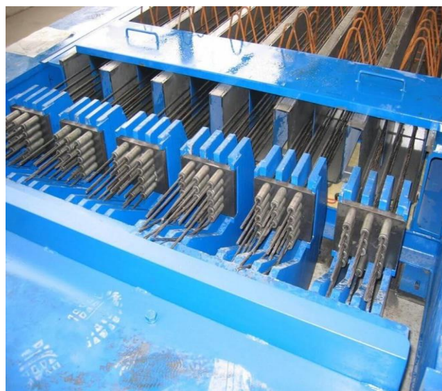
Ilustración 31 Armado de cableado pretensado
