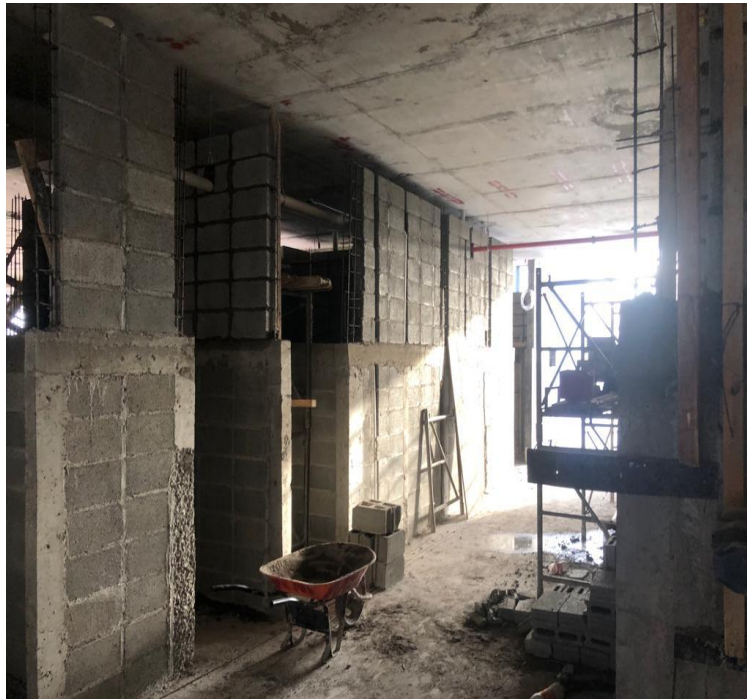
Ilustración 95 Paredes de bloque nivel 4
