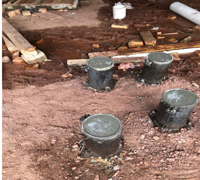
Ilustración 75 Pruebas de concreto del concreto vertido en losa de cisterna
