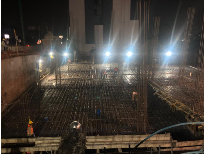
Ilustración 67 Armado de losa listo y encofrado del S3 modulo B
