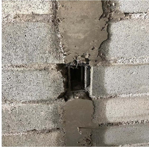
Ilustración 80 Desencofrado de castillos
