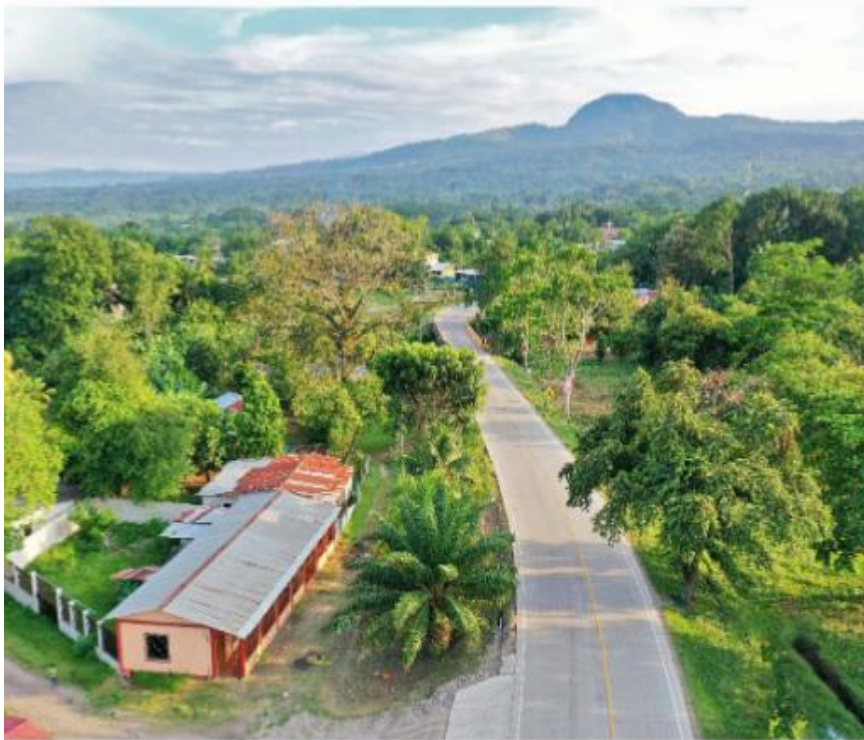
Ilustración 14 Carretera Río Lindo
