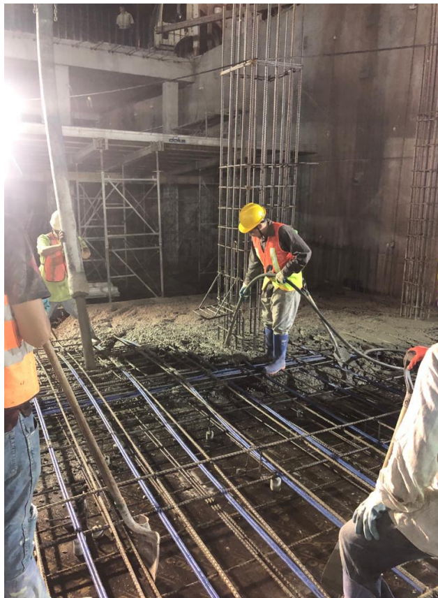
Ilustración 68 Vertido de concreto en S3
