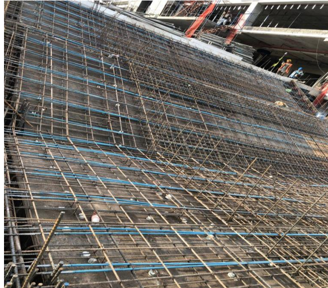
Ilustración 87 Armado de escalinata con acero inferior y superior
