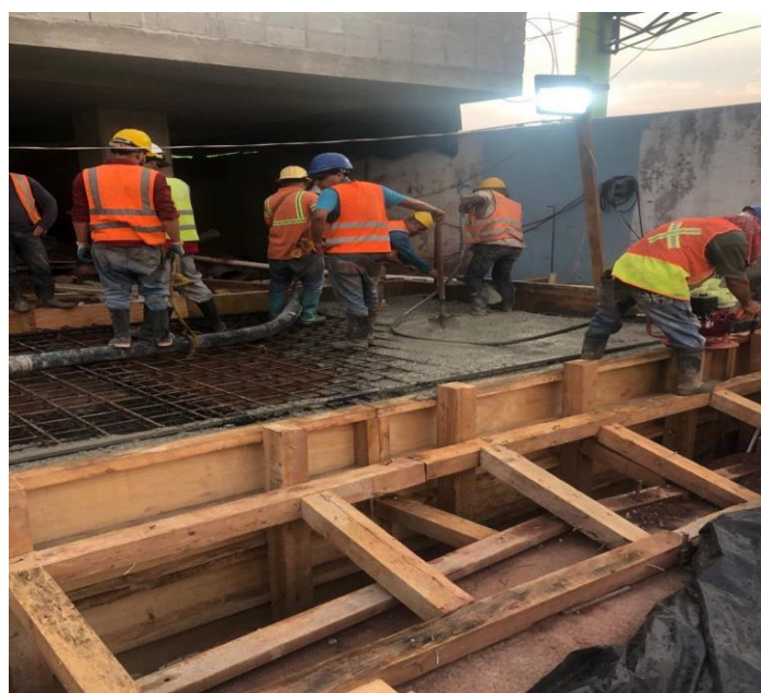
Ilustración 72 Fundición de losa de cisterna PTAR
