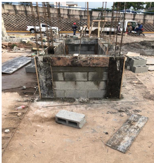
Ilustración 86 Avance de caseta de vigilancia
