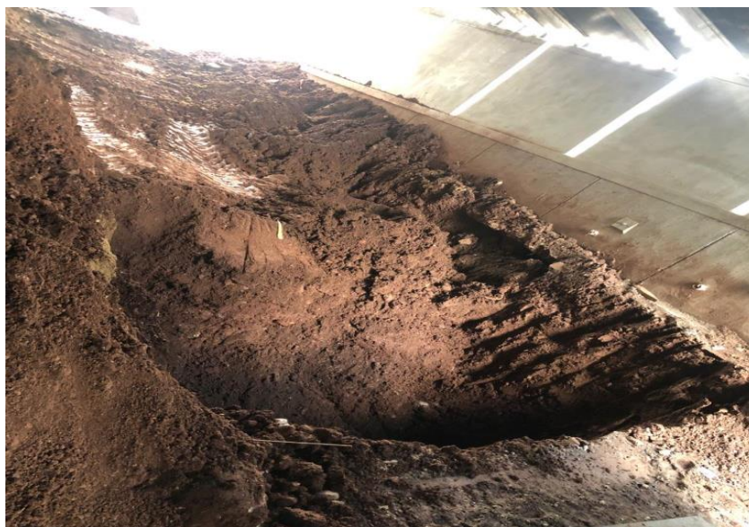
Ilustración 78 Excavación de PTAR
