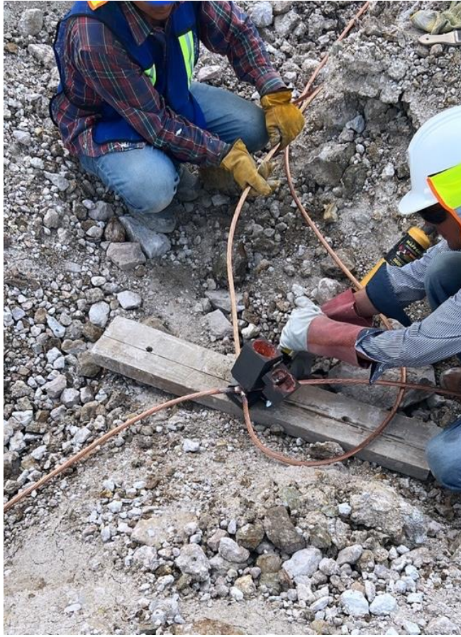
Ilustración 36-Soldadura Exotermica
