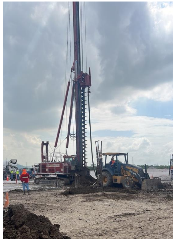
Ilustración 30-Excavacion para pilotes
