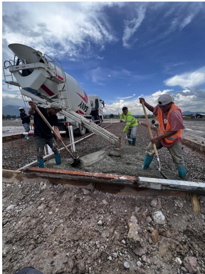
Ilustración 32-Fundición de losa de Oficinas
