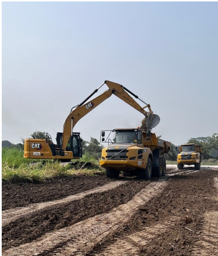
Ilustración 23-Descapote de area verde
