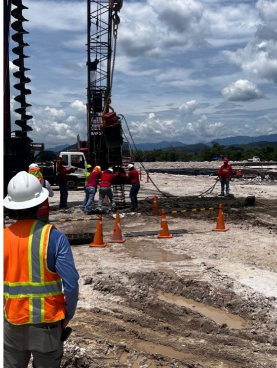
Ilustración 31-Colocacion de Armado de pilotes
