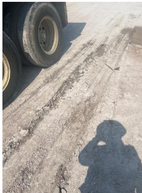
Ilustración 16-Pruebas de Carga con volqueta de 30 ton.
