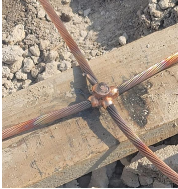
Ilustración 26-Soldaduras Exotermicas
