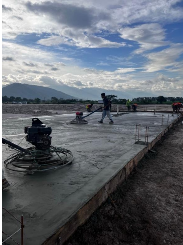
Ilustración 33-Finalizacion de losa de oficinas
