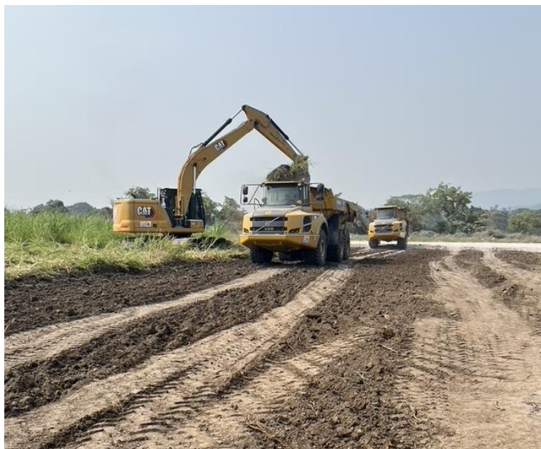
Ilustración 38-Corte & Acarreo corto
