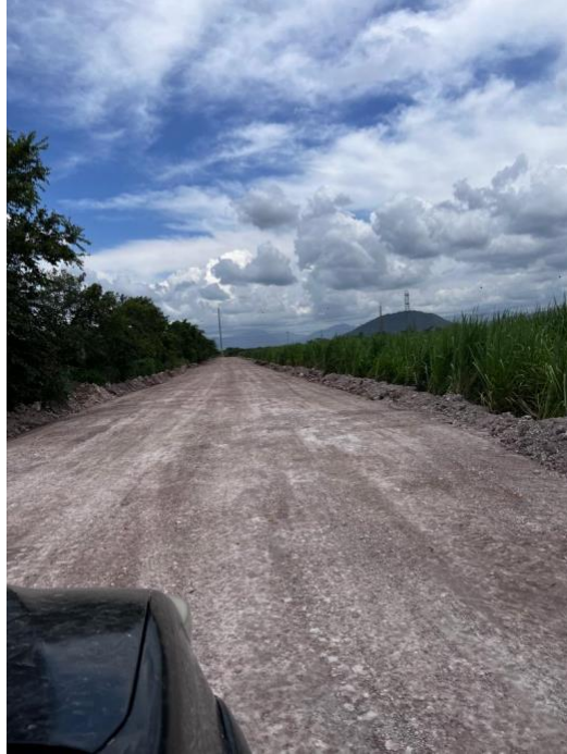
Ilustración 18-Carretera principal para el acceso al proyecto
