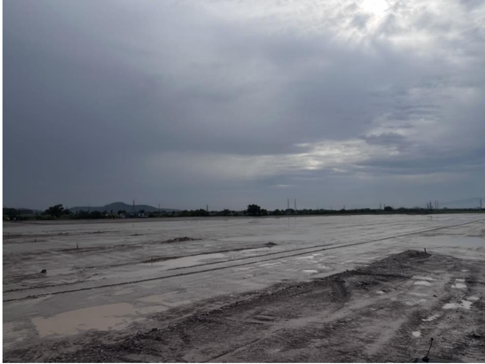
Ilustración 39-Saturacion del proyecto por lluvia
