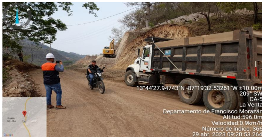
Ilustración 31 – Excavación Común corte de talud
