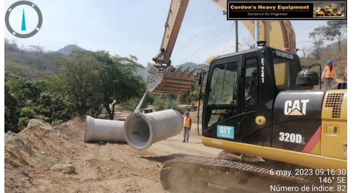
Ilustración 7- Bajado de tubería 2+340
