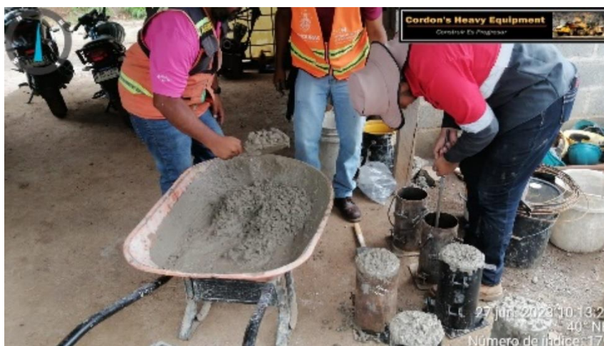
Ilustración 28 – Elaboración de testigos de fundición de losa para caja puente
