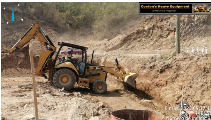
Ilustración 11- Relleno para alcantarilla 0+880
