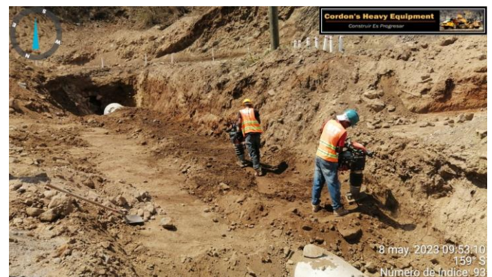
Ilustración 11- Relleno para alcantarilla 0+880
