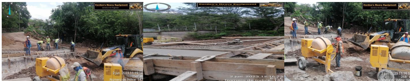
Ilustración 18 - Losa superior de caja puente
