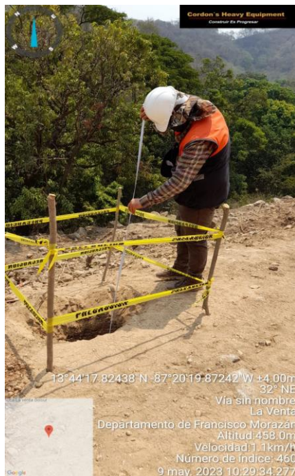
Ilustración 25- Inspección de calidad de excavación para instalación de postes de tendido eléctrico
