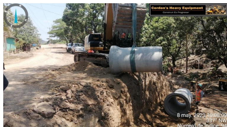
Ilustración 12- Colocación de tubería de 36 in 2+230
