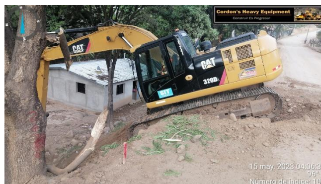
Ilustración 14- Excavación para muro E-2+280
