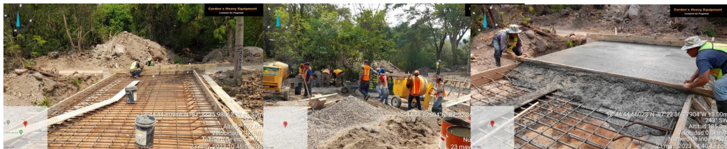
Ilustración 16 - Losa superior de caja puente.
