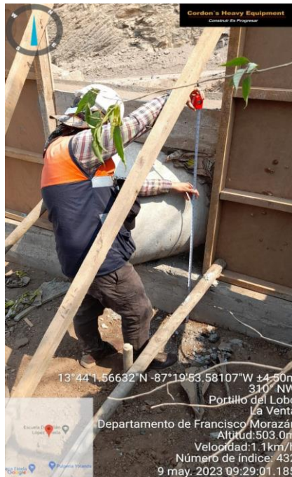
Ilustración 24 – Inspección de calidad de construcción de cabezales para TCR DE 30''
