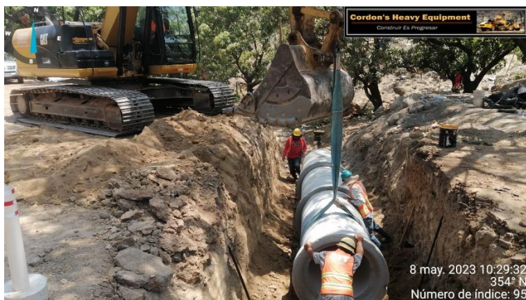
Ilustración 12- Colocación de tubería de 36 in 2+230
