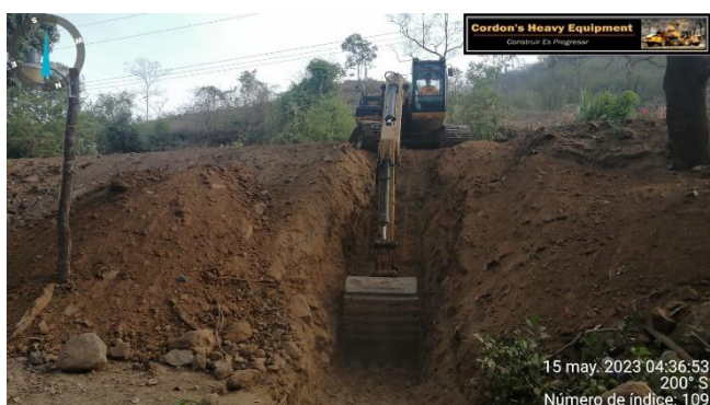
Ilustración 14- Excavación para muro E-2+280
