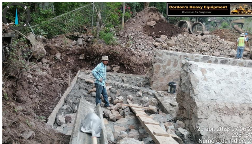
Ilustración 27 – Fundición de losa inferior para caja puente
