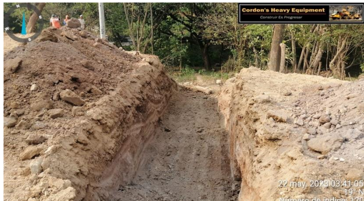
Ilustración 15- Excavación Para Instalación de TB30in
