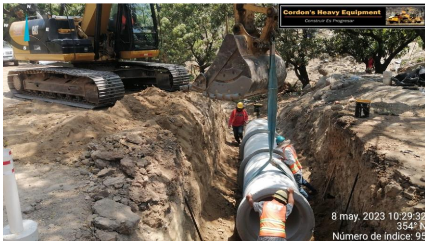
Ilustración 30 – Instalación de tubería TCR de 30"
