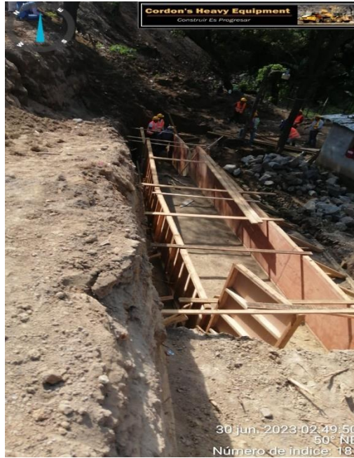
Ilustración 29 – Encofrado para construcción de muro de concreto ciclópeo
