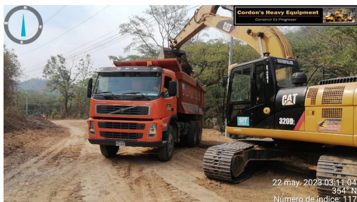
Ilustración 15- Excavación Para Instalación de TB30in
