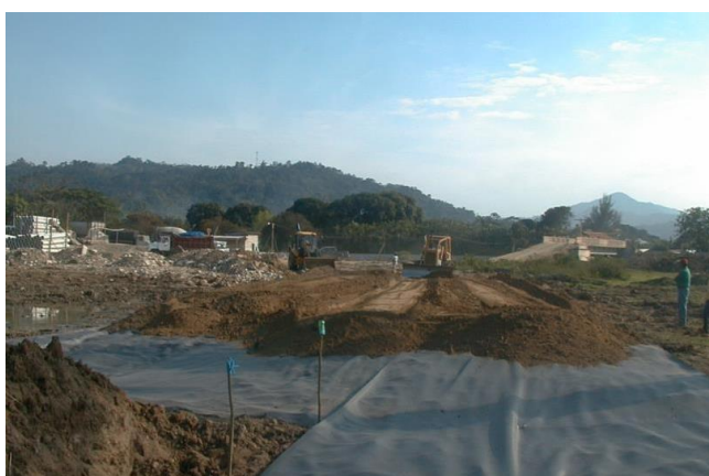
Ilustración 21 - Instalación y Supervisión de Malla Multiaxial
