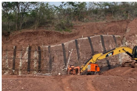
Ilustración 19 - Instalación y Supervisión de Geotextil
