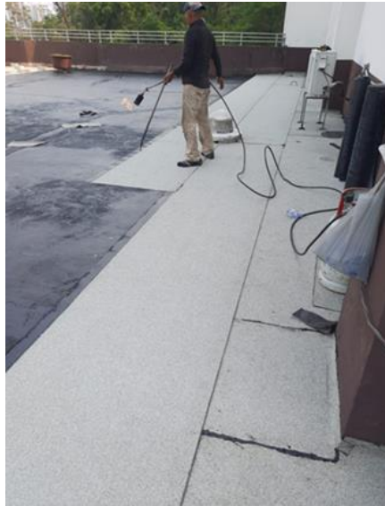
Ilustración 35-Membrana APP colocada y utilización de la antorcha
