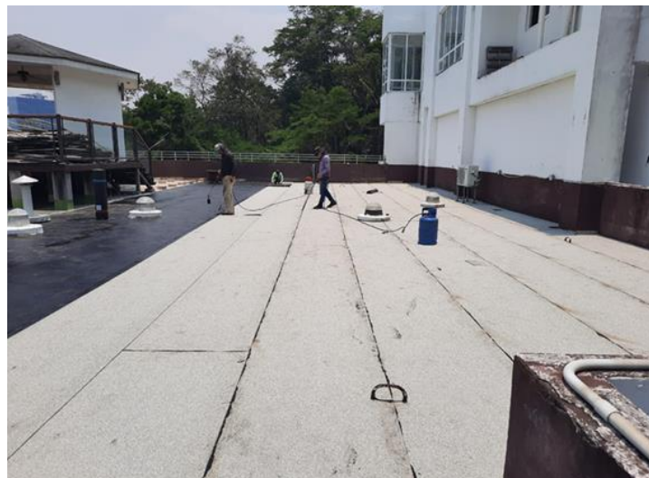
Ilustración 36-Primer área terminada con un largo de 26 m y ancho de 8 m
