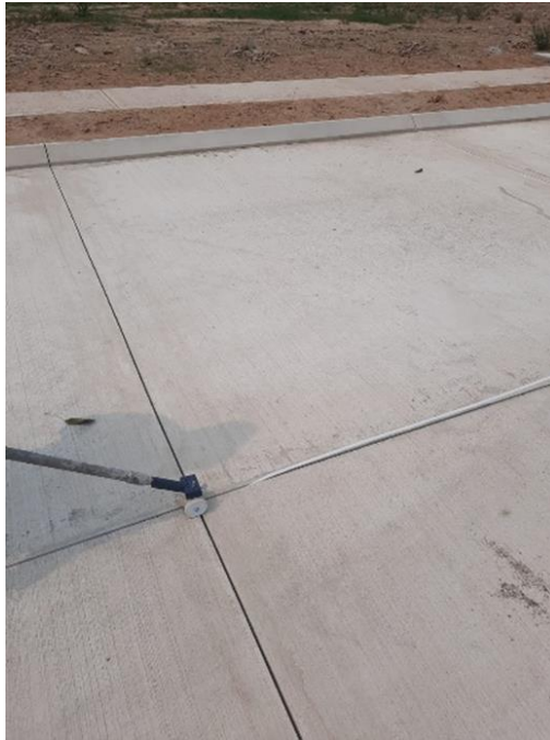
Ilustración 39-Colocación del cordón Cera Rod
