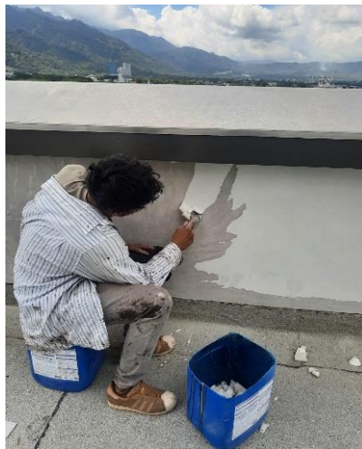
Ilustración 71-Remoción de producto existente en paredes con una espátula
