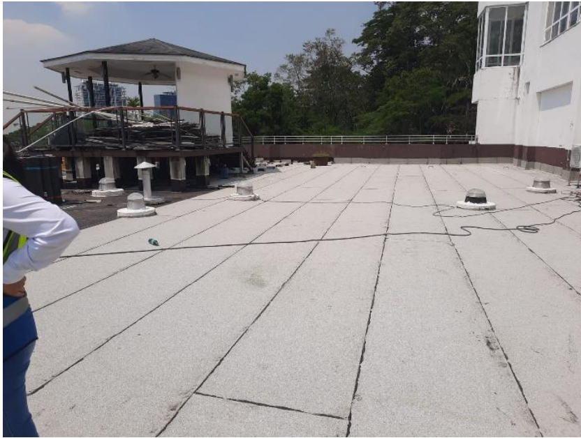
Ilustración 48-Avance de colocación de membrana APP
