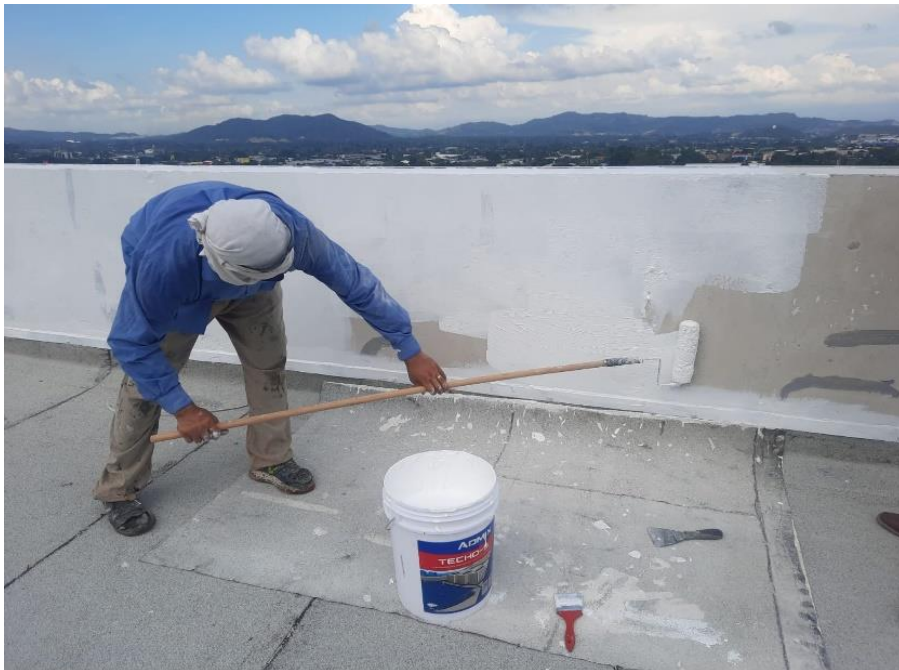
Ilustración 74-Aplicación de pintura impermeabilizante Admix Techo
