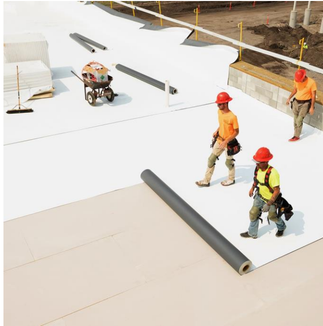
Ilustración 23-Instalación de membrana TPO
