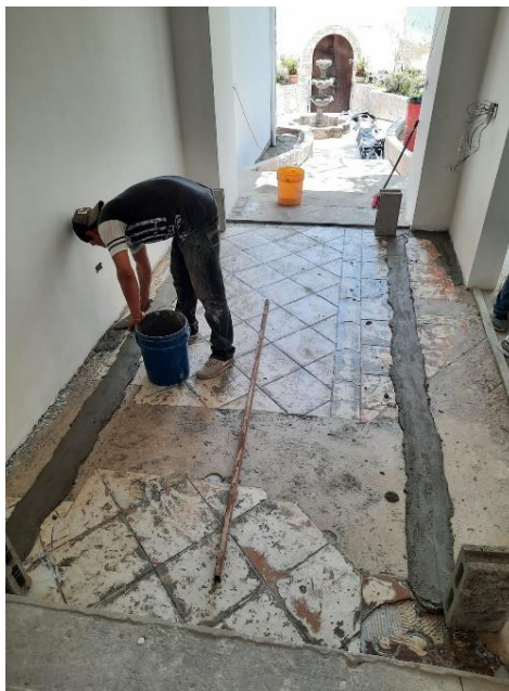
Ilustración 25-Nivelación de piso con Admix Level
