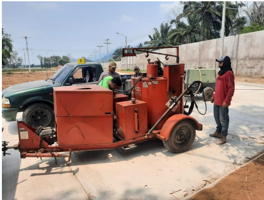
Ilustración 78-Caldera Crafcoc 2013 utilizada para sello de juntas
