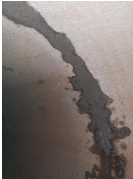
Ilustración 44-Fisuras reparadas de la tubería
