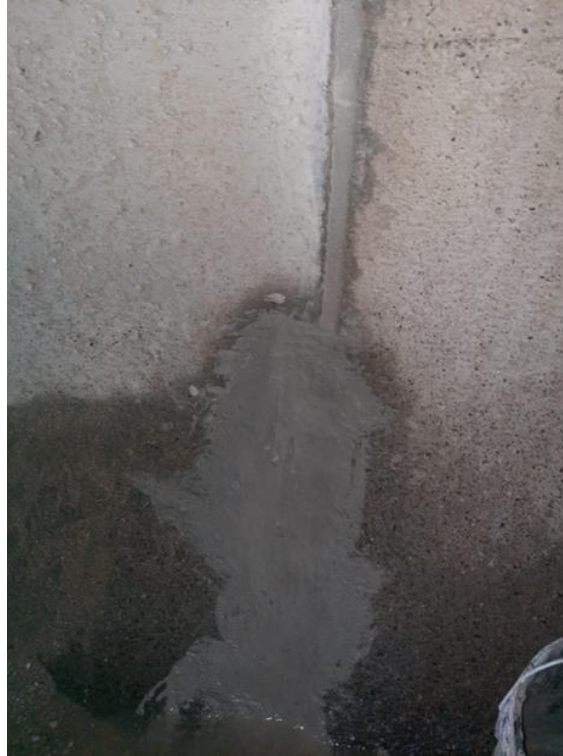
Ilustración 43-Reparación de aberturas en la tubería de concreto
