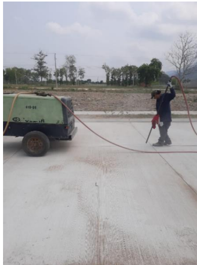
Ilustración 37-Compresor Industrial para la limpieza de juntas.
