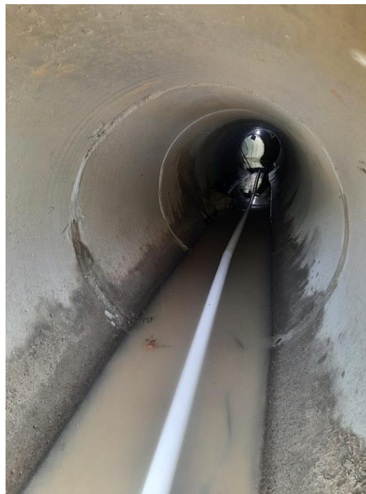
Ilustración 42-Colocación de tubos de pvc para desviación del agua
