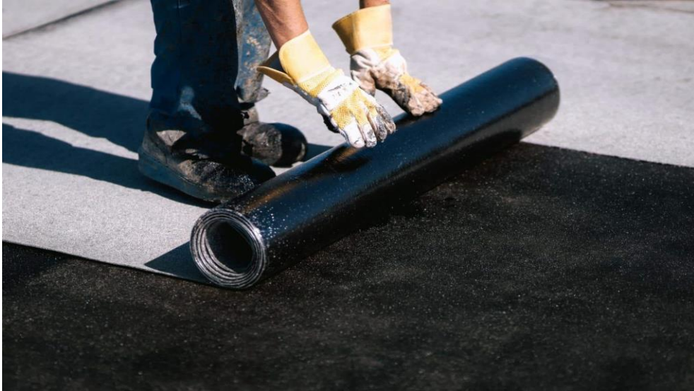
Ilustración 22-Colocación de membrana APP
