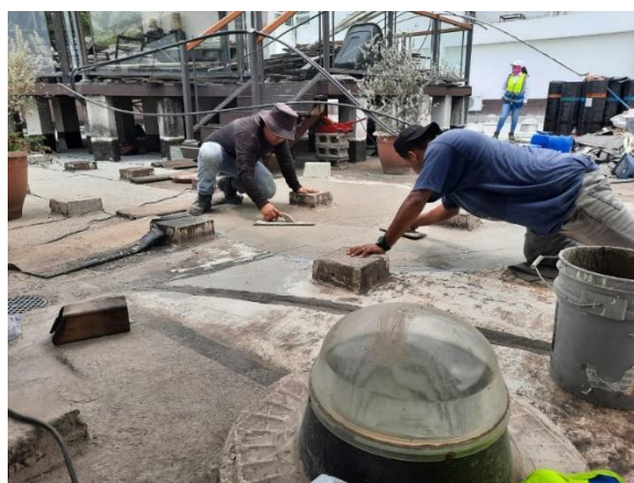
Ilustración 51-Enrasando al nivel deseado
