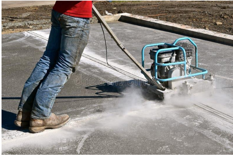
Ilustración 24-Corte de juntas en pavimento hidráulico
