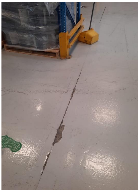
Ilustración 27-Juntas con desgaste/ Cummins
