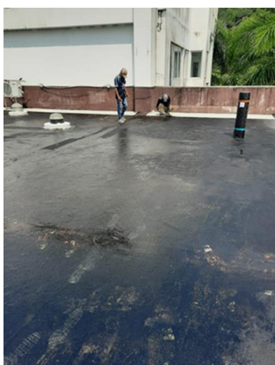
Ilustración 34-Emulsión asfáltica en azotea a impermeabilizar
