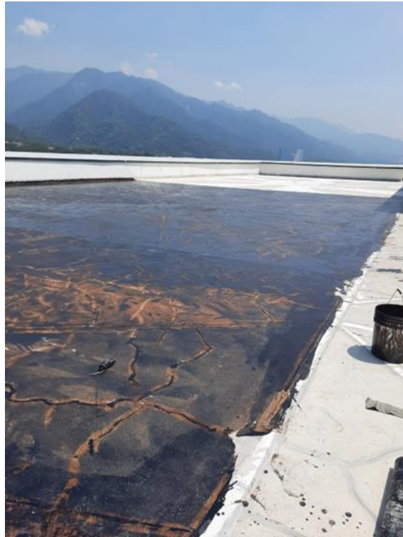
Ilustración 62- Aplicación de Admix emulsión sobre el área
