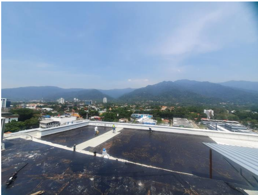
Ilustración 63-Área a impermeabilizar con la membrana APP
