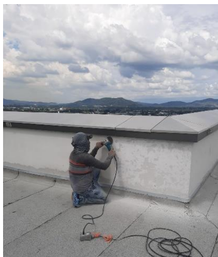
Ilustración 72-Remoción de impermeabilizante de techo con pulidora
