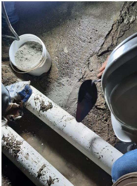
Ilustración 46-Utilización del producto Admix Plug para reparación de abertura
