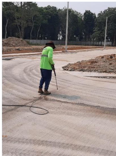
Ilustración 38-Limpieza de junta con Hidro Lavadora
