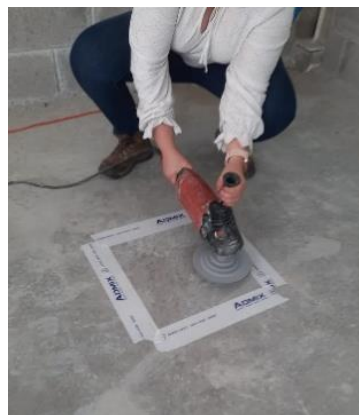
Ilustración 53-Pulido del piso sobre el área de la prueba
