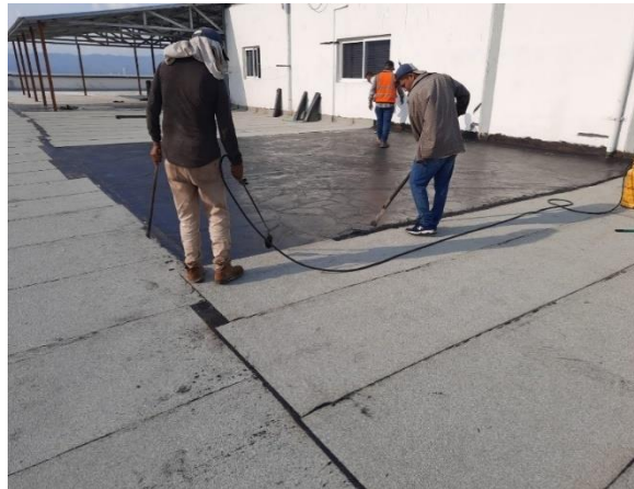
Ilustración 64-Embebido de grano para traslape
