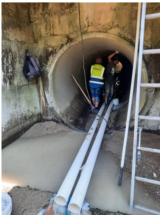
Ilustración 42-Colocación de tubos de pvc para desviación del agua
