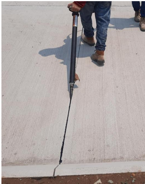
Ilustración 40-Aplicación del Sealright en caliente en junta
