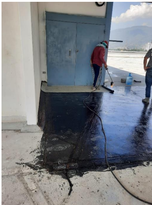
Ilustración 66- Aplicación de Admix emulsión en la entrada a la azotea
