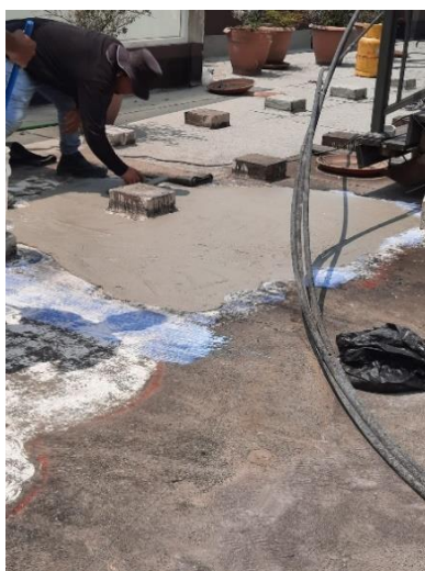
Ilustración 50-Aplicación de Admix level sobre la lechada de imprimación
