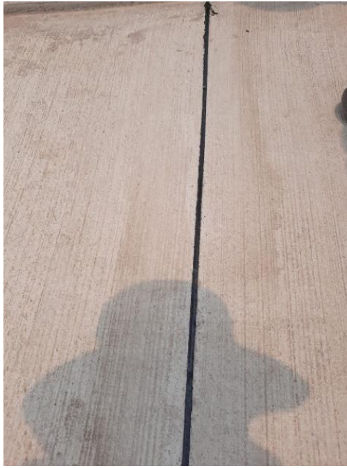
Ilustración 41-Resultado del sellado de junta
