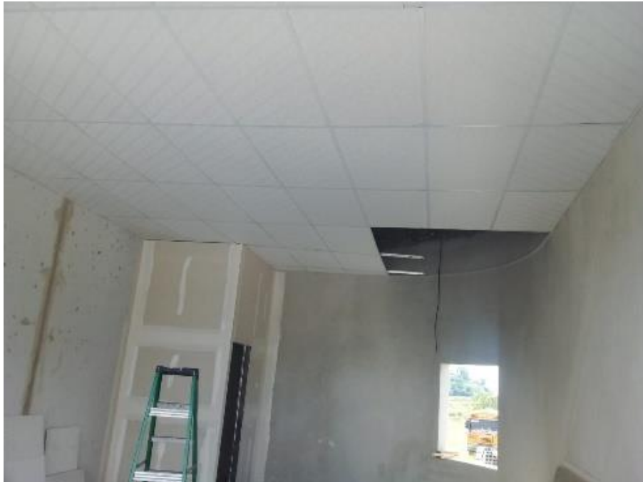
Ilustración 33 – Instalación de cielo falso
