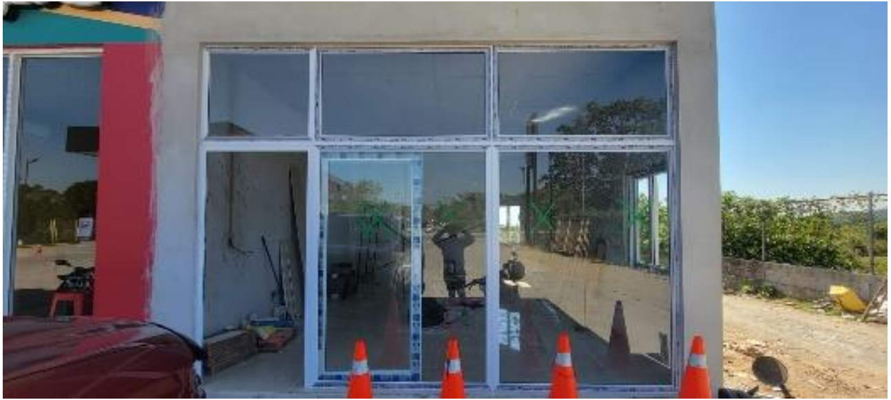
Ilustración 35 – Ventanales ya instalados.
