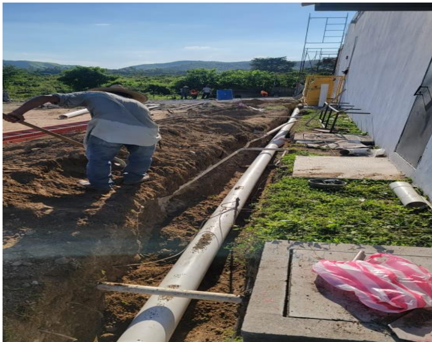
Ilustración 7 – Instalación de tubería de desagüe
