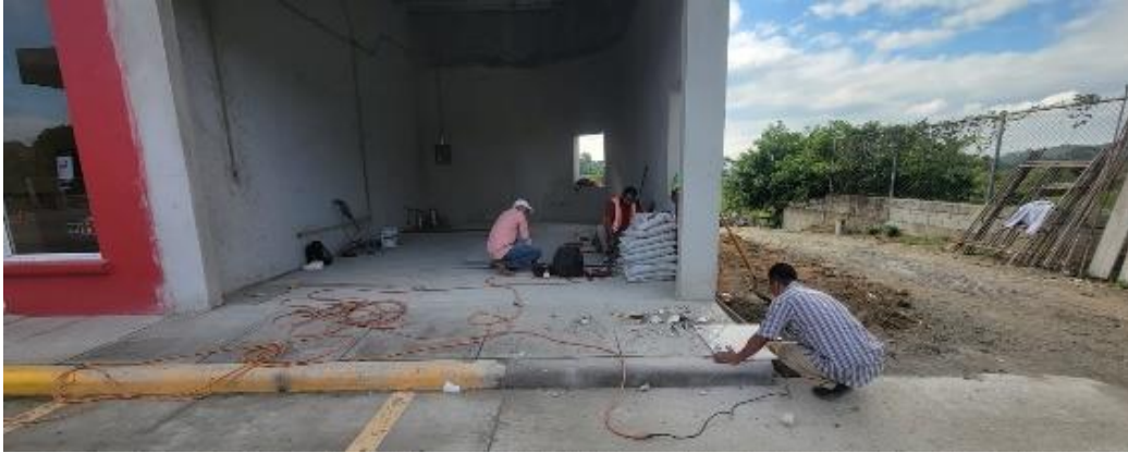
Ilustración 26 – Reparación de bordillo
