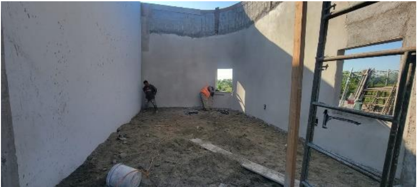
Ilustración 18 – Avance de pulido de las paredes interiores del local
