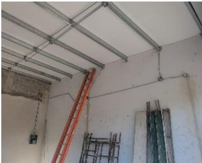
Ilustración 25 – Inicio de instalación de techo
