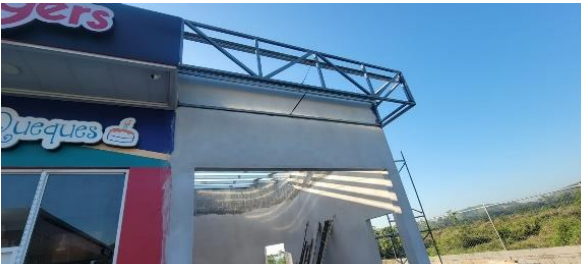
Ilustración 24 – Instalación de Joist
