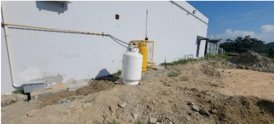
Ilustración 21 – Avance de fundición de Acera
