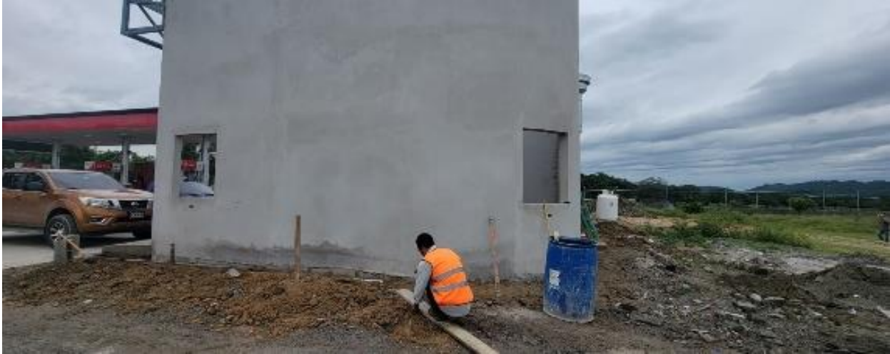
Ilustración 28 – Vista lateral de reparación de bordillo
