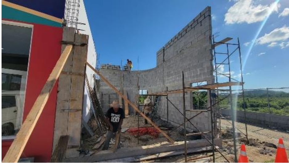
Ilustración 10 – Desencofrado de solera superior
