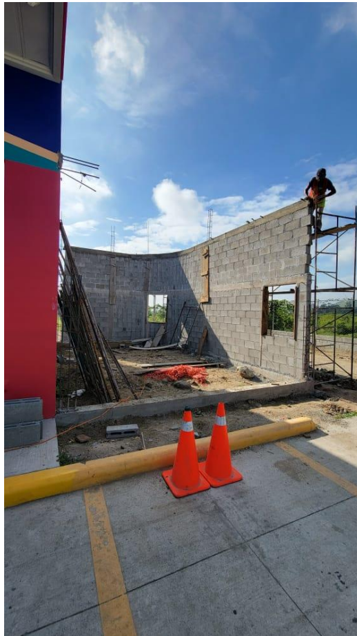
Ilustración 9 – Desencofrado de solera
