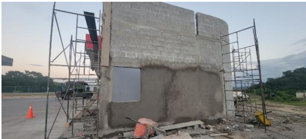
Ilustración 14 – Avance de repello en paredes exteriores
