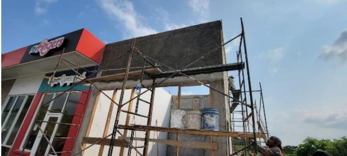
Ilustración 15 – Avance de encofrado de la jamba de cierre
