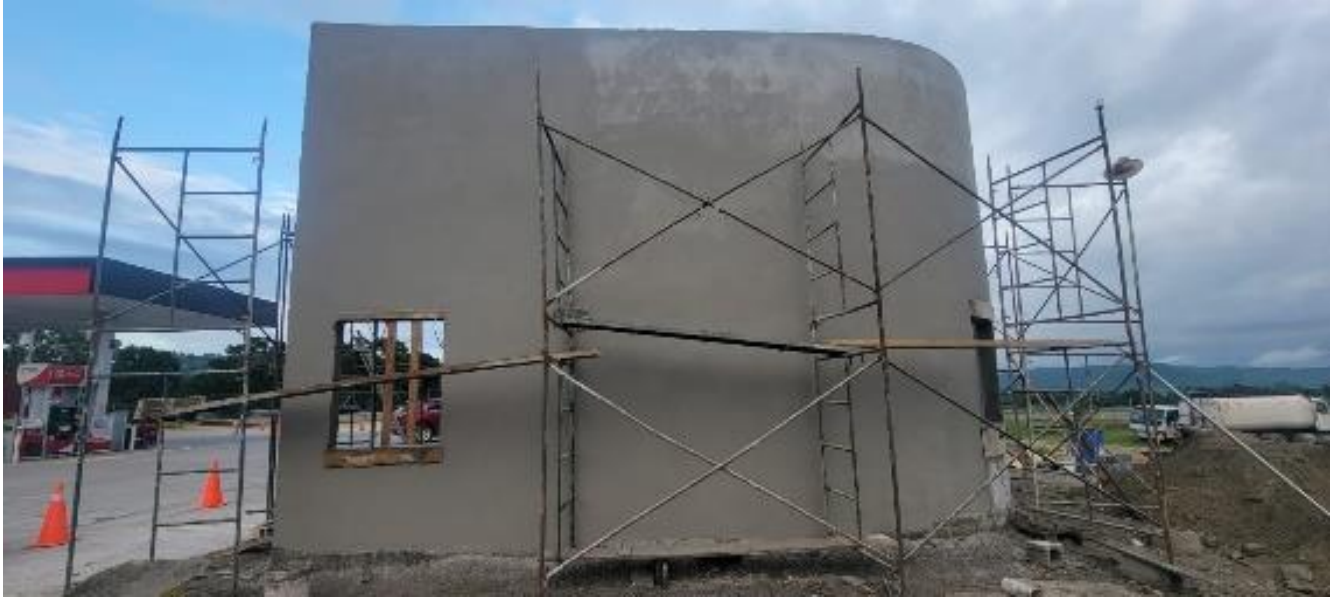
Ilustración 17 – Avance de pulido de las paredes exteriores del local
