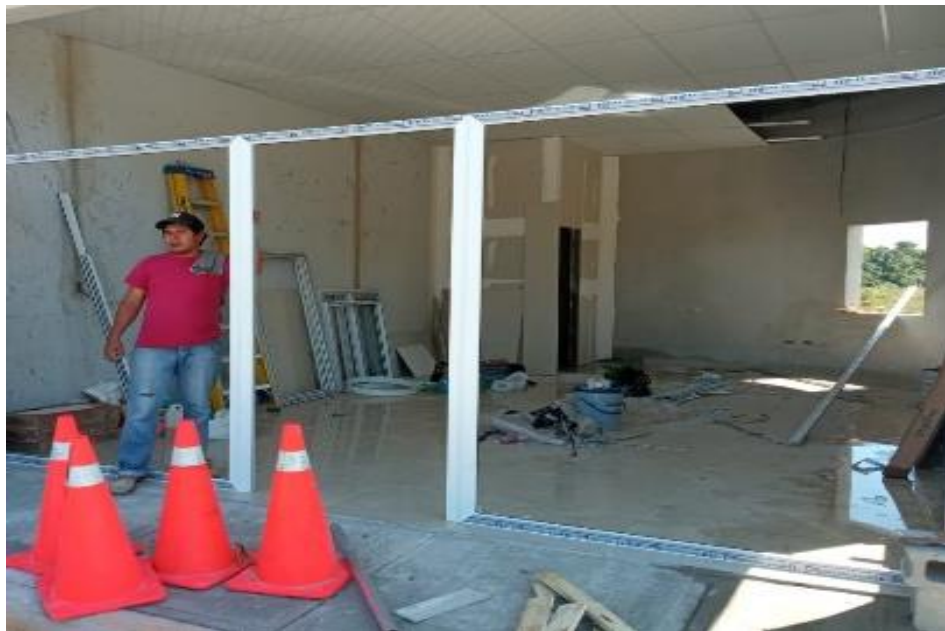
Ilustración 34 – Instalación de estructura para ventanales
