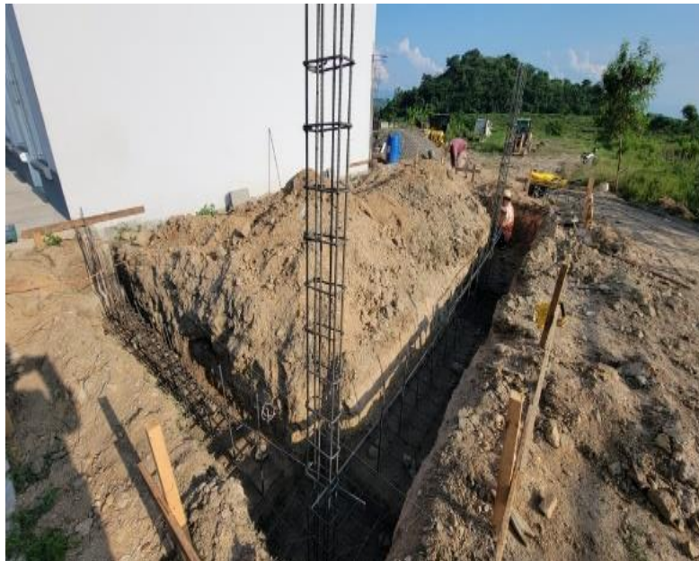
Ilustración 4 – Armado de castillos de hierro para fundición de zapatas
