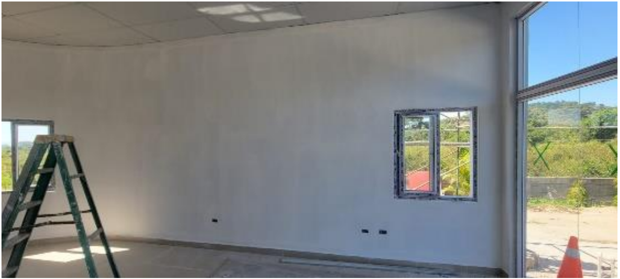
Ilustración 37 – Instalación de ventanales de autoservicio.
