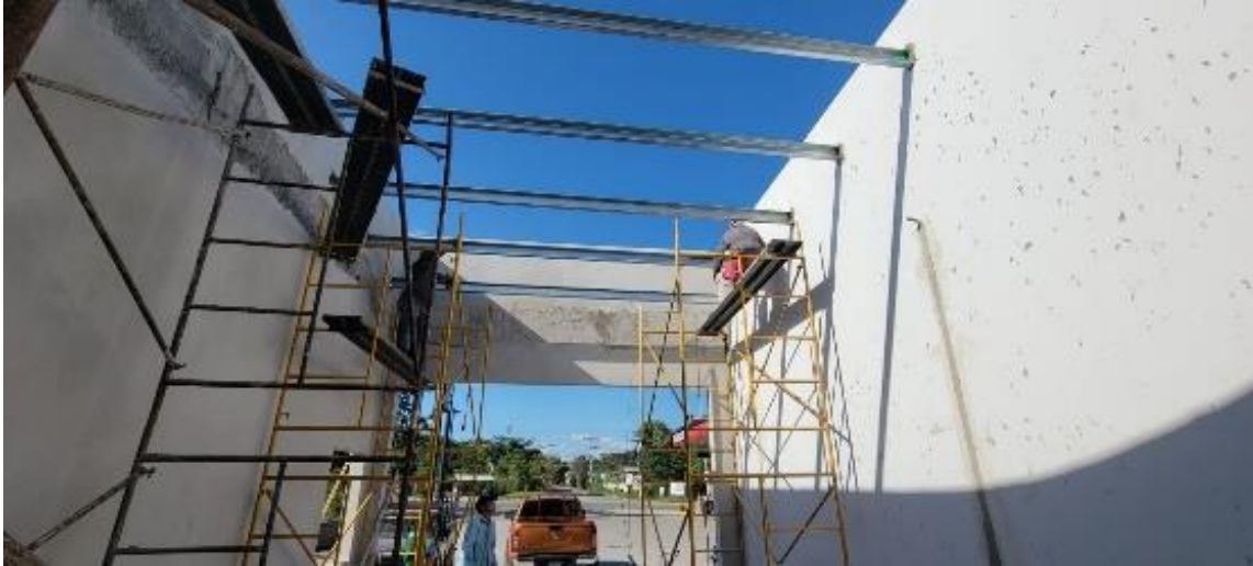
Ilustración 23 – Avance en instalación de techo
