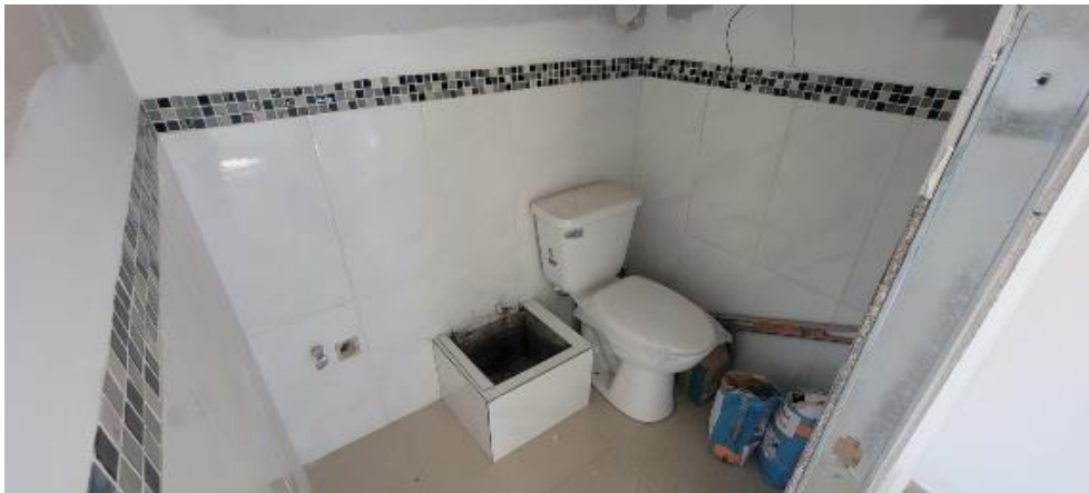
Ilustración 36 – Instalación de sanitarios
