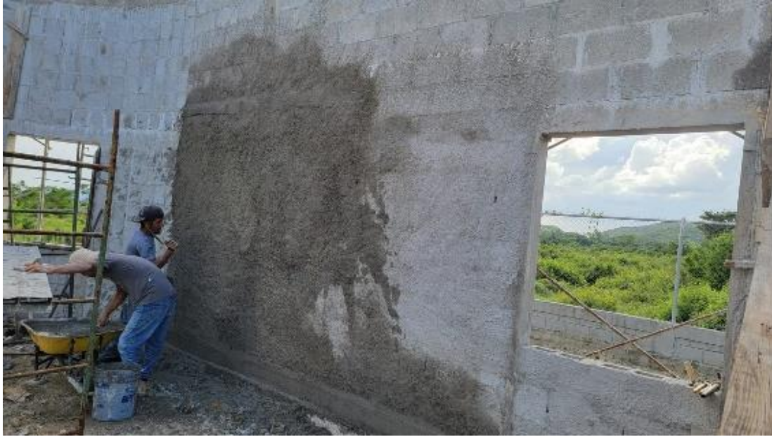
Ilustración 12 – Avances de repello internamente
