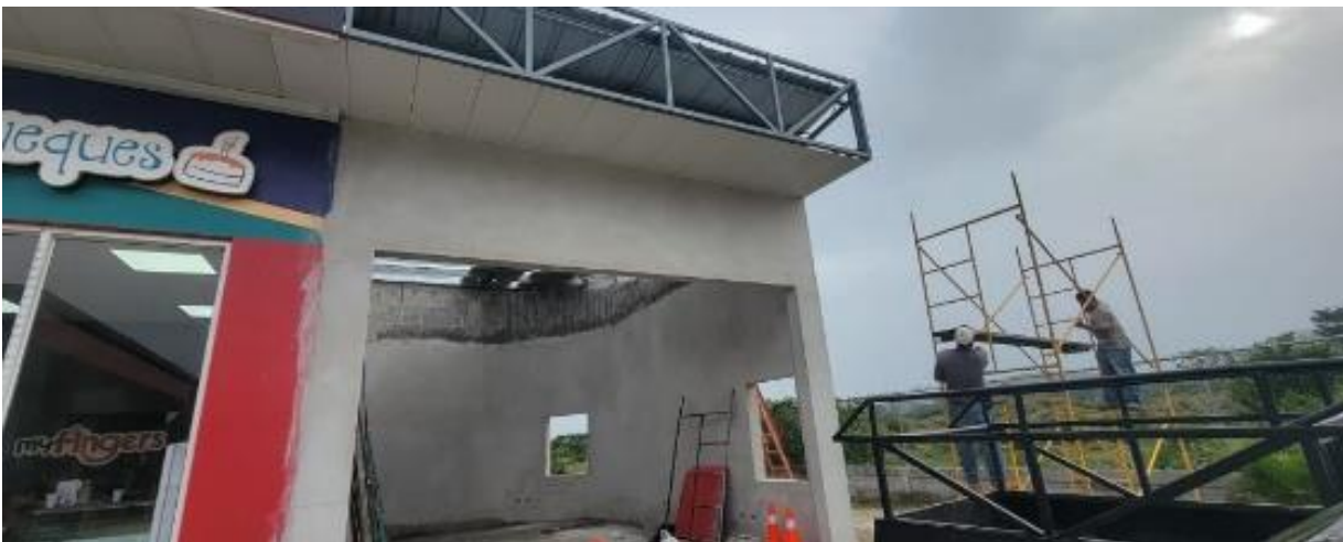
Ilustración 29 – Armado de techo
