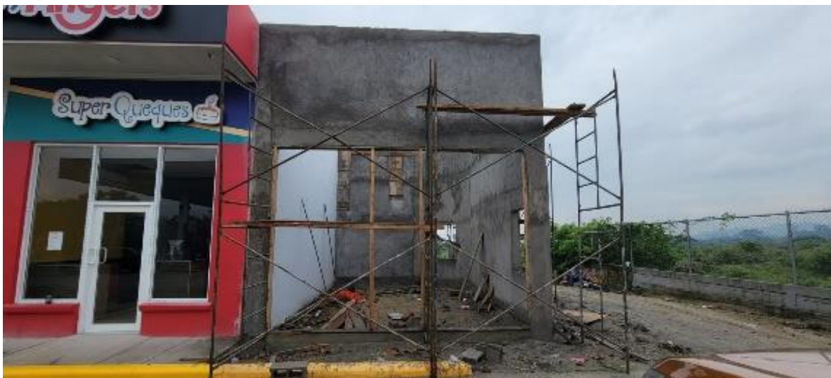
Ilustración 16 – Avance de repellado de las paredes exteriores del local
