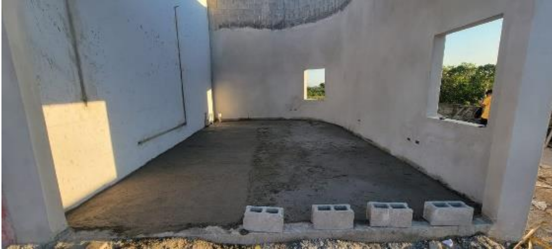
Ilustración 20 – Fundición de firme
