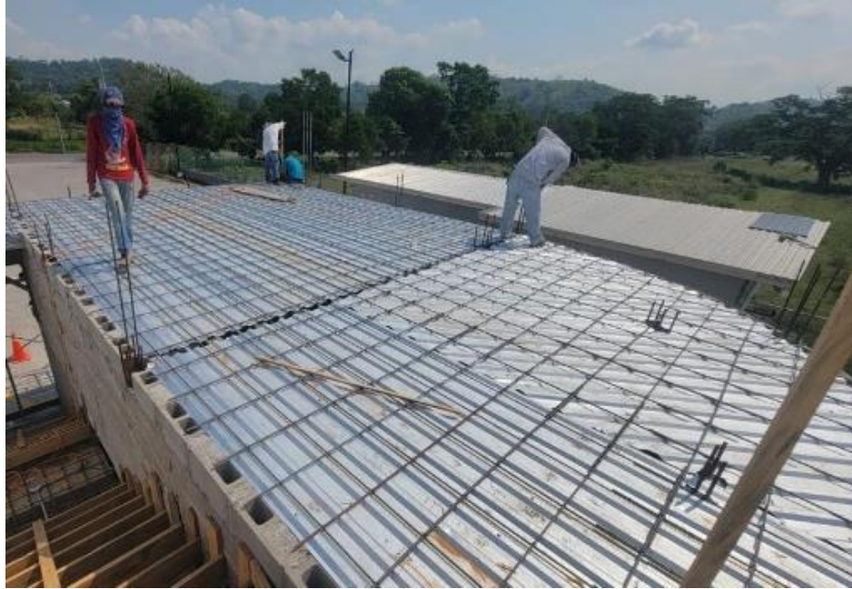
Ilustración 45 – Avance de entepiso
