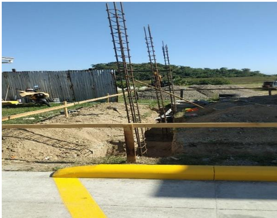
Ilustración 40 – Inicio de excavaciones de zanjas en nuevo local.
