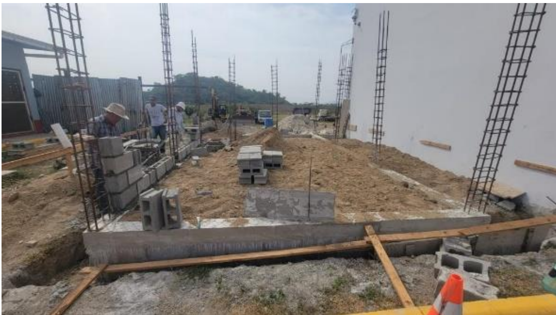
Ilustración 41 – Fundición de zapata corrida
