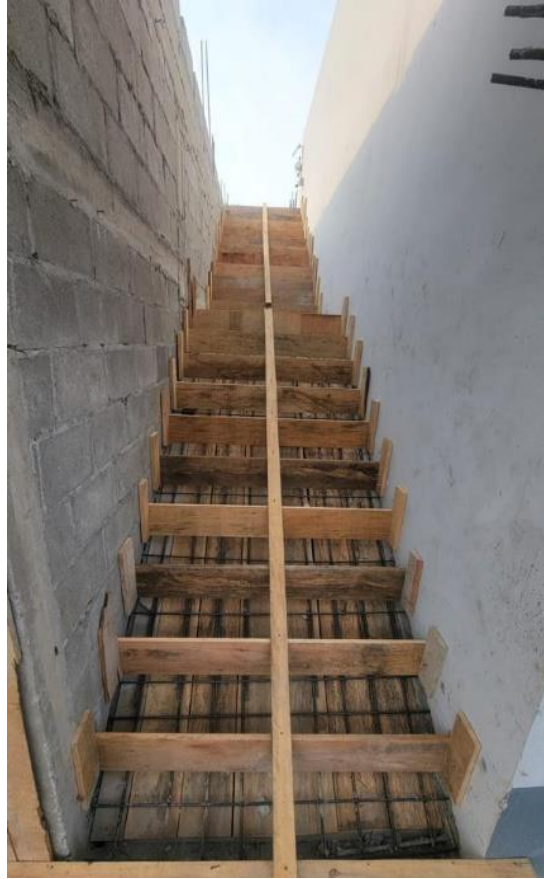
Ilustración 44 – Encofrado de gradas
