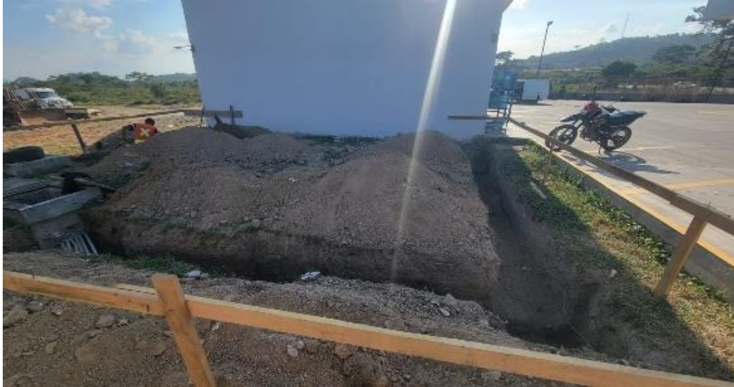
Ilustración 39 – Inicio de excavaciones de zanjas en nuevo local.
