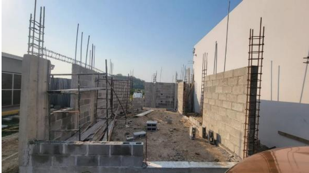
Ilustración 42 – Pegado de bloque
