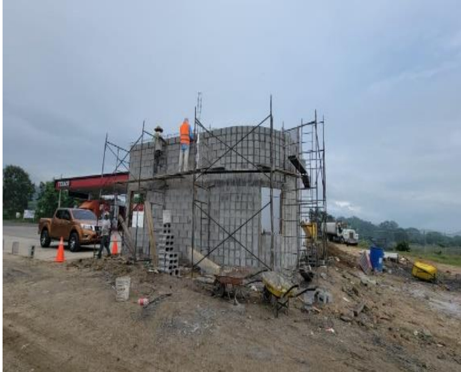
Ilustración 6 – Avance en pegado de bloque
