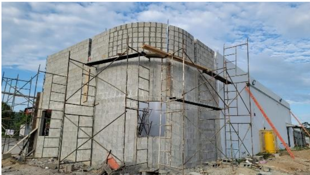
Ilustración 11 – Pegado de bloque en solera de cierre
