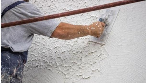
**Ilustración 18 Yeso usado en pared interior**
