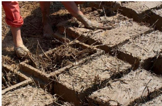
**Ilustración 25 Conformación artesanal de ladrillos a base de adobe**
