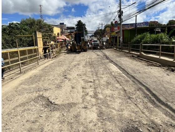
**Ilustración 50 Supervisó del proyecto de bacheo con cemento asfáltico en la losa del puente**
