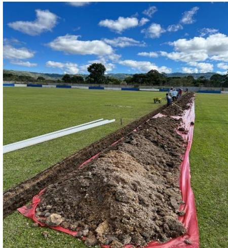
**Ilustración 59 Supervisión en estadio ciudad cívica visualizando etapa actual de la instalación del sistema de riego en la cancha**
