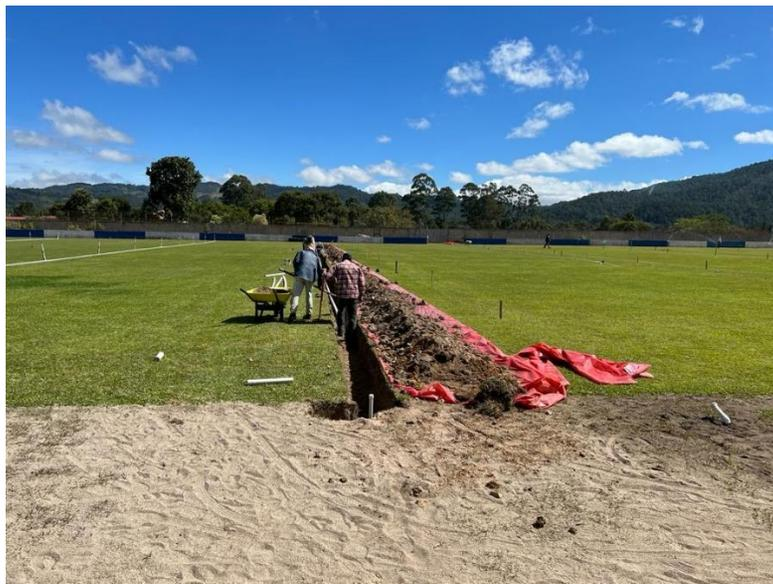
**Ilustración 61 Supervisión en estadio ciudad cívica visualizando etapa de instalación del sistema de riego en la cancha**
