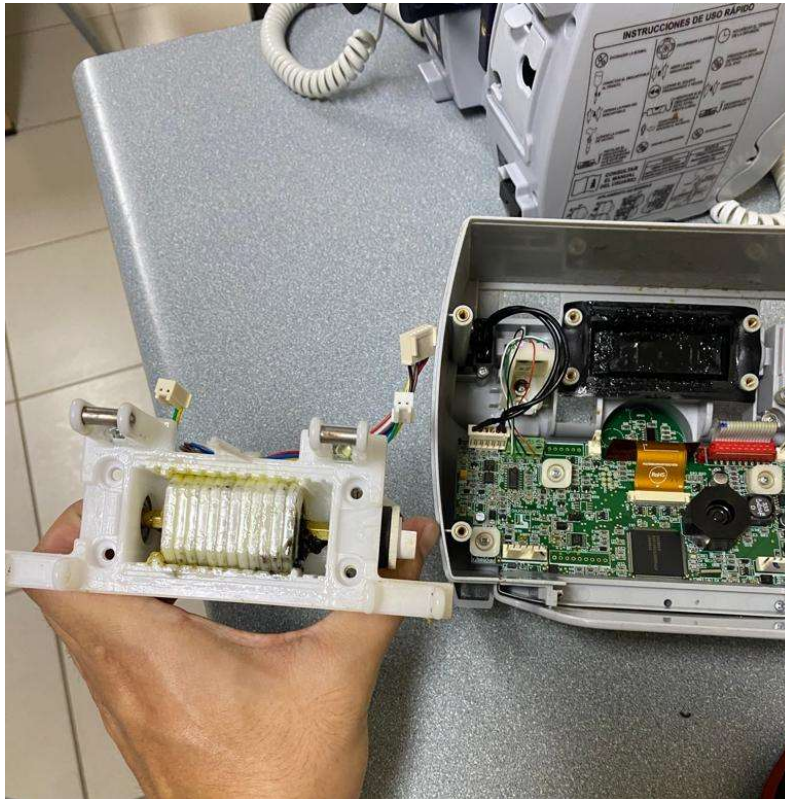
Ilustración 39. Reemplazo de motor en mal estado de bombas de infusión
