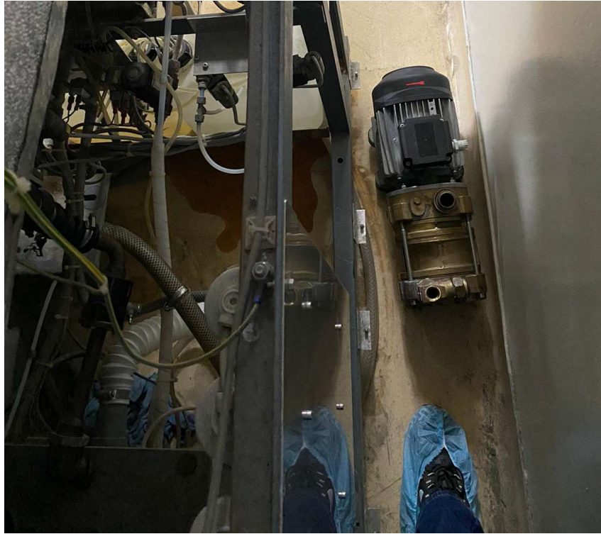
Ilustración 26. Puesta en sitio de bomba de vacío
