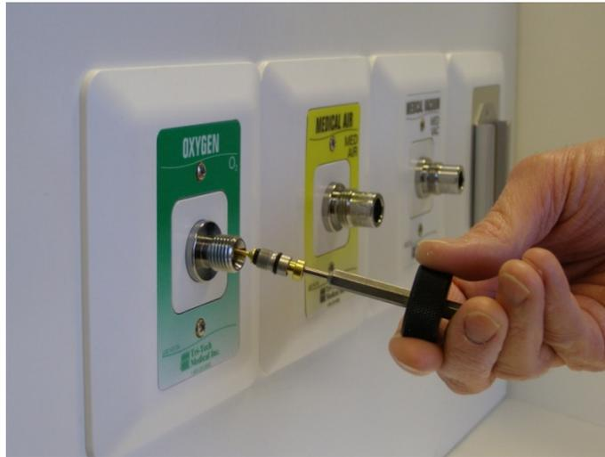
**Ilustración 6: Salida Tipo DISS**
