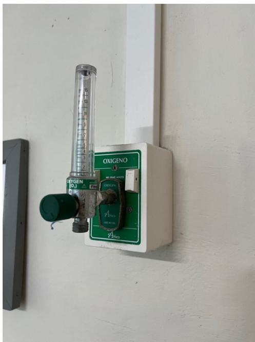
**Ilustración 15: Tomas de pared con su respectivo caudalímetro**
