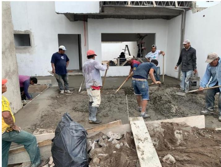
**Ilustración 89 Continuación de fundición de firme C-28**
