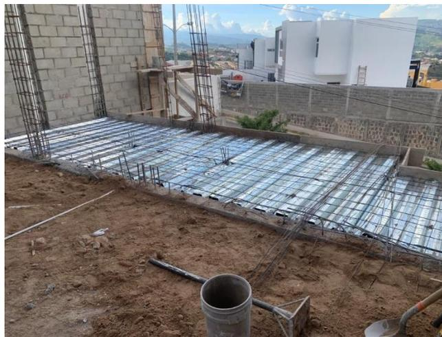
**Ilustración 44 Láminas instaladas para fundir losa y firme C-27**
