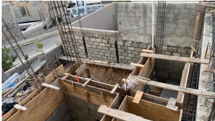
**Ilustración 37 Encofrado final de soleras C-27**
