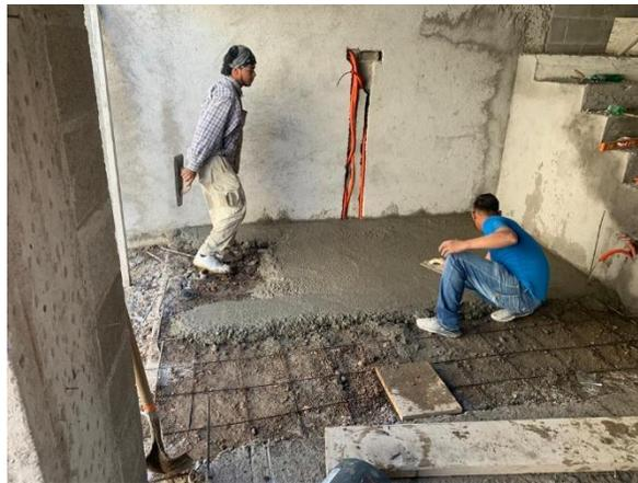
**Ilustración 133 Inicio de fundición de firme en TR9**
