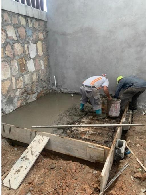
**Ilustración 104 Fundición de cisterna C-21**
