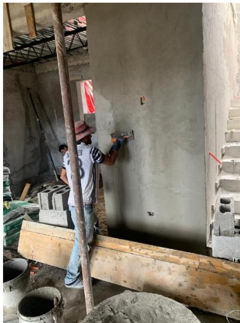
**Ilustración 113 Repello paredes C-27**
