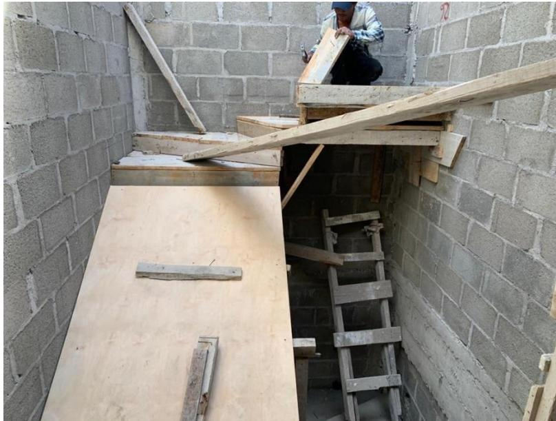
**Ilustración 130 Encofrado de gradas TR11**
