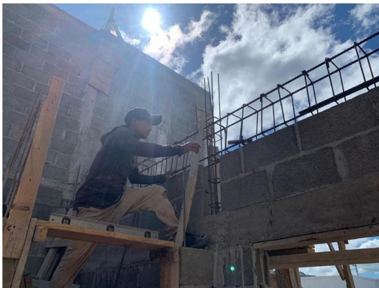
**Ilustración 129 Armado de solera TR11**
