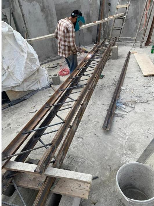
**Ilustración 68 Soldadura de joist C-27**
