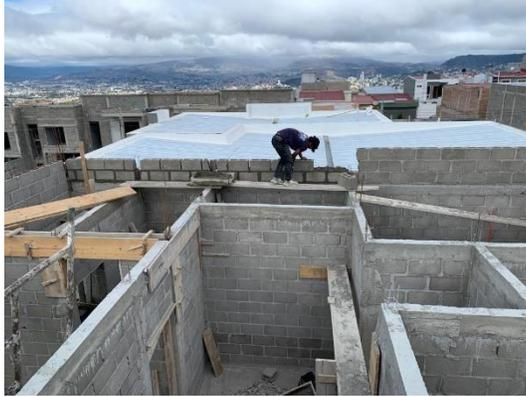
**Ilustración 192 Pegado de ultimas hiladas de bloque en TR8**
