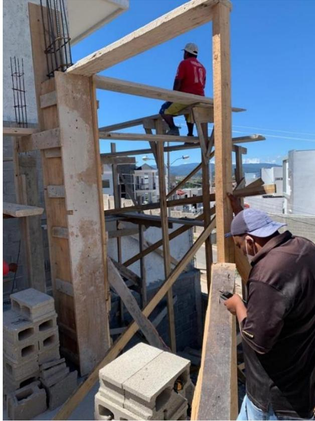
**Ilustración 50 Piloteado de vigas segundo nivel C-27**
