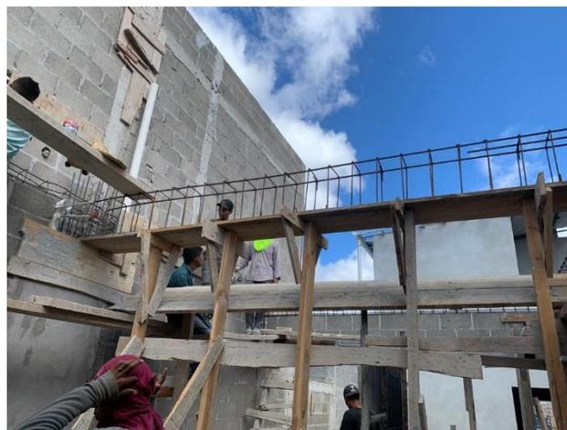
**Ilustración 128 Armado de vigas en TR8**
