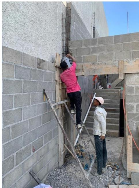
**Ilustración 111 Fundición de soleras y castillos**
