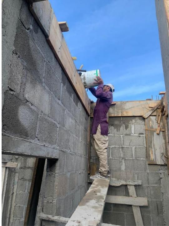
**Ilustración 156 Fundición de solera en TR11**
