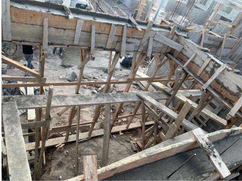
**Ilustración 136 Fundición de vigas en TR8**
