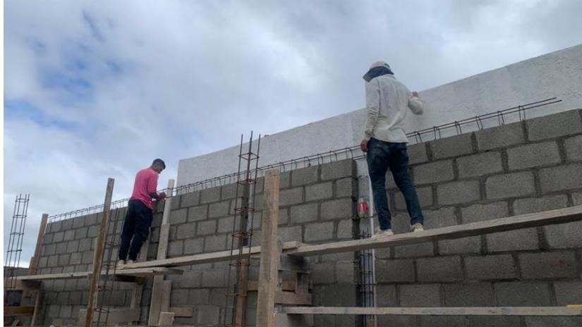
**Ilustración 106 Instalación de acero de solera**
