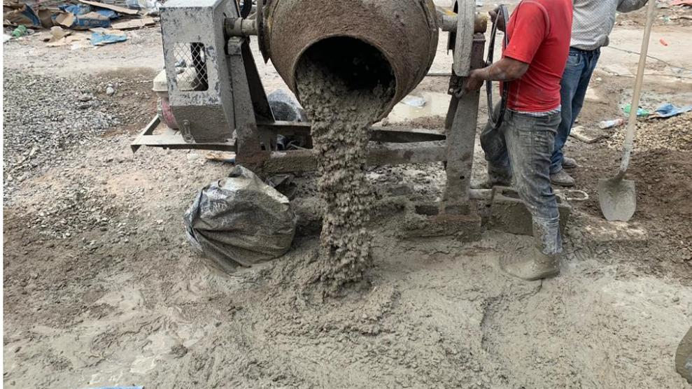
**Ilustración 146 Elaboración mecánica de concreto**
