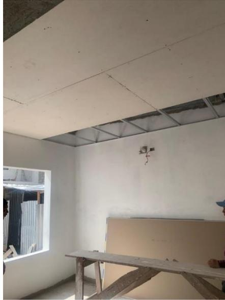
**Ilustración 71 Instalación de tabla yeso C-28**
