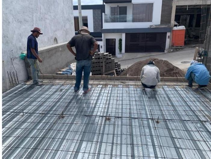
**Ilustración 83 Finalizando armado de losa**
