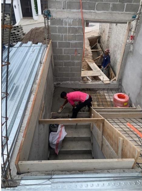
**Ilustración 79 Fundición de gradas C-27**
