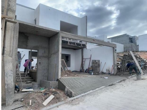
**Ilustración 98 Fundición de rampa de acceso C-28**
