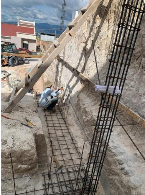
**Ilustración 53 Armado de parrilla para zapatas**
