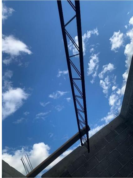
**Ilustración 158 Instalación de joist para fundir terraza en TR11**
