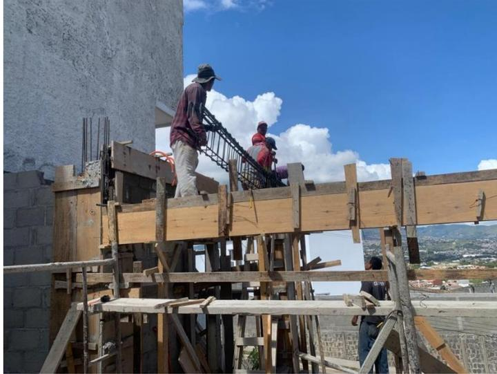
**Ilustración 55 Colocación de armado de viga**
