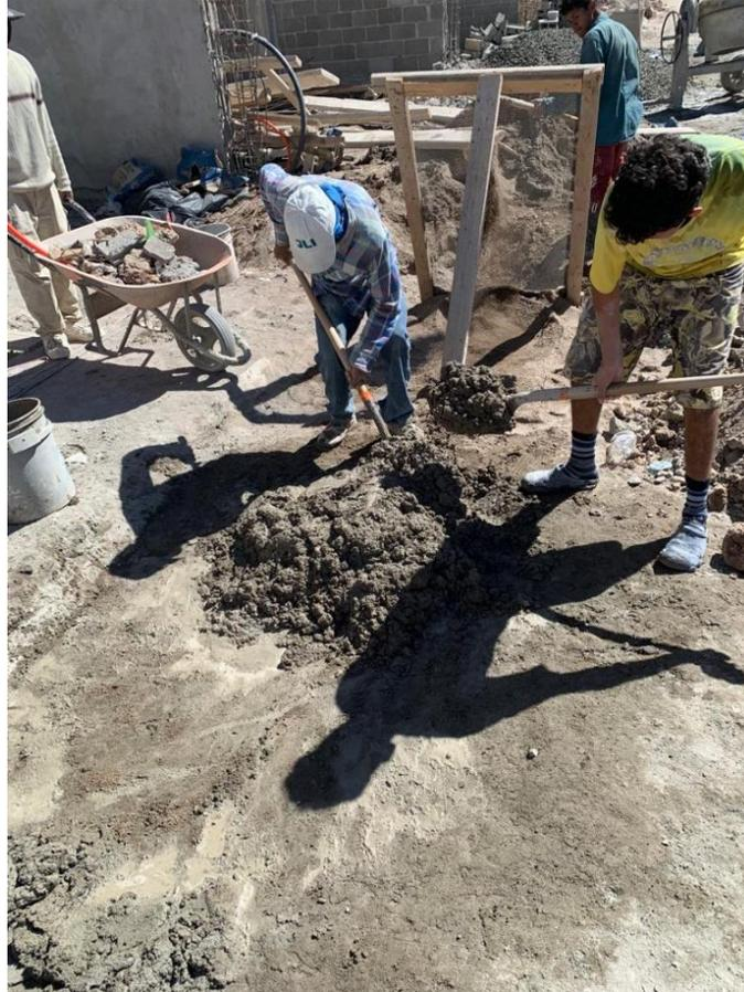
**Ilustración 188 Mezcla manual de mortero**
