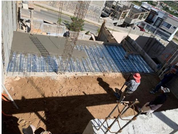
**Ilustración 45 Fundición de firme y losa en C-27**
