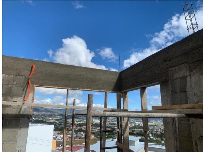
**Ilustración 125 Desencofrado de viga**
