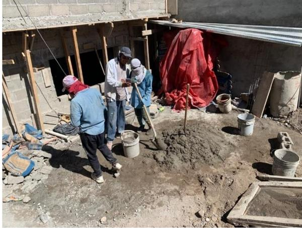
**Ilustración 110 Mezcla de concreto para fundir castillos y soleras**
