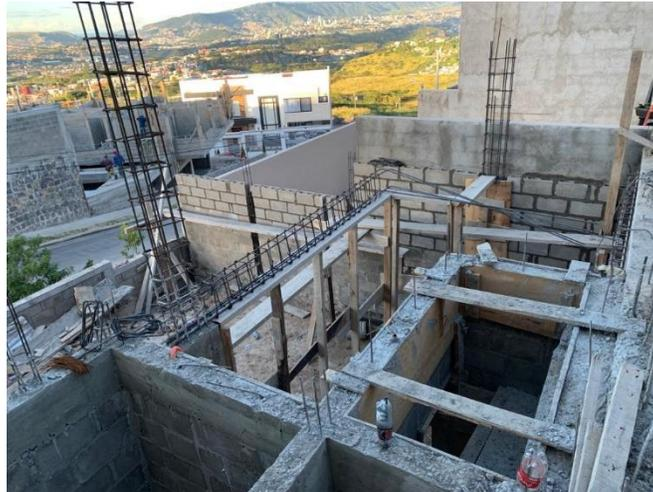
**Ilustración 39 Instalación de viga para losa sobre área de lavandería C-27**
