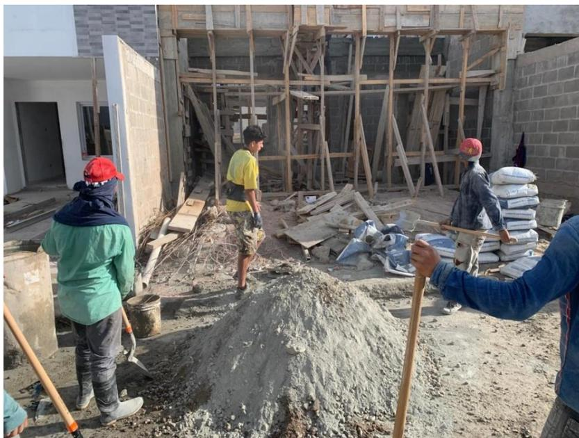
**Ilustración 137 Preparación de concreto manual**
