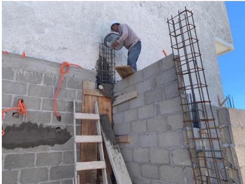
**Ilustración 51 Fundición de columnas y castillos**
