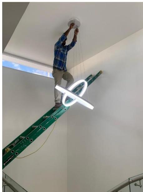
**Ilustración 175 Instalación de lampara TR2**
