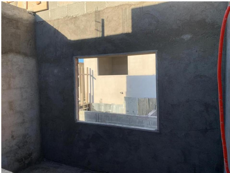
**Ilustración 177 Repello de paredes de interior TR11**
