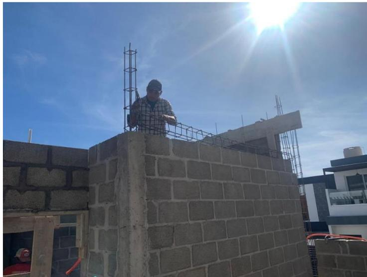
**Ilustración 119 Instalación de armado de soleras**
