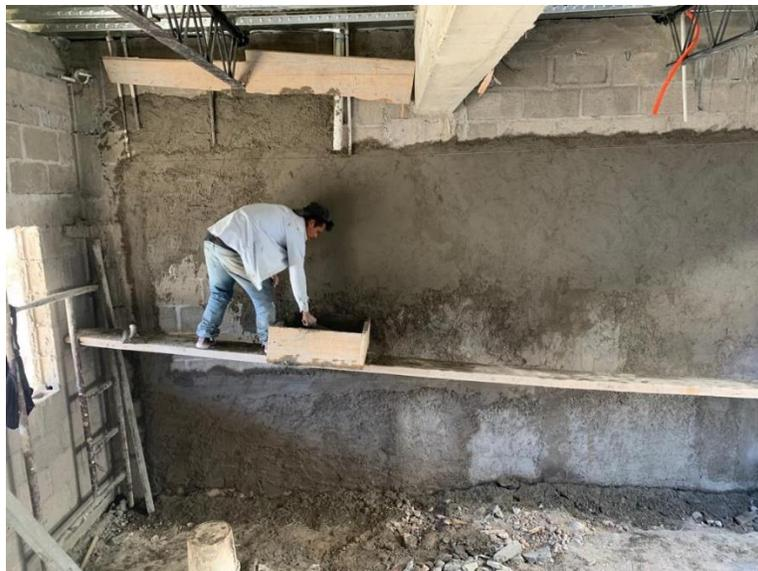
**Ilustración 189 Repello de paredes de interior en TR8**
