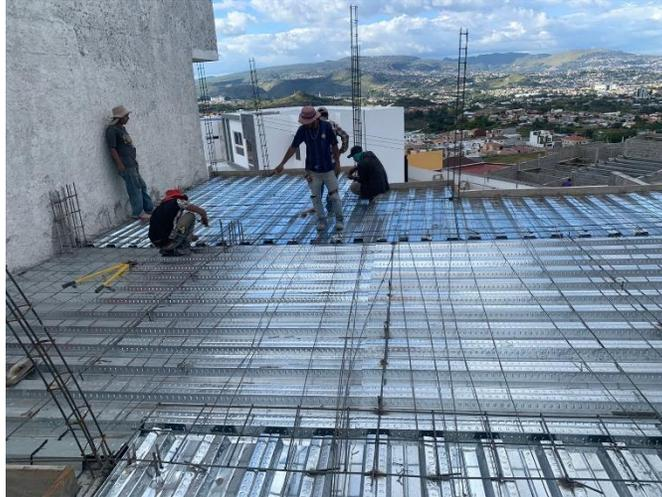
**Ilustración 81 Armado de losa**
