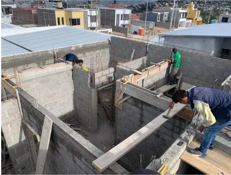
**Ilustración 180 Encofrado de soleras en TR8**
