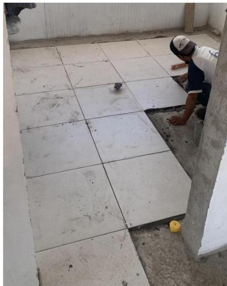
**Ilustración 28 Instalación de cerámica en C-21**
