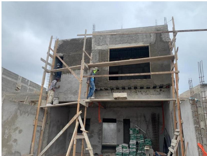
**Ilustración 141 Repello de fachada TR9**
