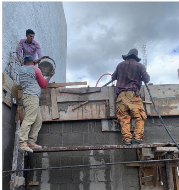
**Ilustración 62 Uso de vibrador de concreto**
