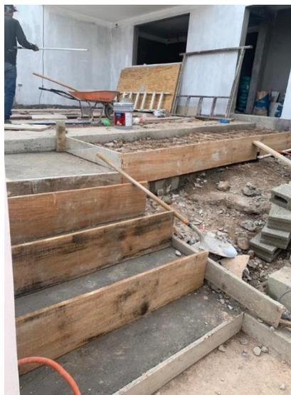
**Ilustración 18 Fundición de parqueo en C-24**
