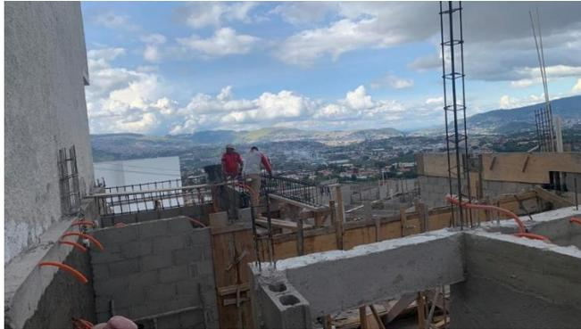
**Ilustración 56 Continuación de colocación de armado de vigas**
