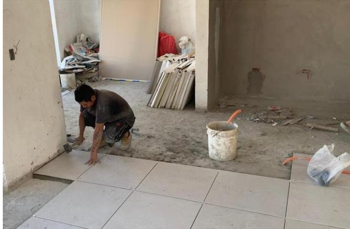
**Ilustración 64 Instalación de cerámica C-24**
