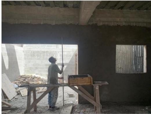
**Ilustración 193 Repello de paredes TR11**
