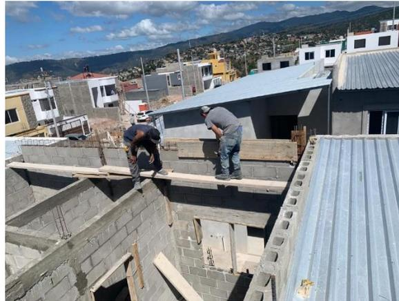
**Ilustración 185 Encofrado de solera superior TR8**
