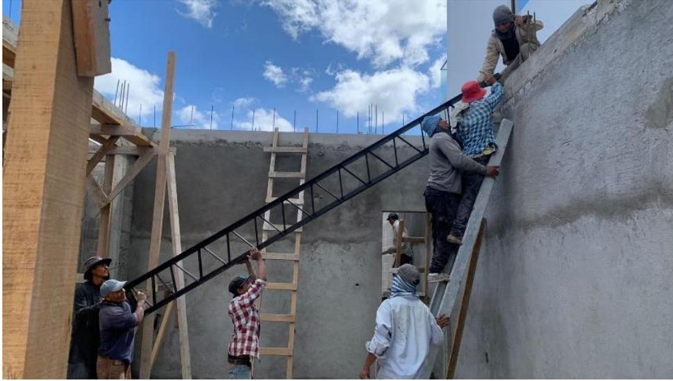
**Ilustración 75 Instalación de joist en N-9**
