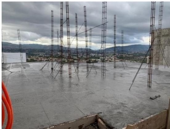
**Ilustración 90 Losa fundida de C-27**
