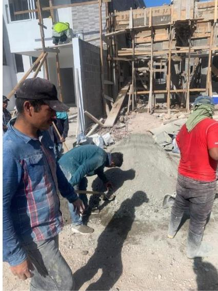
**Ilustración 134 Preparación manual de concreto**
