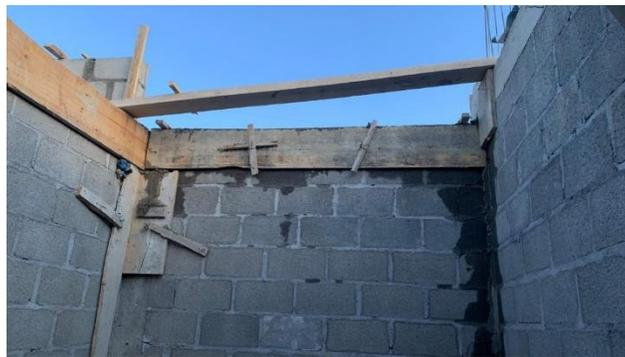
**Ilustración 164 Fundición de solera TR11**
