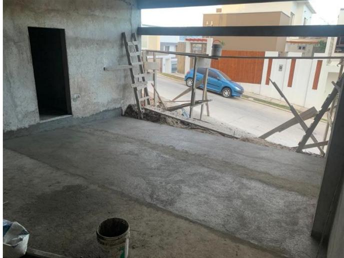
**Ilustración 85 Fundición de firme del garaje C-21**
