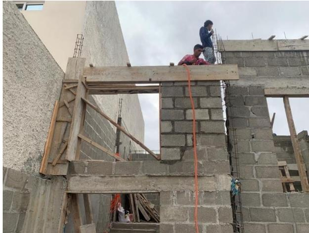
**Ilustración 121 Encofrado de soleras**
