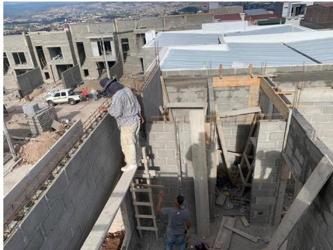
**Ilustración 179 Armado de soleras en TR8**
