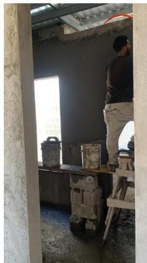
**Ilustración 38 Repello y pulido C-28**
