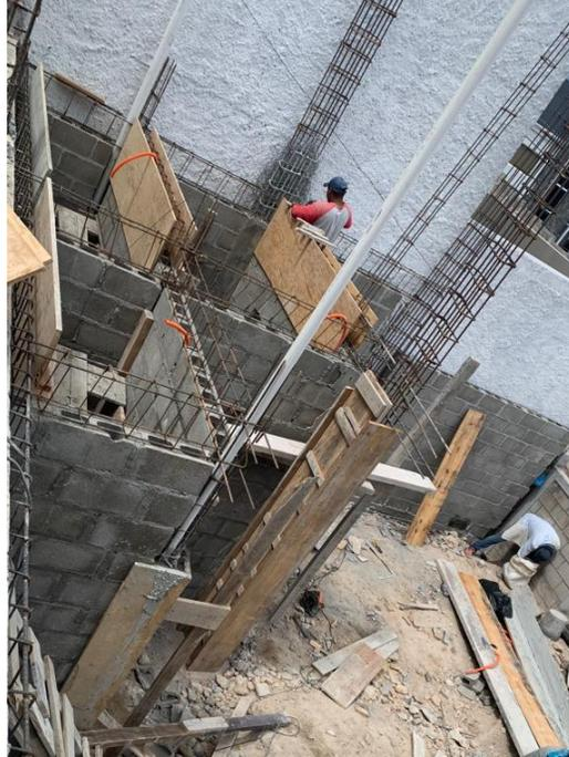
**Ilustración 36 Encofrado de soleras en área de lavandería C-27**
