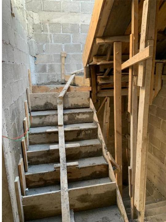
**Ilustración 178 Fundición de gradas hacia terraza TR9**
