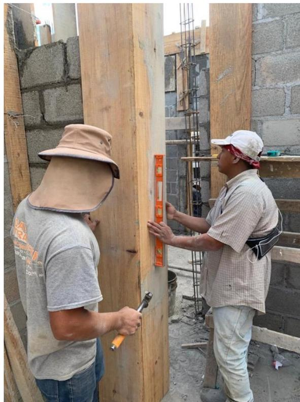
**Ilustración 153 Encofrado de castillo y cargadores TR11**
