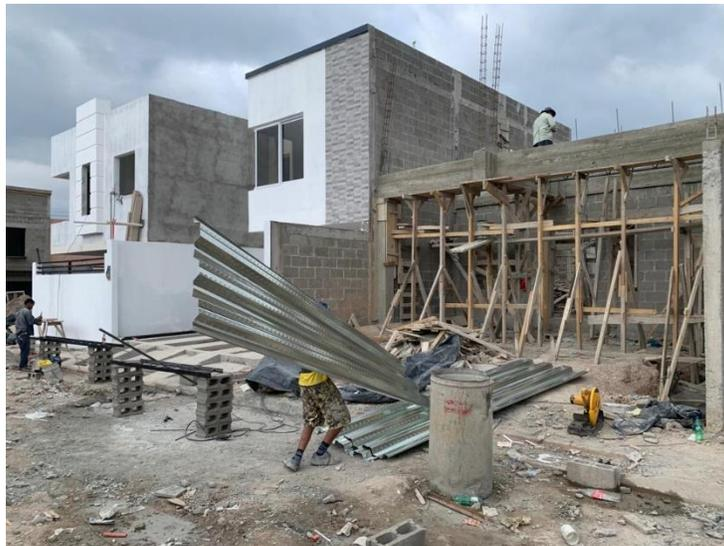
**Ilustración 143 Preparación para instalar laminas estructurales en TR8**
