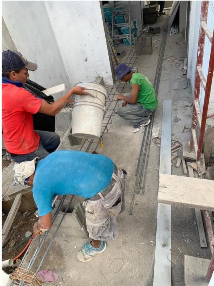
**Ilustración 31 Armado de solera para C-21**
