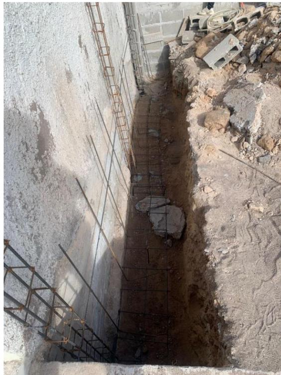
**Ilustración 74 Armado para zapata**
