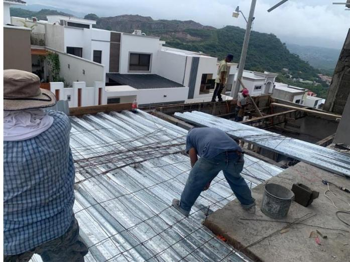
**Ilustración 57 Instalación de láminas estructurales C-21**
