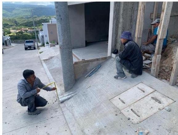
**Ilustración 30 Sacando nivel de rampa de acceso**
