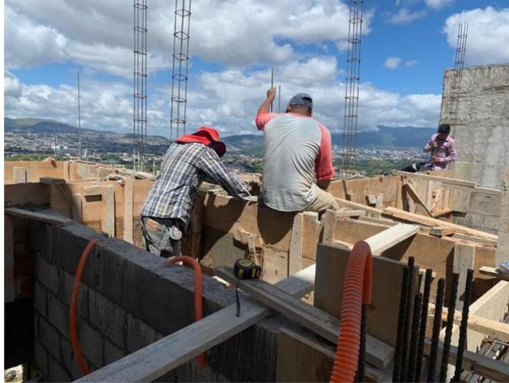
**Ilustración 61 Fundición de vigas C-27**
