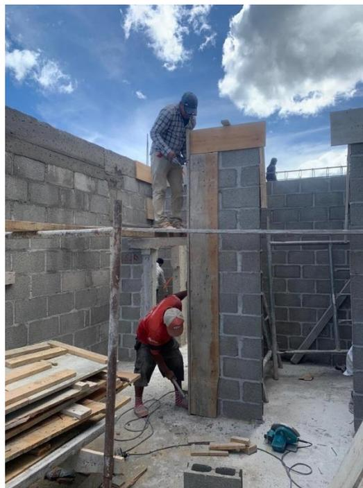
**Ilustración 126 Encofrado de castillo en C-27**
