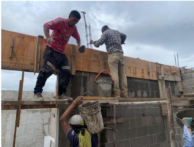
**Ilustración 124 Fundición de vigas y soleras C-27**
