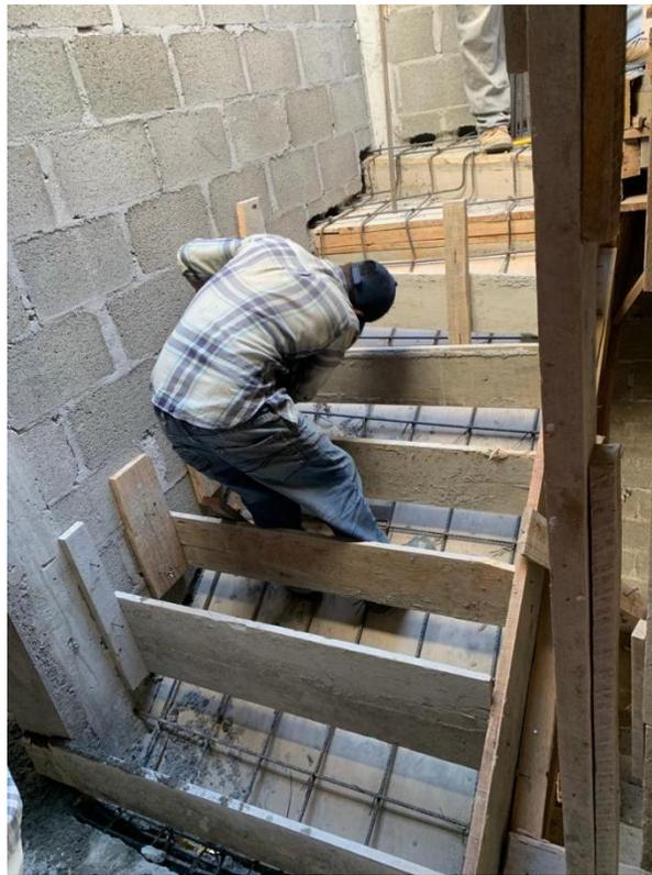
**Ilustración 171 Encofrado y armado de gradas TR9**
