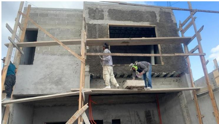
**Ilustración 139 Repello de fachada TR9**
