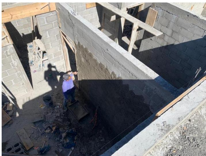
**Ilustración 187 Repello de paredes TR8**
