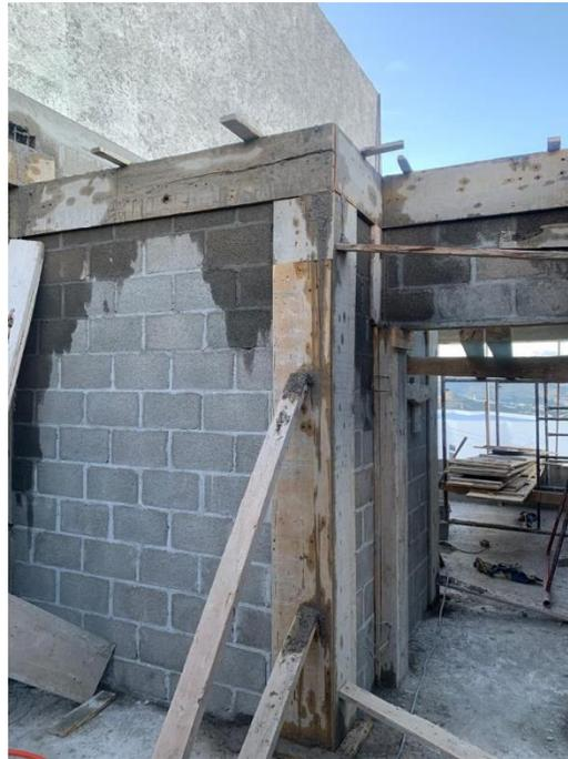
**Ilustración 127 Fundición de soleras y castillos C-27**
