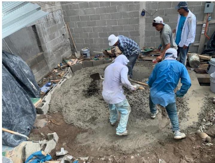
**Ilustración 60 Mezcla de concreto para fundición de vigas C-27**
