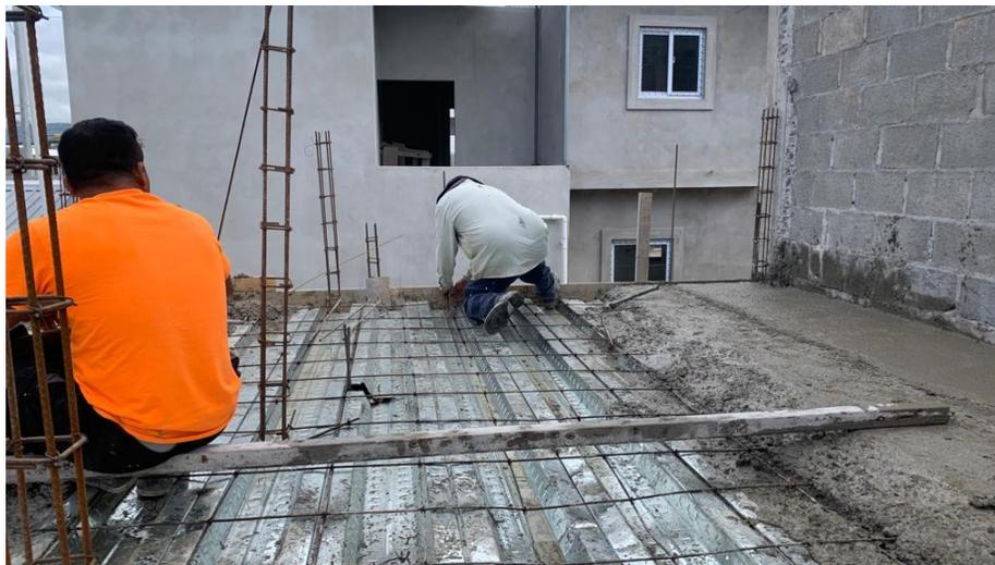
**Ilustración 145 Fundición de losa TR8**
