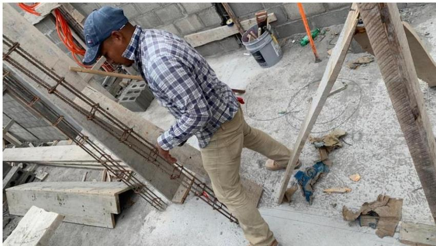
**Ilustración 105 Nivel para empezar a pegar hiladas de bloque**
