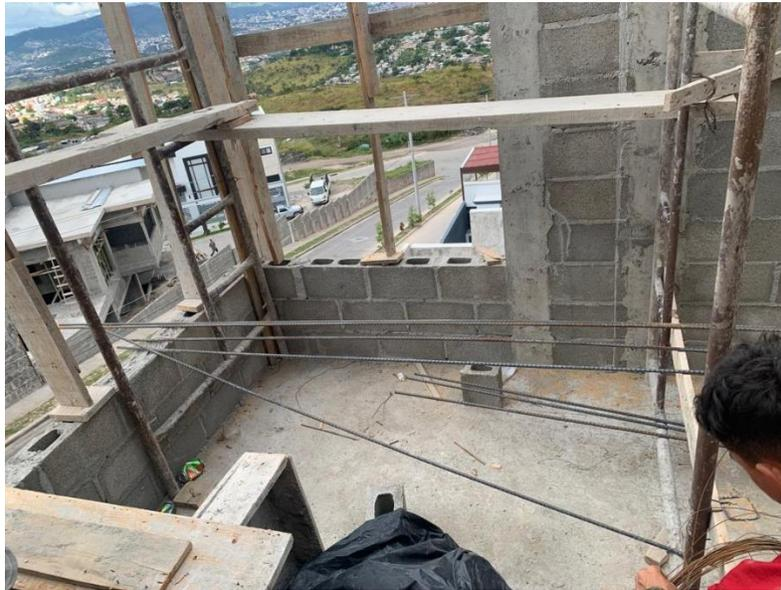
**Ilustración 114 Fundición de soleras y castillos**
