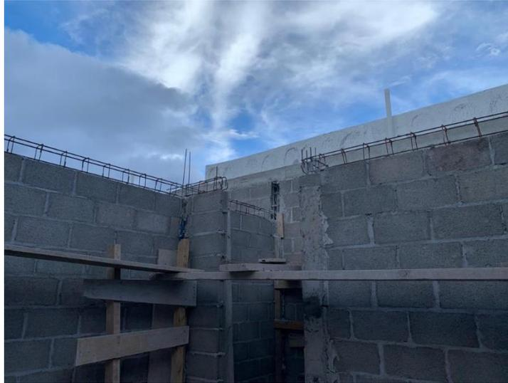
**Ilustración 116 Armado de soleras**
