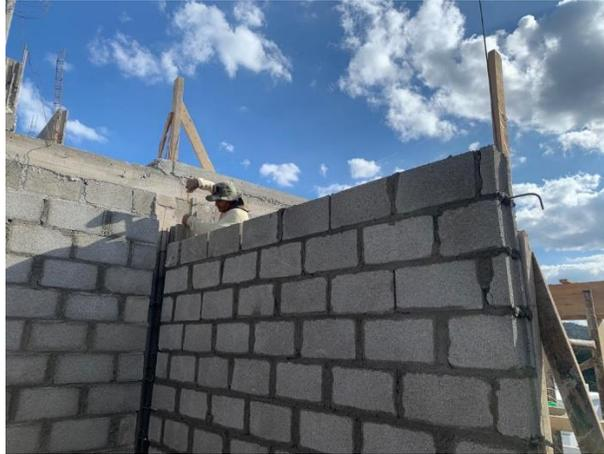
**Ilustración 163 Levantamiento de paredes TR8**
