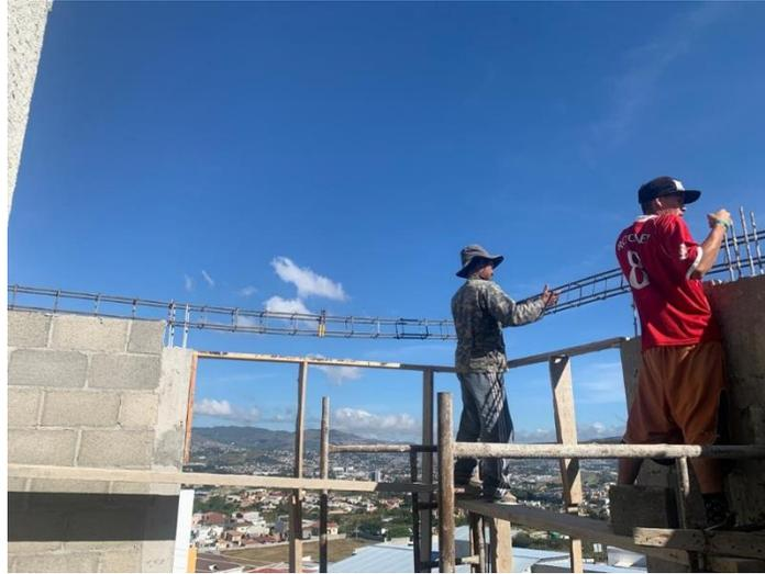
**Ilustración 118 Instalación del acero de viga C-27**
