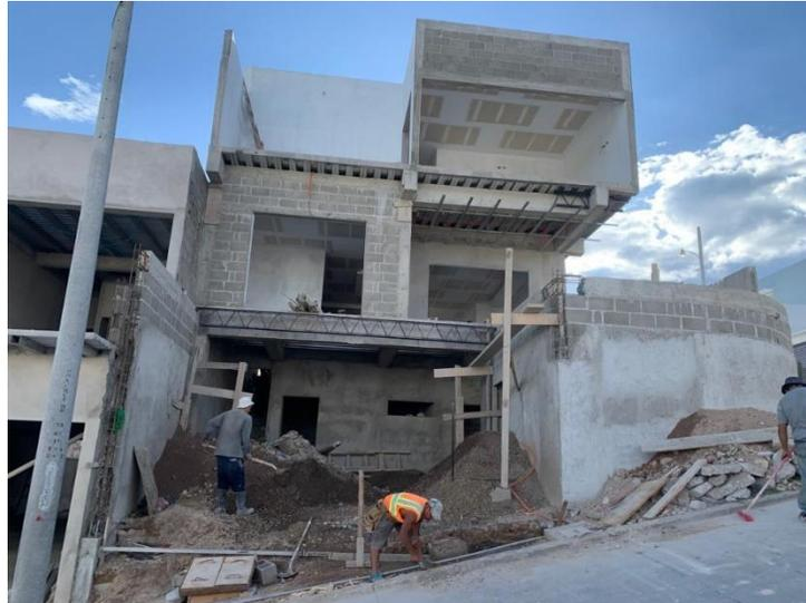
**Ilustración 23 C-21 instalación de joist#1**
