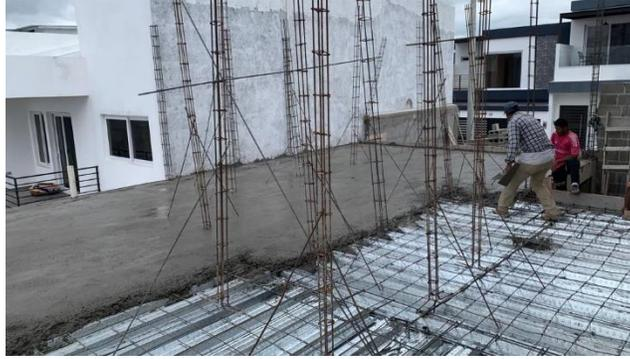
**Ilustración 88 Continuación de fundición de losa C-27**
