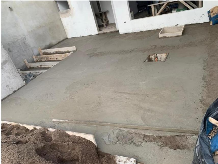
**Ilustración 91 Fundición de firme C-28**
