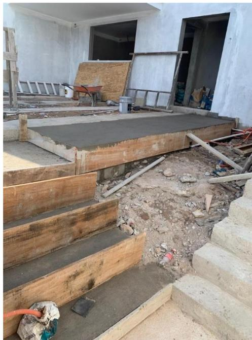
**Ilustración 24 Fundición de parqueo C-24**
