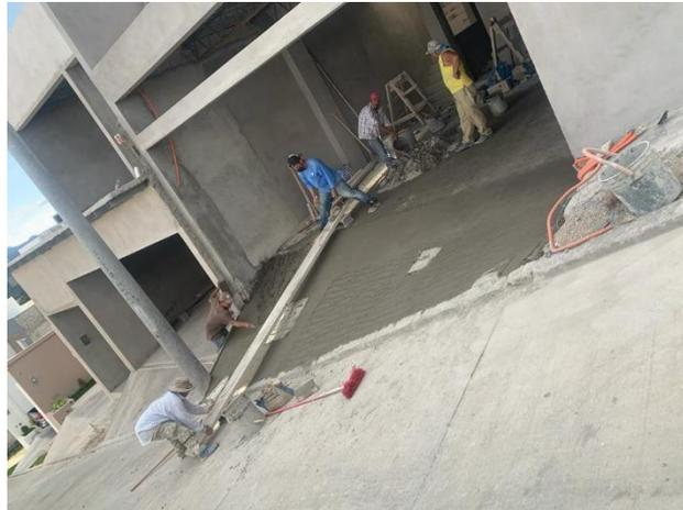
**Ilustración 99 Fundición de rampa de acceso C-21**
