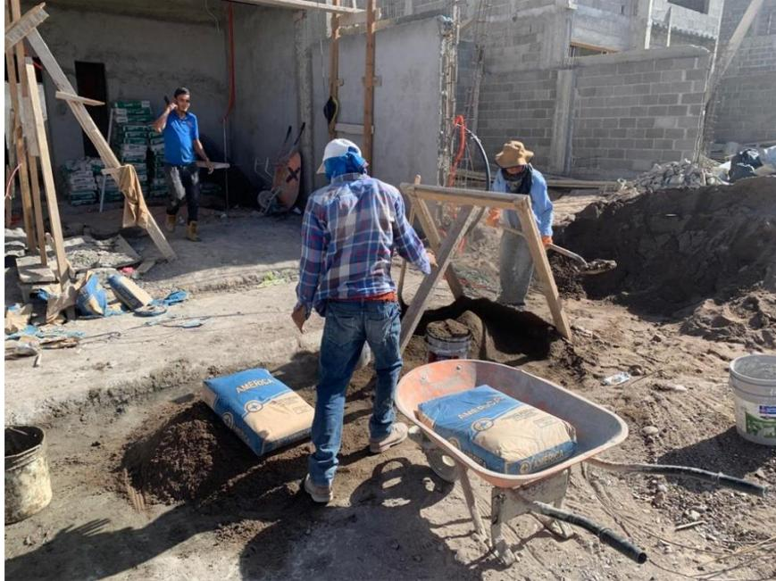
**Ilustración 172 Mezcla de mortero**
