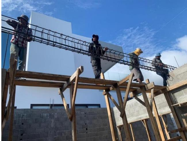
**Ilustración 66 Instalación de vigas en N-9**
