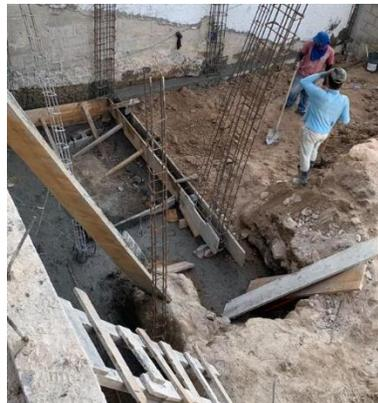
**Ilustración 26 Fundición de cimentación C-27**
