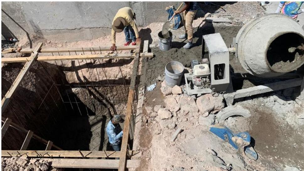
**Ilustración 76 Fundición de cisterna N-3**
