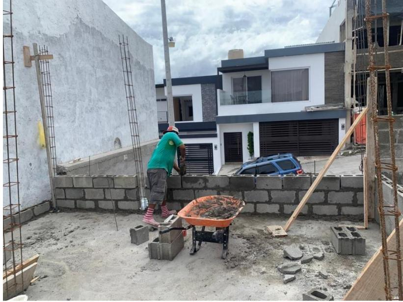
**Ilustración 92 Inicio de levantamiento de paredes**
