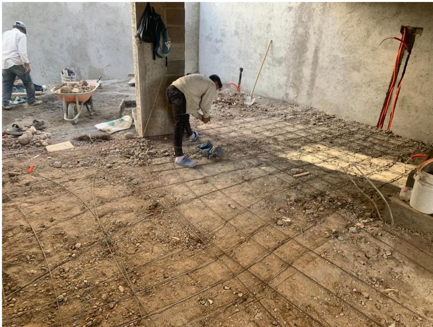
**Ilustración 131 Armado de firme de TR9**
