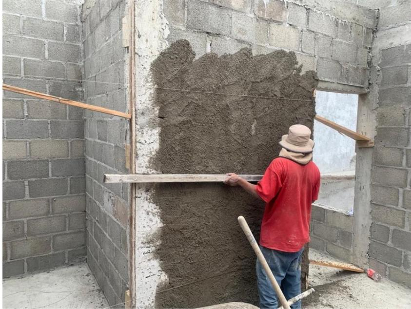
**Ilustración 123 Repello de paredes internas C-27**
