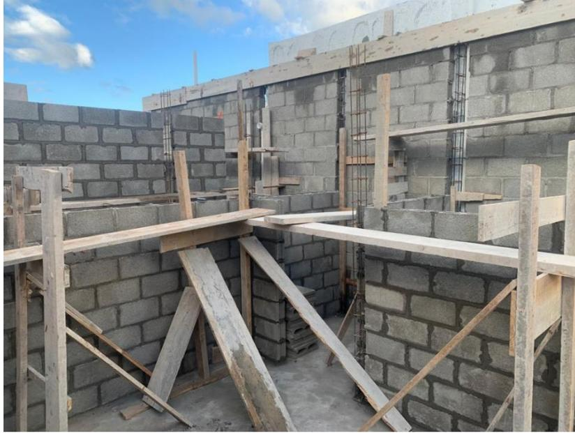
**Ilustración 108 Levantamiento de paredes internas C-27**
