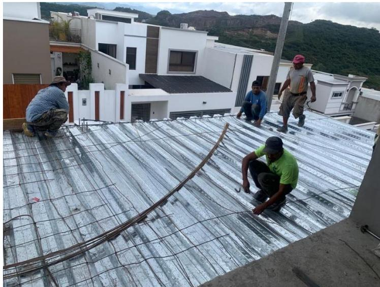
**Ilustración 58 Continuación de instalación de láminas estructurales**
