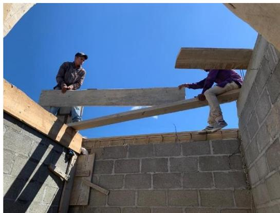
**Ilustración 162 Encofrado soleras TR11**
