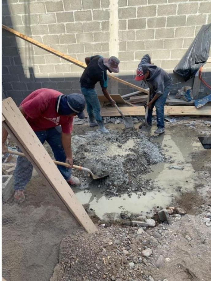
**Ilustración 52 Mezcla de concreto**
