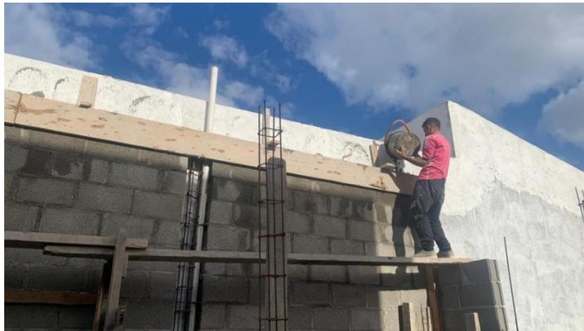
**Ilustración 107 Fundición de solera**
