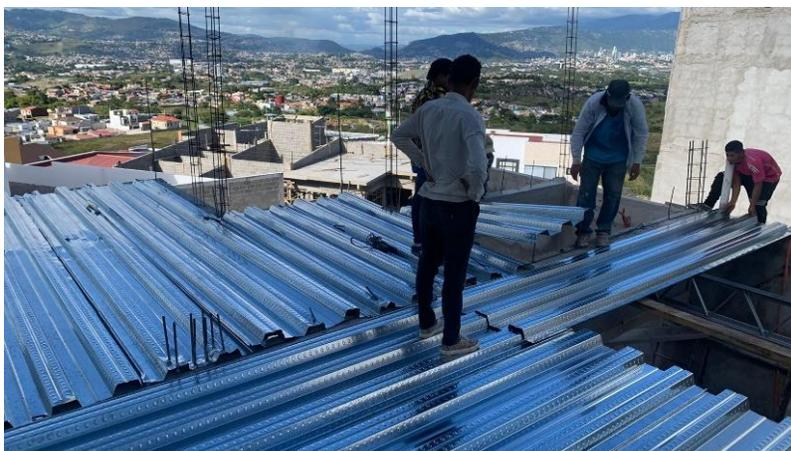
**Ilustración 78 Instalación de láminas estructurales**
