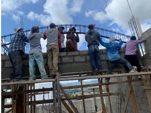
**Ilustración 59 Instalación de viga en C-27**
