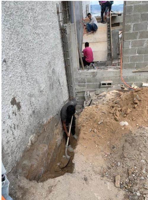
**Ilustración 70 Excavación para zapata corrida C-27**
