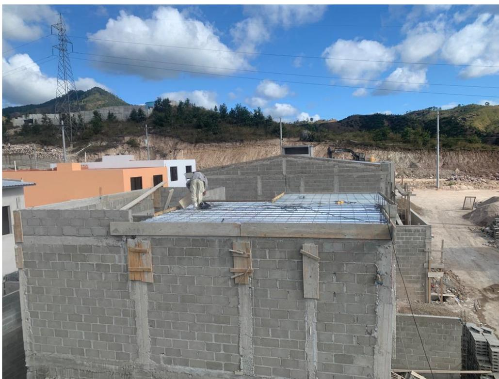
**Ilustración 183 Armado de terraza TR11**
