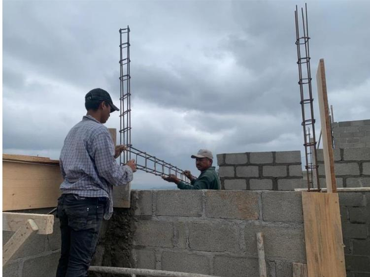
**Ilustración 142 Instalación de armado de soleras en TR11**
