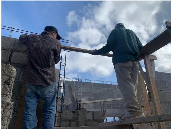
**Ilustración 159 Instalación de cargadores de puertas TR11**
