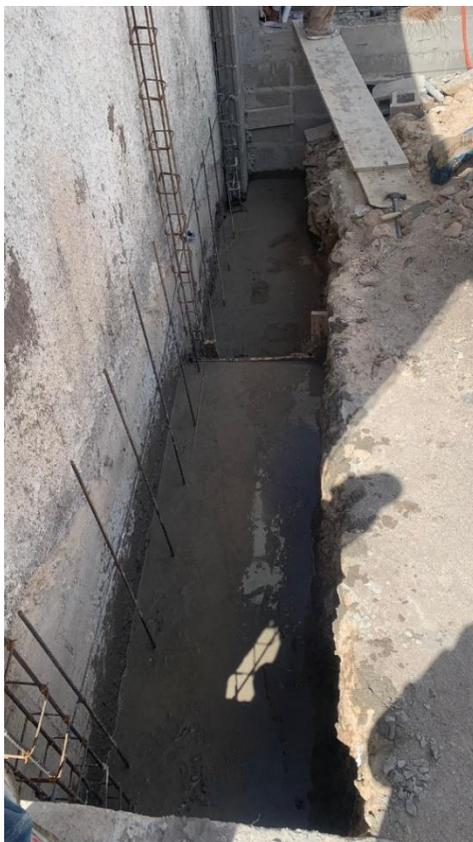
**Ilustración 77 Fundición de zapata**
