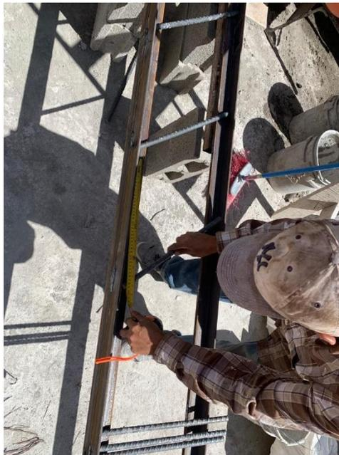
**Ilustración 67 Inicio de soldadura de joist C-27**
