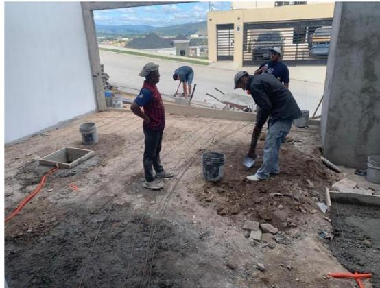
**Ilustración 87 Preparación de armado para fundir firme C-28**
