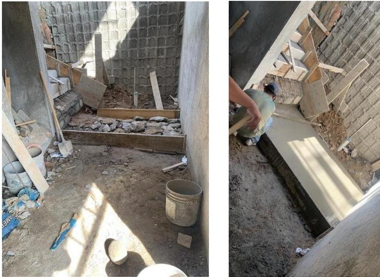
**Ilustración 25 Continuación de fundición gradas laterales C-21**
