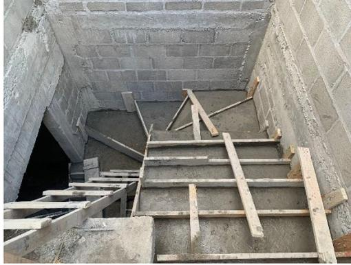
**Ilustración 160 Fundición de gradas TR11**
