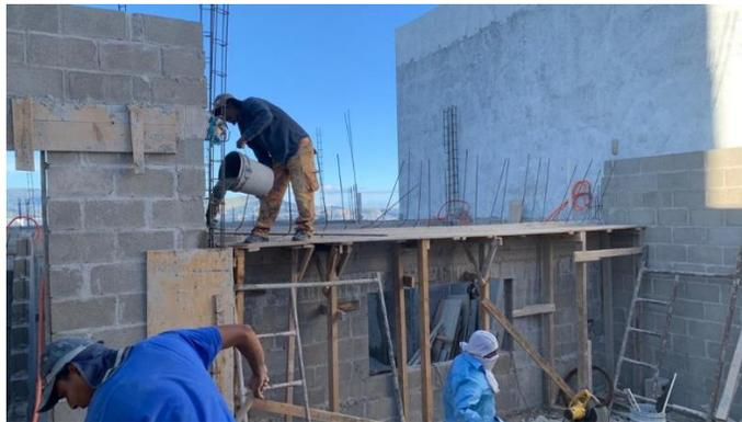
**Ilustración 65 Fundición de columnas y castillos C-27**
