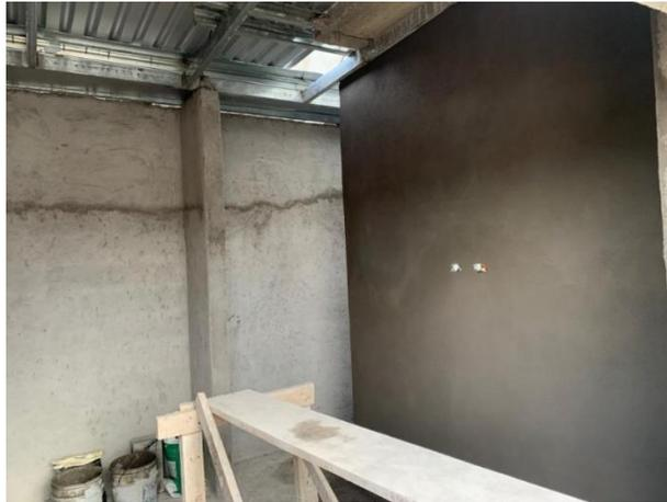
**Ilustración 27 Repello y pulido en C-26**
