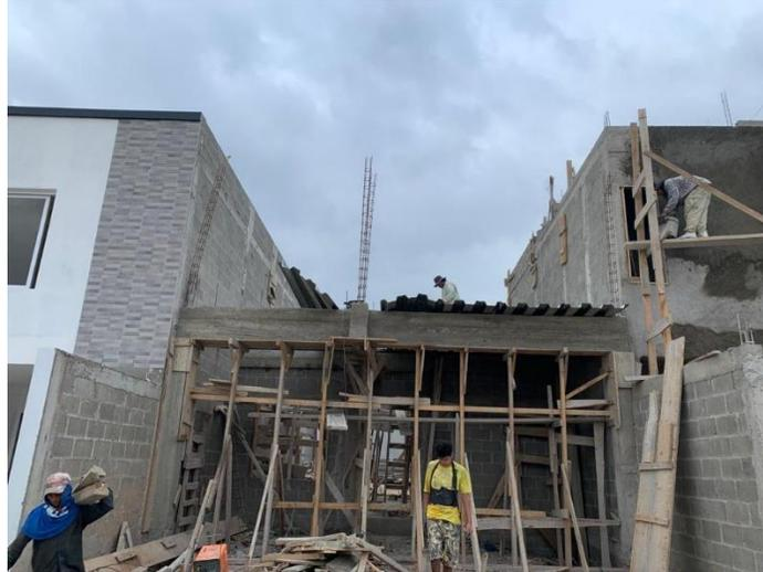
**Ilustración 144 instalación de láminas estructurales**
