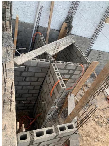
**Ilustración 34 Fundición de zapatas y levantamiento de paredes en C-27**
