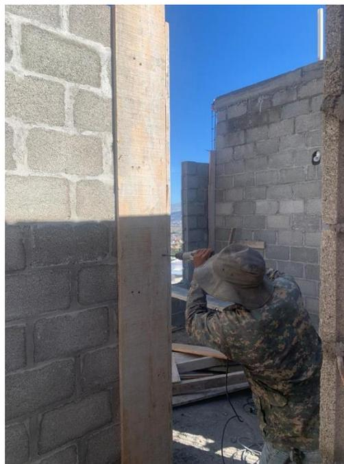
**Ilustración 109 Encofrado de castillos C-27**
