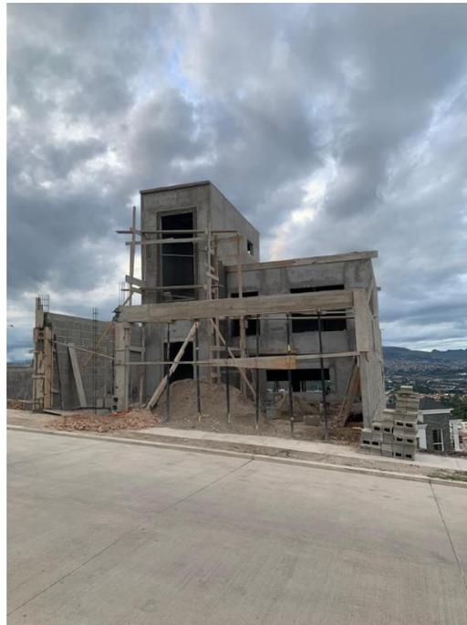
**Ilustración 42 Avance repello y pulido de paredes de exterior C-26**
