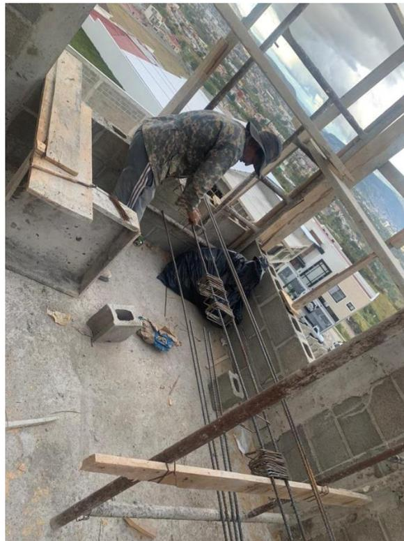
**Ilustración 115 Armado de anillos en viga de C-27**
