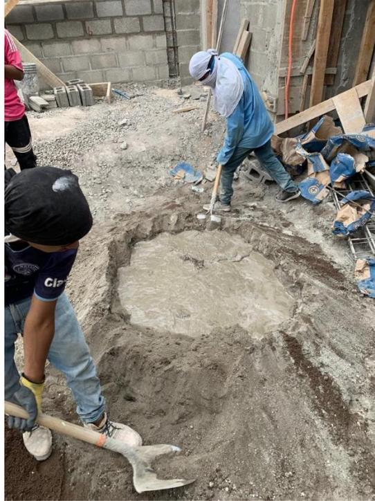
**Ilustración 100 Mezcla de mortero para pegar bloques**
