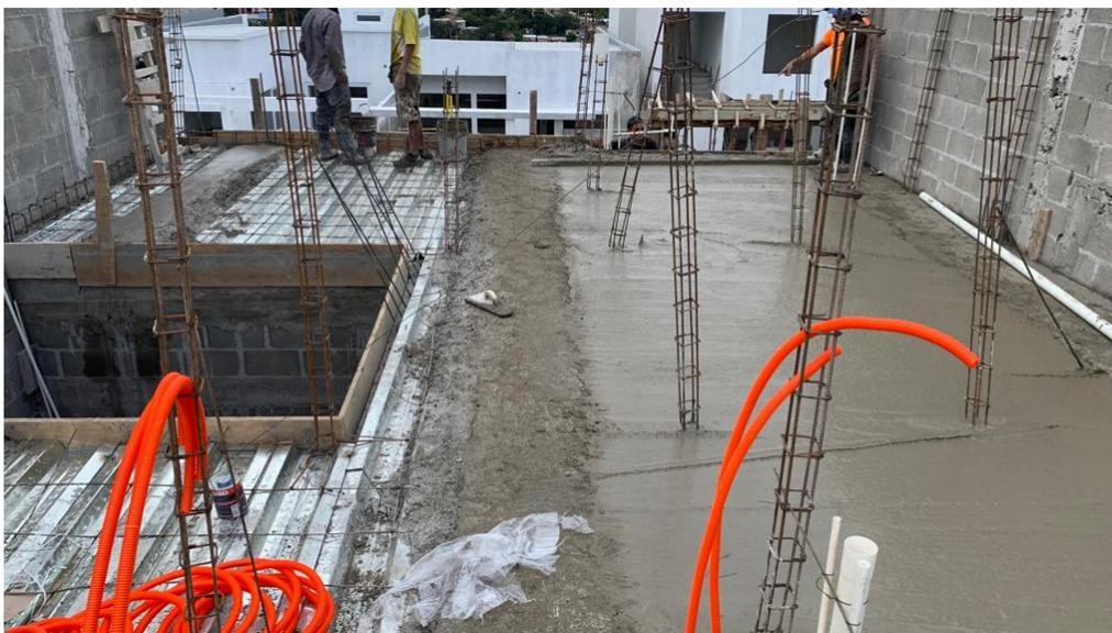
**Ilustración 147 Fundición parcial de losa de TR8**
