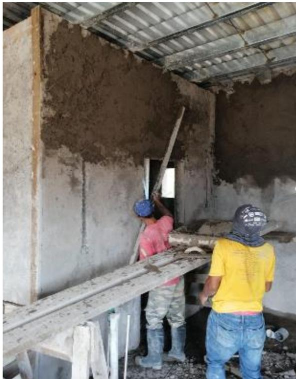
**Ilustración 89 Acabado en repello de paredes de 5to nivel**
