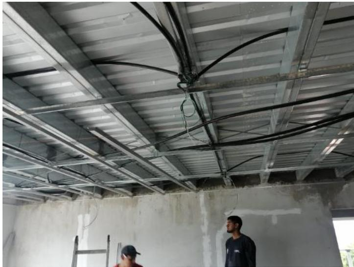
**Ilustración 196 Montaje de elementos de encielado en tercer nivel**
