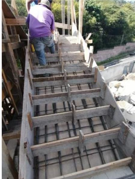
**Ilustración 251 Piloteado de gradas de quinto nivel**
