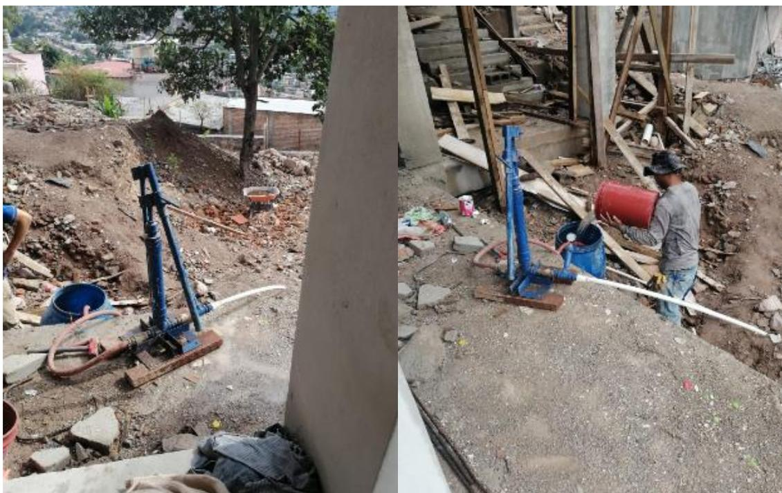
**Ilustración 129 Bomba para realización de pruebas hidráulicas**
