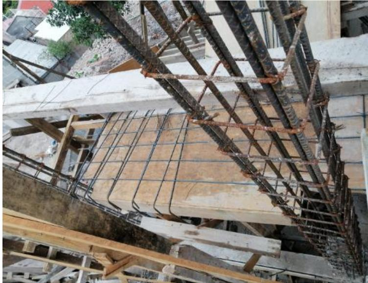
**Ilustración 46 Inicio de colocación de petate en losa de descanso y rampa de gradas**
