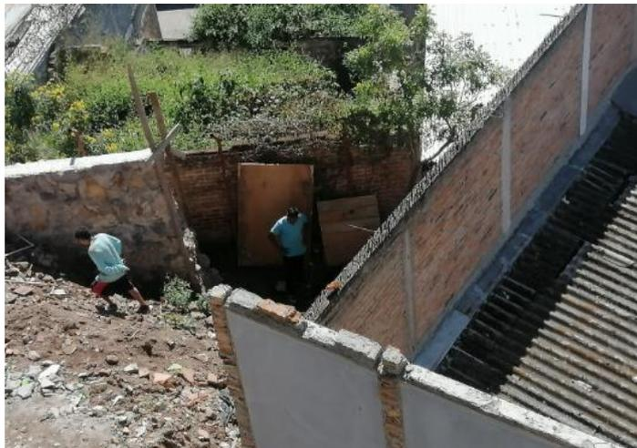
**Ilustración 141 Continuación de excavación en cajas negras**
