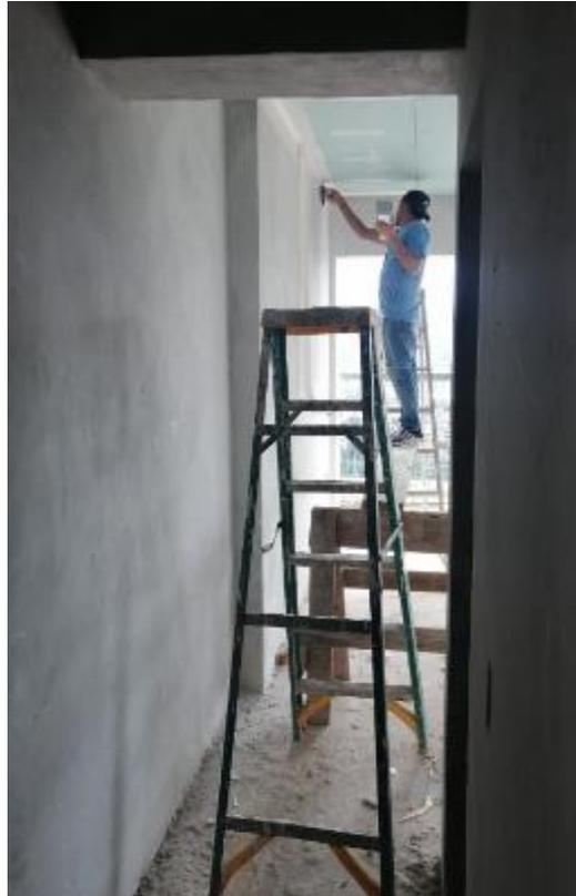
**Ilustración 194 Enmasillado de cielo falso en segundo nivel**
