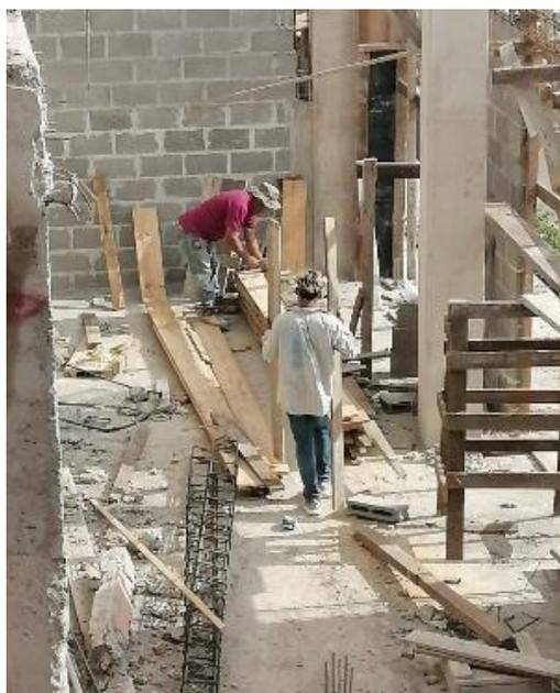
**Ilustración 68 Corte de madera para encofrado de viga en zona habitacional 1**
