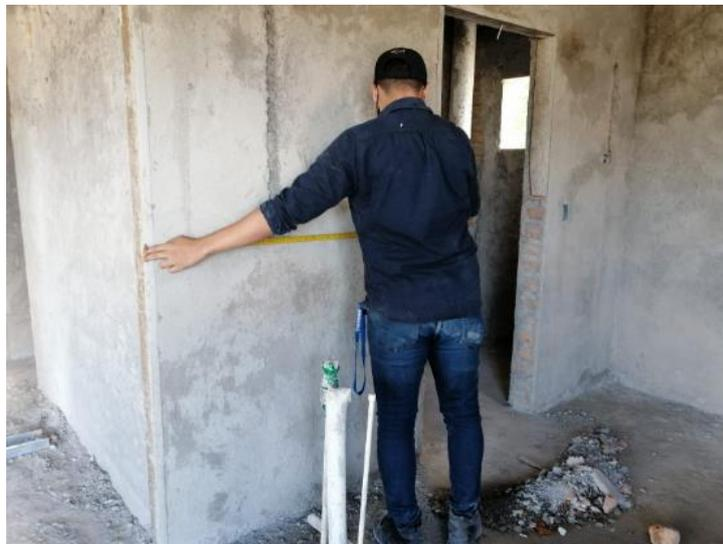
**Ilustración 100 Medición de paredes repelladas para llenado de planilla**
