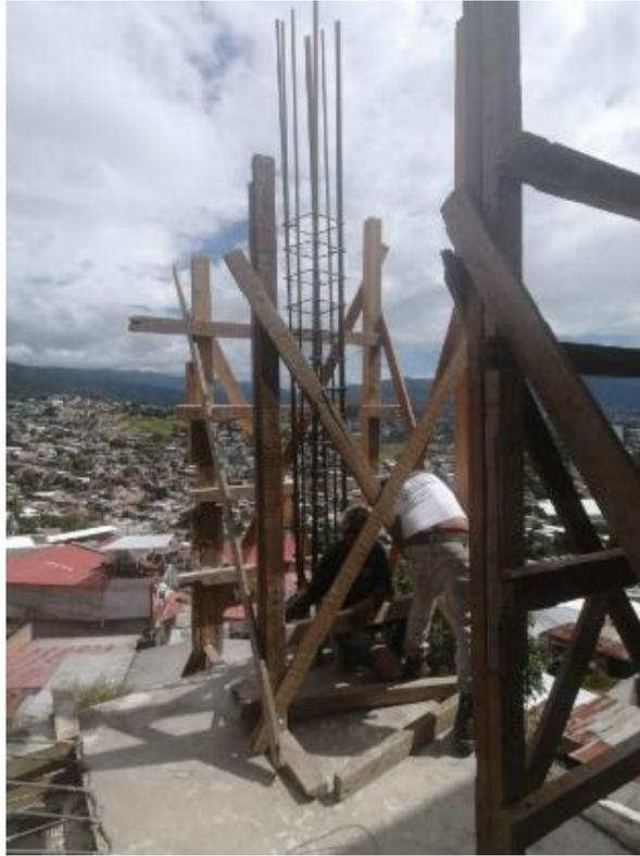
**Ilustración 190 Inicio piloteado de gradas de cuarto nivel**
