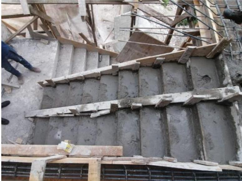
**Ilustración 188 Fundición de gradas**
