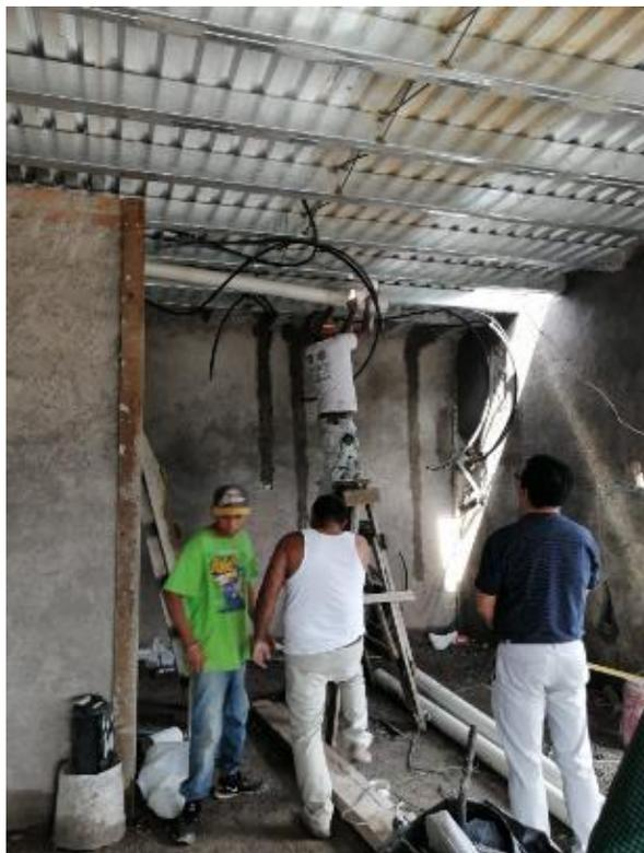
**Ilustración 131 Conexión de tubería con drenaje**
