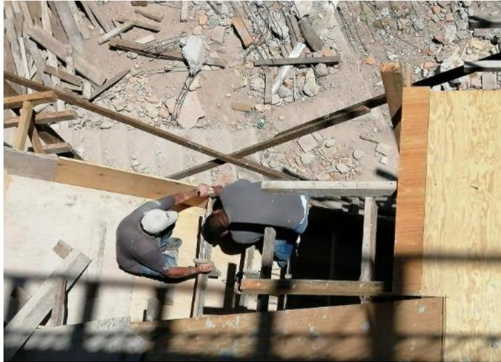
**Ilustración 38 Colocación de madera para contrahuella**
