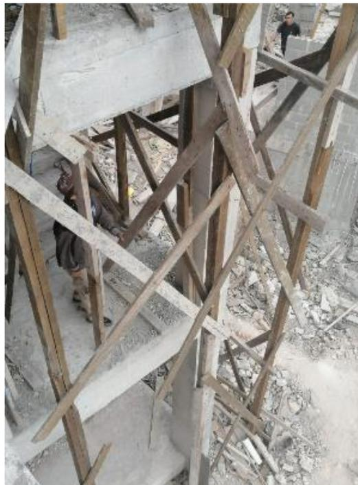
**Ilustración 191 Removimiento de madera a reutilizar**
