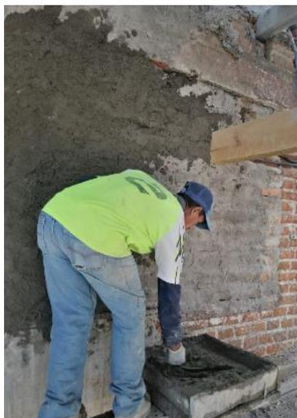
**Ilustración 270 Continuación de repello en caras exteriores de paredes**
