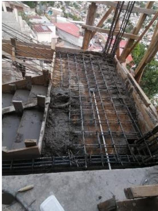
**Ilustración 187 Fundición de losa de descanso**
