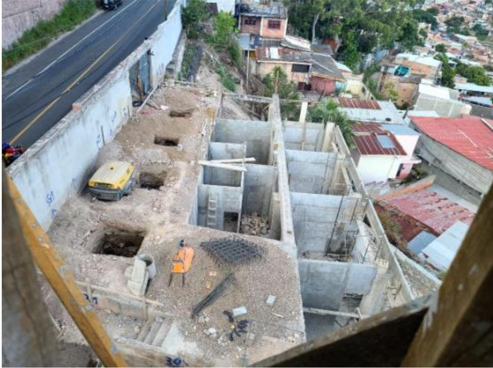
**Ilustración 306 Continuación en excavación para zapatas**
