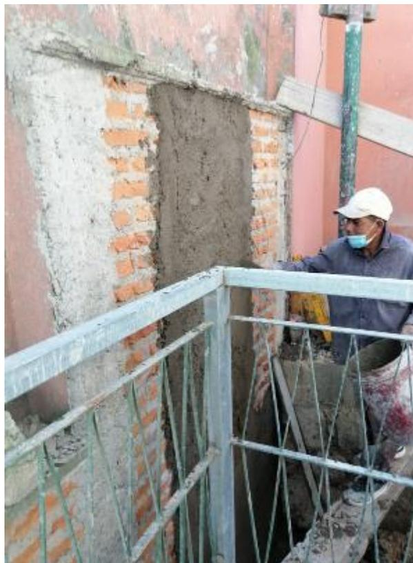
**Ilustración 78 Repello de muro perimetral compartido en un costado**
