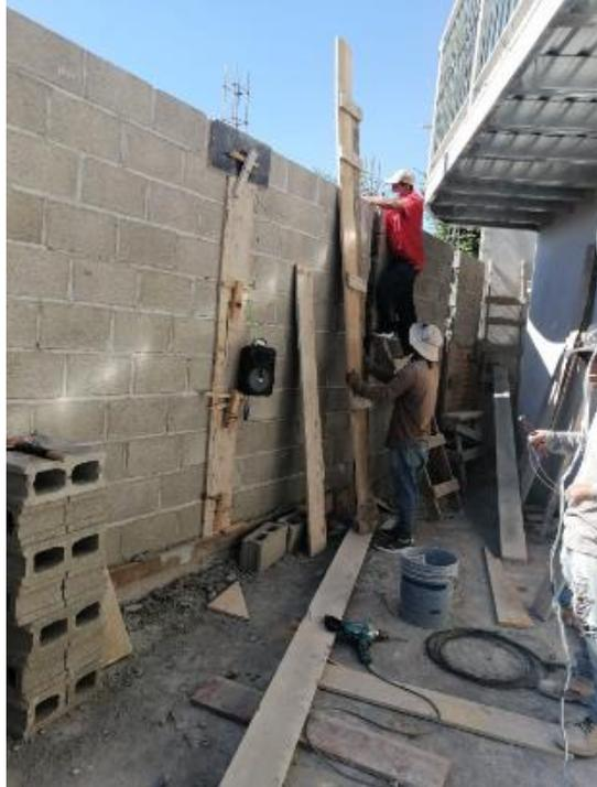
**Ilustración 297 Encofrado de castillos de muro perimetral**
