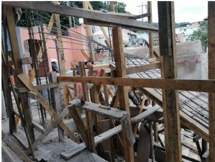
**Ilustración 60 Desmontaje para reconfiguración de escaleras**
