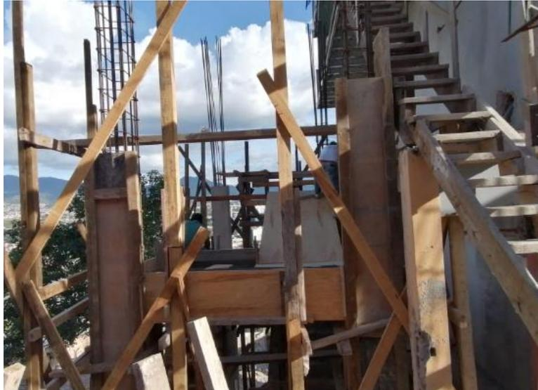
**Ilustración 77 Encofrado de columnas próximas al cubo de escaleras**
