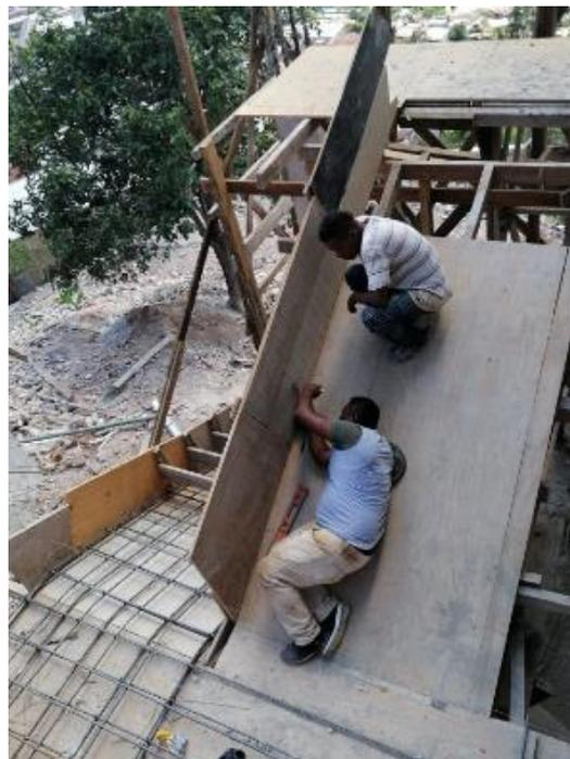
**Ilustración 61 Reconfiguración de escaleras de segundo nivel**
