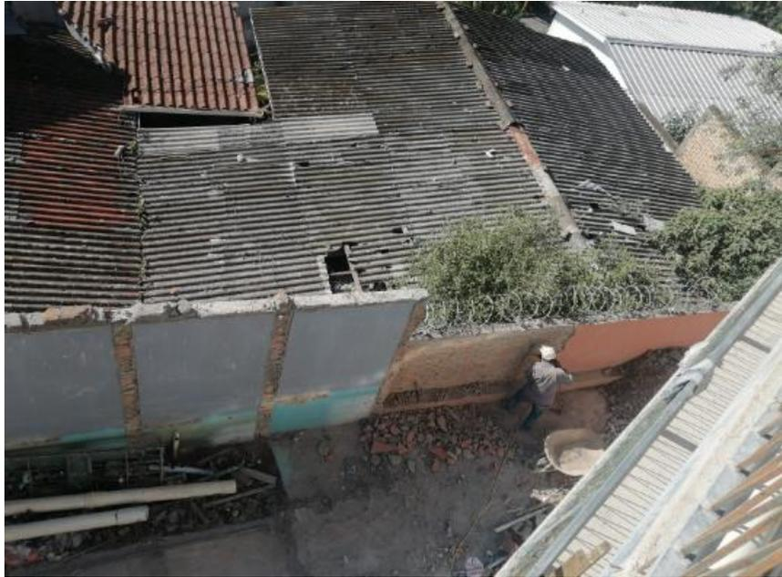
**Ilustración 164 Picado de pared trasera del edificio**
