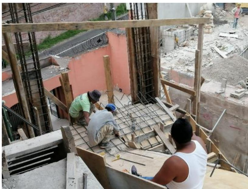
**Ilustración 161 Vuelta en colocación de piloteado y acero de refuerzo**
