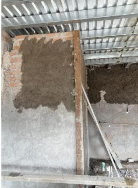
**Ilustración 62 Repello en paredes de 5to nivel**
