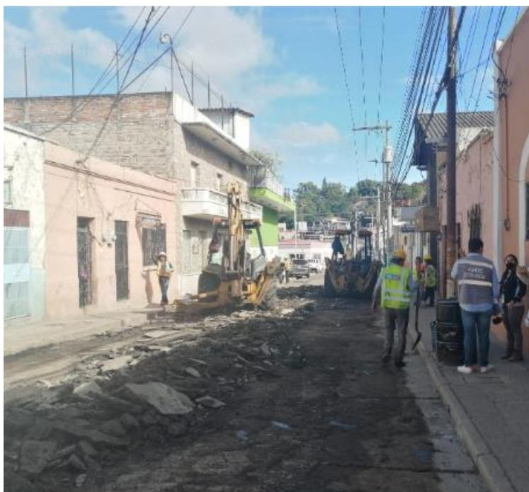
**Ilustración 211 Supervisión en extracción de pavimento antiguo**
