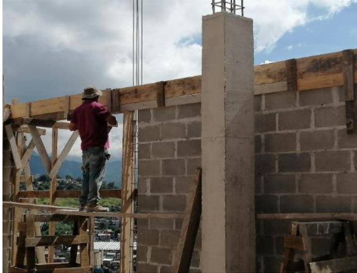
**Ilustración 69 Colocación final del encofrado de solera en zona habitacional 1**
