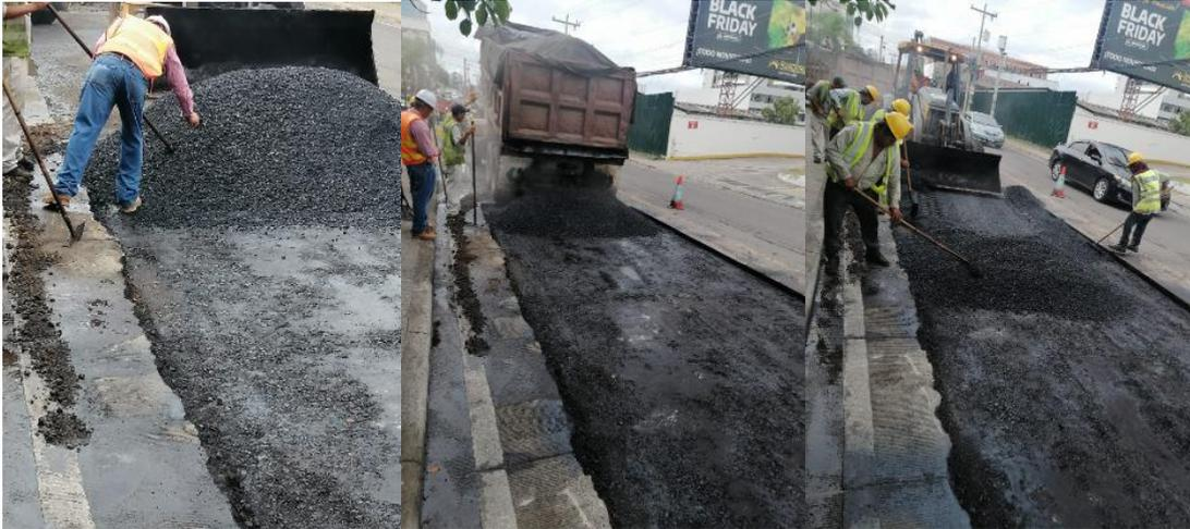
**Ilustración 205 Toma de temperatura y colocación de primera capa de carpeta asfáltica**
