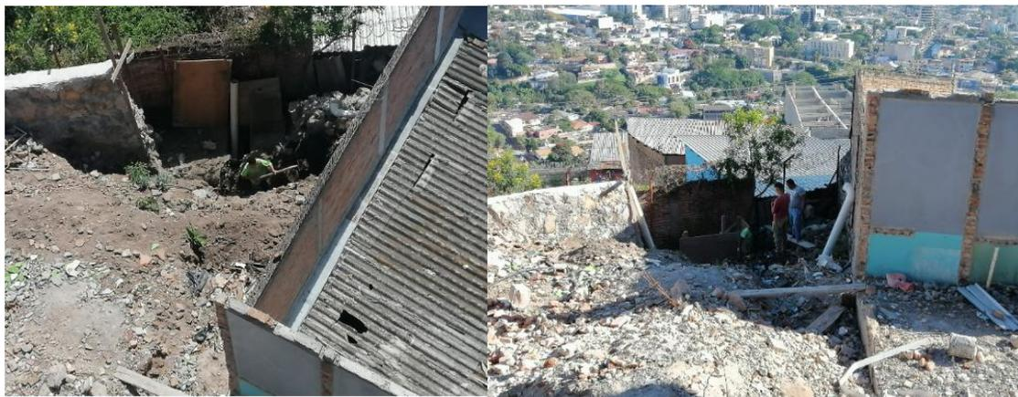
**Ilustración 151 Excavación y delimitación de caja para continuación de muro**
