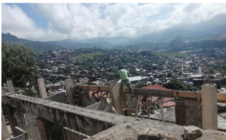
**Ilustración 95 Supervisión y finalización de fundición en sección de zona habitacional 1**
