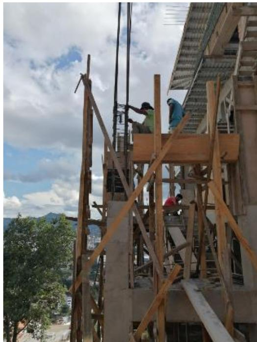
**Ilustración 122 Colocación de anillos y encofrado de otras 2 columnas de gradas
