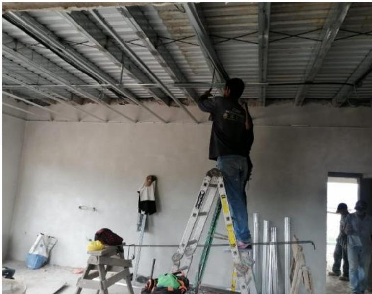
**Ilustración 252 Colocación de ángulos y pequeñas canaletas para encielado**
