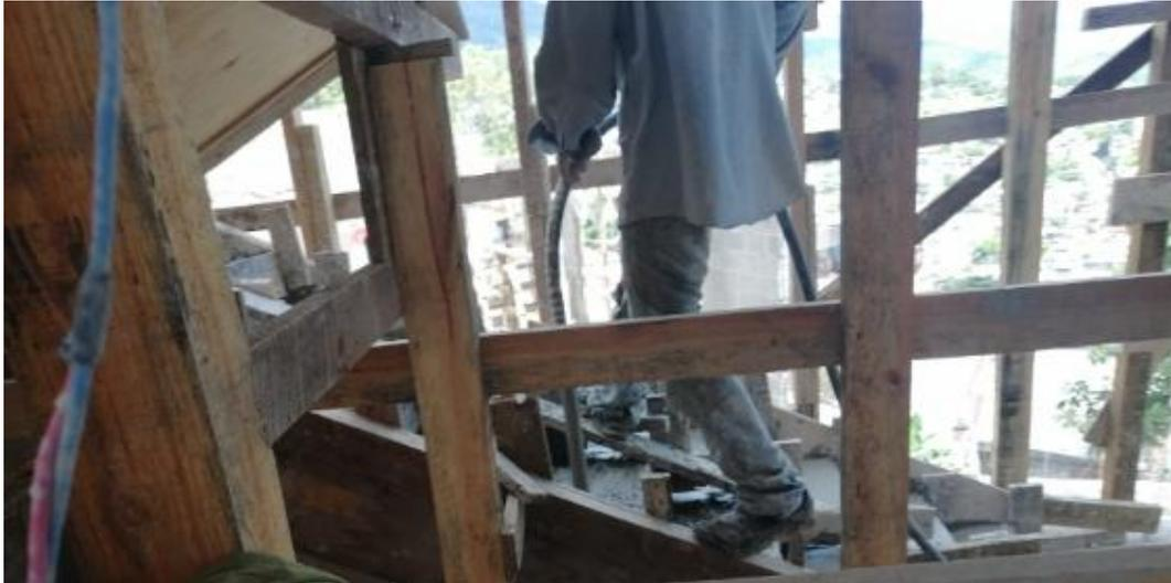
**Ilustración 102 Vibrado de concreto en primer tramo de gradas segundo nivel**
