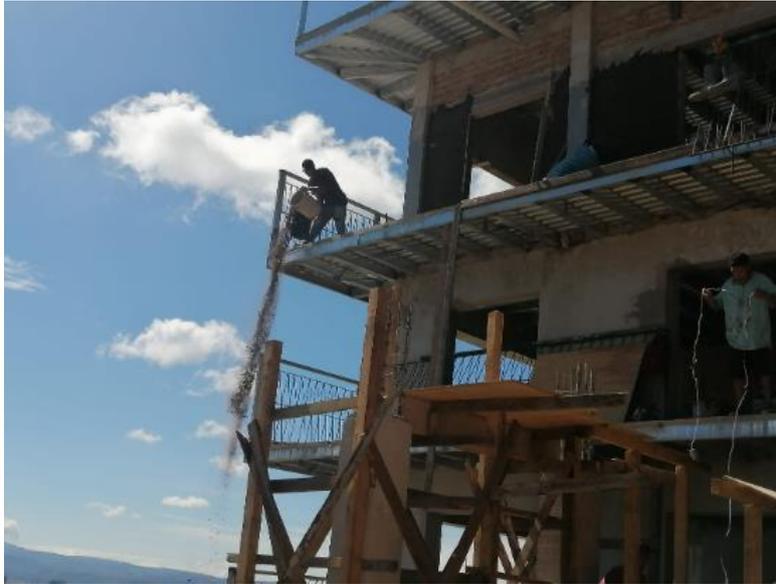
**Ilustración 142 Limpieza de desperdicios de construcción en 5to nivel**
