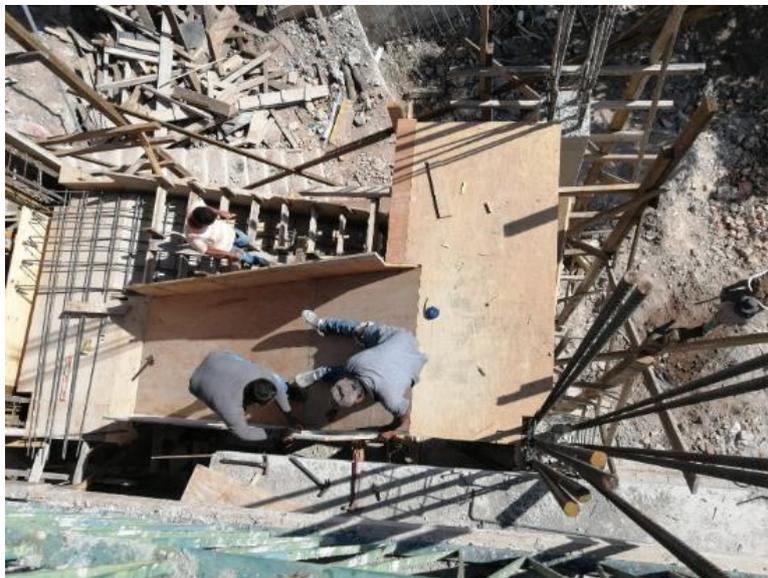
**Ilustración 82 Piloteado y armado de escaleras de segundo nivel**
