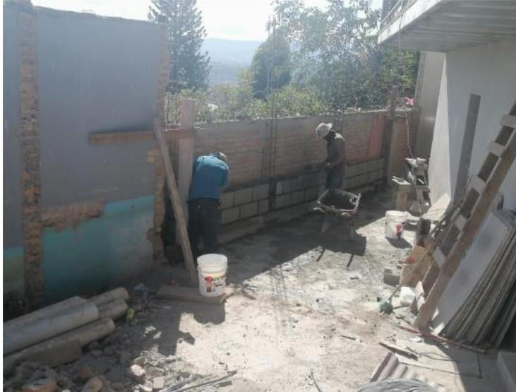
**Ilustración 282 Levantamiento de muro de bloque de hormigón**
