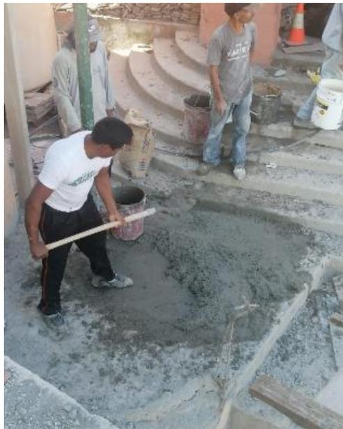
**Ilustración 285 Mezcla de concreto manual**
