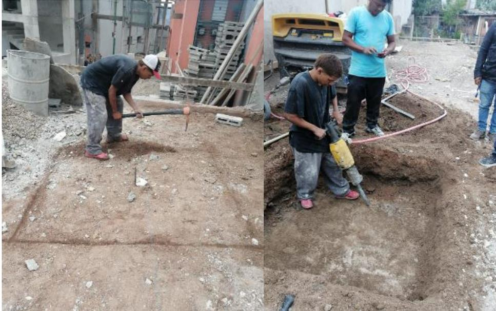
**Ilustración 295 Excavación de zapata Z2**
