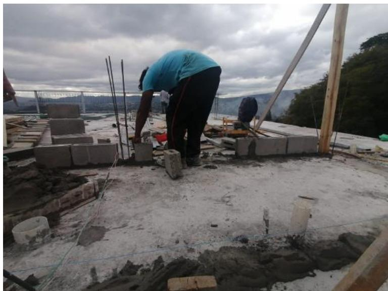
**Ilustración 298 Construcción de paredes en nivel de azotea**
