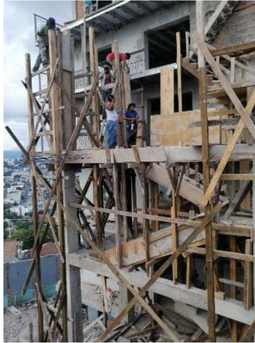
**Ilustración 123 Fundición de sección de columnas de cubo de gradas**
