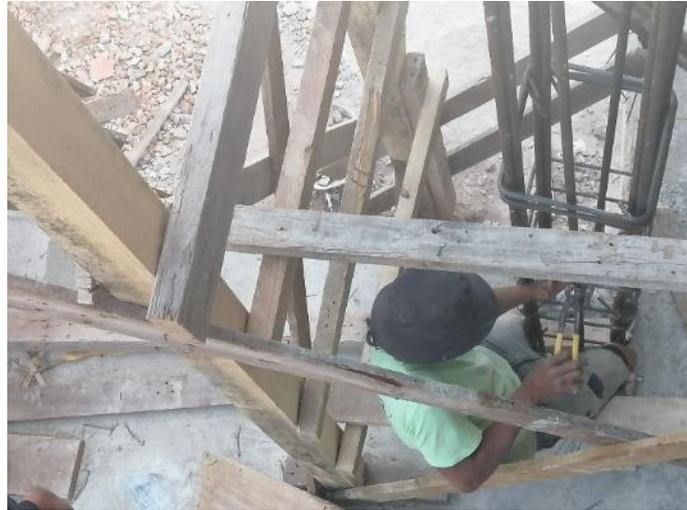
**Ilustración 112 Colocación de anillos a columnas de cubo de gradas de edificio**
