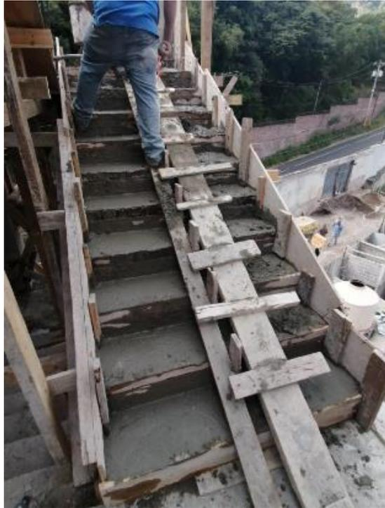
**Ilustración 257 Fundición de primer tramo de gradas de quinto nivel**
