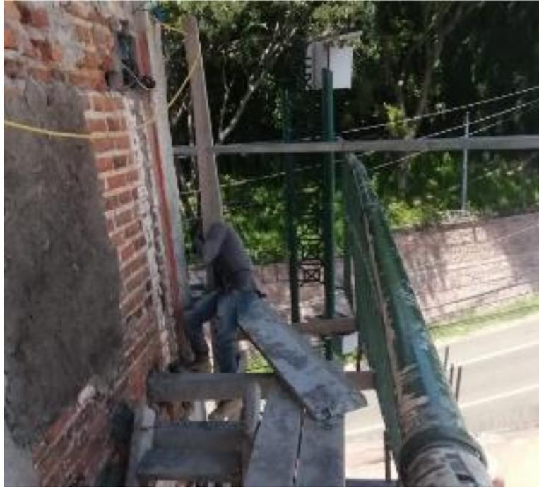
**Ilustración 152 Picado y limpieza de pared paralela a calle principal**
