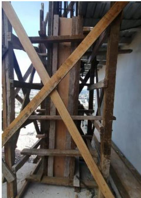
**Ilustración 32 Supervisión de encofrado de columnas**
