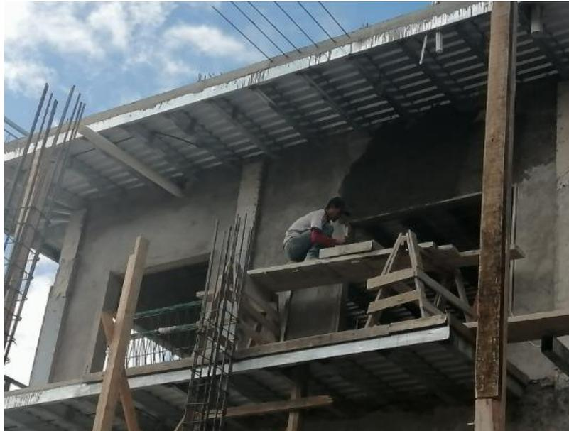
**Ilustración 182 Segunda mano de repello en paredes de quinto nivel**
