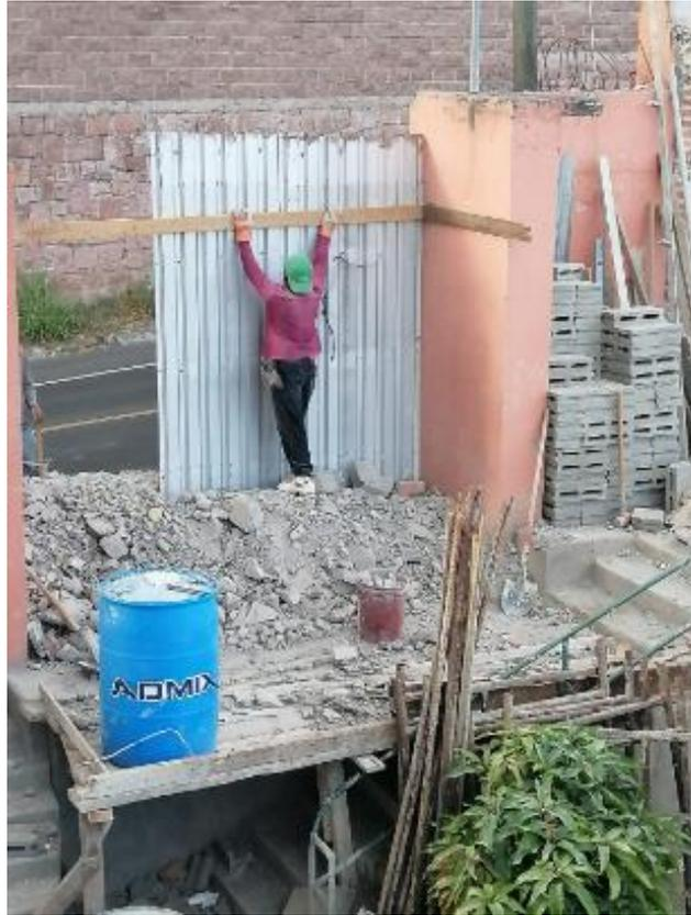
**Ilustración 260 Cubrimiento de acceso con lámina de Aluzinc**
