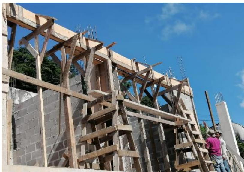
**Ilustración 90 Supervisión de encofrado de castillos en zona habitacional 1**
