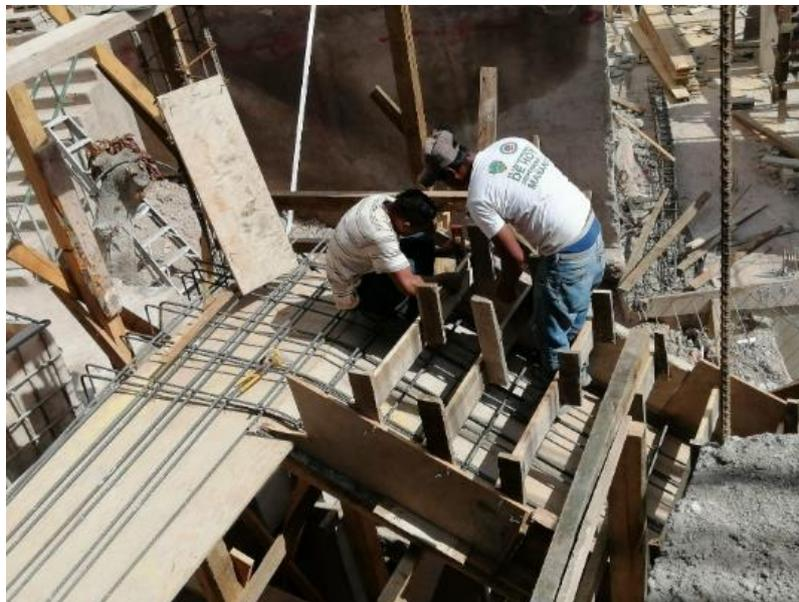
**Ilustración 76 Reconfiguración de escaleras, piloteado y encofrado del segundo nivel**
