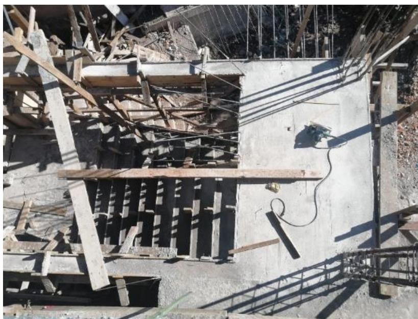
**Ilustración 107 Resultado de fundición de segundo tramo de gradas del 2do nivel**
