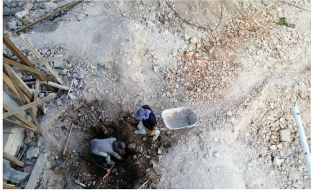
**Ilustración 83 Extracción de tierra para muro de contención**
