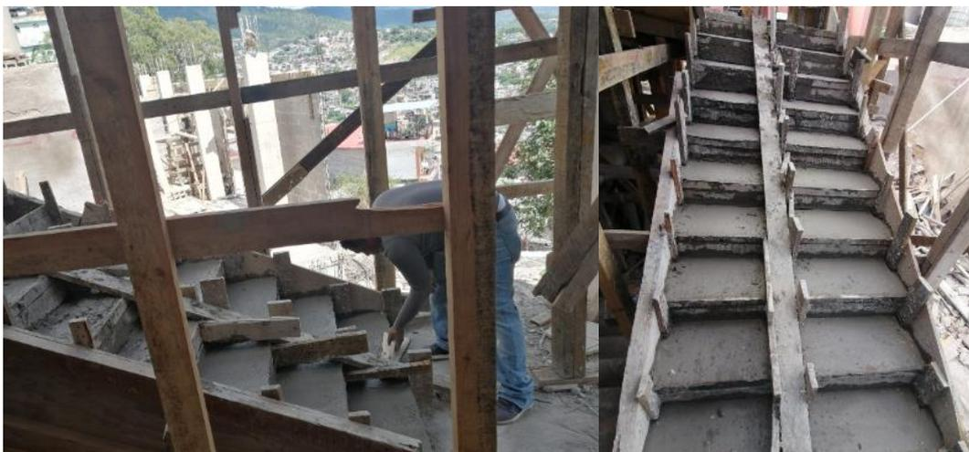
**Ilustración 103 Acabado de primer tramo de escaleras de segundo nivel**
