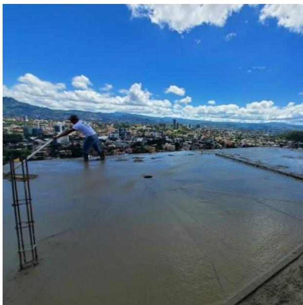
**Ilustración 59 Losa de azotea fundida**
