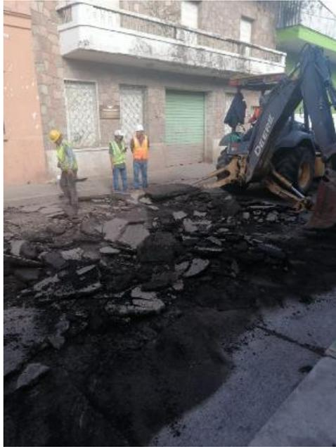
**Ilustración 210 Extracción de pavimento**
