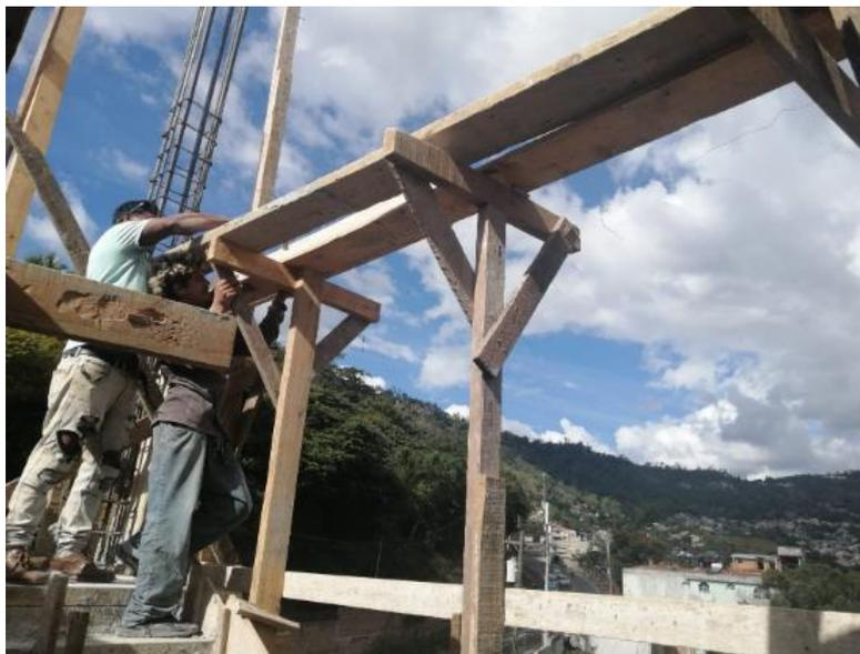
**Ilustración 263 Encofrado de viga lateral de cubo de gradas de quinto nivel**
