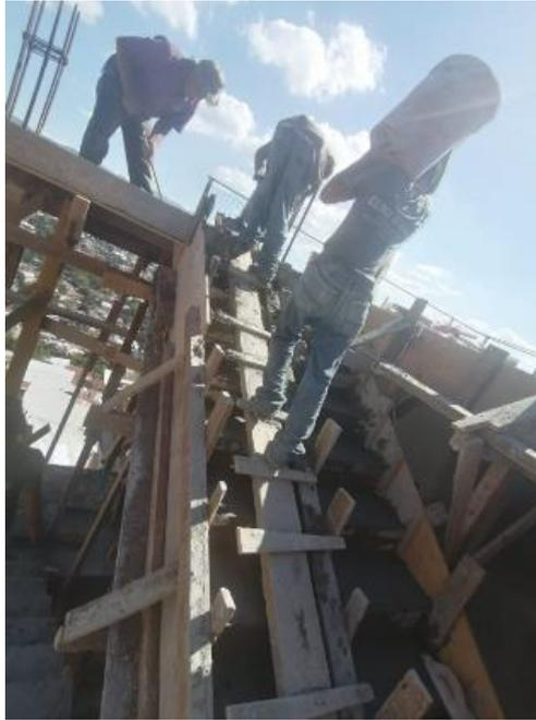
**Ilustración 286 Fundición de gradas y losa de quinto nivel**
