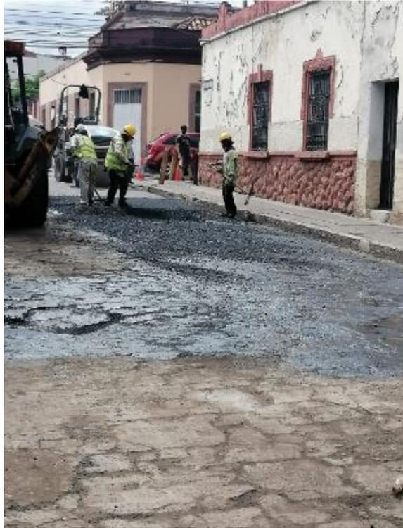
**Ilustración 216 Colocación y rastrillado de carpeta asfáltica**
