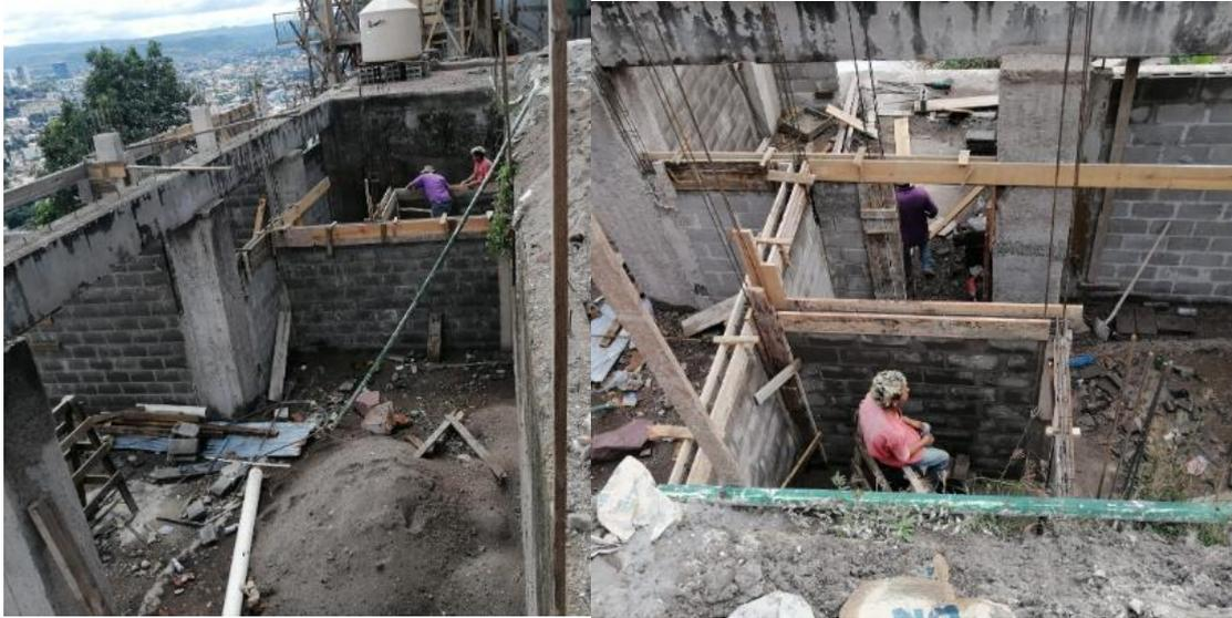
**Ilustración 132 Colocación de encofrado de soleras en monoambiente de zona habitacional 1**
