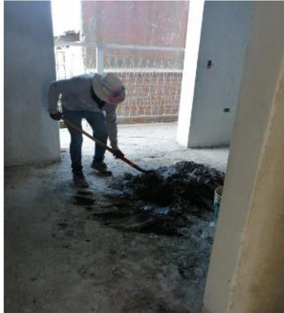
**Ilustración 86 Mezcla para repello**
