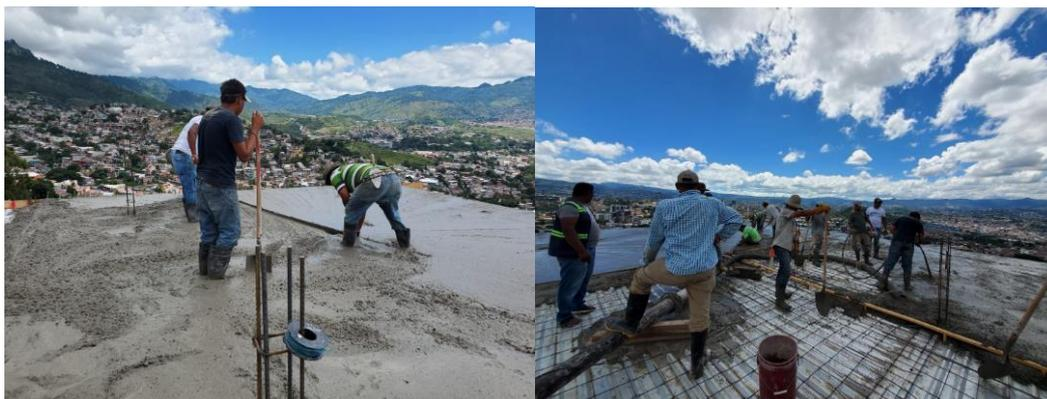
**Ilustración 57 Fundición de losa por bombeo**
