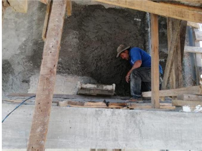
**Ilustración 274 Continuación de repello de paredes**
