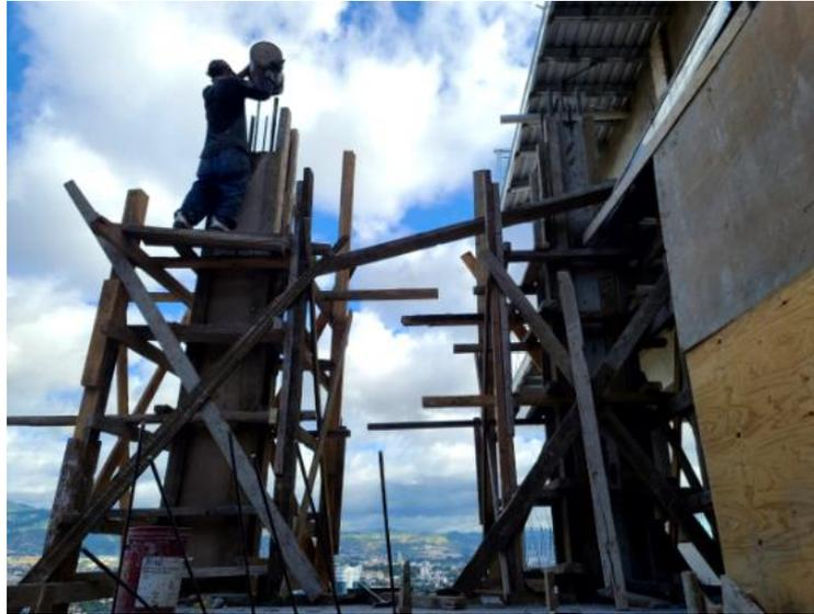
**Ilustración 198 Fundición de sección de columnas de cuarto nivel**
