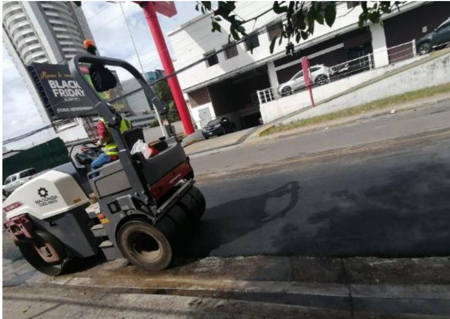
**Ilustración 207 Compactación de carpeta mediante vibro compactador**
