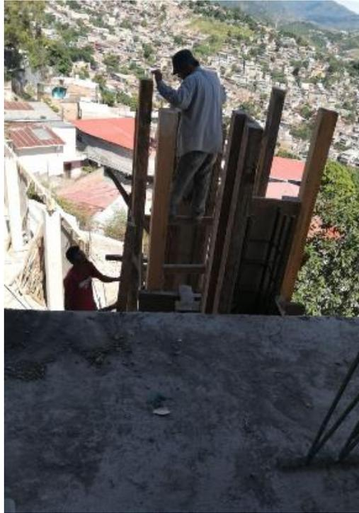
**Ilustración 116 Colocación de anillos y encofrado de columnas de 3er nivel**
