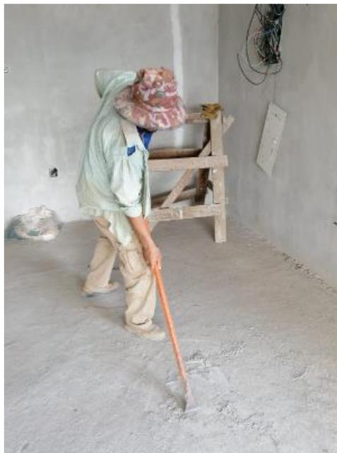
**Ilustración 63 Limpieza de segundo nivel con el uso de una barra**
