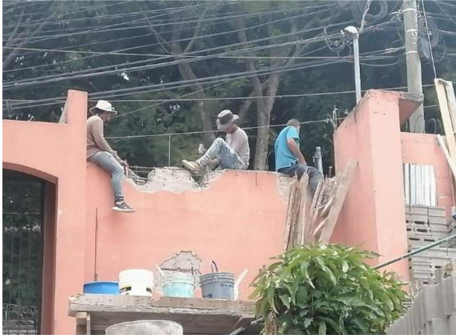
**Ilustración 258 Demolición de muro principal**
