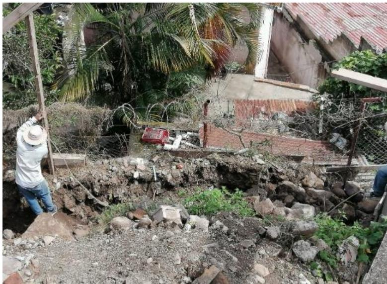
**Ilustración 133 Toma de nivel para seguimiento en construcción de muro de contención**
