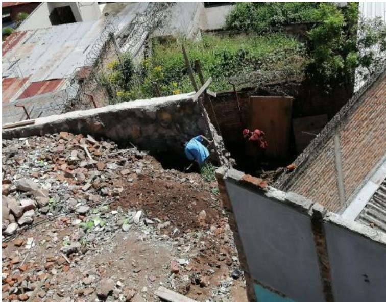
**Ilustración 136 Extracción de terreno alrededor de caja de aguas lluvias**
