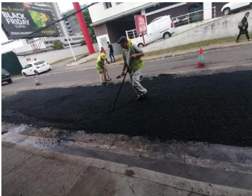
**Ilustración 206 Colocación de segunda capa en carpeta**
