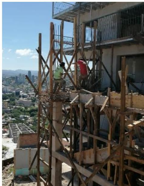
**Ilustración 113 Inicio de piloteado para escaeras del tercer nivel**
