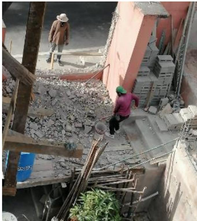
**Ilustración 259 Limpieza de escombros de muro**
