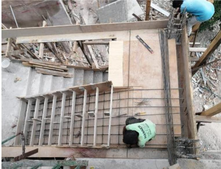
**Ilustración 176 Seguimiento de encofrado, piloteado y petate de losa**
