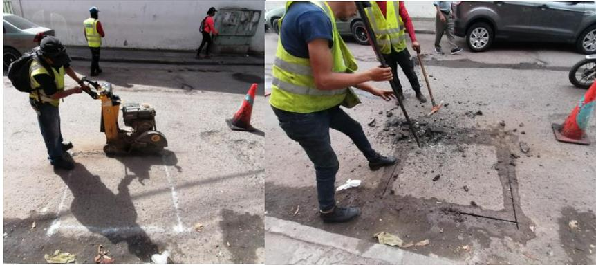
**Ilustración 219 Extracción manual de 1 m<sup>2</sup> de carpeta asfáltica**
