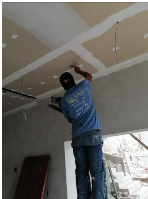
**Ilustración 185 Empastado en enclavado de primer nivel**
