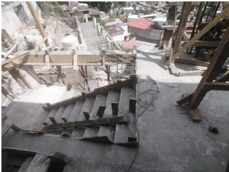
**Ilustración 189 Resultado de fundición segundo tramo de gradas de 3er nivel**
