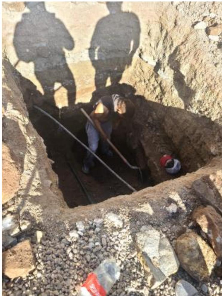
**Ilustración 301 Continuación en excavación para zapatas**
