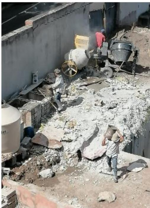
**Ilustración 58 Complementación de fundición de losa de azotea**
