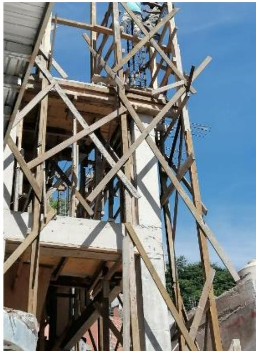
**Ilustración 115 Seguimiento en piloteado de gradas de 3er nivel**
