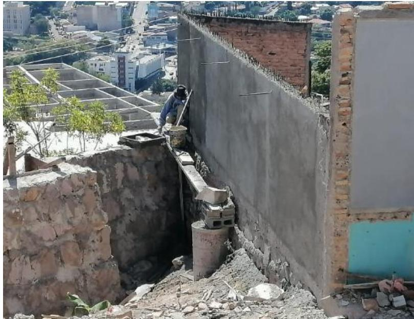
**Ilustración 232 Continuación de repello de pared próxima a muro**
