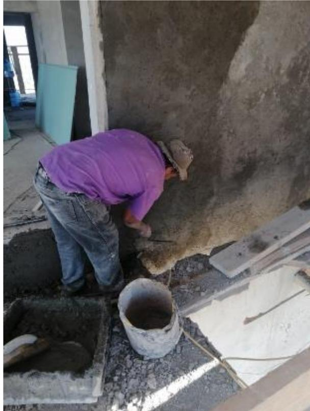
**Ilustración 280 Continuación de repello de paredes exteriores.**
