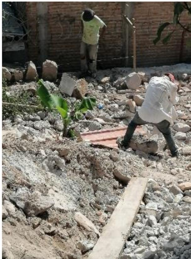
**Ilustración 72 Picado de piedra ripio para hiladas en muro de contención**
