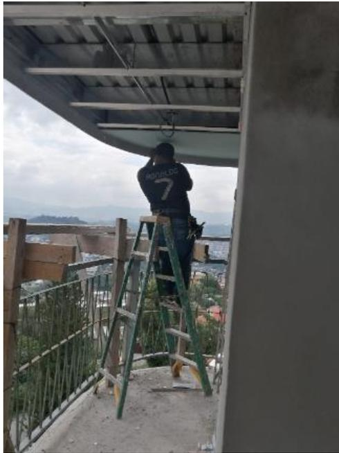
**Ilustración 237 Colocación de tabla yeso RH en voladizo**
