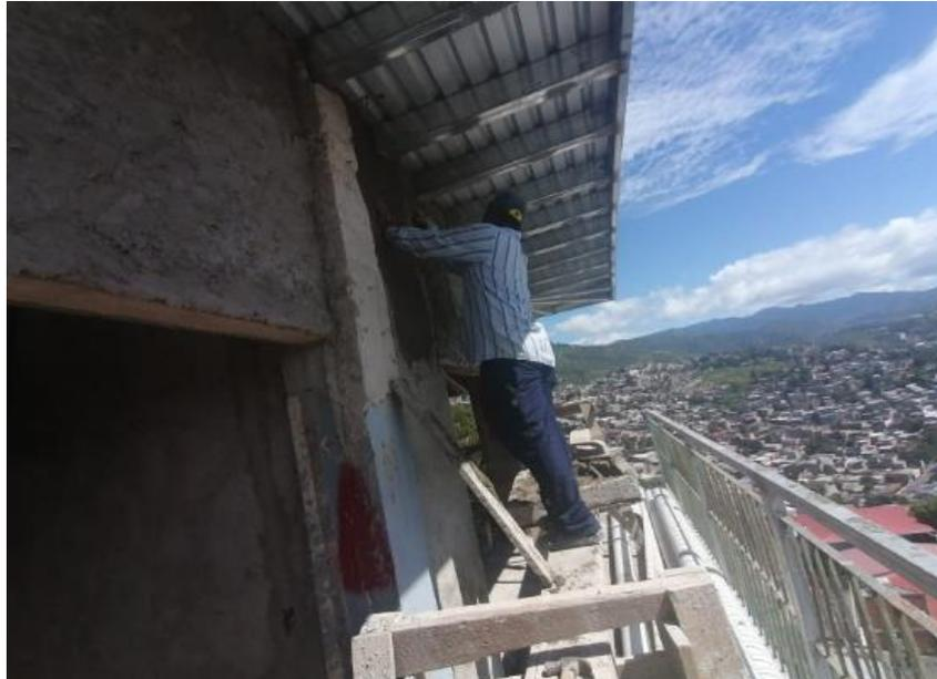
**Ilustración 148 Repello de paredes exteriores**
