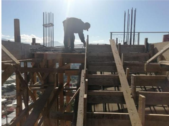
**Ilustración 284 Colocación de armado de losa que conecta con el nivel de azotea**
