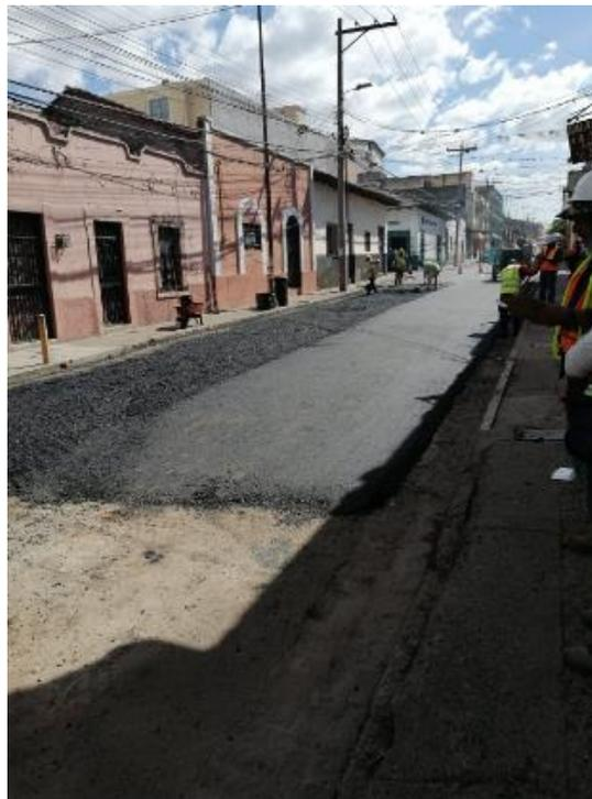
**Ilustración 217 Vibrado de carpeta y completación de tramo**
