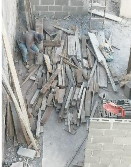
**Ilustración 278 Removimiento de clavos en madera**
