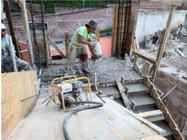
**Ilustración 162 Fundición y vibrado de primer tramo de gradas y losa de descanso de 3er nivel**
