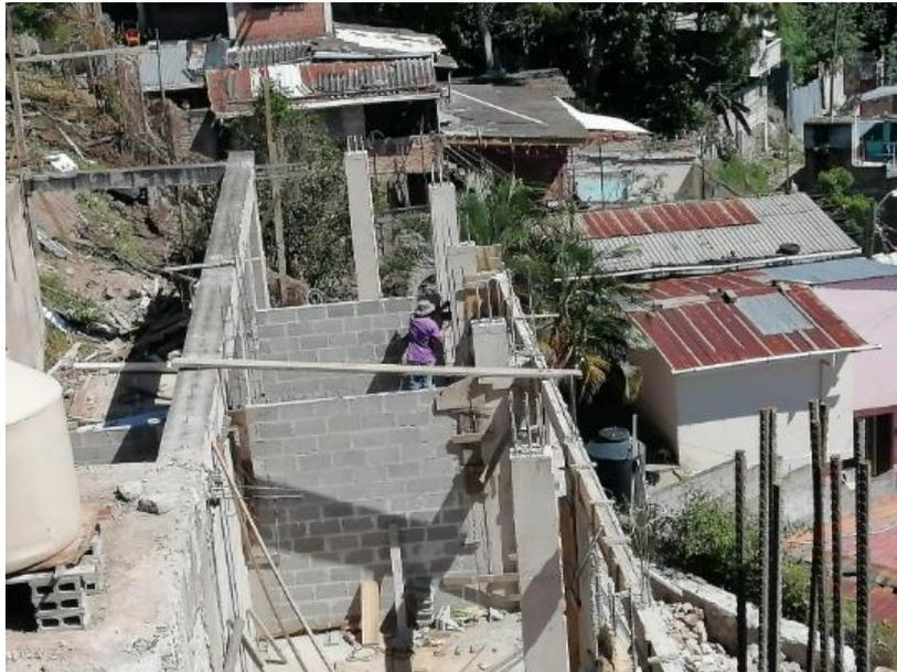
**Ilustración 108 Armado y colocación de anillos en castillo de zona habitacional 1**
