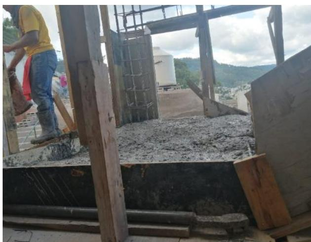
**Ilustración 101 Fundición de losa de descanso**
