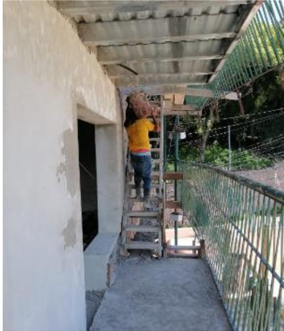
**Ilustración 88 Movilización de mezcla para repello de paredes en 5to nivel**
