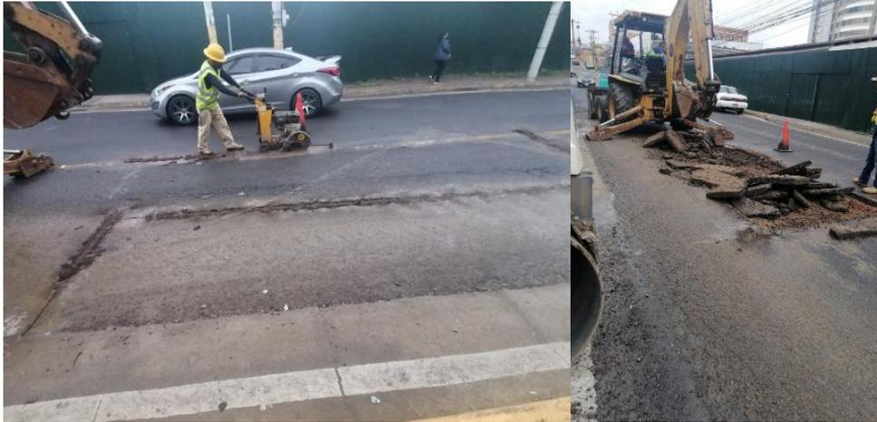
**Ilustración 201 Corte y extracción de carpeta de baches**
