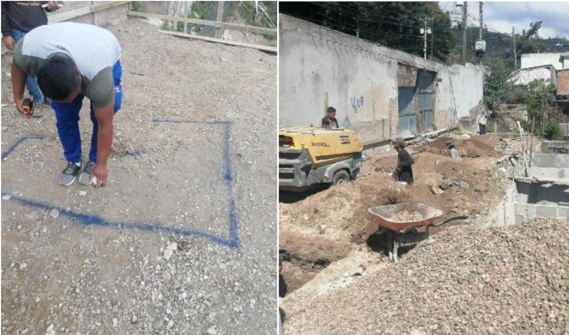
**Ilustración 299 Continuación en excavación de zapatas**
