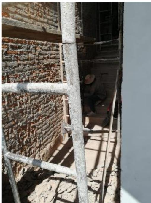
**Ilustración 45 Limpieza de pared compartida con vecino para posterior repello**
