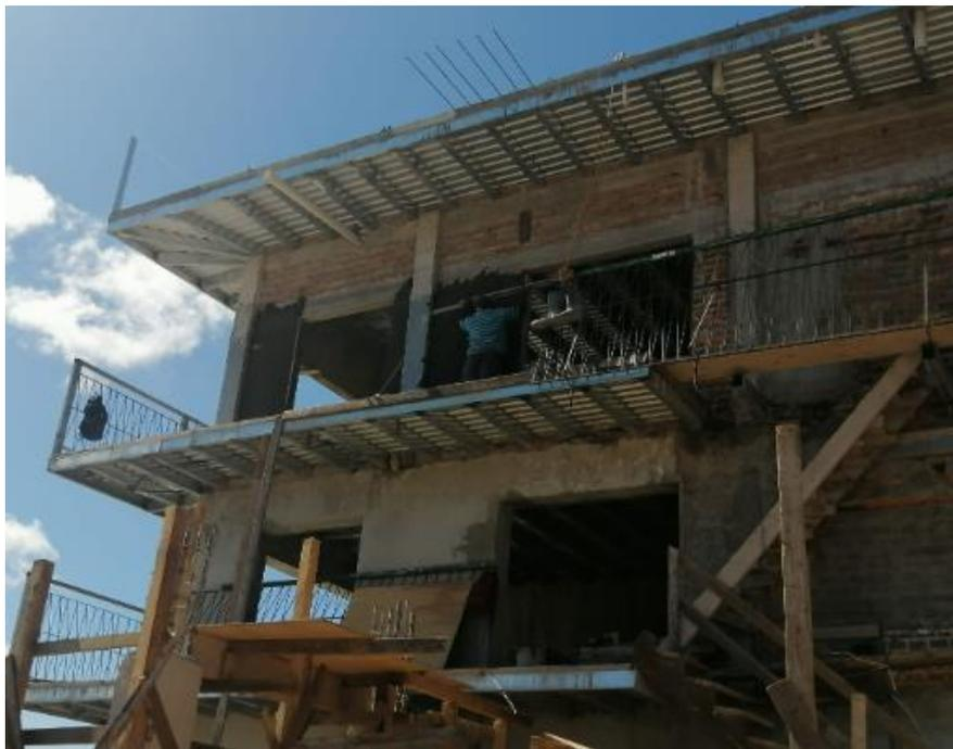
**Ilustración 143 Repello de paredes en la cara exterior**
