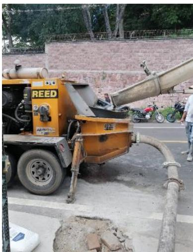
**Ilustración 56 Bombeo de concreto**
