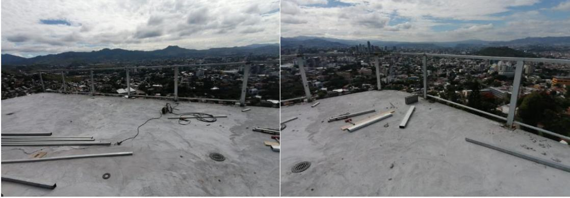
**Ilustración 156 Instalación de barandales en nivel de azotea**
