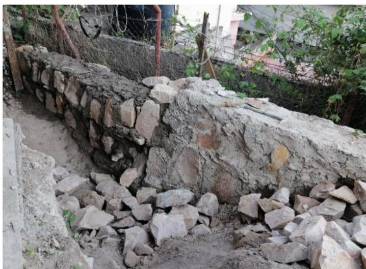
**Ilustración 65 Ampliación de muro de contención dos hiladas arriba**
