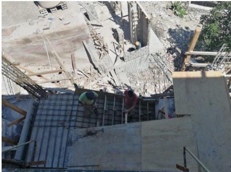
**Ilustración 146 Armado de gradas tercer nivel**
