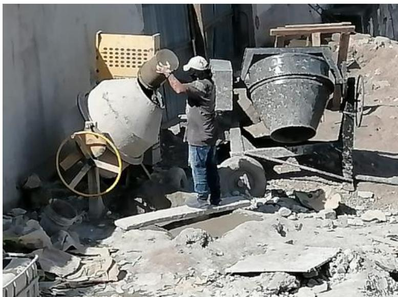
**Ilustración 70 Mezcla de mortero para nuevas hiladas en muro de contención**
