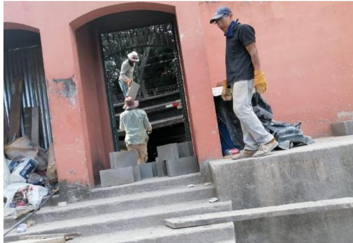
**Ilustración 99 Llegada y movilización de bloques de hormigón de pedido**
