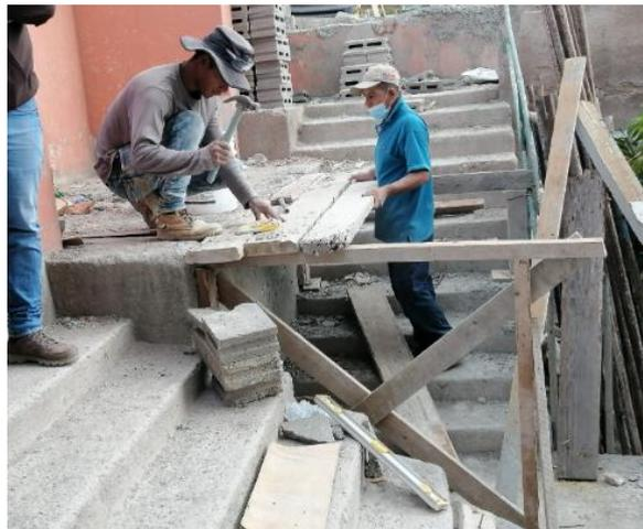
**Ilustración 245 Construcción de tarima para agregados**
