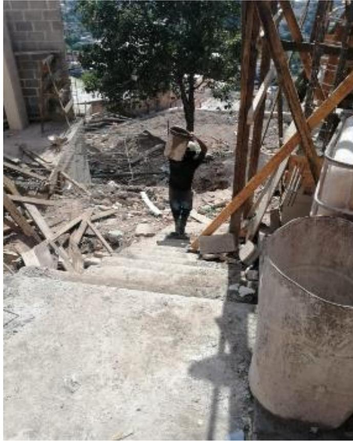
**Ilustración 71 Movilización de mortero para muro de contención**
