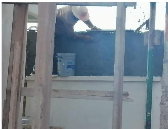
**Ilustración 236 Repello en pared perimetral**
