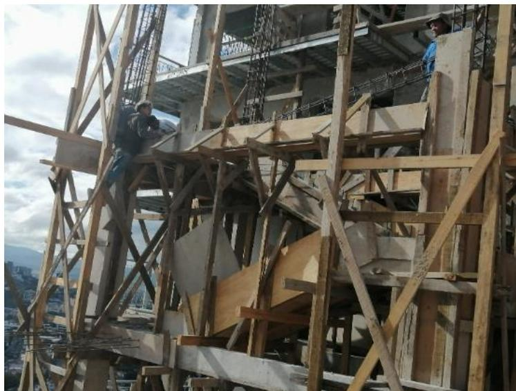
**Ilustración 183 Colocación de armado para viga lateral**
