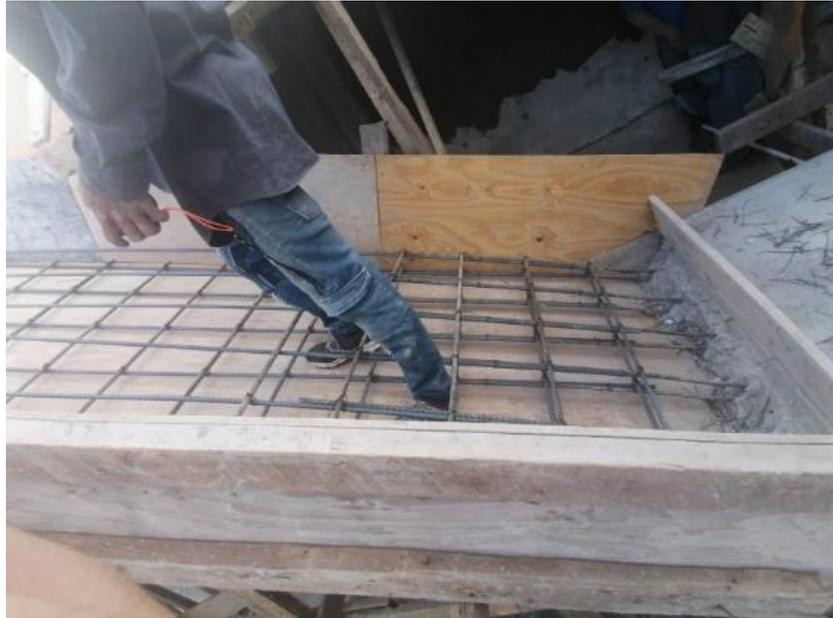
**Ilustración 276 Colocación de armado de segundo tramo de gradas de quinto nivel**
