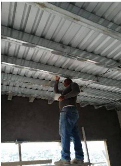
**Ilustración 128 Drenajes de losa de azotea tapados**
