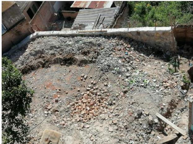
**Ilustración 84 Colocación de tierra en proximidad del muro, que luego será compactada**
