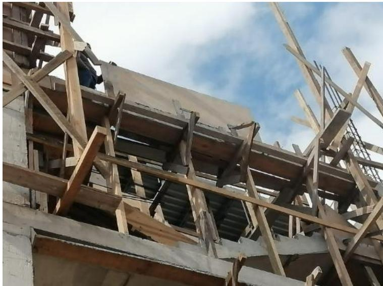
**Ilustración 240 Configuración de gradas de quinto nivel**
