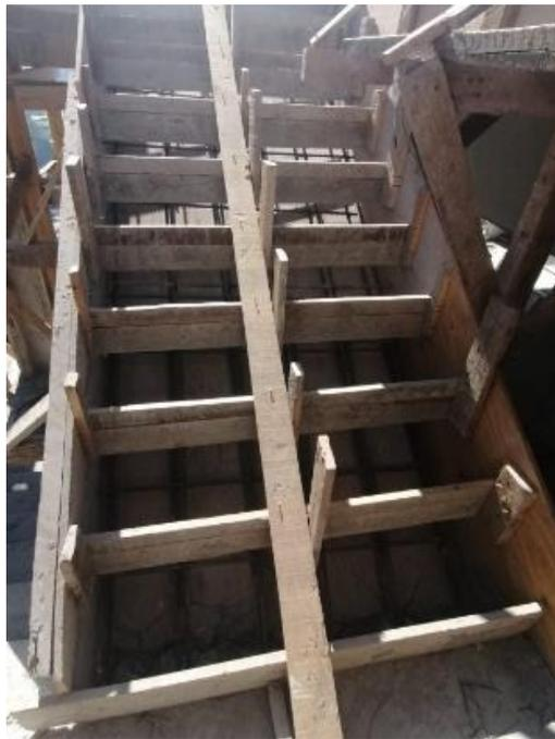
**Ilustración 283 Piloteado de segundo tramo de gradas de quinto nivel**
