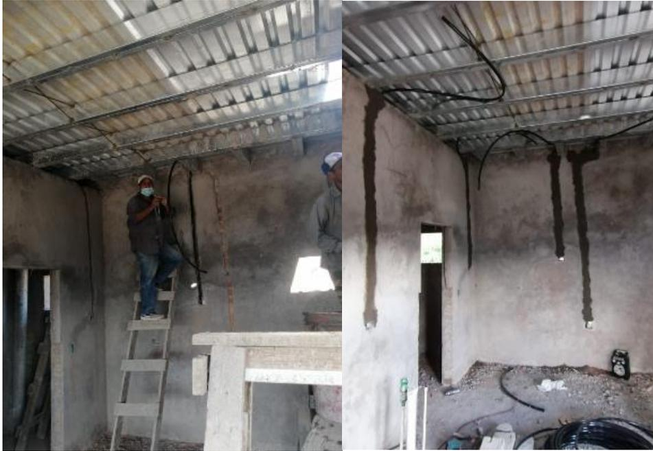
**Ilustración 127 Colocación de cableado en quinto nivel**
