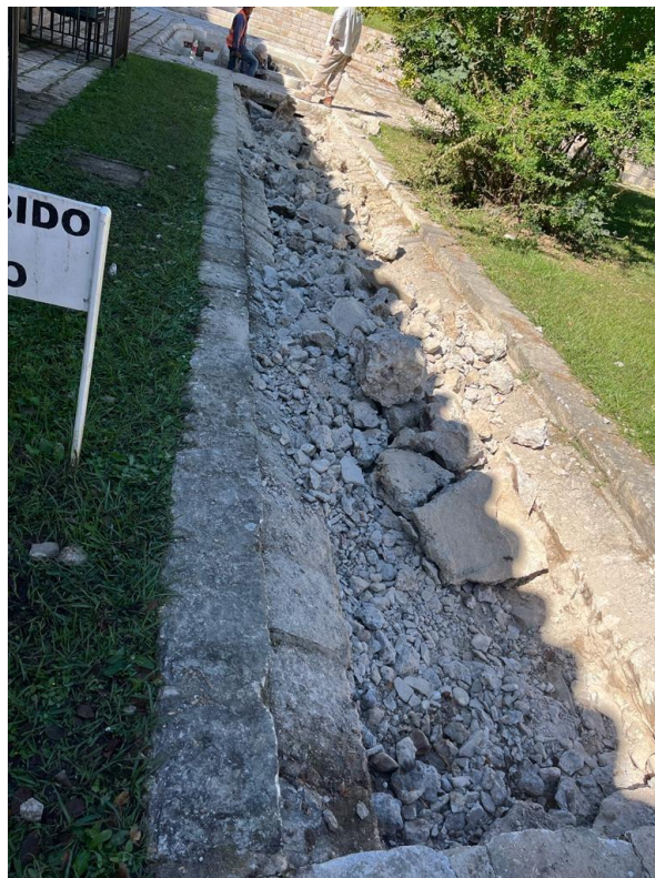
Ilustración 150. Demolición de losa en canal
