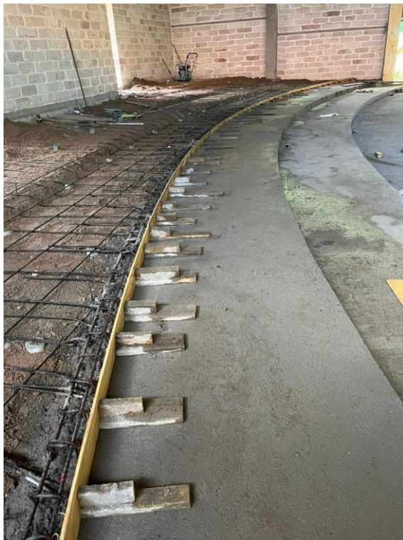
Ilustración 128. Finalización del firme de la décimo segunda gradería
