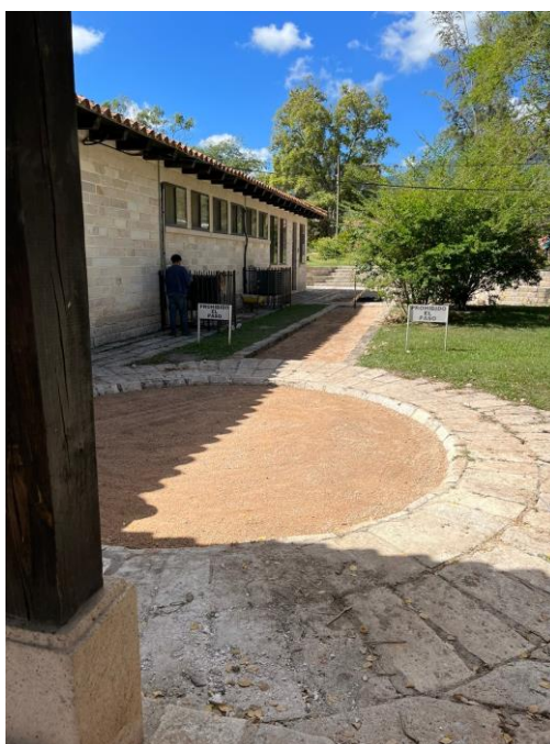
Ilustración 163. Finalización de sellado de pilas con material selecto
