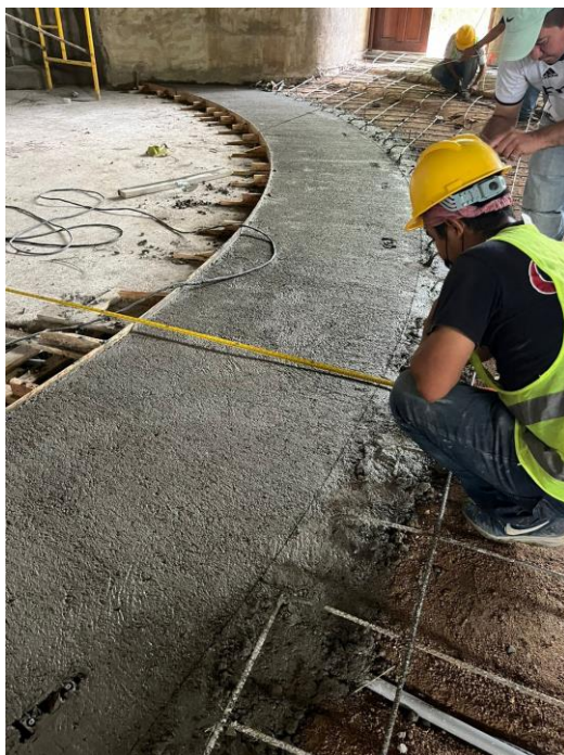
Ilustración 104. Finalización del firme de la primera gradería
