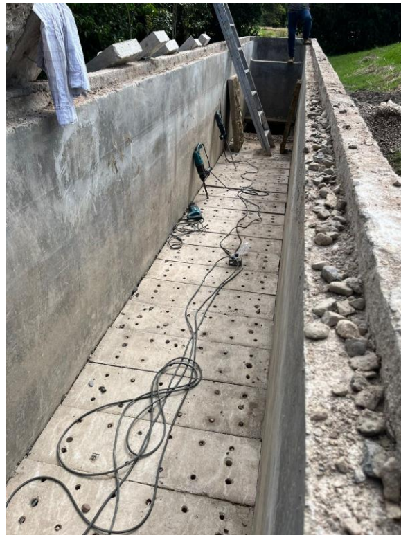
Ilustración 35. fondo falso sistema FAFA
