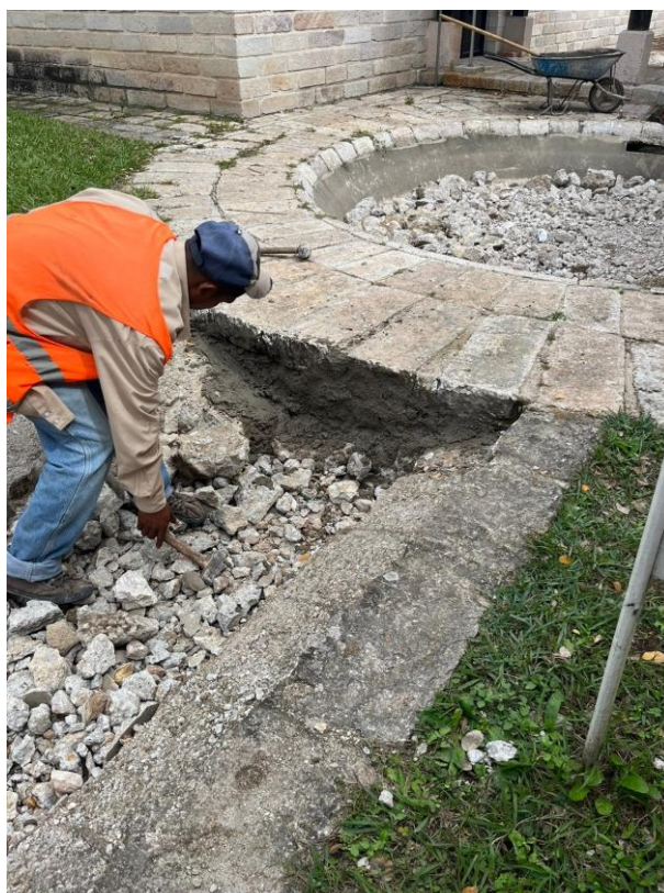
Ilustración 157. Sellado con mortero en entrada y salida de piletas
