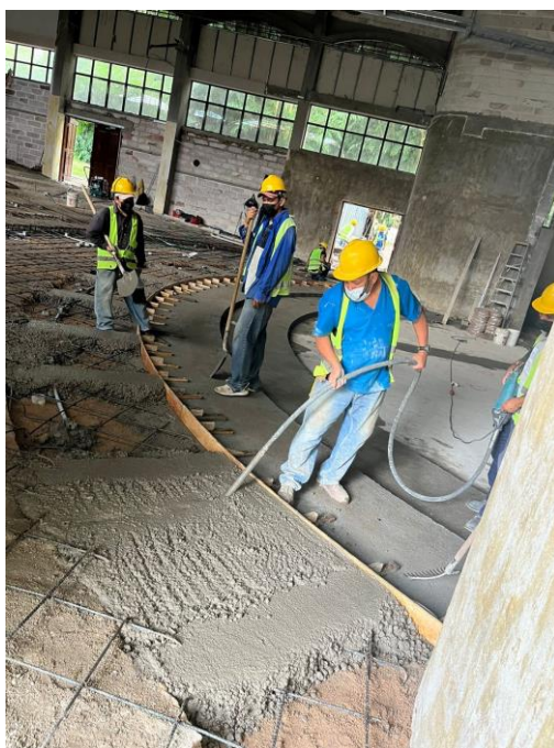
Ilustración 109. Vibrado de concreto para la tercera gradería
