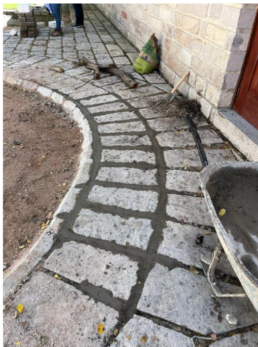
Ilustración 162. Finalización de acera con piedra existente7
