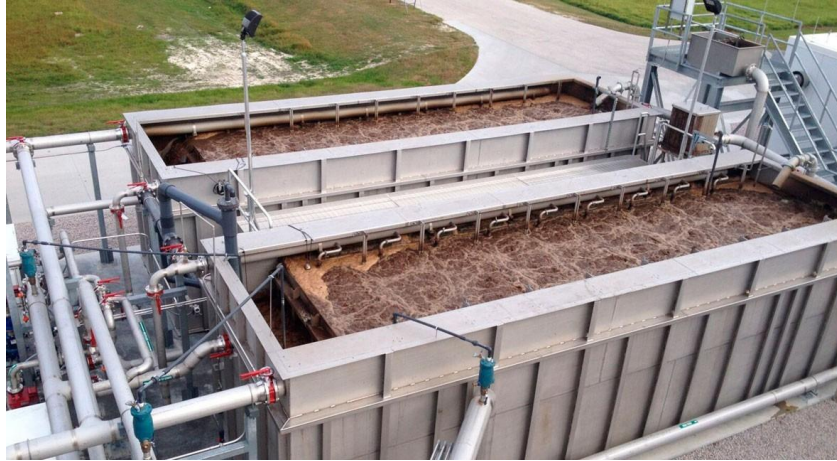
Ilustración 19. Biorreactor de membranas
