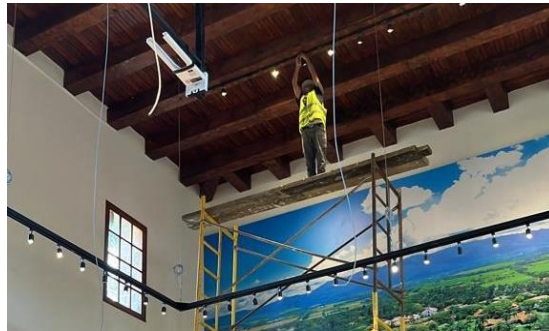
Ilustración 78. Colocación de luminarias con tubo galvanizado
