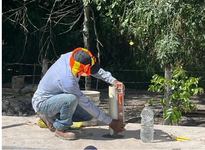
Ilustración 47. Elaboración de agujeros para tubos de ventila
