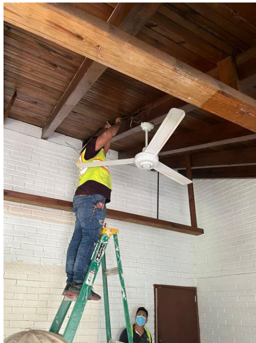
Ilustración 140. Desmontaje de ventilador
