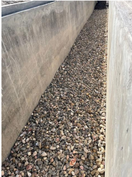
Ilustración 25. Colocación de material filtrante grava 1"φ.
