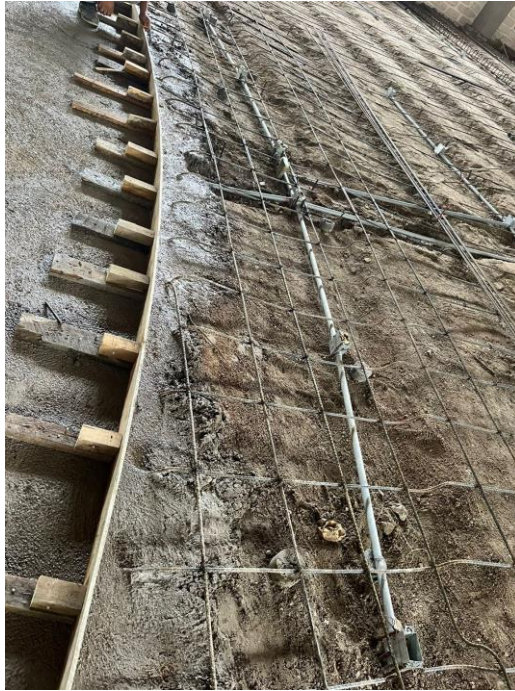
Ilustración 116. Armado de hierro para la sexta gradería
