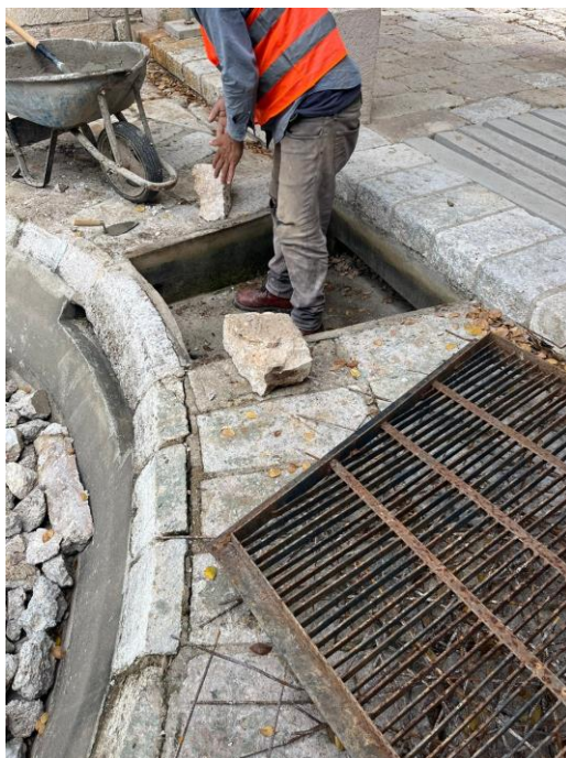
Ilustración 158. Desmontaje de rejillas y vigueta de concreto
