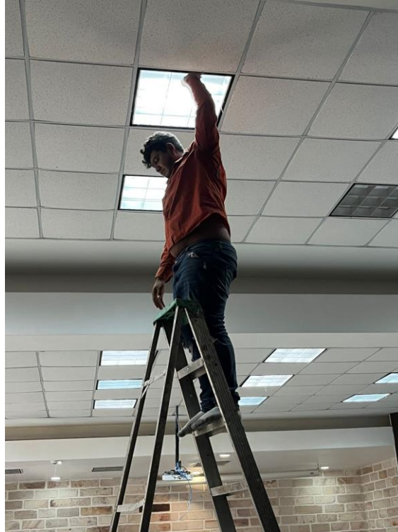
Ilustración 58. Supervisión de instalación de nuevas luminarias
