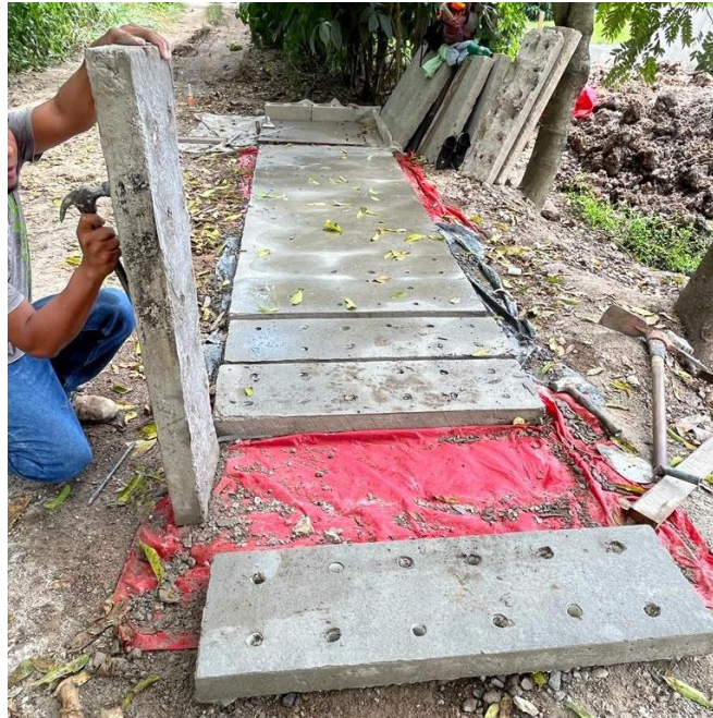
Ilustración 42. Elaboración de tapaderas descartadas
