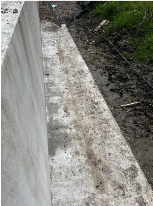
Ilustración 38. Cuneta de concreto
