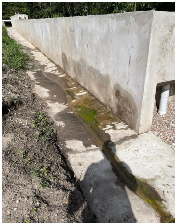
Ilustración 86. Fugas de líquido en el sistema FAFA
