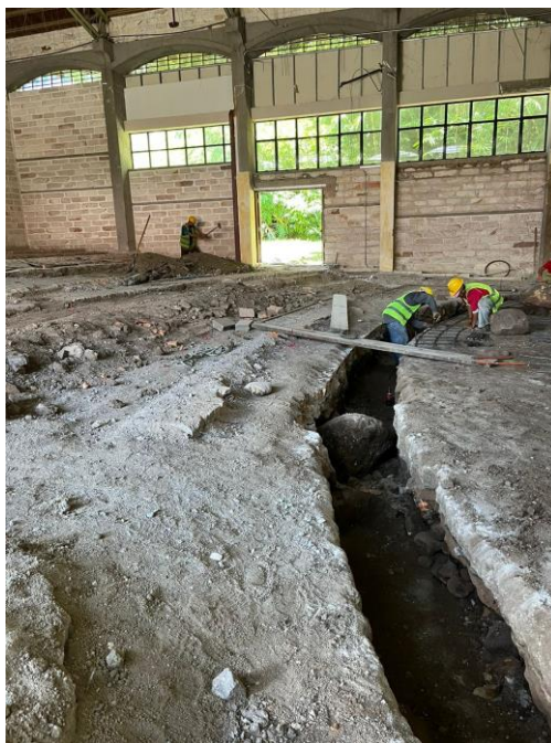
Ilustración 94. Cimentación de mampostería de piedra
