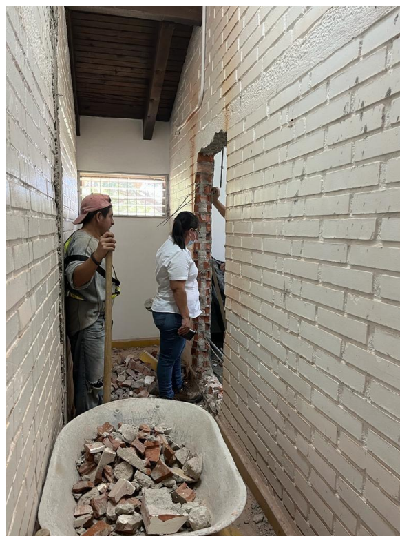
Ilustración 152. nuevo boquete para nueva puerta
