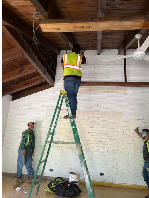
Ilustración 139. Desmontaje de ductería y cableado
