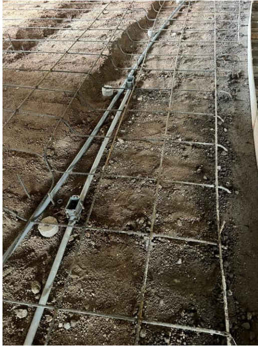
Ilustración 131. Armado de hierro para la décimo cuarta gradería
