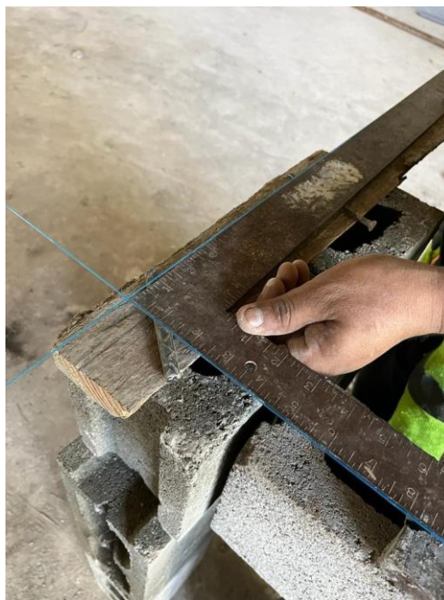
Ilustración 96. Verificación de eje central
