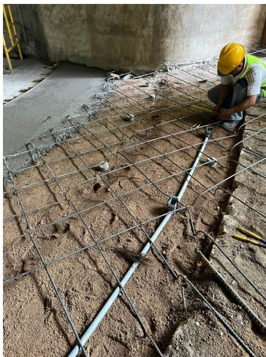
Ilustración 105. Armado de hierro para la segunda gradería
