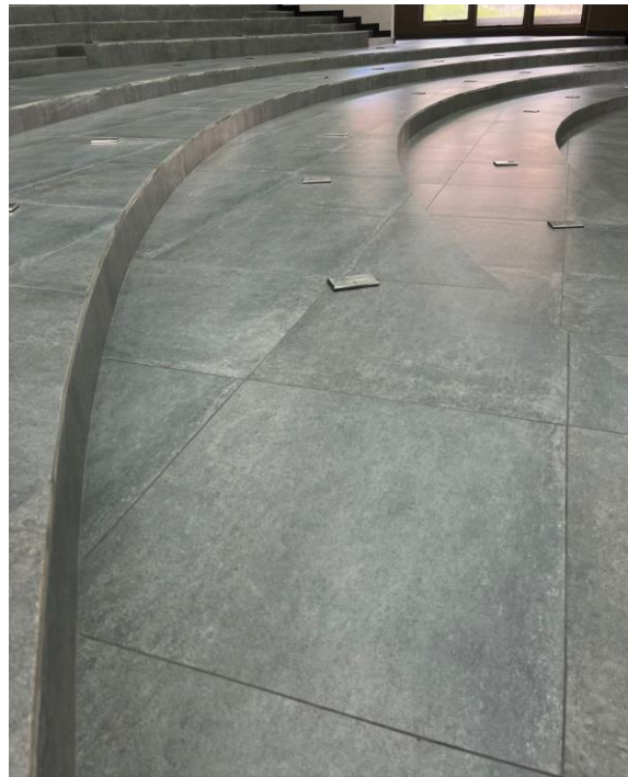
Ilustración 60. Supervisión de acabado en porcelanato
