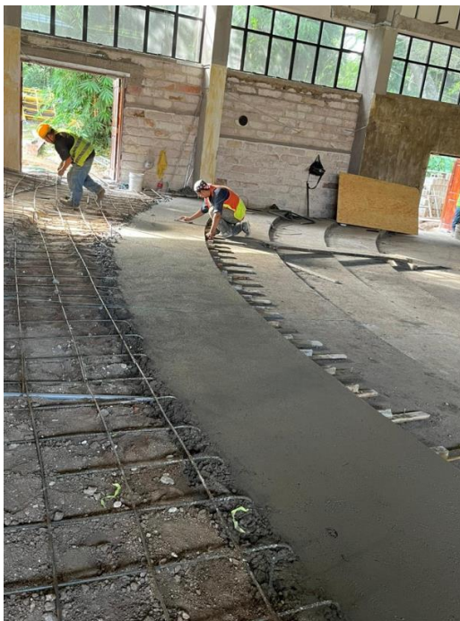
Ilustración 121. Finalización del firme de la octava gradería
