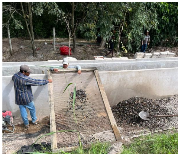
Ilustración 53. Lavado y tamizado de material filtrante
