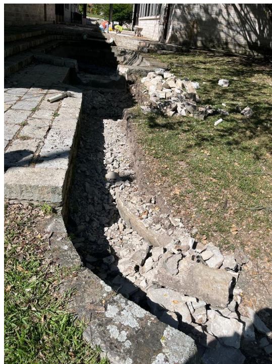
Ilustración 148. Extracción de piedra cuña
