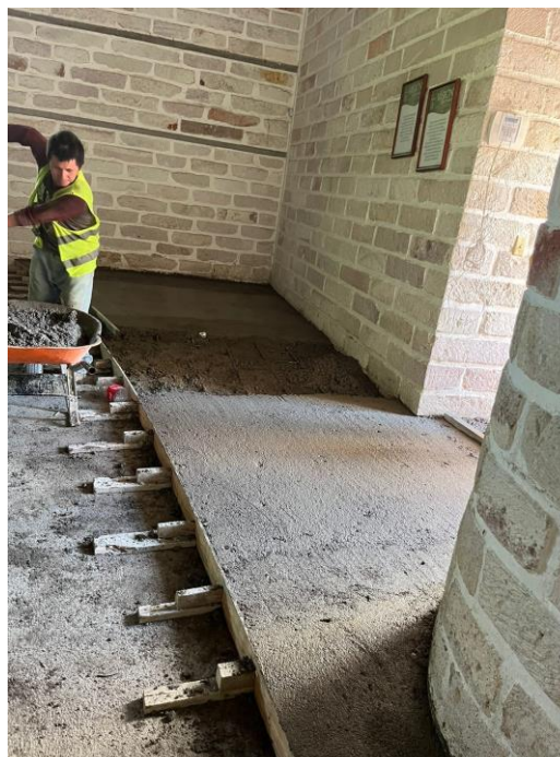
Ilustración 136. Finalización del firme de la décimo sexta gradería
