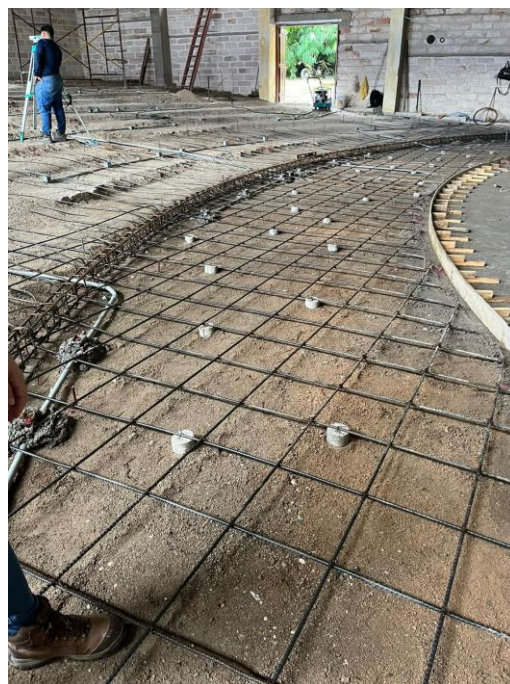
Ilustración 114. Armado de hierro para la cuarta gradería
