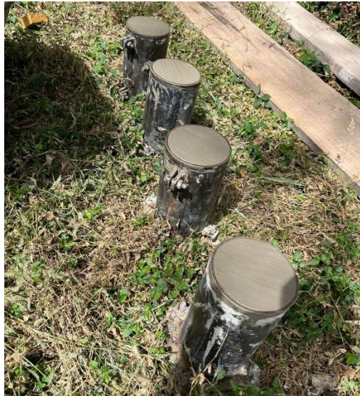
Ilustración 113. Prueba de cilindros de concreto
