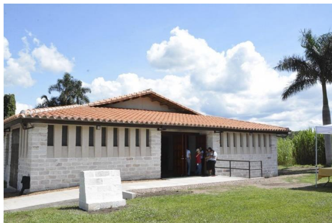
Ilustración 31. Edificio tecnologías eco amigables
