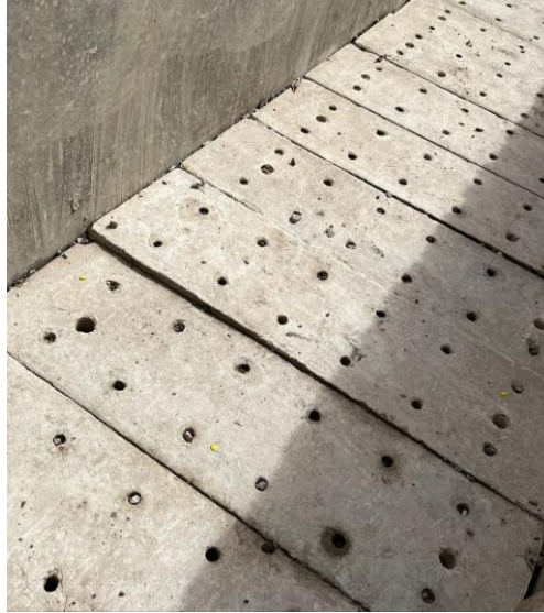
Ilustración 36. Tapaderas falso fondo sistema FAFA
