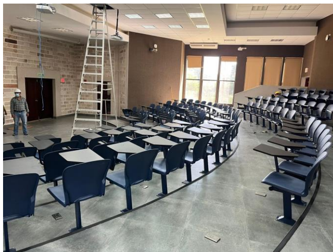
Ilustración 70. Finalización de colocación de sillas
