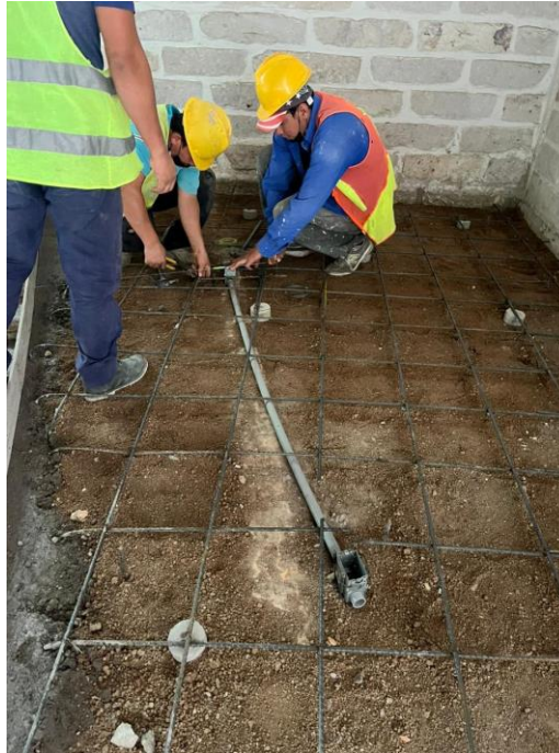
Ilustración 135. Armado de hierro para la décimo sexta gradería
