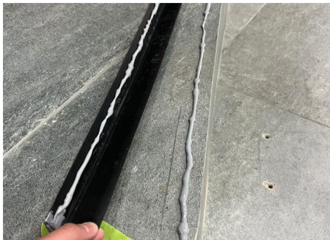
Ilustración 63. Colocación de pegamento a nariz de hule
