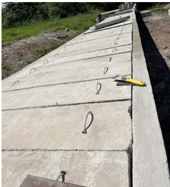
Ilustración 68. Colocación final de tapaderas superiores sistema FAFA
