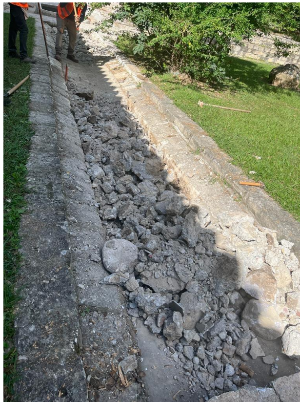
Ilustración 146. Demolición de canal e=10cm
