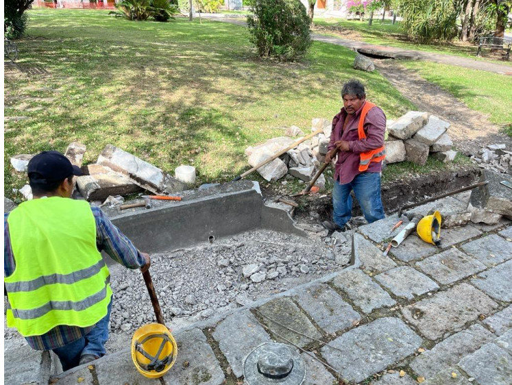
Ilustración 145. Demolición de losas e=10cm
