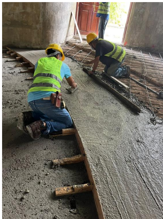
Ilustración 107. Finalización del firme de la segunda gradería
