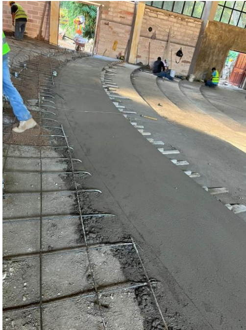
Ilustración 124. Finalización del firme de la novena gradería
