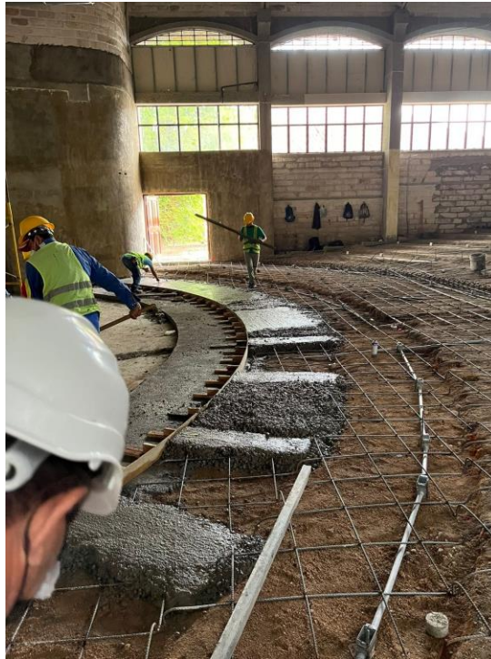
Ilustración 106. Fundición de la segunda hilera de gradería
