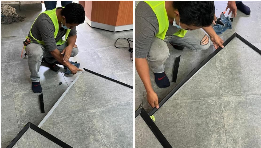
Ilustración 72. Colocación de nariz de hule con adhesivo híbrido MS50 en gradería
