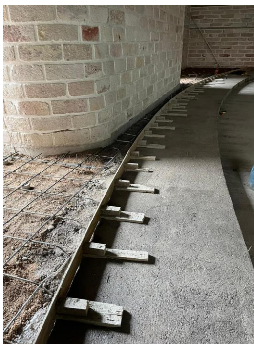
Ilustración 134. Finalización del firme de la décimo quinta gradería
