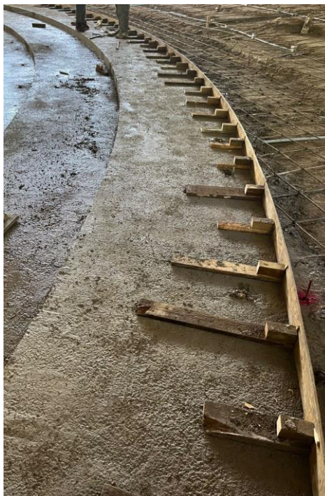
Ilustración 119. Finalización del firme de la séptima gradería
