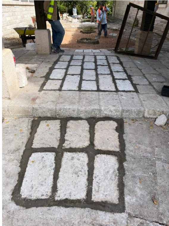
Ilustración 160. Finalización de acera con piedra
