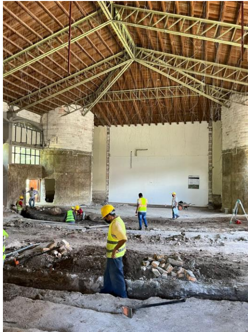
Ilustración 93. Demolición de firme de concreto
