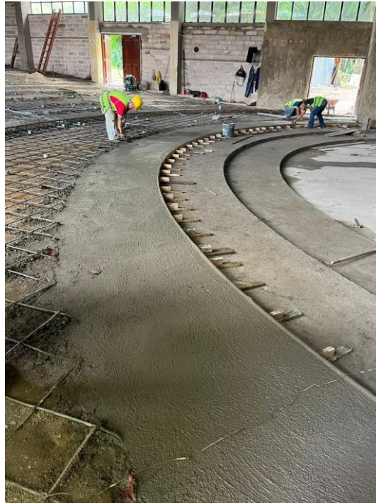
Ilustración 110. Finalización del firme de la tercera gradería
