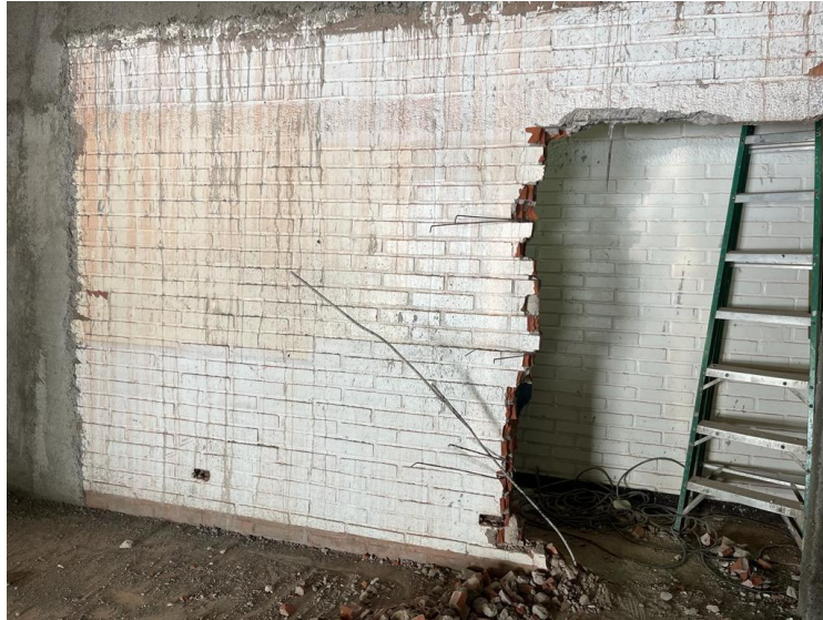
Ilustración 151. Demolición de pared de ladrillo
