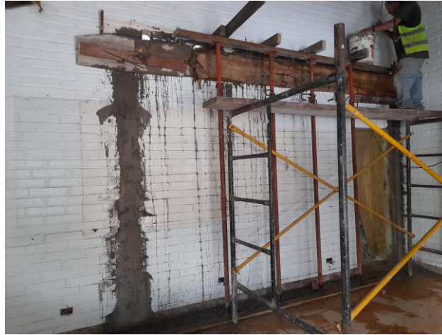
Ilustración 143. Solera superior de concreto armado
