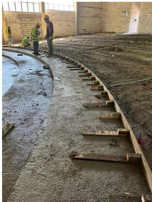
Ilustración 117. Finalización del firme de la sexta gradería
