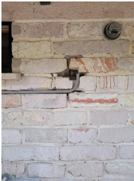
Ilustración 144. Colocación de tubo PVC SCH 40
