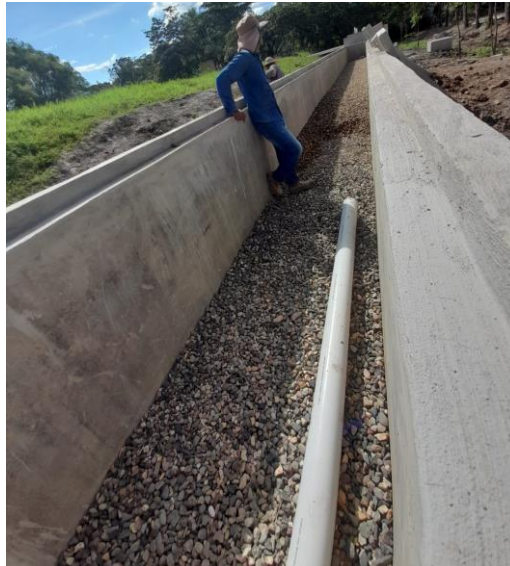
Ilustración 54. Colocación de material filtrante grava \frac{3}{4} " \phi .
