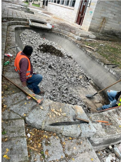
Ilustración 154. Demolición de bordillos de concreto
