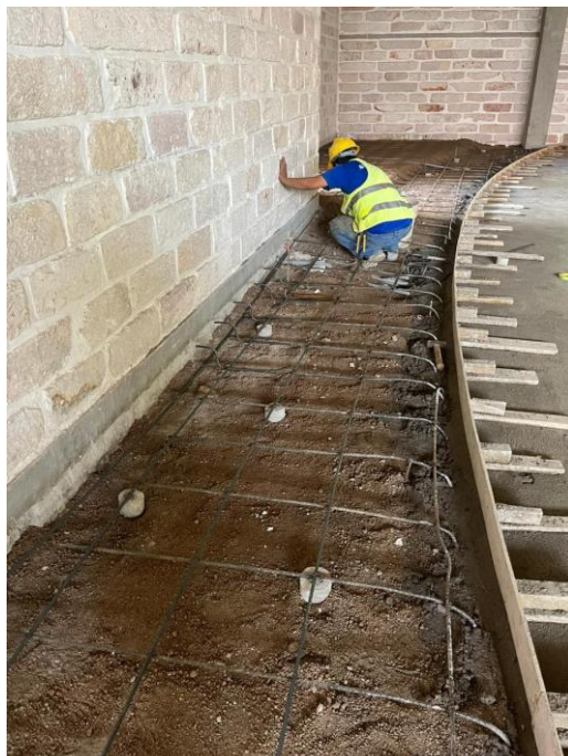
Ilustración 133. Armado de hierro para la décimo quinta gradería
