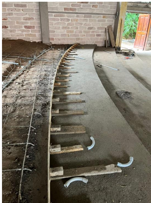
Ilustración 130. Finalización del firme de la décimo tercera gradería
