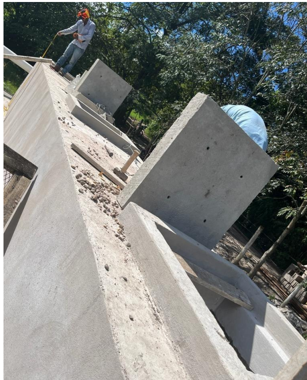
Ilustración 46. Rompiendo solera de concreto superior
