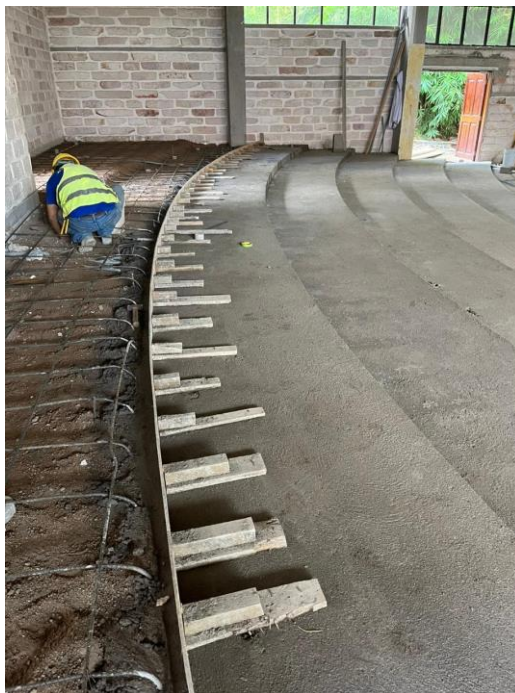
Ilustración 132. Finalización del firme de la décimo cuarta gradería
