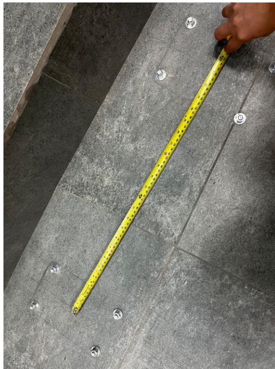
Ilustración 59. Supervisión de colocación pernos para sillas en el auditorio A2
