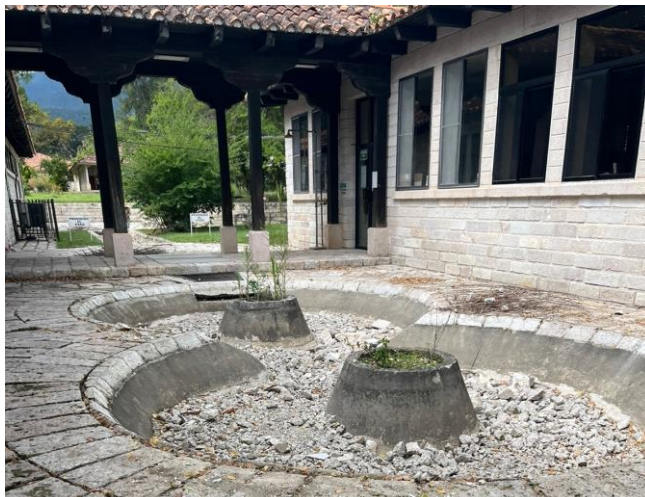
Ilustración 156. Demolición de jardineras centrales
