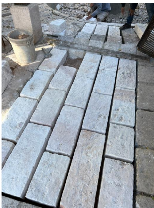
Ilustración 159. Colocación de piedra para finalización de acera
