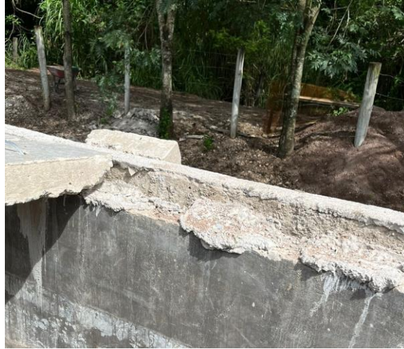
Ilustración 45. Dado fino bordes superiores
