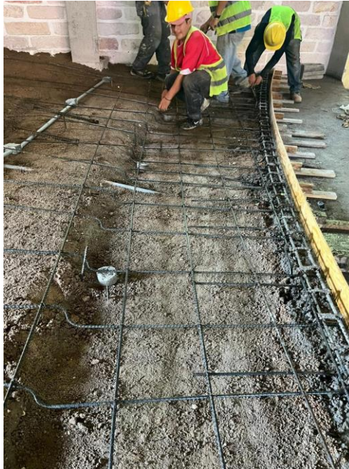
Ilustración 129. Armado de hierro para la décimo tercera gradería
