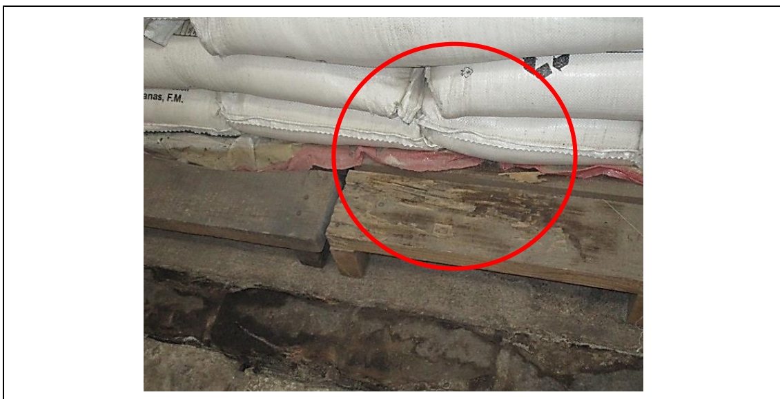
Ilustración 2. Pallets o ramplas en mal estado.
