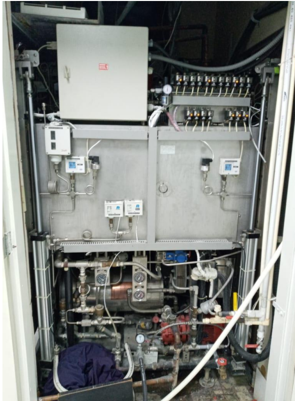
Ilustración 47. sistema electrico y neumático de Autoclave tuttnauer
