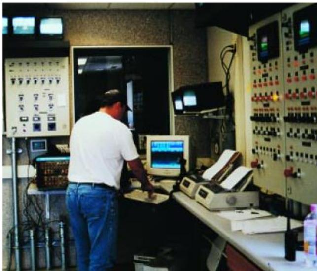
**Ilustración 28. Sala de control de los equipos de dosificación en una planta típica de concreto premezclado**
