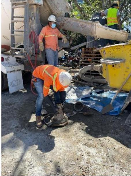
**Ilustración 46. Ensayos en el concreto premezclado**
