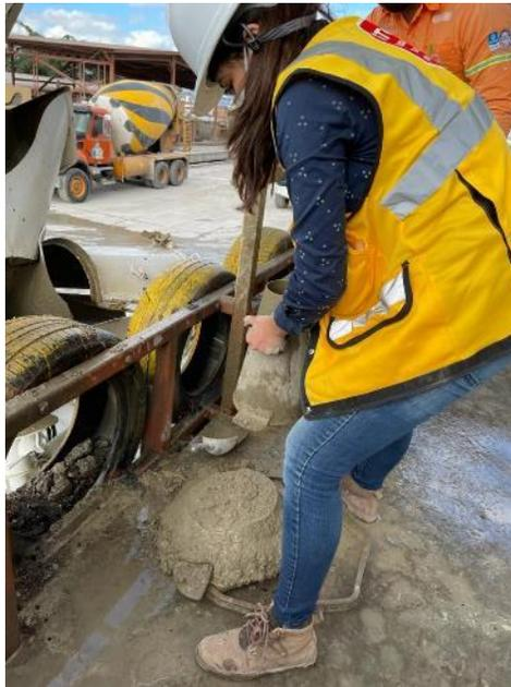
**Ilustración 39. Determinación del revenimiento del concreto premezclado**
