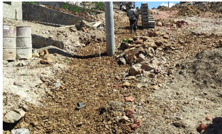
Ilustración 55 -Relleno de sistema de agua potable calle-07, 11 de febrero.
