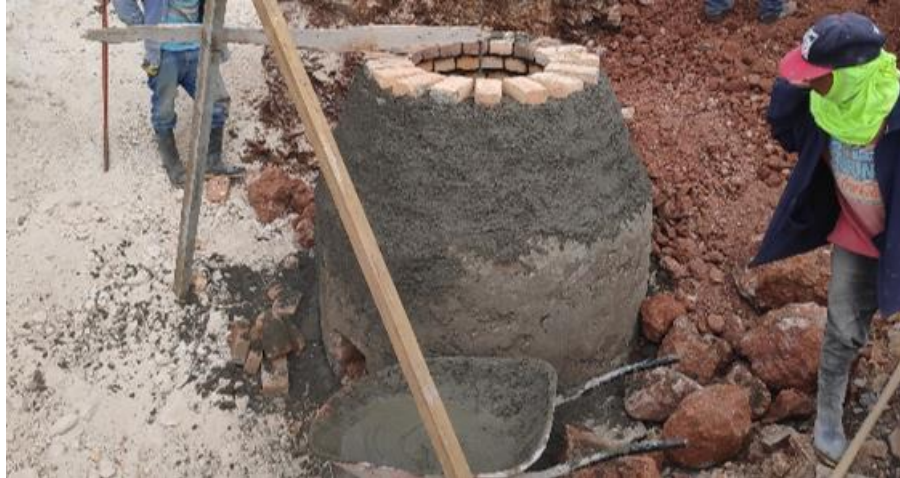
Ilustración 48- Construcción de pozo de inspección, 13 de febrero.
