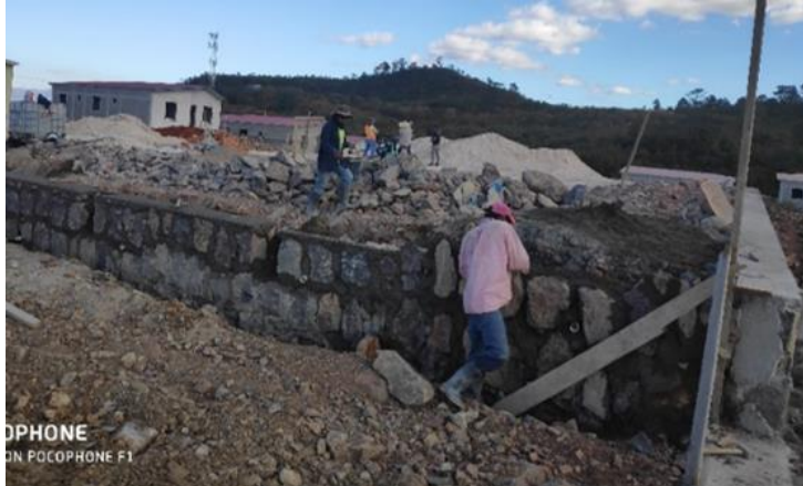
Ilustración 31-Construcción de “grada” en el muro lateral 06, 05 de febrero.
