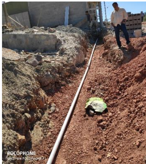
Ilustración 47-Instalación de tubería de agua potable calle-07, 13 de febrero.
