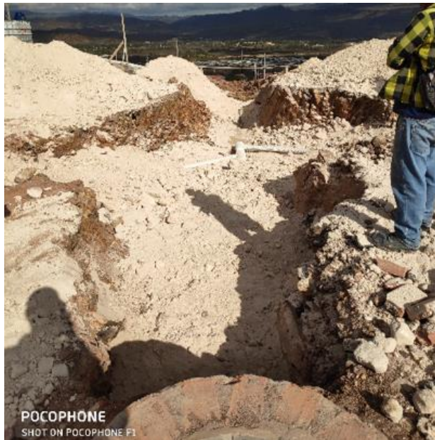
Ilustración 29-Relleno del sistema de tuberías de aguas negras, 04 de febrero.
