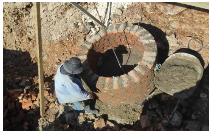
Ilustración 46-Construcción de pozo de inspeccion,12 de febrero.
