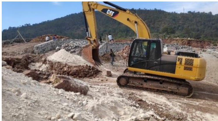
Ilustración 40-Excavación para el sistema de aguas negras, 07 de febrero.
