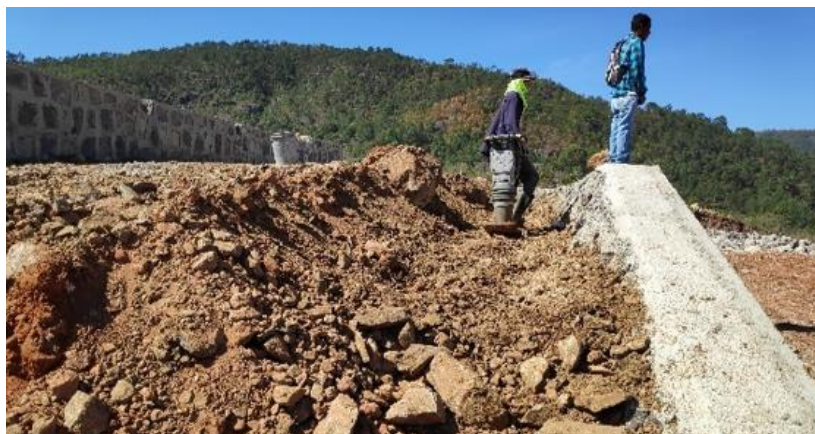
Ilustración 57-Relleno de los muros laterales del bloque F,18 de febrero.
