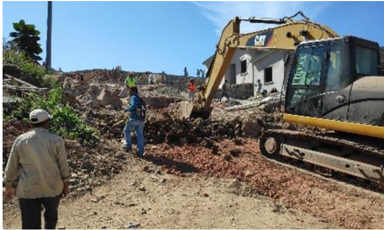
Ilustración 56-Excavación del sistema de aguas negras de la calle 08,18 de febrero.
