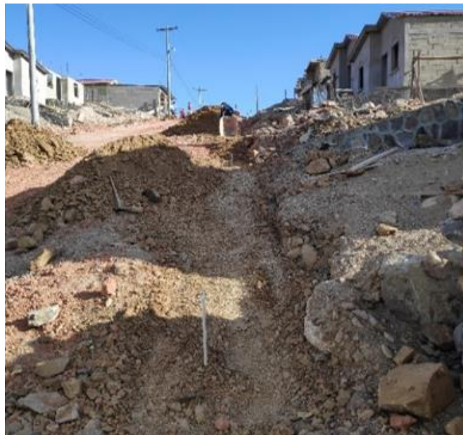
Ilustración 51-Relleno del sistema de agua potable de la calle 07, 14 de febrero.
