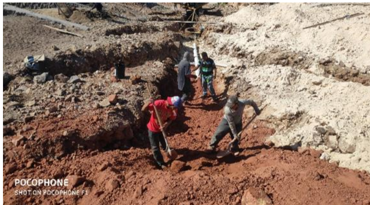
Ilustración 45-Instalación y relleno del sistema de aguas negras,12 de febrero.
