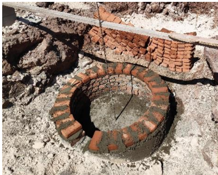
Ilustración 30- Construcción del pozo de inspección, 04 de febrero.
