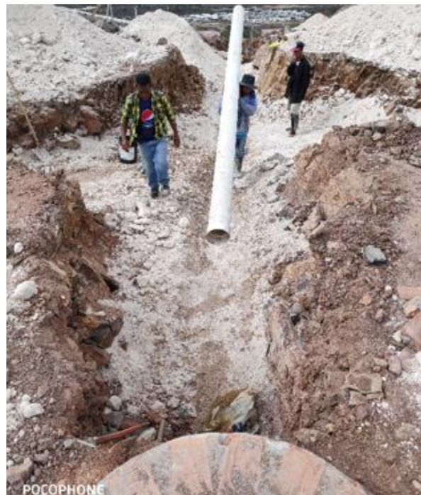
Ilustración 26-Instalación de la tubería de aguas negras, 03 de febrero.
