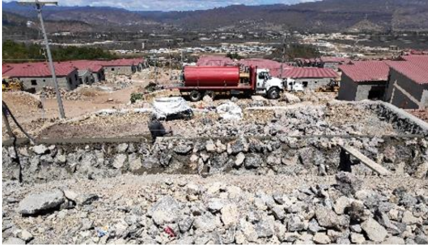
Ilustración 88-Construcción del muro lateral, 12 de marzo
