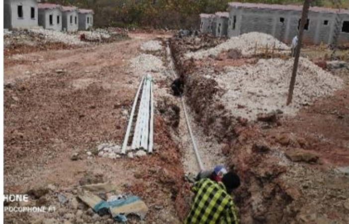
Ilustración 82-Instalación de la tubería del sistema de agua potable, 09 de marzo.
