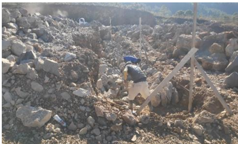
Ilustración 79-Construcción de la cimentación de los muros de mampostería laterales.
