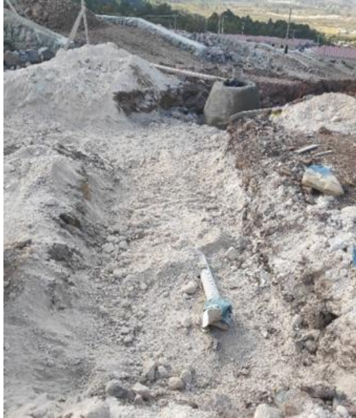
Ilustración 37-Relleno de la tubería del sistema de aguas negras, 06 de febrero.
