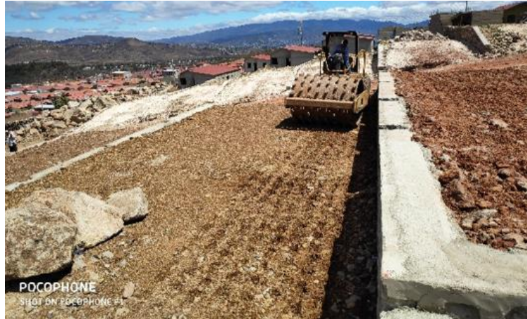
Ilustración 73-Etapa final de la construcción de lotes, 02 de marzo.
