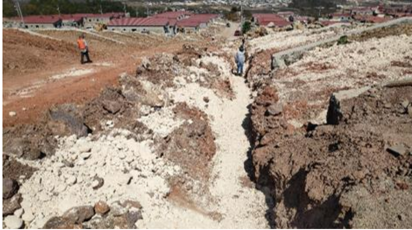
Ilustración 67-Preparación del terreno para la colocación de la tubería del sistema de agua potable, 26 de febrero.
