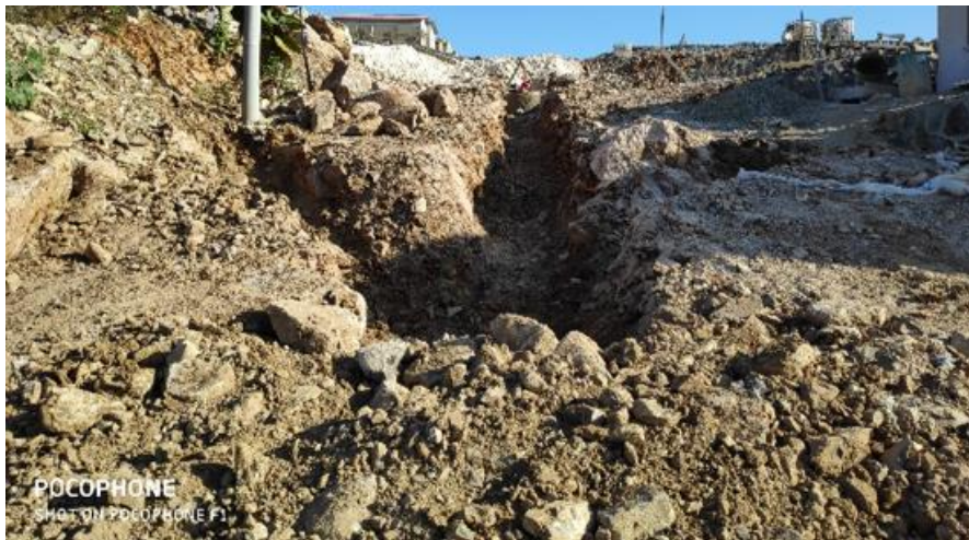
Ilustración 49- Excavación del sistema de aguas negra, 13 de febrero.
