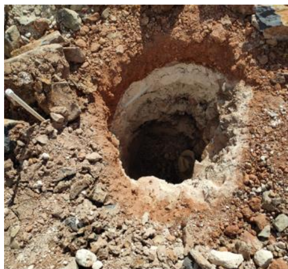
Ilustración 85-Excavación de los banderines para alumbrado público de la calle 08.
