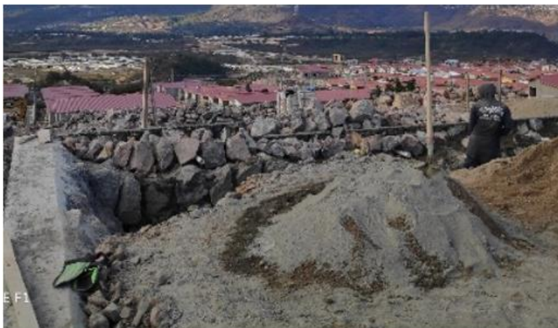
Ilustración 18-Muros laterales de mampostería, 23 de enero.
