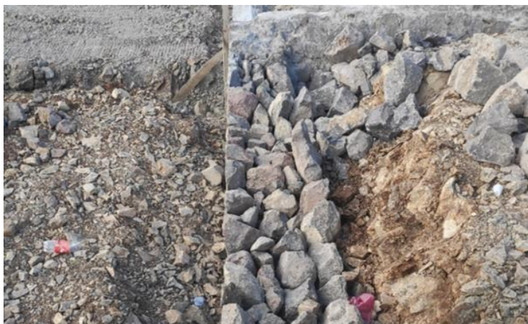
Ilustración 25-Construcción muro de mampostería posterior del lote 10, 03 de febrero.
