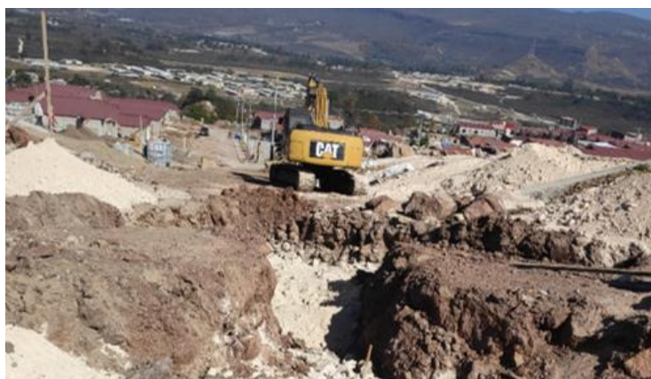
Ilustración 36-Excavación del sistema de aguas negras, 06 de febrero.
