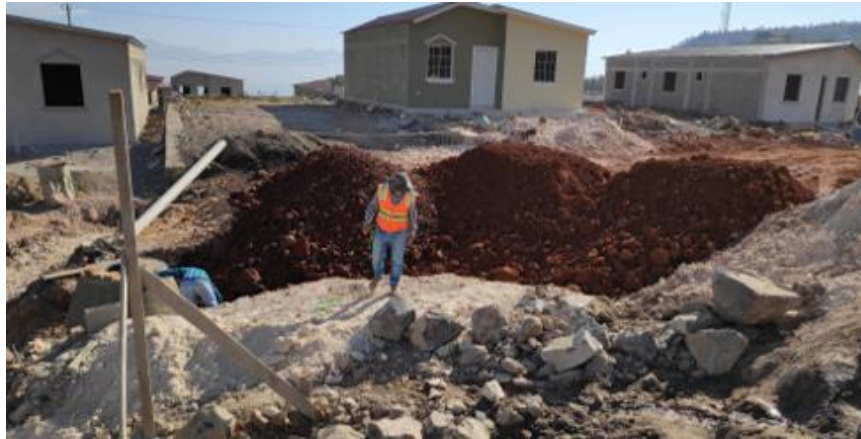
Ilustración 39-Relleno para el sistema de aguas negras, 07 de febrero.
