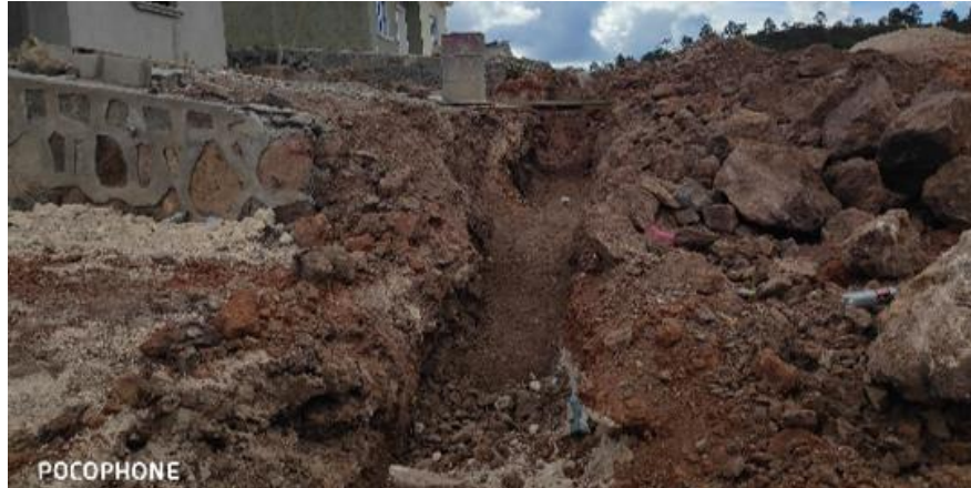
Ilustración 64-Excavación del sistema de agua potable de la calle 08, 25 de febrero.
