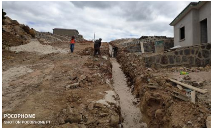
Ilustración 86-Relleno de la tubería del sistema de agua potable de la calle 08, 11 de marzo.
