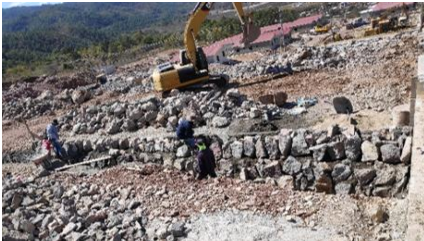
Ilustración 66- Construcción del muro lateral de mampostería 42, 26 de febrero.
