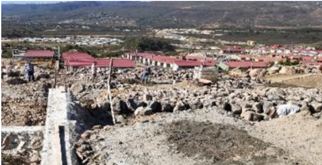
Ilustración 15-Muros laterales de mampostería, 20 de enero.
