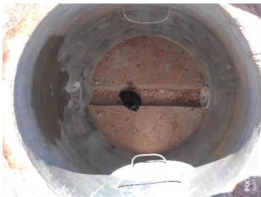
Ilustración 35-Media caña del pozo de inspección, 06 de febrero.
