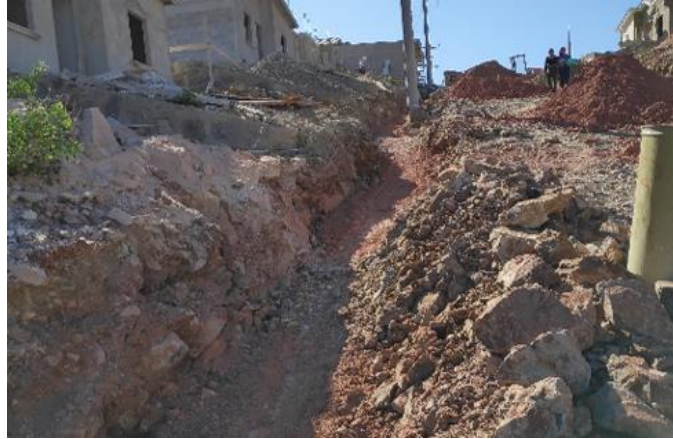
Ilustración 21-Excavación sistema de agua potable, 28 de enero.
