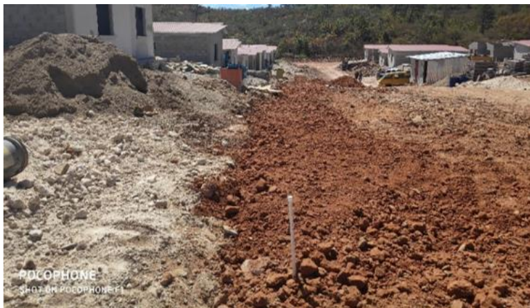
Ilustración 75-Relleno del sistema de agua potable de la calle 08, 03 de marzo.
