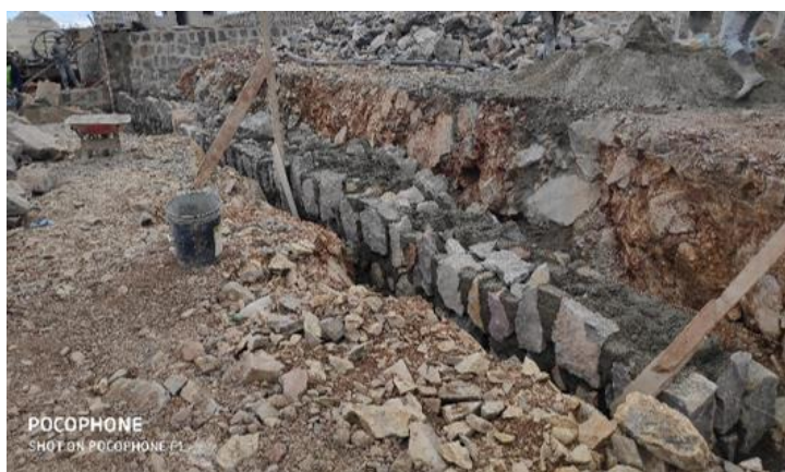
Ilustración 63-Construcción de muro de mampostería lateral, 25 de febrero.
