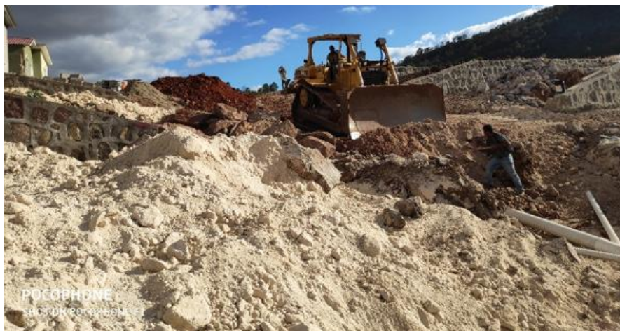
Ilustración 44- Relleno del sistema de aguas negras, 11 de febrero.
