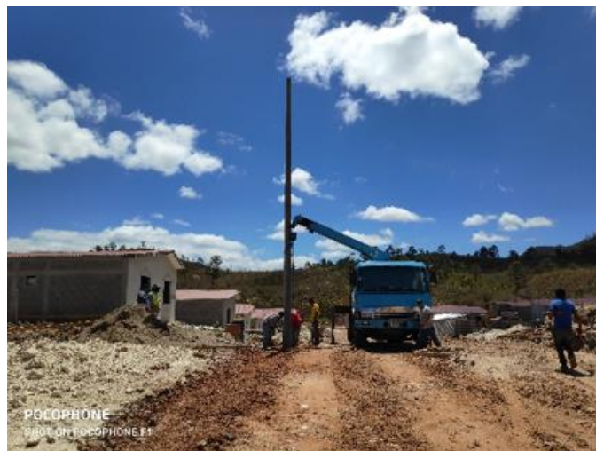
Ilustración 87-Instalación de los banderines de alumbrado público, 11 de marzo.
