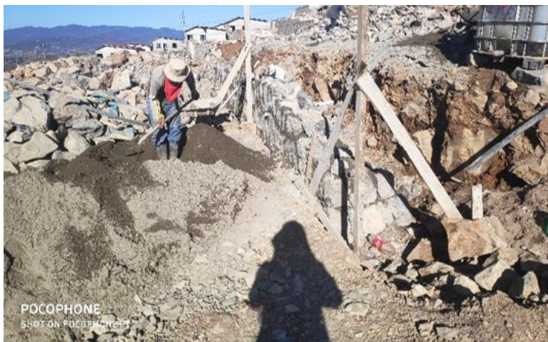
Ilustración 76-Construcción de los muros laterales del bloque F, 04 de marzo.
