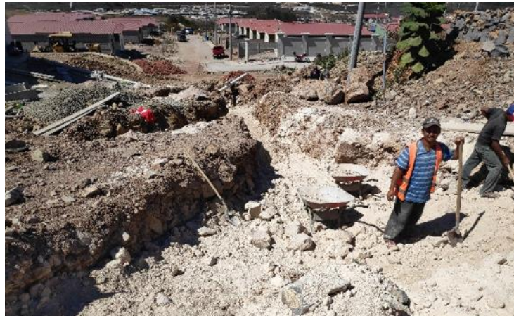
Ilustración 54-Relleno del sistema de aguas negras,18 de febrero.
