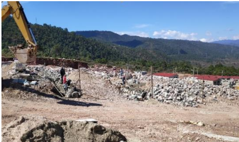
Ilustración 16-Muros laterales de mampostería, 21 de enero.
