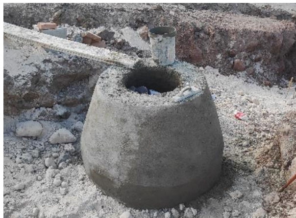
Ilustración 32-Construcción del pozo de inspección, 05 de febrero.
