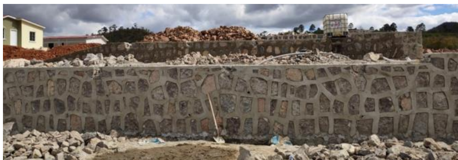
Ilustración 41-Detalle de la "liga" en los muros laterales,10 de febrero.
