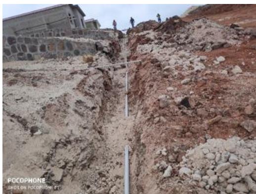
Ilustración 69-Colocación de la tubería del sistema de agua potable en la calle 08, 27 de febrero.
