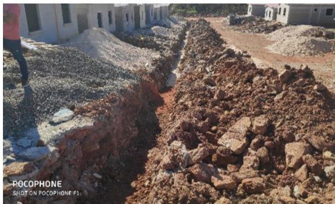
Ilustración 62-Excavación del sistema de agua potable de la calle 08, 24 de febrero.
