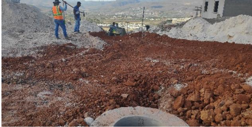
Ilustración 33-Relleno para el sistema de aguas negras, 05 de febrero.
