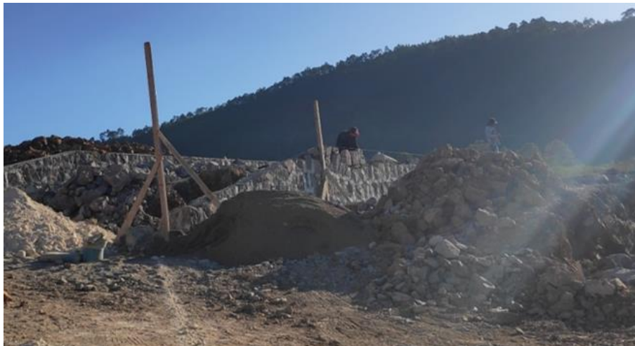
Ilustración 34-Construcción muro lateral, 06 de febrero.
