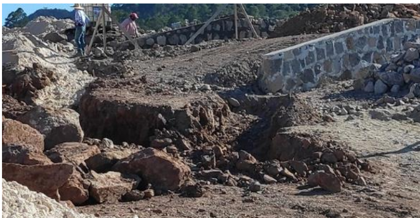
Ilustración 23-Excavación sistema de aguas negras, 30 de enero.
