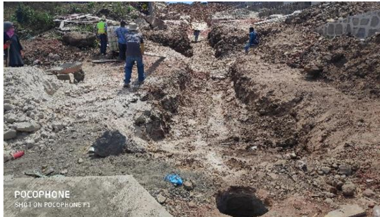
Ilustración 58-Relleno del sistema de aguas negras, 20 de febrero.
