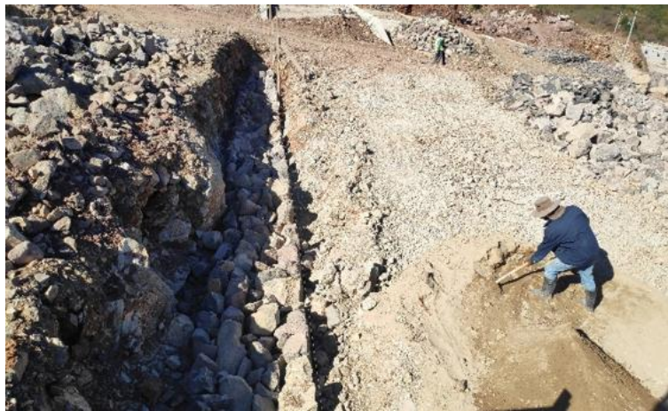
Ilustración 61-Construcción del muro lateral 42, 24 de febrero.
