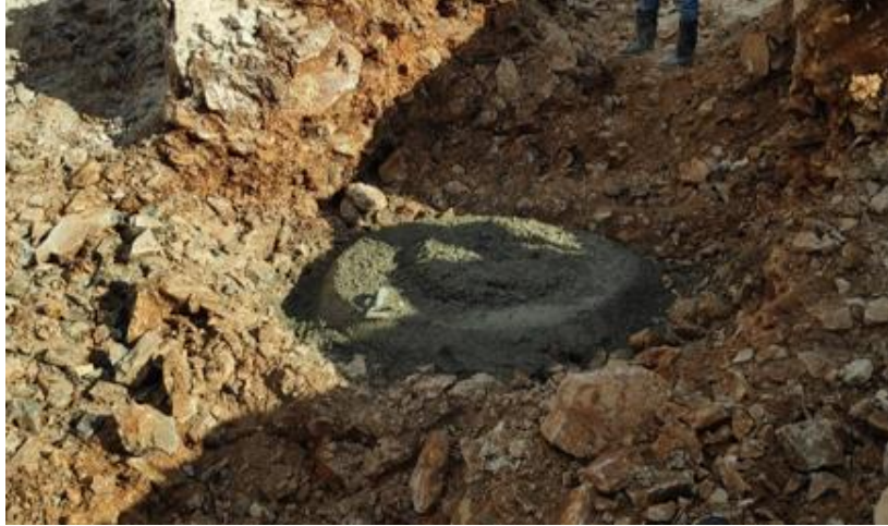
Ilustración 43- Construcción de la cimentación para el pozo de inspección, 11 de febrero.
