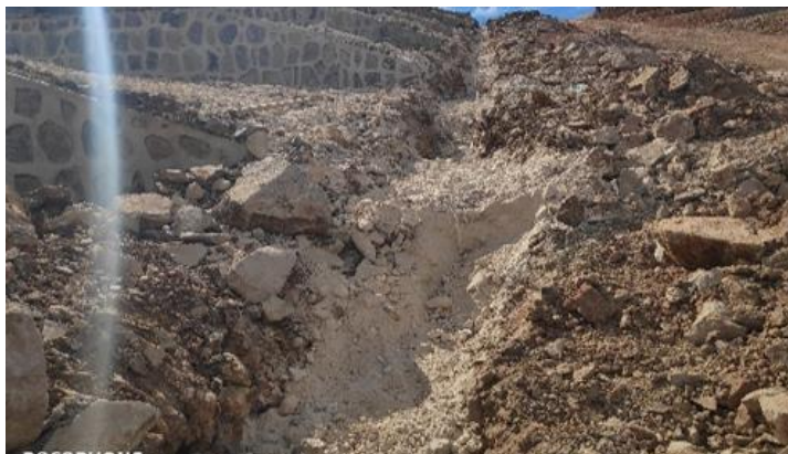
Ilustración 70-Relleno de la tubería del sistema de agua potable, 28 de febrero.
