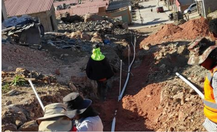
Ilustración 50-Prueba hidrostática del sistema de agua potable de la calle 07, 14 de febrero.
