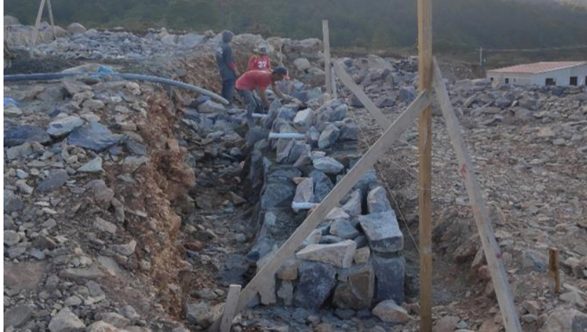
Ilustración 28-Construcción de muro lateral, 04 de febrero.
