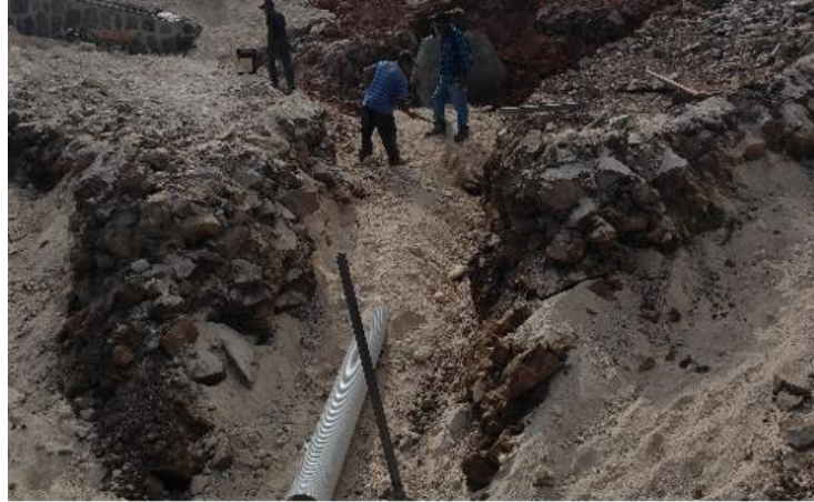
Ilustración 52-Instalación de la tubería de aguas negras de la calle 08,17 de febrero.
