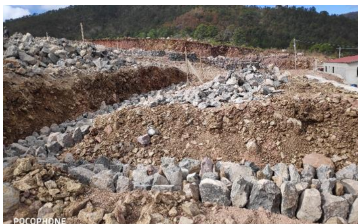
Ilustración 72-Colocación de la primera hilada de piedra en muro posterior y lateral, 02 de marzo.
