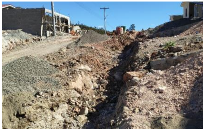
Ilustración 19-Excavación de tubería de agua potable, 24 de enero.
