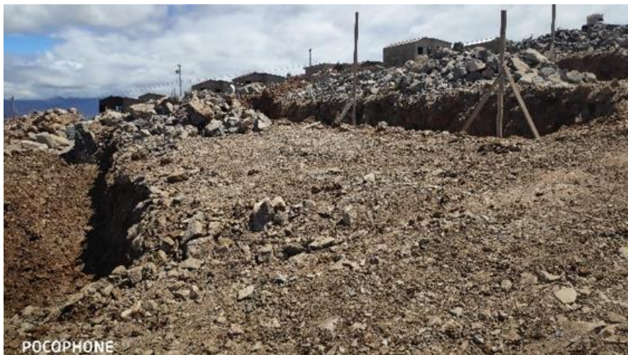
Ilustración 71- Construcción de muros de mampostería laterales y posterior, 28 de febrero.
