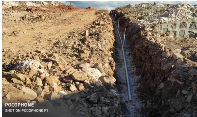
Ilustración 84-Tramo final de la tubería del sistema de agua potable, 10 de marzo.
