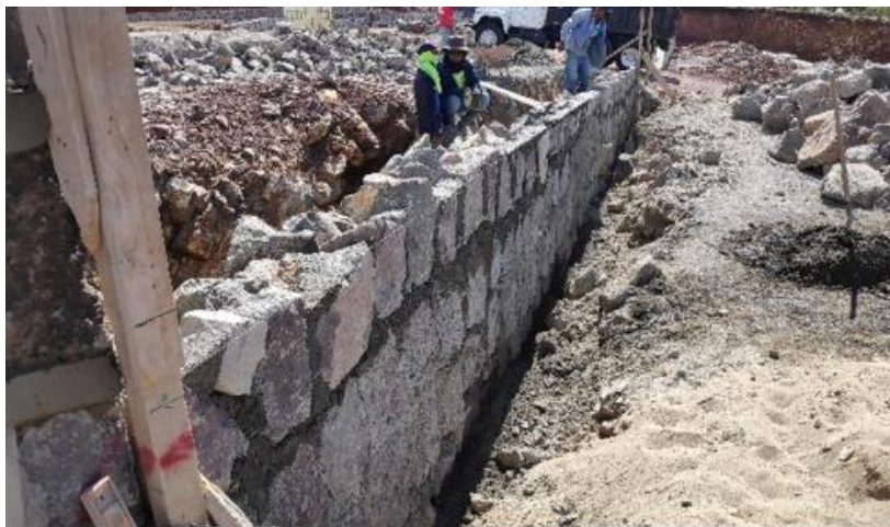
Ilustración 68-Construcción de muro lateral de mampostería, 27 de febrero.
