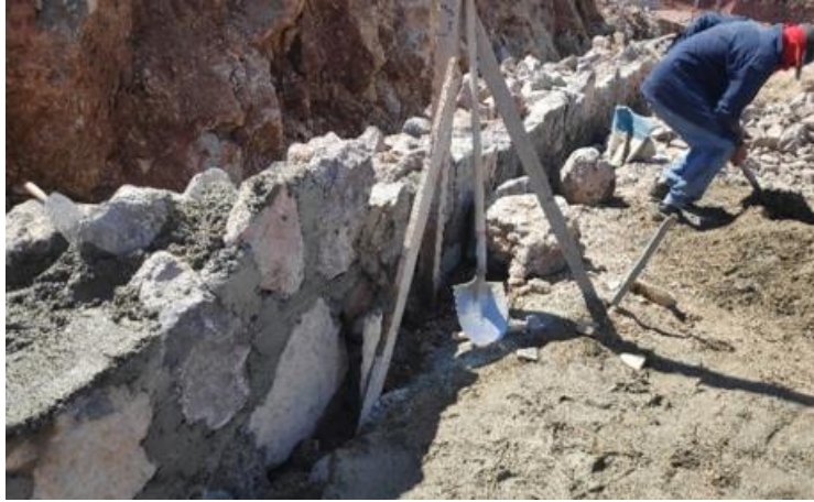
Ilustración 17-Muros laterales de mampostería, 22 de enero.
