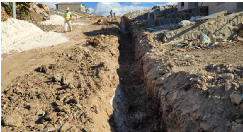
Ilustración 83-Excavación final de la segunda brecha del sistema de agua potable de la calle 08, 10 de marzo.
