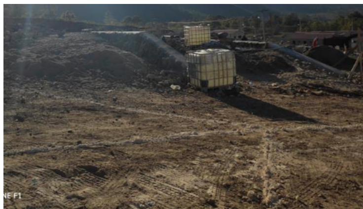
Ilustración 22-Excavación del sistema de aguas residuales, 29 de enero.
