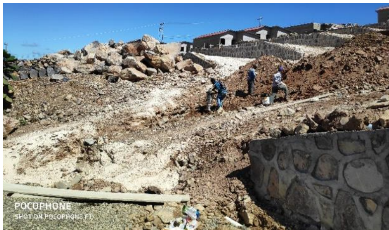
Ilustración 59-Relleno del sistema de aguas negras de la calle 08, 20 de febrero.
