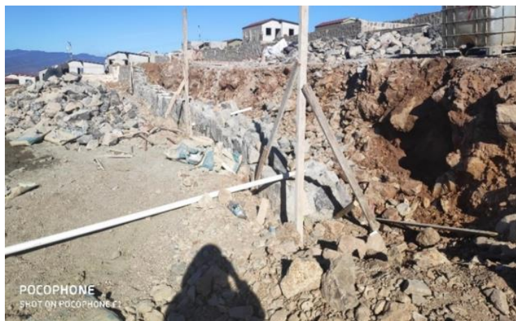
Ilustración 74-Construcción de muros de mampostería, 03 de marzo.
