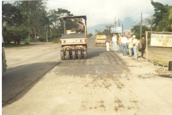
Ilustración 4- Compactación de material
