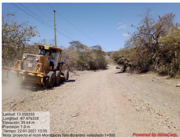
Ilustración 29- Reposición de balasto
