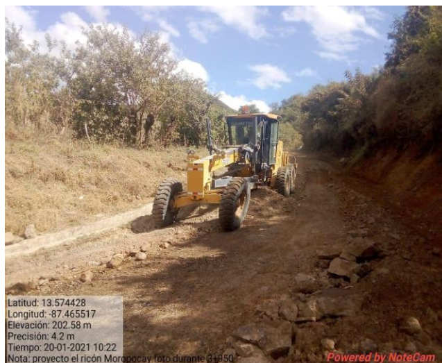
Ilustración 27- Reposición de balasto proyecto
