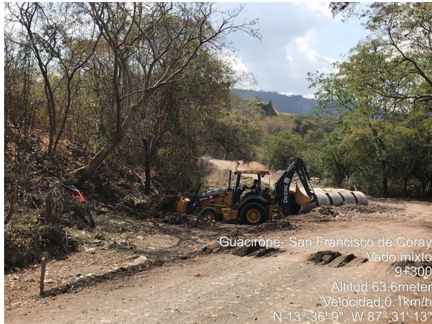
Ilustración 44- Limpieza para construcción de vado mixto
