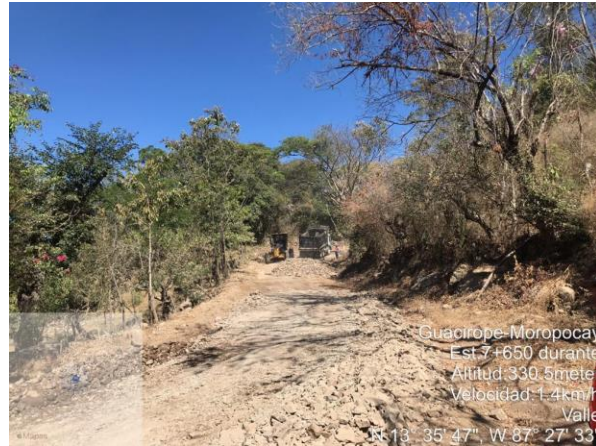
Ilustración 31- Reposición de balasto
