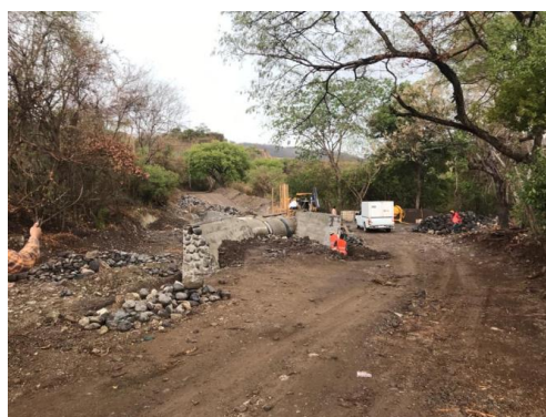
Ilustración 56- Encofrado de aleta de vado mixto
