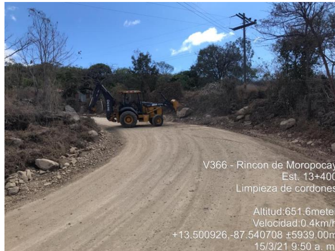
Ilustración 53- Limpieza de cordones
