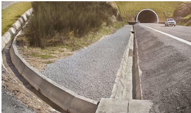
Ilustración 13- Cunetas revestidas
