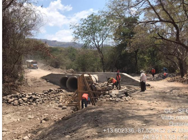
Ilustración 59- Encofrado de aleta vado mixto
