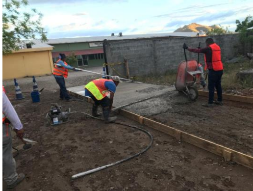
Ilustración 25- Fundido de concreto hidráulico en bulevar Corcovado
