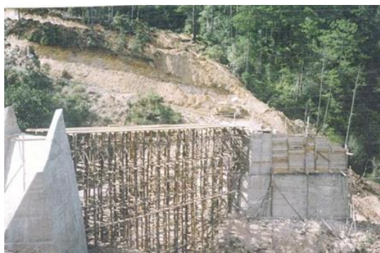
Ilustración 3- Construcción de puente sobre Rio Payacal
