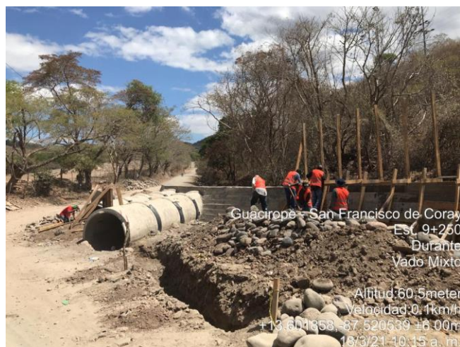
Ilustración 55- Fundición de aleta de vado mixto
