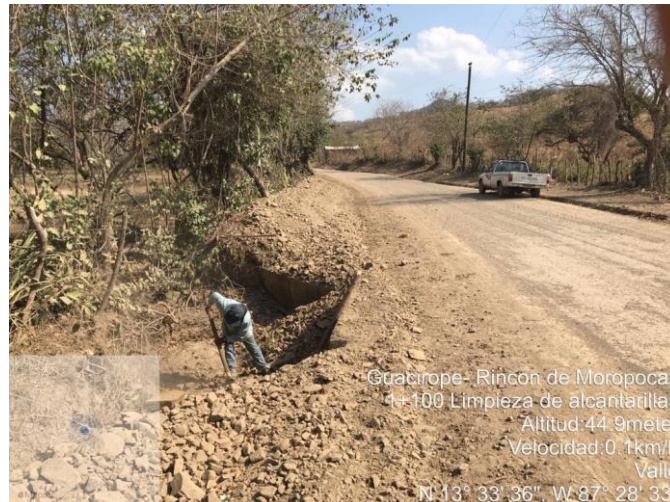
Ilustración 41- Limpieza de alcantarillas
