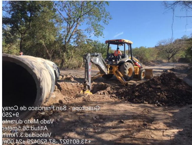
Ilustración 45- Excavación de zanjas
