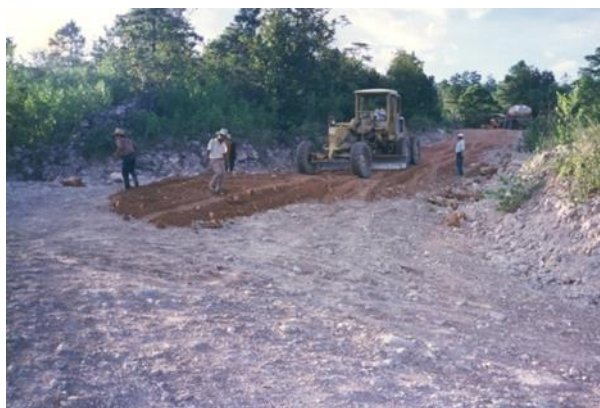
Ilustración 2- Tendido de material
