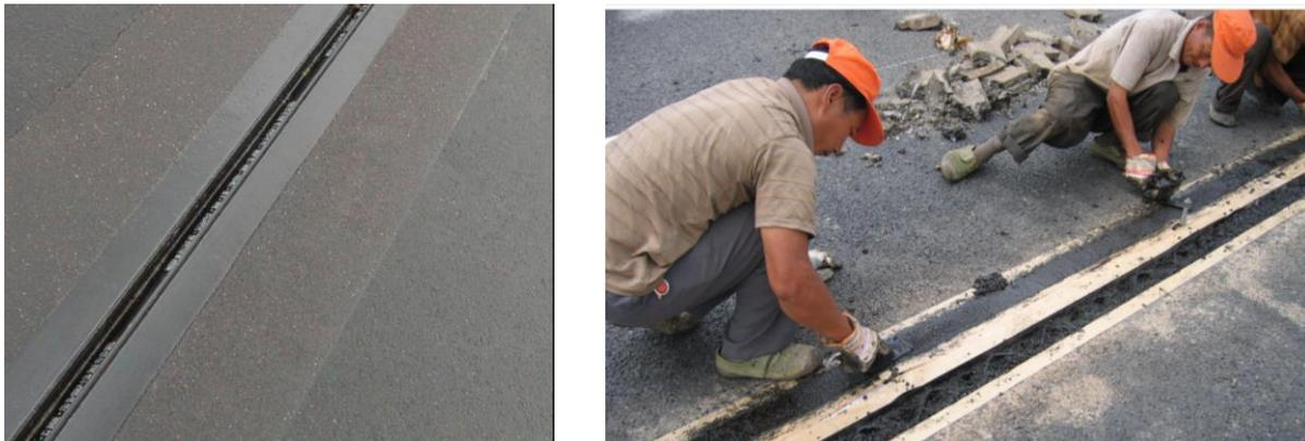
**Ilustración 19 Ejemplos de junta de expansión**
