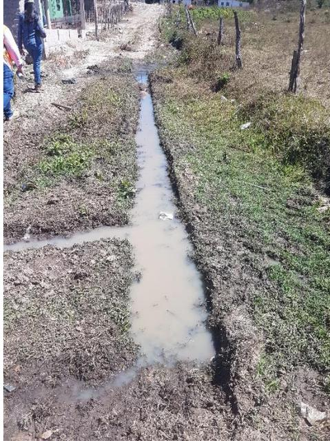
**Ilustración 28 Continuación de zanjas para aguas residuales**
