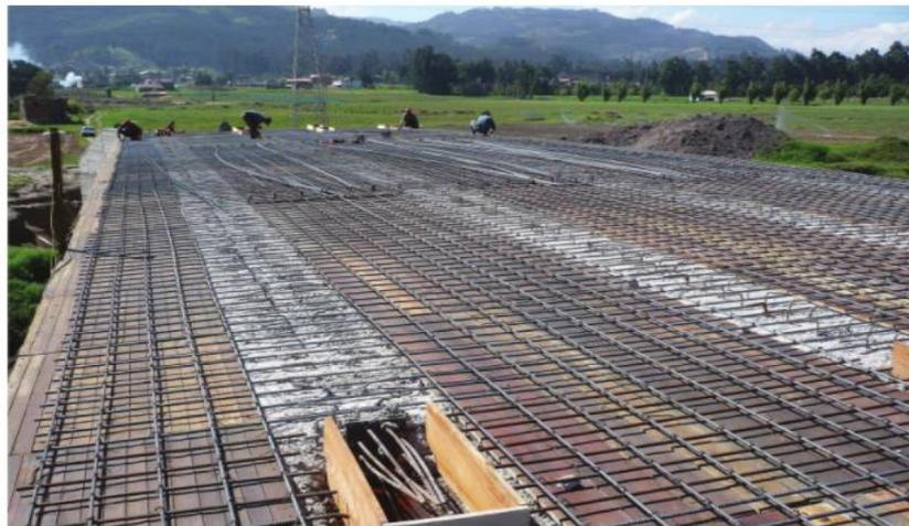
**Ilustración 6. Proceso constructivo (Puente losa y vigas)**
