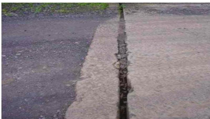
**Ilustración 22. Obstrucción de movimientos en junta de expansión**
