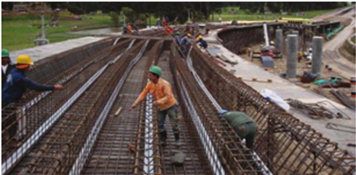
**Ilustración 5. Proceso constructivo (Puente Losa)**
