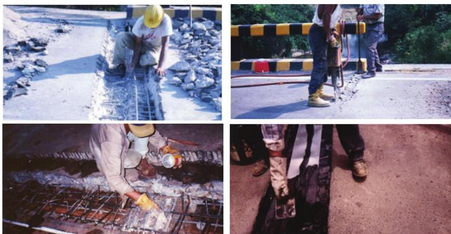
**Ilustración 23. Reparación de juntas varias**
