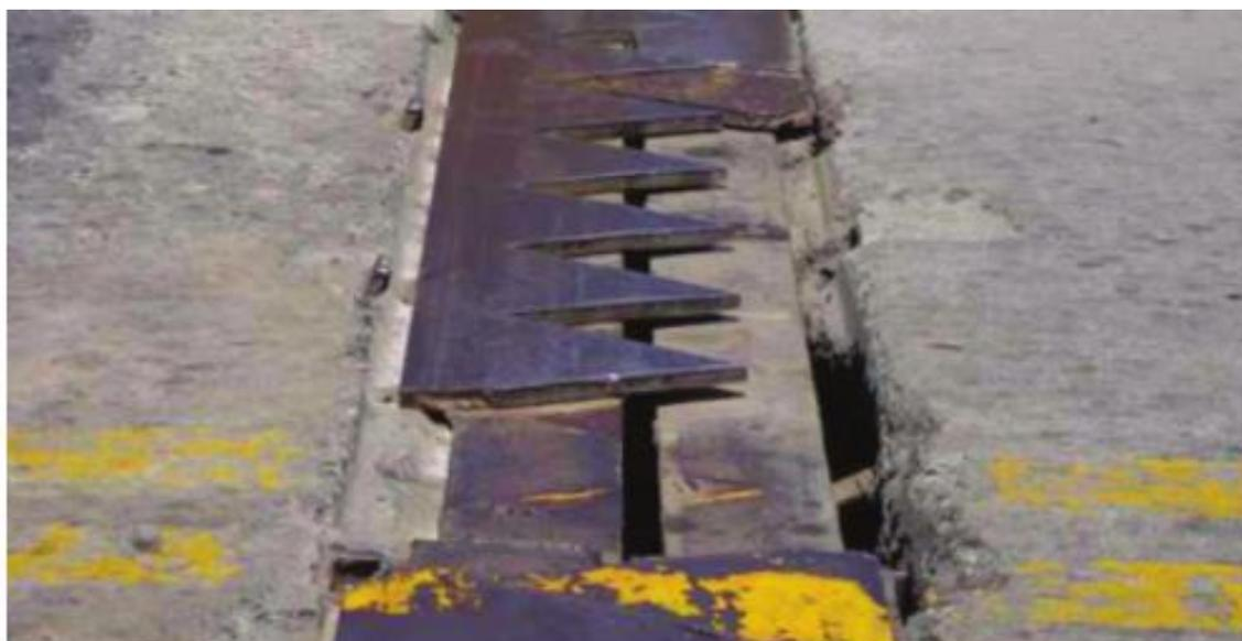
**Ilustración 2. Junta de dilatación con fallas en sus elementos.**
