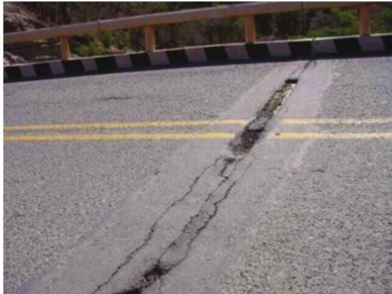
**Ilustración 21. Daño estructural en junta de expansión**
