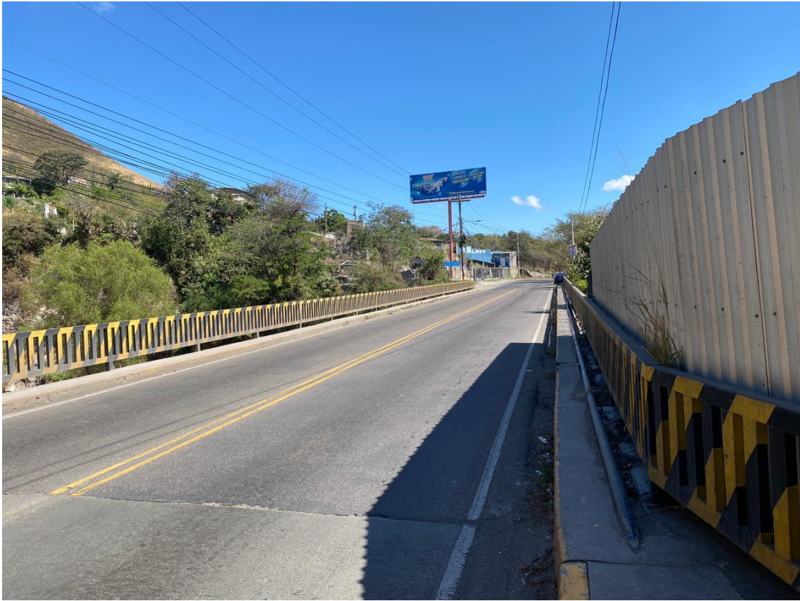
Ilustración 88 Est. 1+670 Ubicado al Finalizar el Puente Germania
