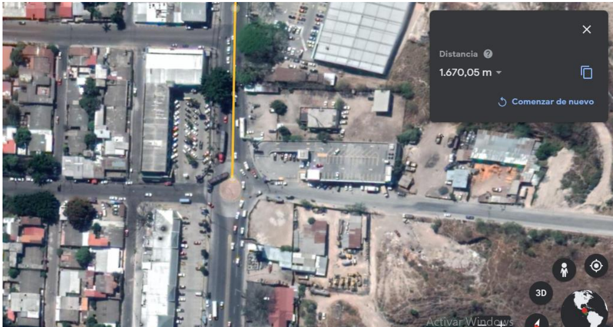
Ilustración 92 Vista Aérea de la Est. 0+000
