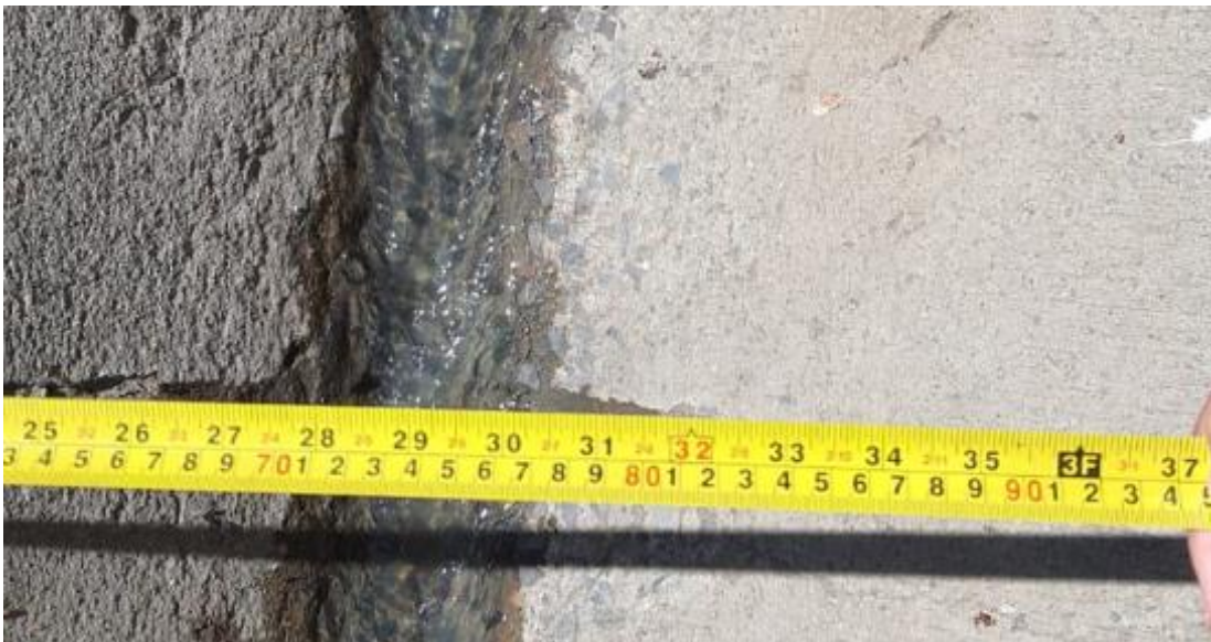
Ilustración 44 Ancho de Cuneta Existente en el Tramo a Diseñar
