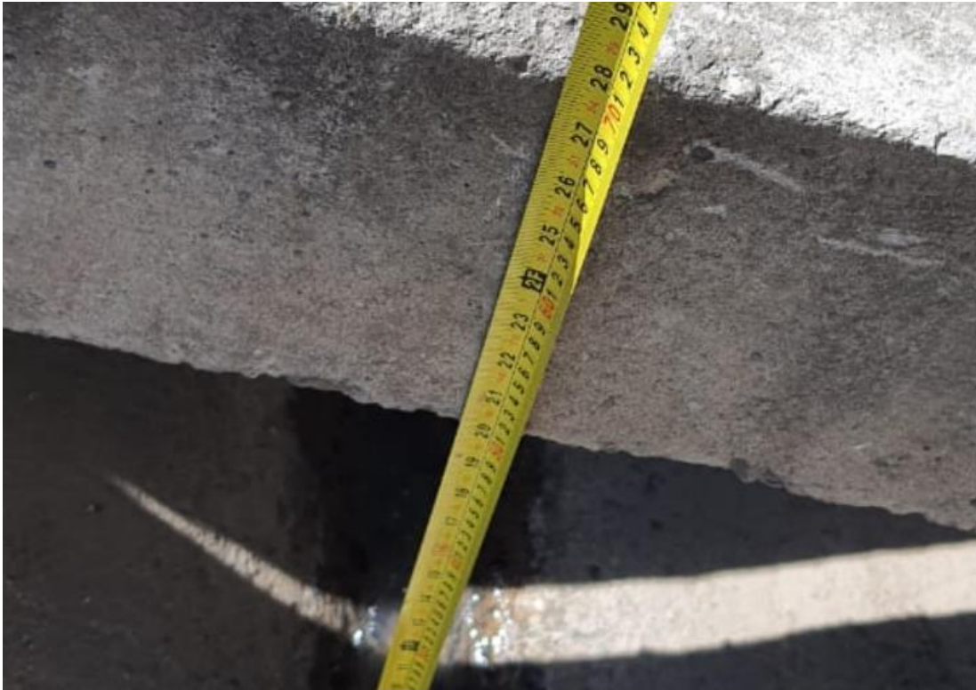
Ilustración 43 Profundidad de Cuneta Existente en el Tramo a Diseñar
