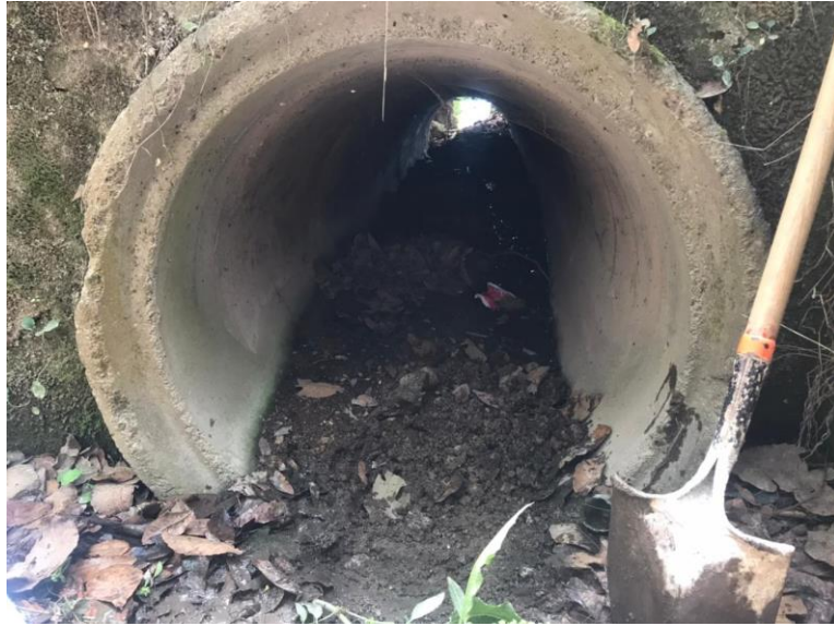
Ilustración 60. Revisión de diámetro de la alcantarilla en la Est. 2+075
