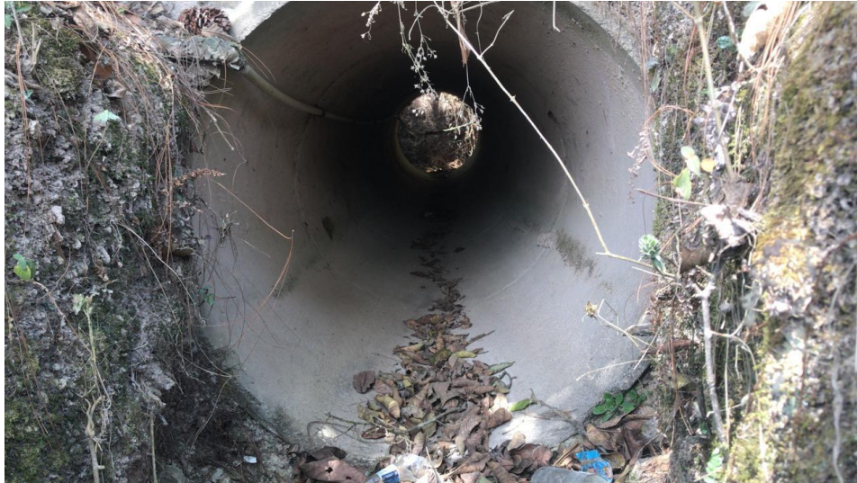
Ilustración 62. Revisión de diámetro de la alcantarilla en la Est. 1+990
