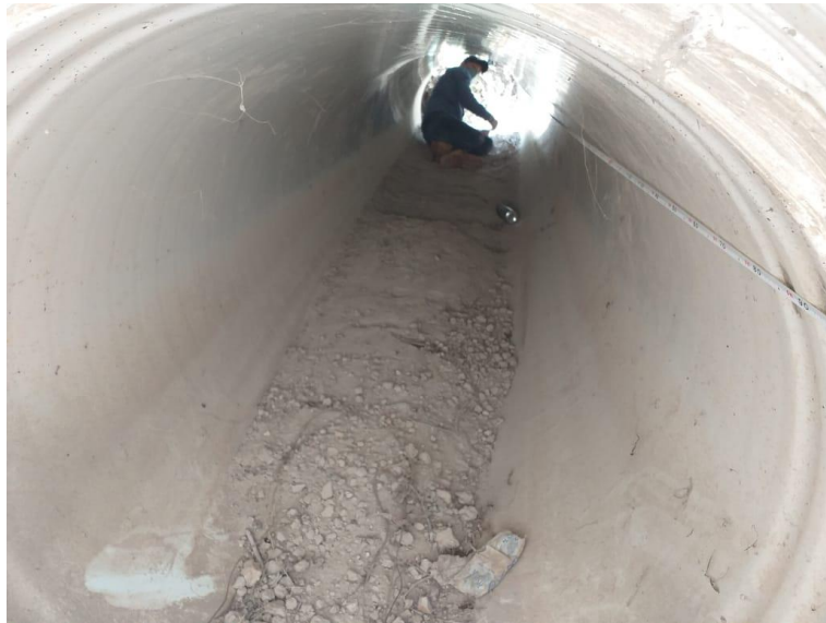
Ilustración 59. Revisión de diámetro de la alcantarilla en la Est. 2+277
