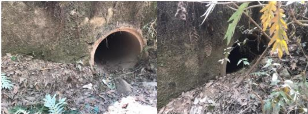
Ilustración 63. Doble alcantarilla Est. 1+990
