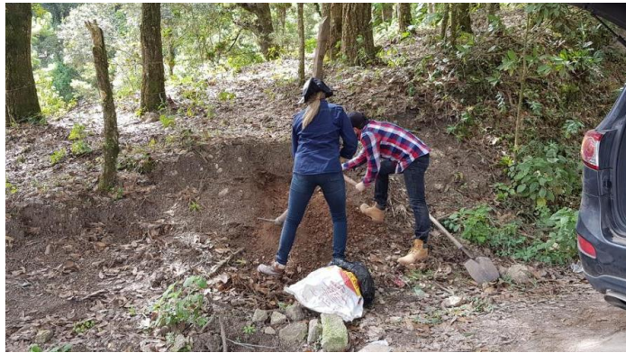
Ilustración 51. Extracción de muestra de suelo Est. 1+670
