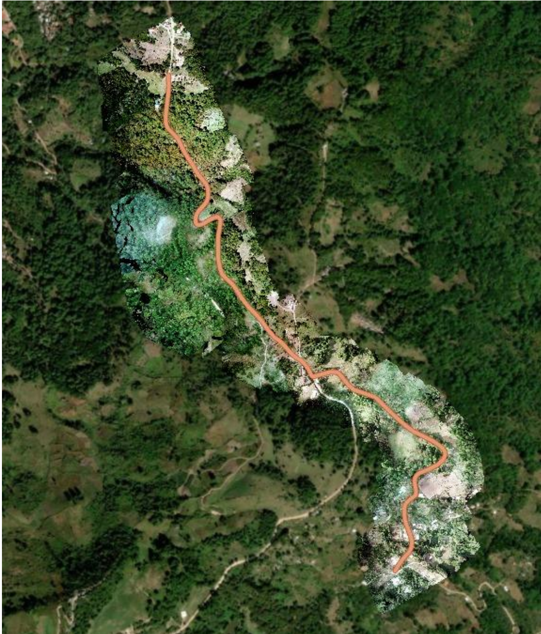
Ilustración 37. Levantamiento Aero-fotogramétrico del tramo carretero
