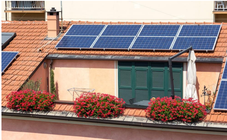
Ilustración IV.4 Sistema fotovoltaico con inyección a red.
