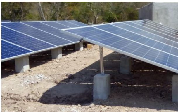
Ilustración IV.7 Paneles instalados en dados. Fuente: (IBS, 2020)
