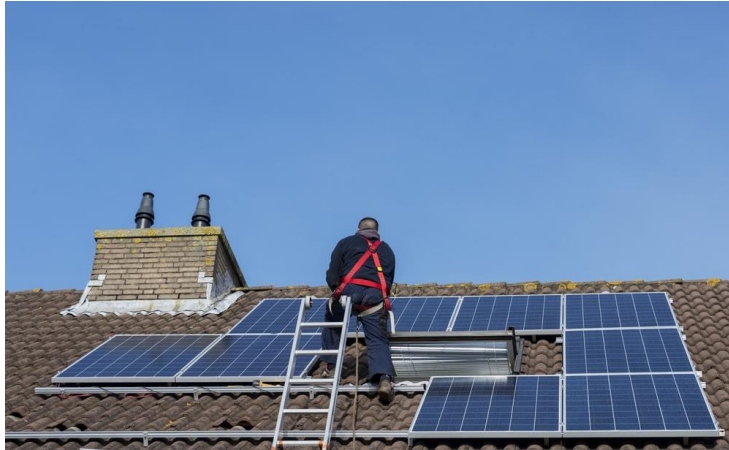
Ilustración IV.11 Instalación de paneles solares para un ISF. Fuente: https://www.quotatis.es
