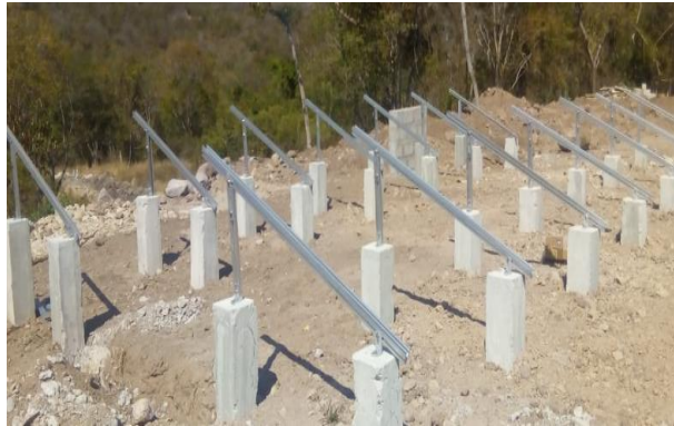
Ilustración IV.6 Dados para soporte de paneles solares. Fuente: (IBS, 2020)
