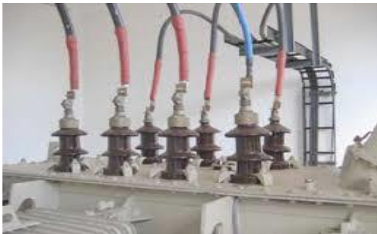
Figura 8.7 Conexión primario/secundario de transformador de potencia
