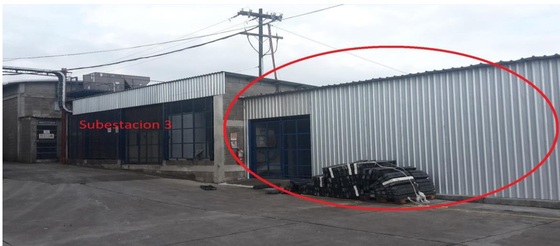
Figura 8.36 Vista panorámica de ubicación de la nueva subestación eléctrica
