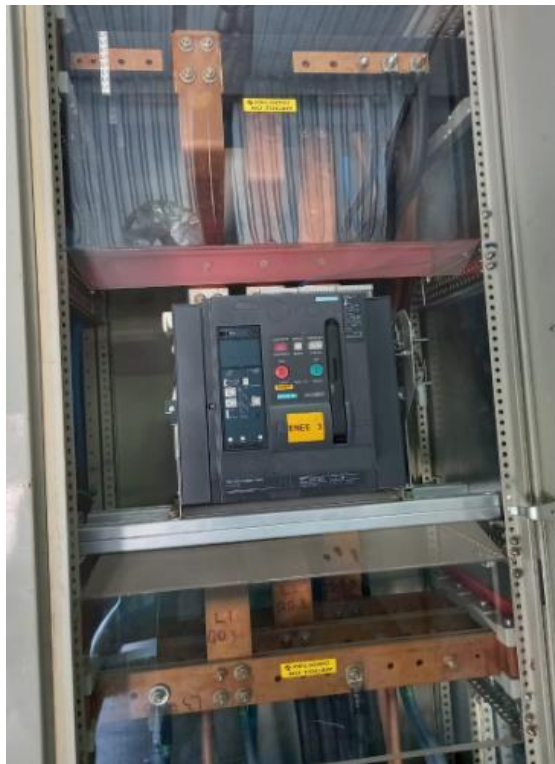
Figura 8.9 Vista lateral de barras de interruptor de transferencia 3WL1216-4BB34-1AA2
