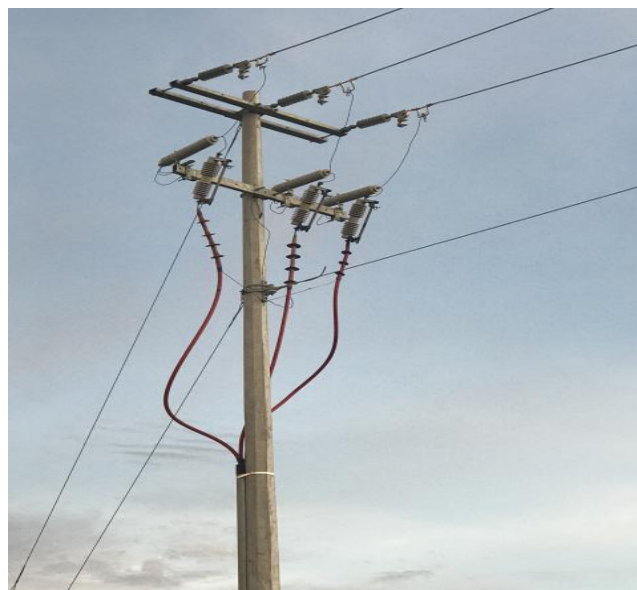
Figura 8.5 Conexión en media tensión
