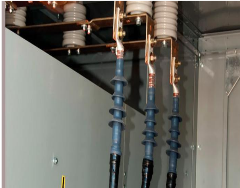
Figura 8.6 Conexión Primario de transformador de potencia
