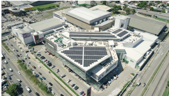
Ilustración 11 - Sistema FV sobre techo Mega Mall San Pedro Sula.
