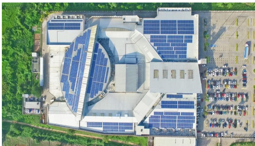
Ilustración 12 - Sistema FV sobre techo Mall Megaplaza El Progreso.
