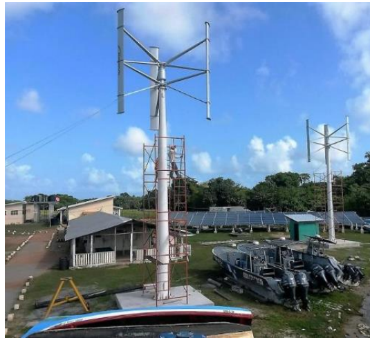
Ilustración 10: Montaje de turbinas del proyecto híbrido solar-eólico
