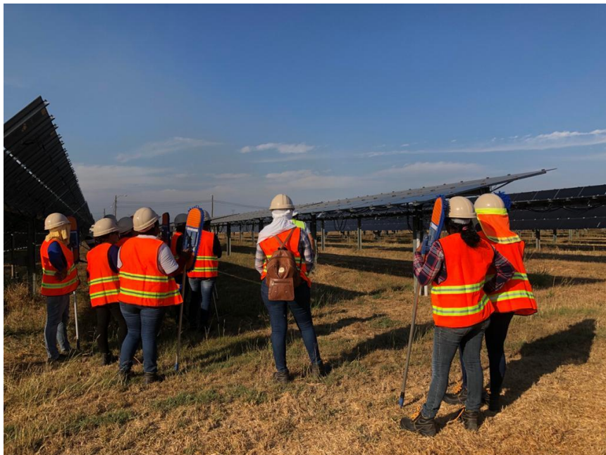
Ilustración 22. Capacitación de limpieza de Módulos FV
