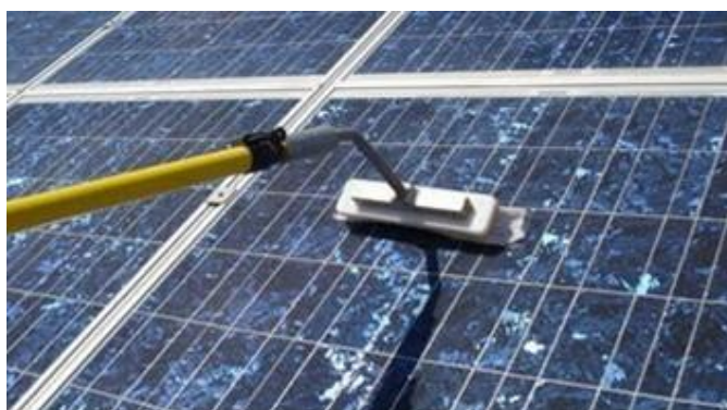
Ilustración 16. Limpieza en seco con mopetas de Módulos FV
