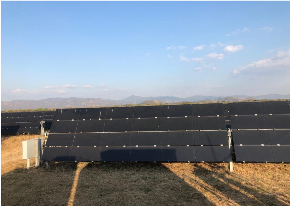
Ilustración 21. Cambio de los nuevos Módulos FV HELIOS
