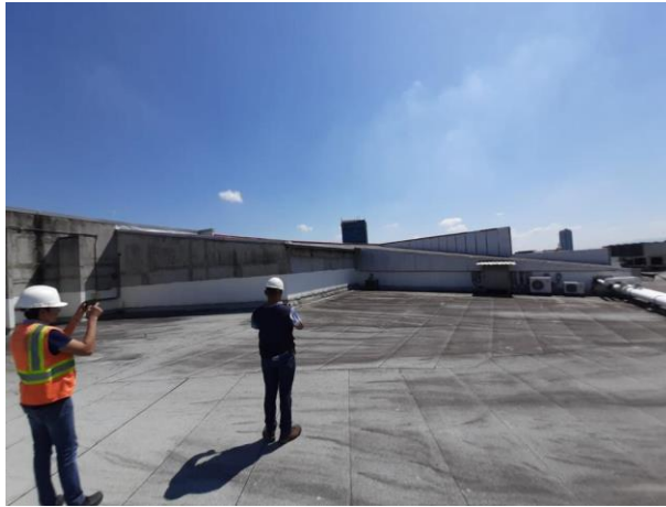
Ilustración 13 Levantamiento de techo UNITEC
