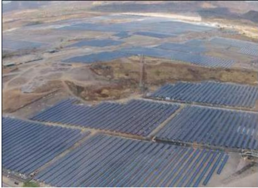
Ilustración 8 Planta Solar Cohessa en Nacaome, Valle
