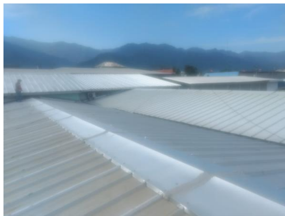
Ilustración 22 Levantamiento de techo plaza Fesmar
