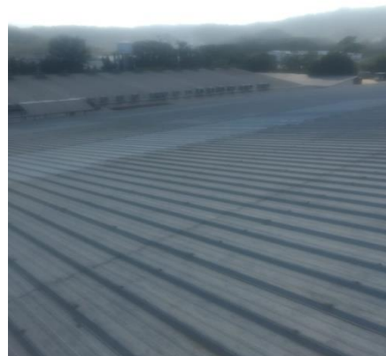
Ilustración 18 Levantamiento Techo de INHDELVA
