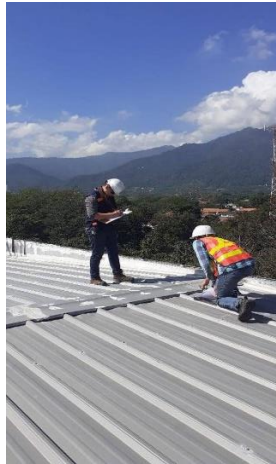
Ilustración 9 Levantamiento techo de Cable Color/Canal 11
