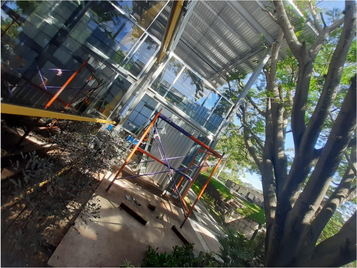
Anexo 20 - Área de Techo d vidrio - En Sitio
