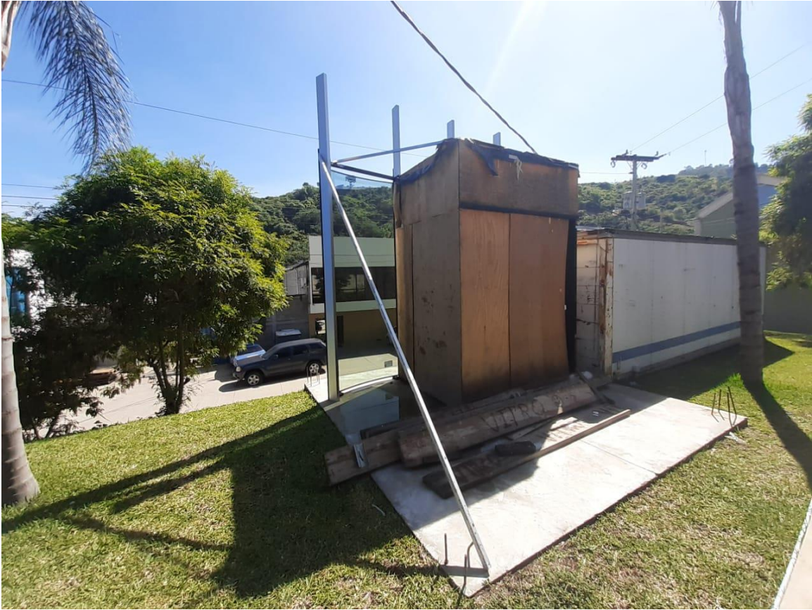
Anexo 19 - Área de contenedor - En Sitio
